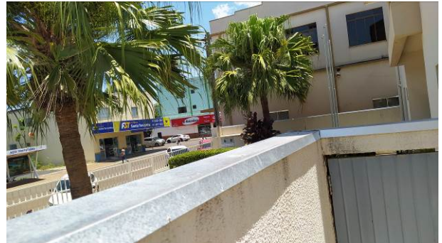
Figura 14C: Chapim aplicado no muro frontal
