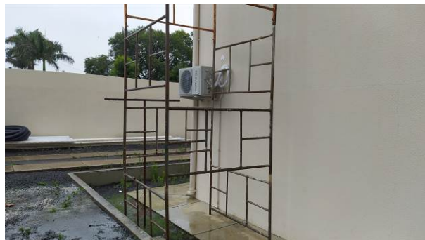
Figura 01C: Utilização de andaime metálico
