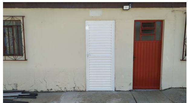
Figura 47C: Instalação de porta veneziana no arquivo
