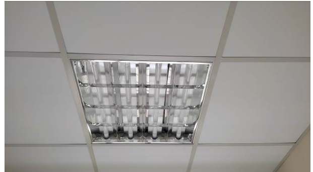
Figura 09E: lâmpadas tubulares LED
