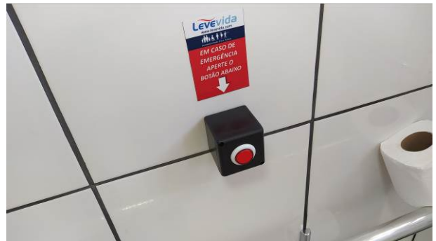
Figura 39C: Kit de emergência para PNE, botoeira de acionamento
