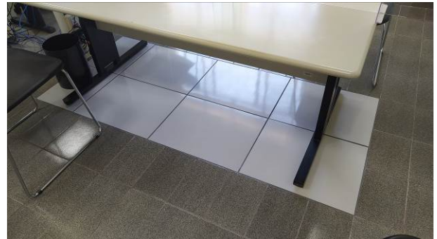
Figura 45C: Instalação de piso cerâmico na sala de audiência
