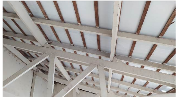
Figura 08C: Telha termoacústica vista através do sistema de enterçamento – edícula
