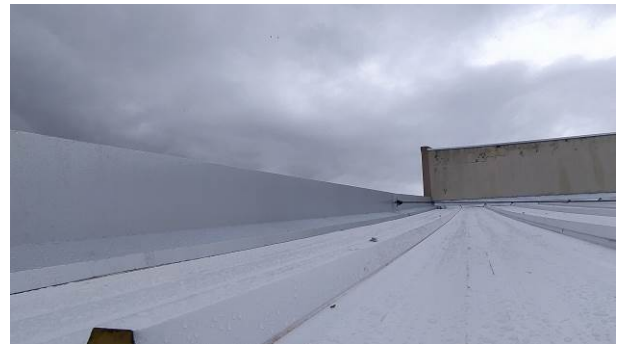
Figura 05C: Chapim instalado na cobertura do prédio principal
