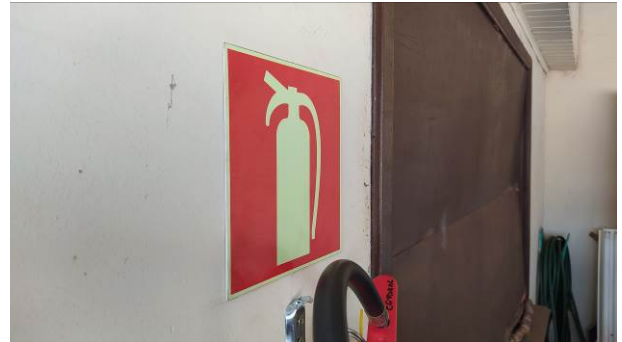
Figura 28C: Placa E5, instalada no estacionamento (edícula)
