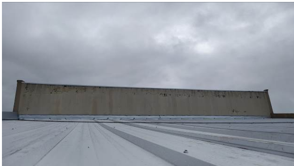
Figura 06C: Rufo instalado na cobertura do prédio principal
