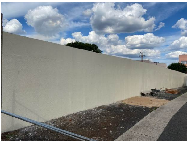
Figura 52C: Textura aplicada no aumento do muro lateral direito
