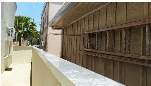
Figura 15C: Chapim aplicado no muro lateral esquerdo
