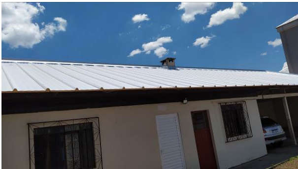
Figura 09C: Cobertura da edícula finalizada
