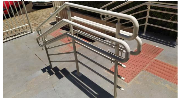
Figura 42C: Corrimão e guarda corpo instalados
