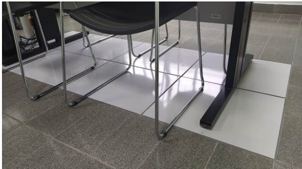
Figura 44C: Instalação de piso cerâmico na sala de audiência
