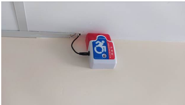
Figura 38C: Kit de emergência para PNE, sinalizador audiovisual
