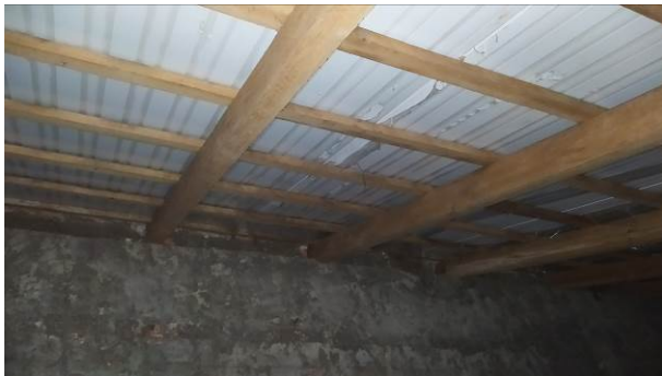
Figura 04C: Telha termoacústica vista através do sistema de enterçamento – prédio principal
