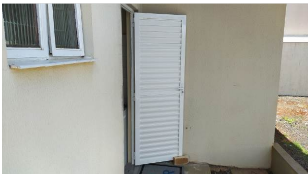
Figura 46C: Instalação de porta veneziana na edícula
