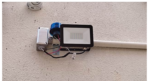
Figura 13E: refletor LED cisterna e fotocélula
