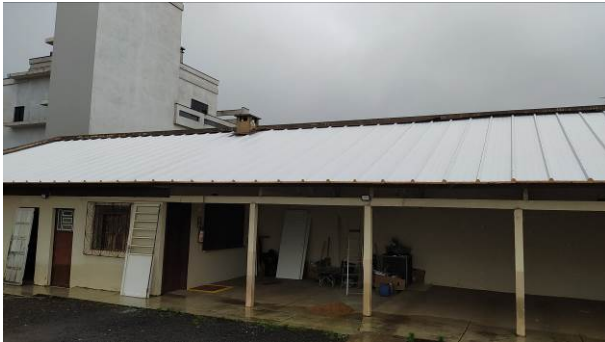
Figura 07C: Instalação de telha termoacústica na edícula
