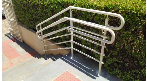
Figura 41C: Corrimão instalado em guarda corpo
