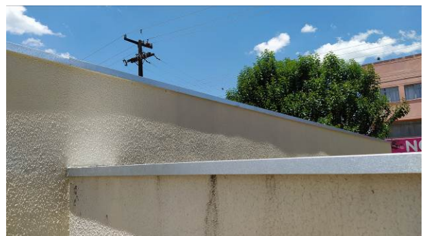
Figura 16C: Chapim aplicado no muro lateral direito e no muro frontal, próximo ao portão de veículos
