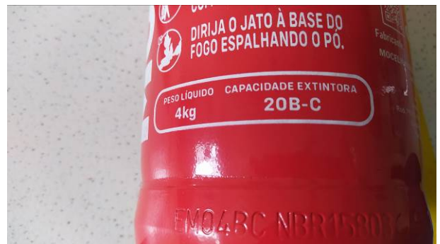
Figura 22C: Detalhe da carga e da capacidade extintora
