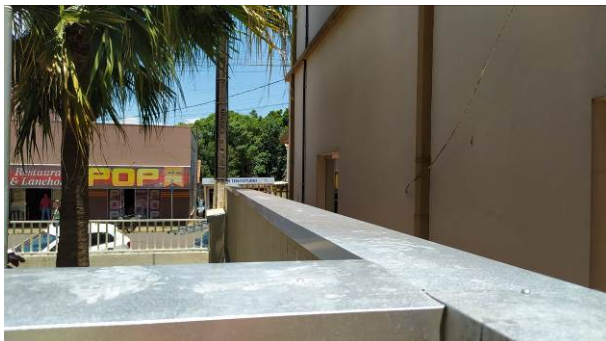
Figura 17C: Chapim aplicado no muro lateral esquerdo e frontal
