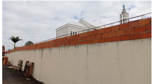
Figura 49C: Armadura da viga cinto de amarração do aumento do muro lateral direito
