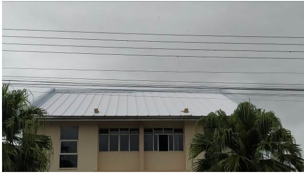
Figura 02C: Instalação de telha termoacústica na água frontal do prédio principal
