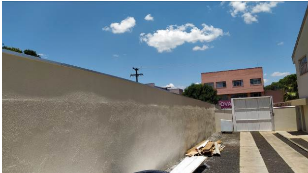
Figura 13C: Chapim aplicado no muro lateral direito
