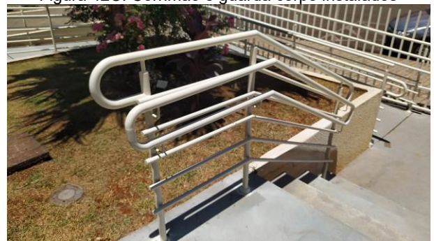
Figura 43C: Corrimão instalado em guarda corpo
