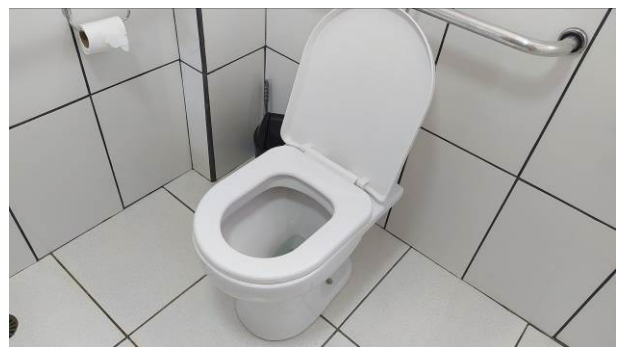
Figura 35C: Assento para vaso sanitário, no banheiro público PNE
