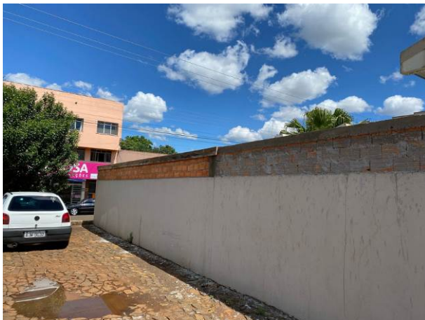
Figura 50C: Concretagem da viga cinto de amarração do aumento do muro
