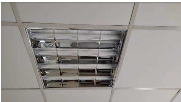
Figura 12E: lâmpadas tubulares LED
