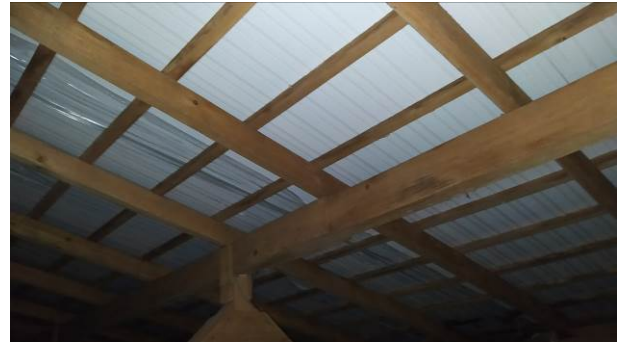
Figura 03C: Telha termoacústica vista através do sistema de enterçamento – prédio principal
