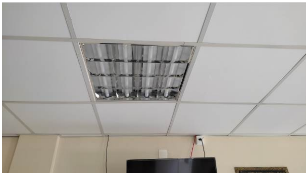
Figura 10E: lâmpadas tubulares LED
