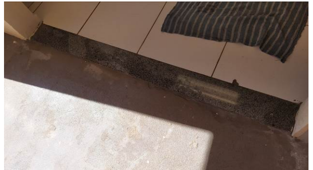
Figura 24C: Instalação de soleiras no hall do auditório
