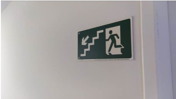
Figura 27C: Placa S9, instalada na escada da 2ª vara
