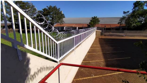
Figura 39C: Execução do gradil metálico sobre o muro lateral esquerdo e instalação de concertina dupla – parte dos fundos
