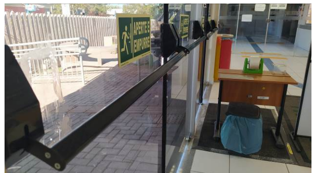
Figura 30C: Instalação de barras antipânico nas portas de entrada do fórum
