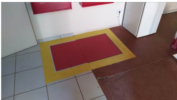
Figura 01C: Sinalização de solo, tipo E17, executada na doca de carga da setorial, junto ao par de hidrantes
