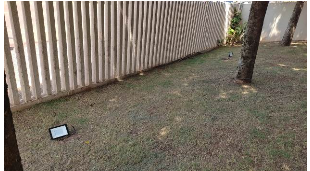
Figura 40E: projetores externos fachada
