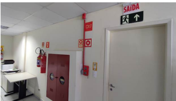
Figura 15E: botoeiras para SDAI, acionamento bombas, sirene audiovisual
