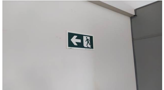
Figura 04C: Placa S2, instalada no almoxarifado da setorial
