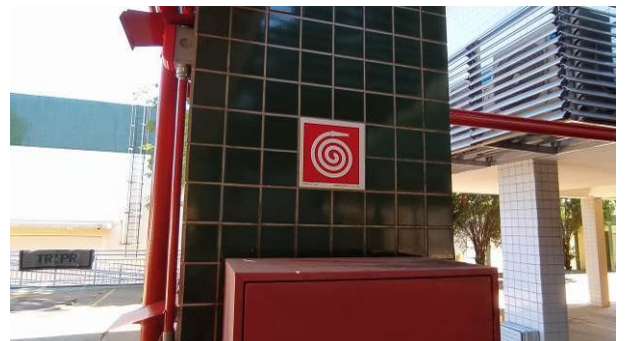
Figura 18C: Placa E7, instalada junto a hidrante, no estacionamento da 4ª vara
