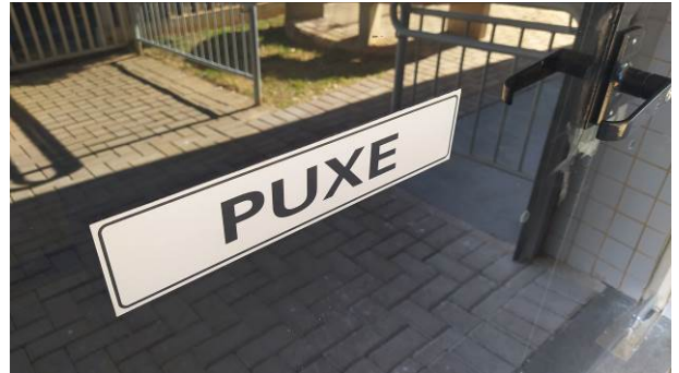
Figura 68C: Placa "puxe" instalada na face externa das portas de acesso ao fórum e, também, nas portas do hall do auditório
