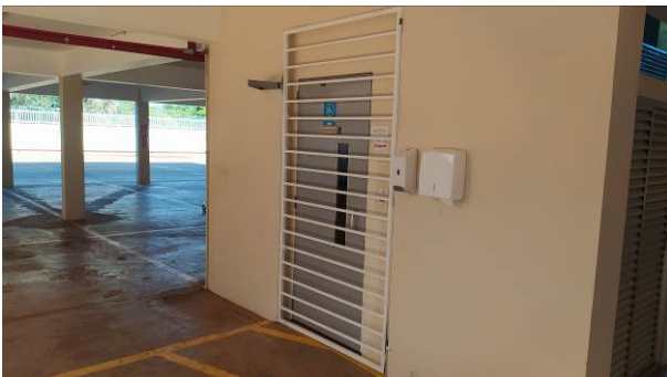
Figura 55C: Portão em gradil metálico, instalado na porta de acesso ao elevador PNE
