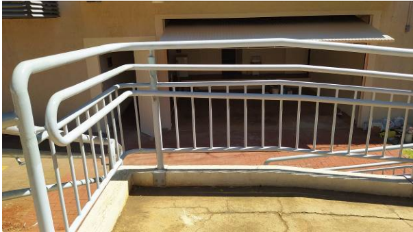
Figura 35C: Adaptação da altura dos guarda-corpos e pintura da rampa de acesso PNE à setorial
