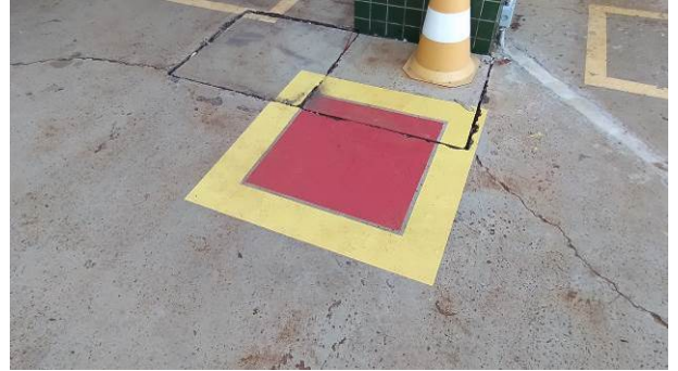
Figura 20C: Sinalização de solo E17, executada abaixo de extintor, no estacionamento da 4ª vara
