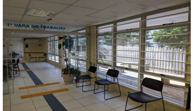
Figura 62C: Gradis metálicos instalados em todas as janelas localizadas no corredor de acesso à 1ª vara
