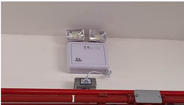
Figura 31E: blocos de emergência refletores
