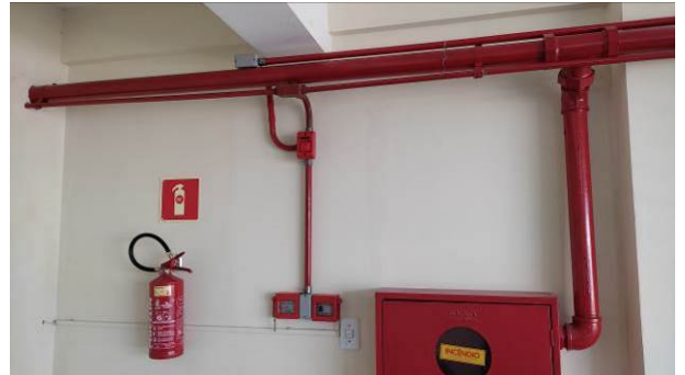
Figura 14E: botoeiras para SDAI, acionamento bombas, sirene audiovisual
