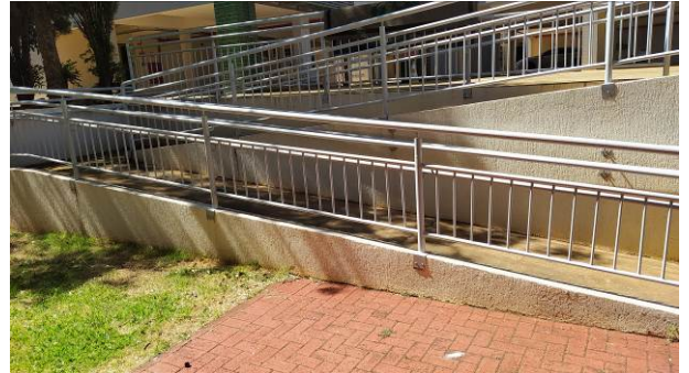
Figura 36C: Adaptação da altura dos guarda-corpos e pintura da rampa de acesso PNE à setorial
