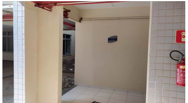
Figura 22C: Demolições de paredes e esquadria, com requadro e pintura, no hall do auditório
