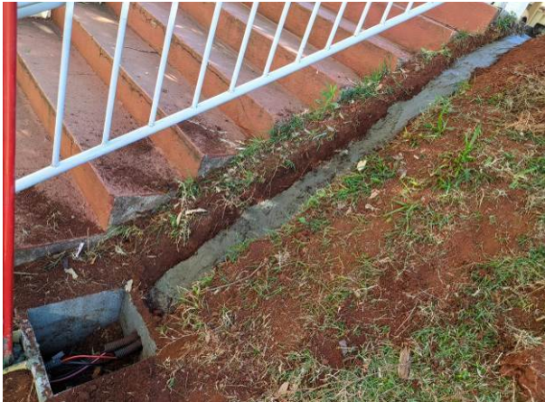
Figura 19E: infraestrutura subterrânea - Setorial
