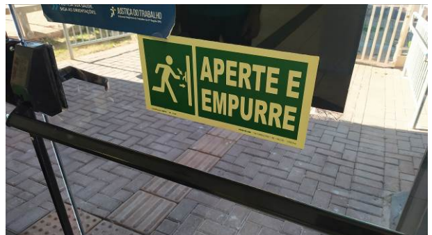
Figura 66C: Placas de sinalização "Aperte e empurre" instaladas na face interna das portas de acesso principal do fórum
