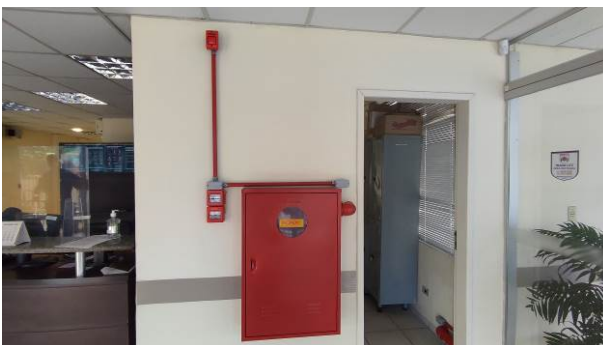
Figura 11E: botoeiras para SDAI, acionamento bombas, sirene audiovisual
