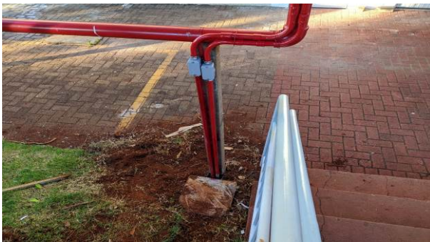
Figura 21E: infraestrutura subterrânea - Setorial
