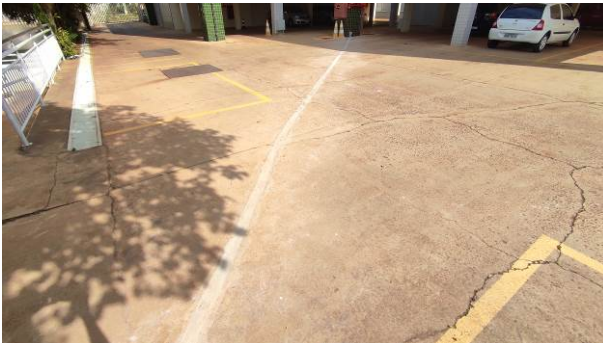
Figura 09E: infra subterrânea para SDAI e acionamento bombas
