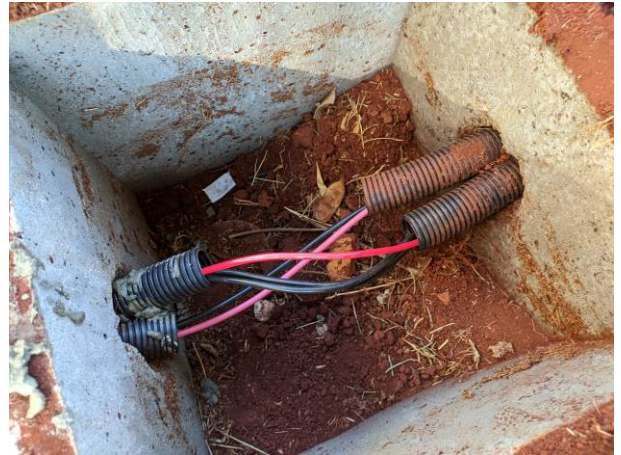
Figura 20E: infraestrutura subterrânea - Setorial
