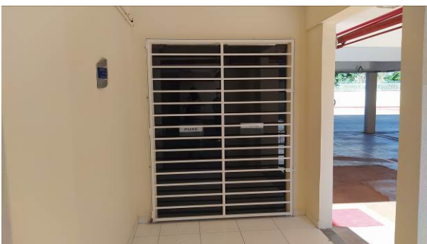
Figura 53C: Portão em gradil metálico, instalado na porta do hall do auditório
