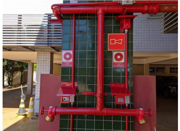
Figura 08E: botoeiras e sirene alarme SDAI – proteção rufos
