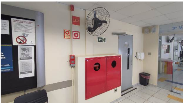
Figura 47E: botoeiras para acionamento SDAI
