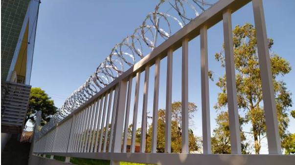
Figura 37C: Execução do gradil metálico sobre o muro lateral esquerdo e instalação de concertina dupla – parte frontal
