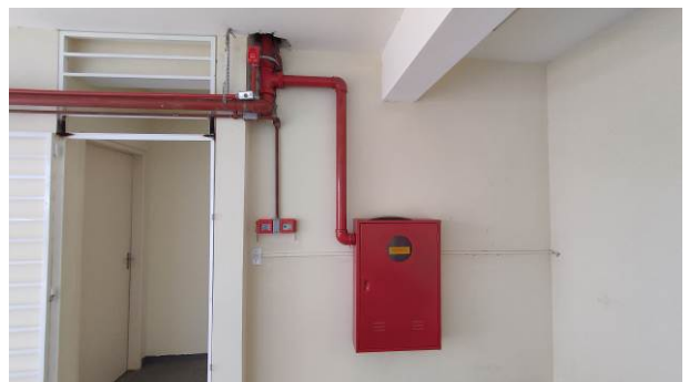
Figura 12E: botoeiras para SDAI, acionamento bombas, sirene audiovisual
