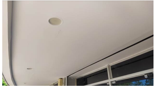
Figura 60C: Forro de gesso, após recomposição, na área de localização da porta de enrolar
