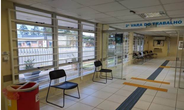
Figura 61C: Gradis metálicos instalados em todas as janelas localizadas no corredor de acesso à 2ª vara
