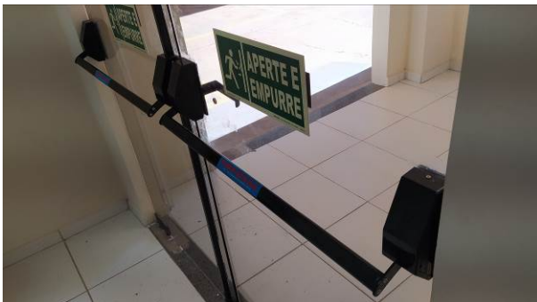
Figura 25C: Instalação de porta de VT e barra antipânico no hall do auditório
