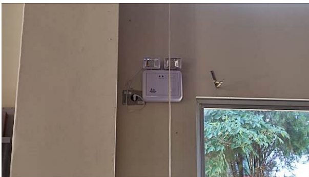
Figura 33E: blocos de emergência refletores
