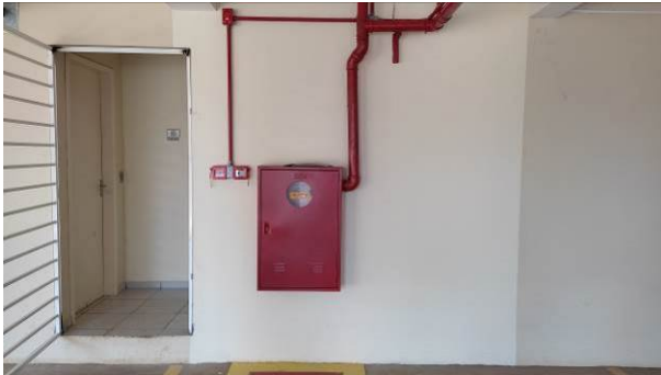
Figura 13E: botoeiras para SDAI, acionamento bombas, sirene audiovisual
