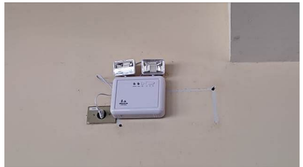
Figura 32E: blocos de emergência refletores
