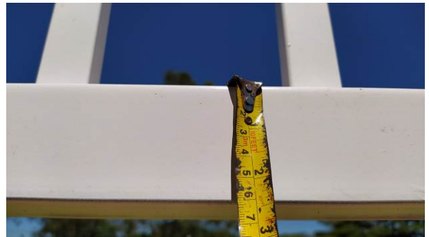
Figura 42C: Aferição da seção das longarinas do gradil
