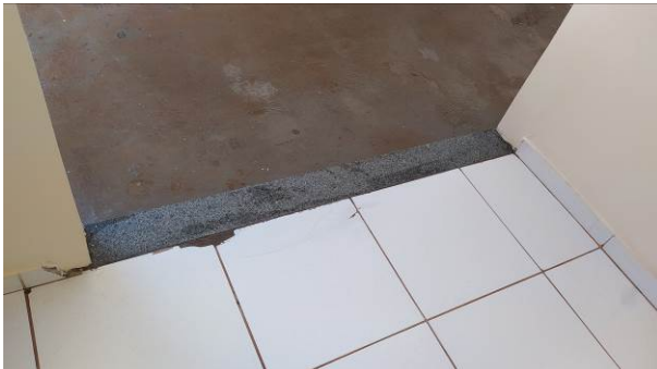
Figura 23C: Instalação de soleiras no hall do auditório
