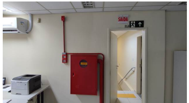
Figura 48E: botoeiras para acionamento SDAI
