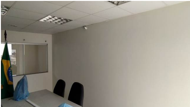
Figura 53C: Aplicação de uma demão de látex acrílico na sala de audiência 2, do primeiro andar
