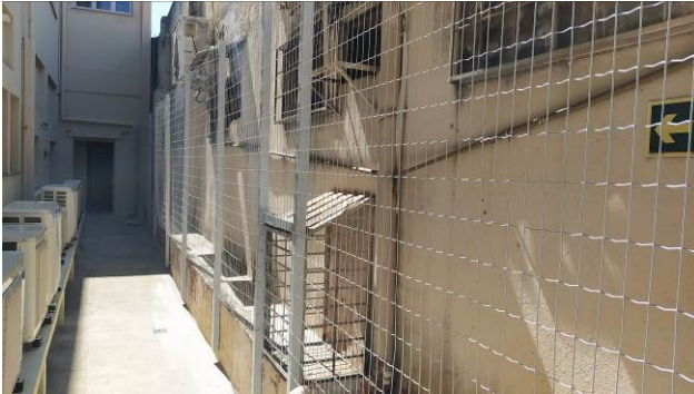
Figura 45C: Pintura do gradil localizado no corredor lateral esquerdo do pavimento térreo
