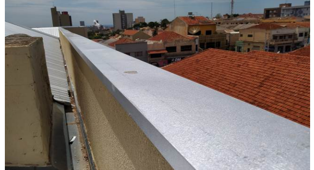
Figura 04C: Instalação de rufos sobre platibanda
