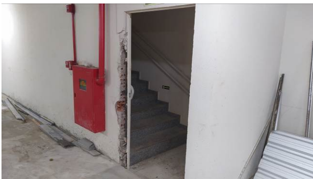
Figura 31C: Remoção da porta corta-fogo do subsolo
