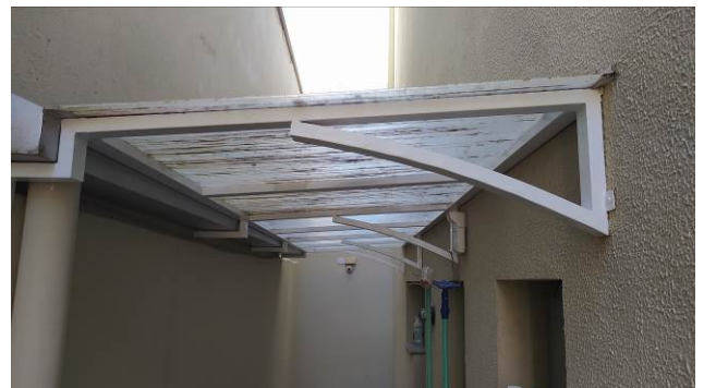
Figura 44C: Cobertura sobre o corredor dos fundos, pintada
