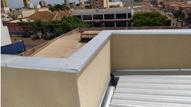
Figura 03C: Instalação de rufos sobre platibanda e no encontro entre telha e platibanda
