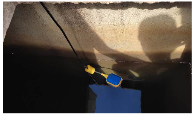
Figura 08E: Chave bóia cisterna água potável
