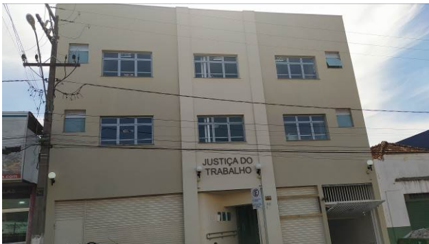
Figura 41C: Fachada fronta, com pintura finalizada
