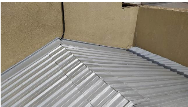
Figura 07C: Instalação de rufos no encontro entre telha e platibanda
