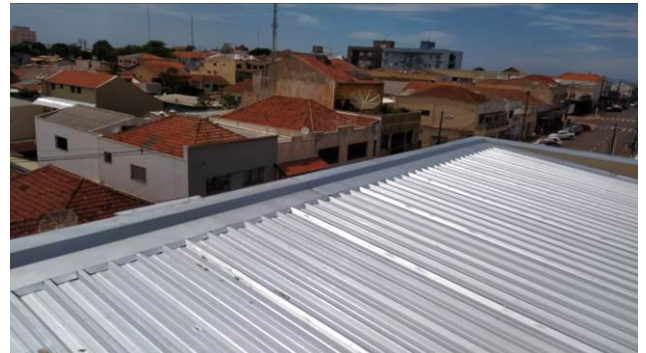
Figura 06C: Instalação de rufos no encontro entre telha e platibanda
