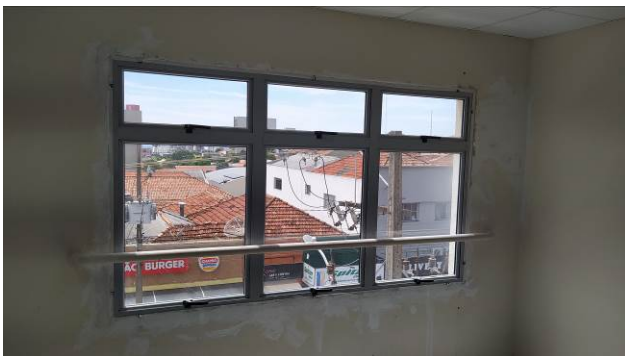
Figura 19C: Esquadria instalada no segundo andar (gabinete do juiz 1)
