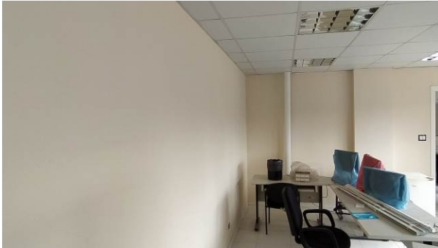
Figura 51C: Aplicação de uma demão de látex acrílico nas paredes, no gabinete do juiz 2, no primeiro andar
