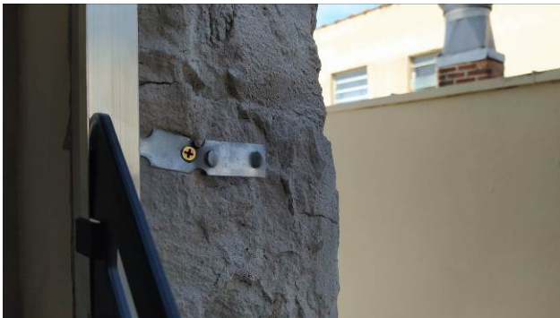
Figura 11C: Detalhe da fixação do contramarco
