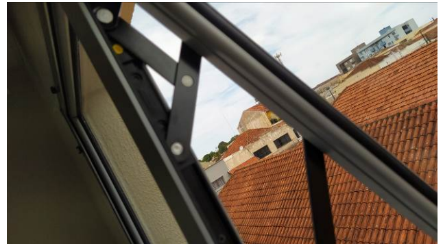
Figura 24C: Detalhe do sistema de abertura progressiva
