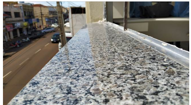
Figura 14C: Detalhe de peitoril instalado em janela da secretaria, no segundo andar
