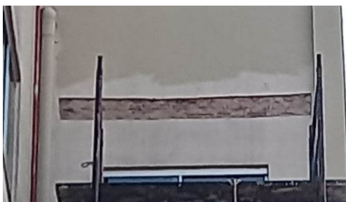
Figura 25C: Serviço de demolição do revestimento em local com fissura
