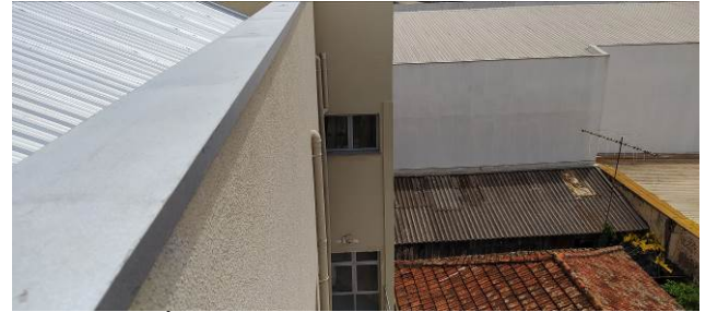
Figura 28C: Áreas recuperadas, após aplicação de pintura texturizada
