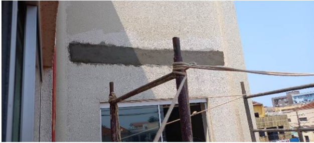
Figura 27C: Revestimento recuperado, após aplicação de reboco sobre tela de aço
