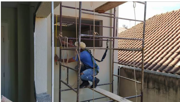
Figura 29C: Trabalhador realizando finalização da recuperação do revestimento próximo a vão de janela
