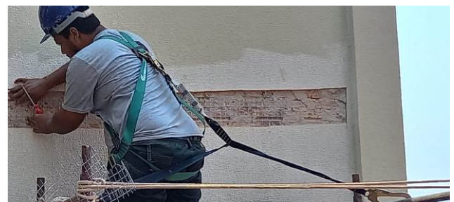
Figura 26C: Aplicação da tela de aço sobre a alvenaria
