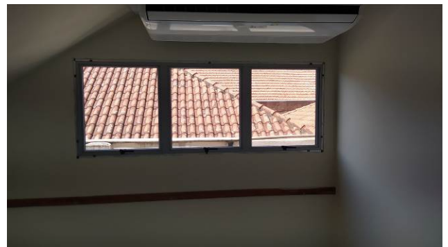
Figura 20C: Esquadria instalada no primeiro andar (hall público)
