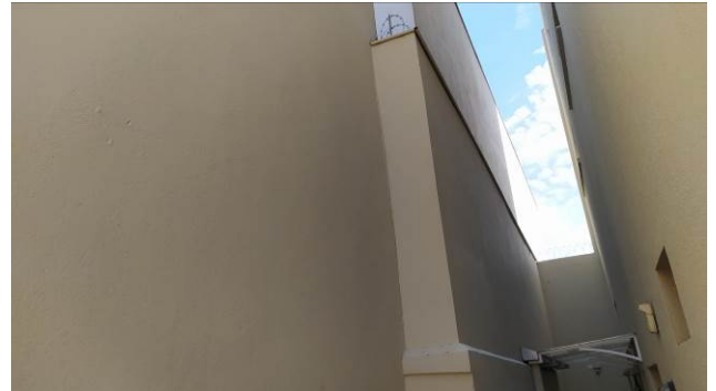
Figura 40C: Muro localizado nos fundos do imóvel, com pintura finalizada
