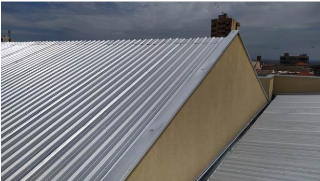
Figura 05C: Instalação de rufos sobre platibanda
