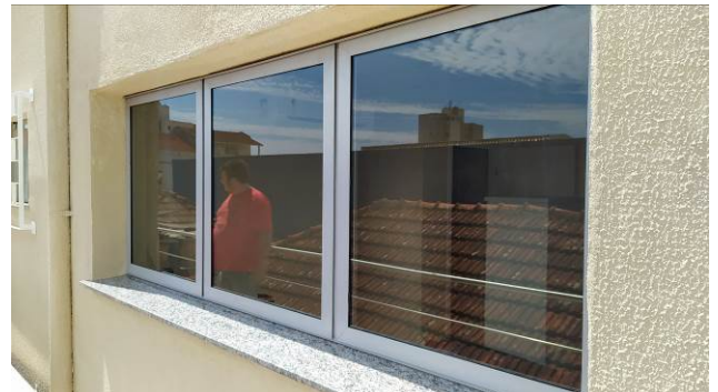
Figura 18C: Esquadria instalada no primeiro andar (gabinete do juiz 2)
