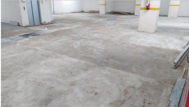
Figura 33C: Execução do piso em concreto do subsolo
