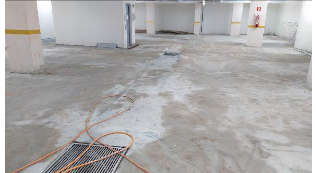
Figura 34C: Execução do piso em concreto do subsolo
