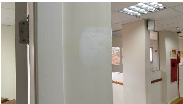
Figura 47C: Preparo de parede com aplicação de massa PVA e lixamento, no segundo pavimento – hall público
