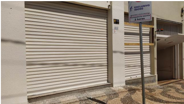
Figura 55C: Pintura das portas de aço de enrolar
