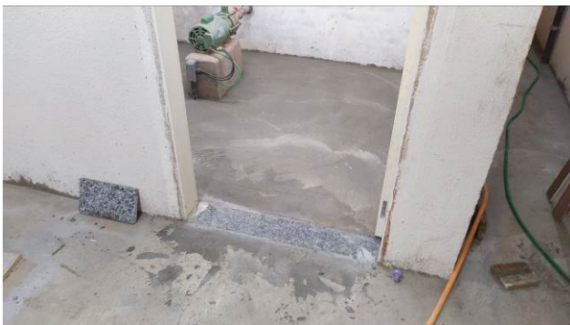
Figura 35C: Instalação de soleira na porta da casa de bombas
