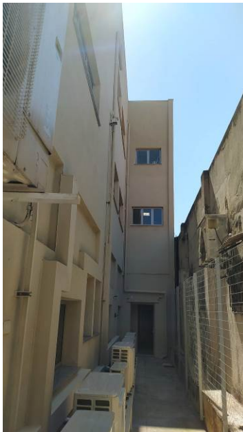
Figura 37C: Fachada lateral esquerda, com pintura finalizada
