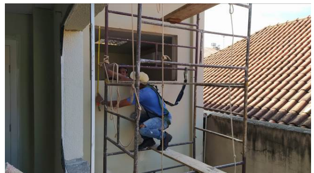
Figura 02C: Utilização de andaime
