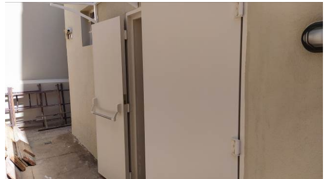
Figura 56C: Segunda demão de pintura das portas corta-fogo do pavimento térreo
