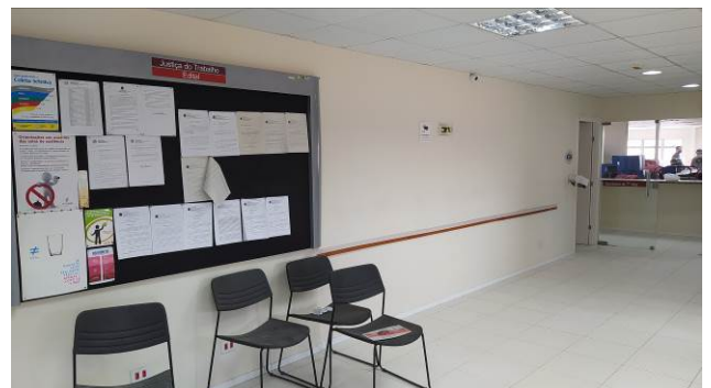
Figura 50C: Aplicação de uma demão de látex acrílico nas paredes, no hall público, do primeiro andar
