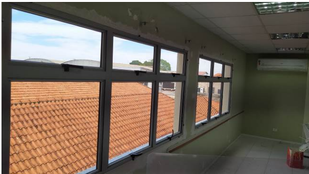
Figura 17C: Esquadrias instaladas no segundo andar (sala de audiência 1)
