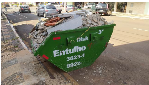
Figura 01C: Caçamba utilizada na remoção de entulhos
