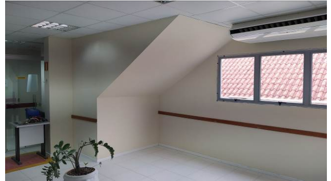
Figura 52C: Aplicação de uma demão de látex acrílico nas paredes, no hall público, do primeiro andar
