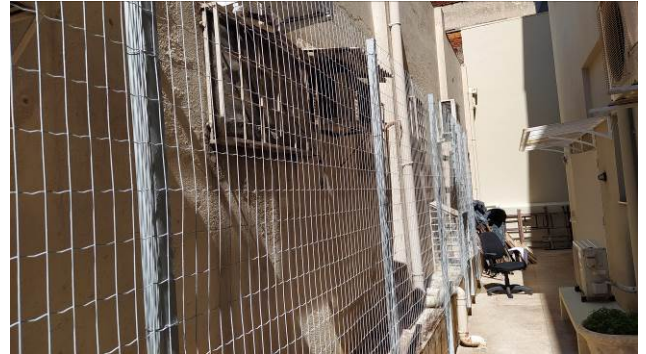
Figura 46C: Pintura do gradil localizado no corredor lateral esquerdo do pavimento térreo
