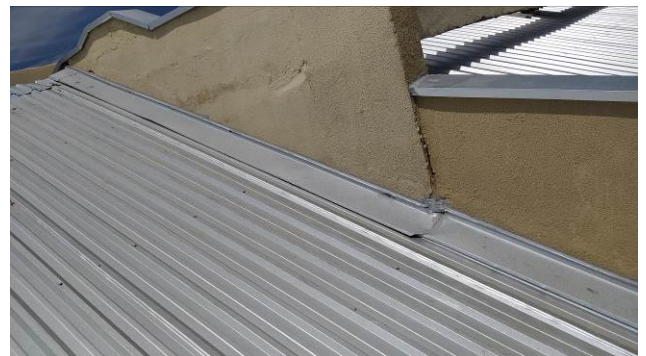
Figura 08C: Instalação de rufos no encontro entre telha e platibanda
