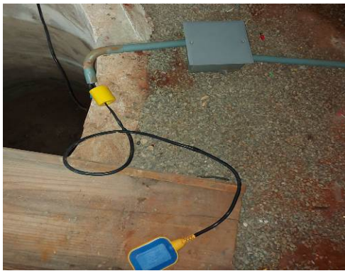
Figura 07E: Chave bóia drenagem
