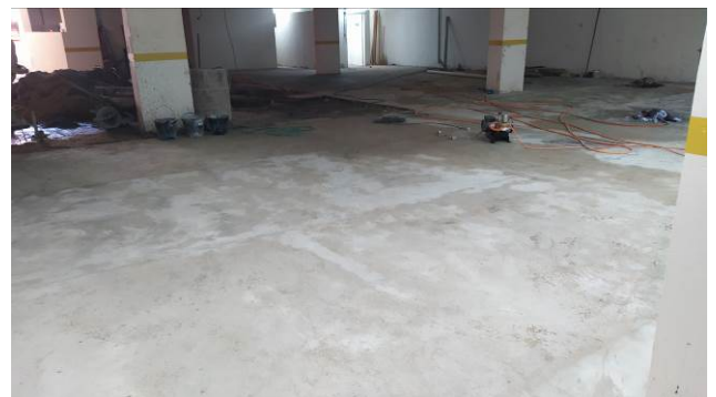
Figura 32C: Execução do piso em concreto do subsolo
