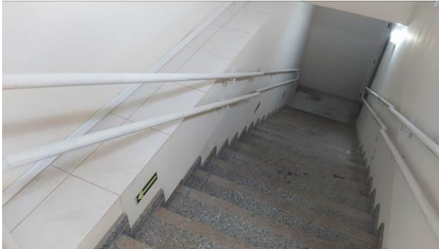
Figura 57C: Instalação de corrimão duplo na escada de acesso ao subsolo
