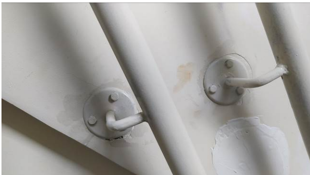
Figura 61C: Detalhe da fixação dos corrimãos na parede
