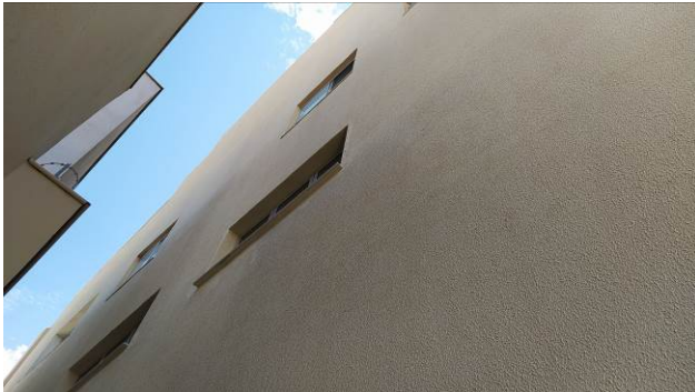
Figura 39C: Fachada posterior, com pintura finalizada
