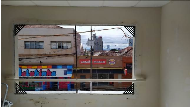
Figura 09C: Janela removida, já com contramarco novo instalado, no primeiro andar
