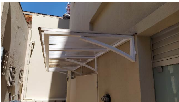
Figura 43C: Cobertura sobre a porta corta-fogo de acesso ao corredor lateral, pintada
