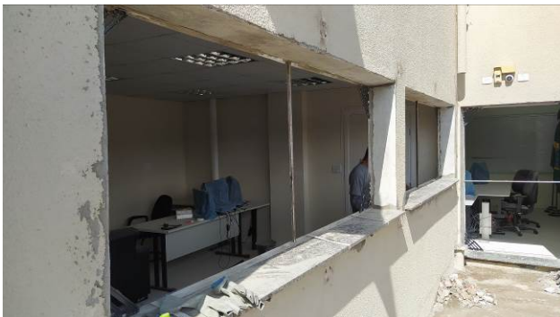
Figura 13C: Vãos de janelas, no primeiro andar, já com requadro executado e peitoril instalado
