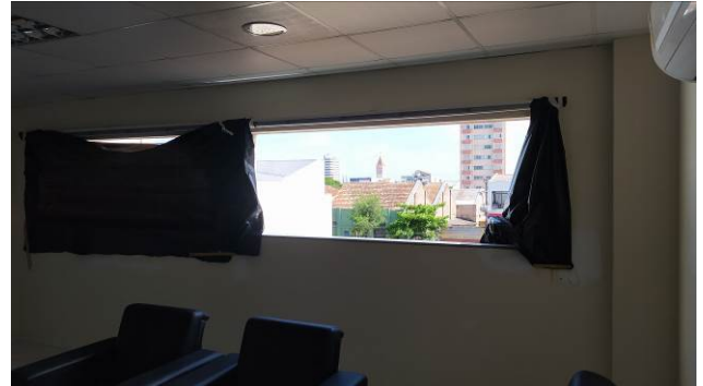
Figura 10C: Janela removida, já com contramarco novo instalado, no segundo andar
