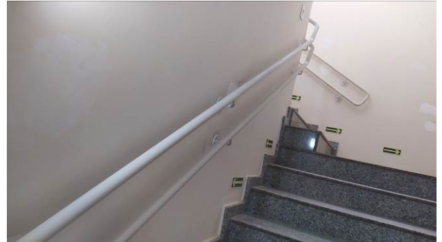
Figura 58C: Instalação de corrimão duplo na escada de acesso ao primeiro andar
