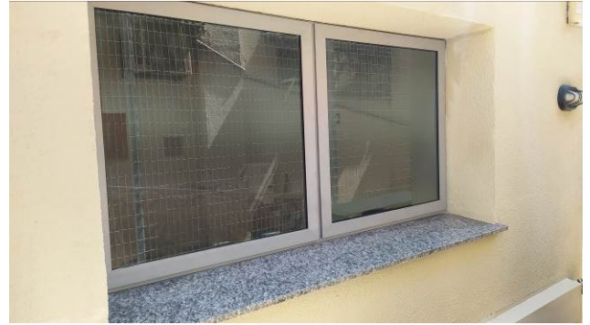
Figura 16C: Esquadria instalada no pavimento térreo
