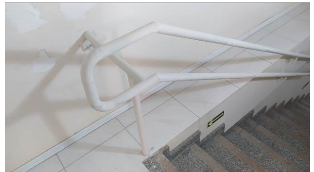
Figura 62C: Detalhe do raio de giro e avanço de 30cm do corrimão após o término do degrau da escada
