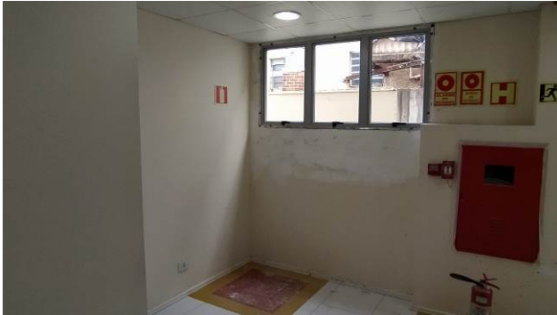
Figura 21C: Esquadria instalada no segundo andar (hall público)
