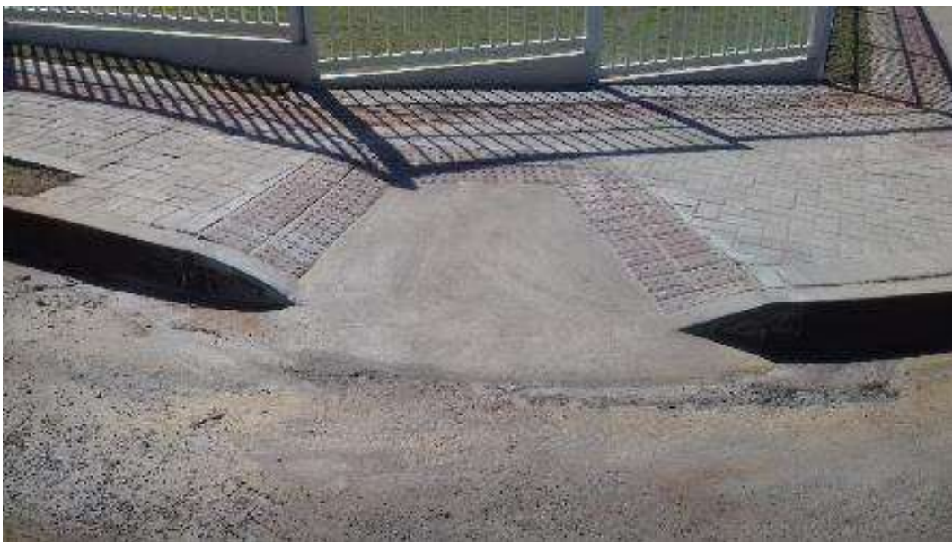
Acesso – guia rebaixada meio fio
