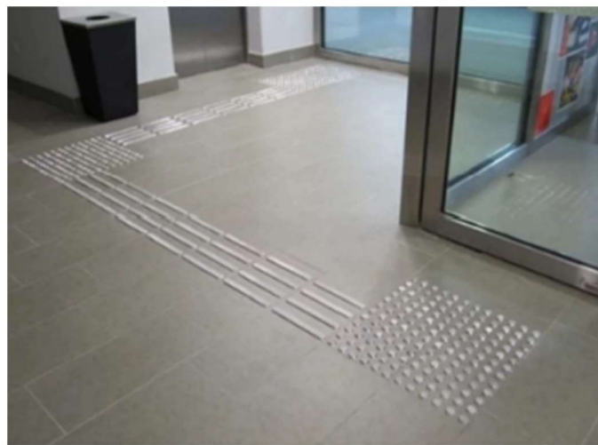
Piso inox instalado
