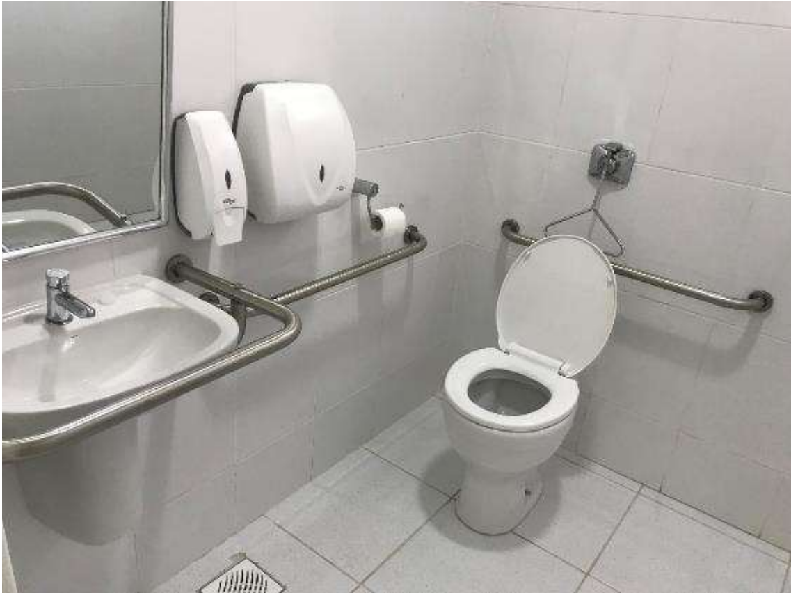
Modelo de Instalações sanitárias PCD
