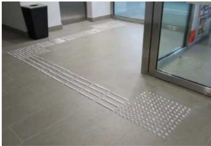
Piso Tátil instalado
