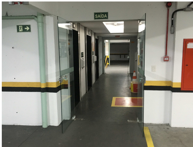
Portas de vidro a remover
