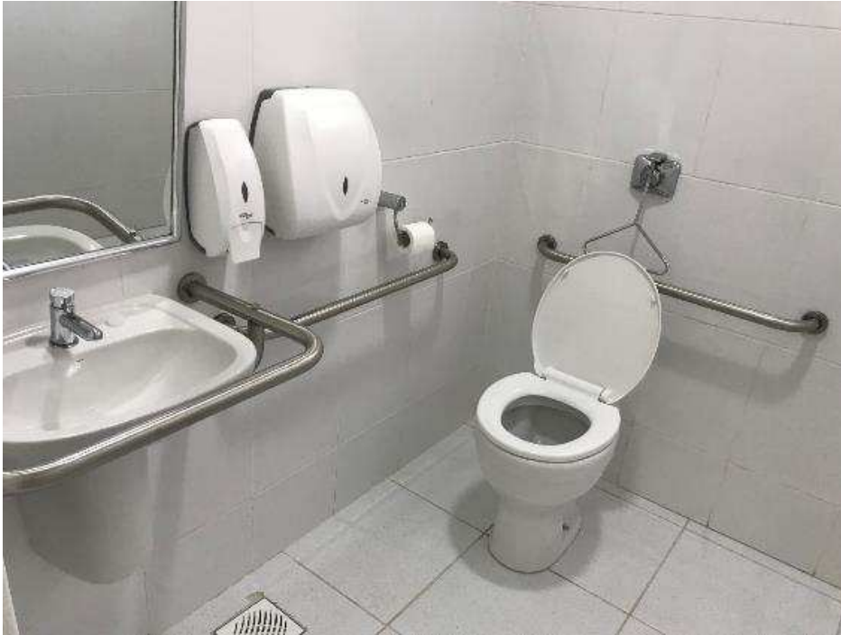
Modelo de Instalações sanitárias PCD
