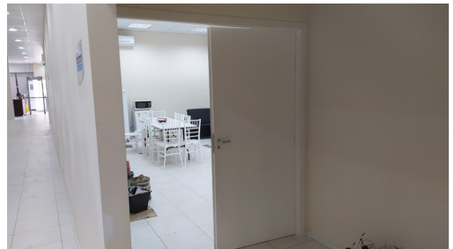
Figura 44C: Aplicação de uma demão esmalte sintético em portas, no acesso ao auditório, no pavimento térreo
