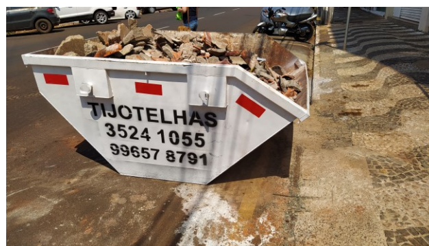
Figura 02C: Caçamba utilizada na remoção de entulhos
