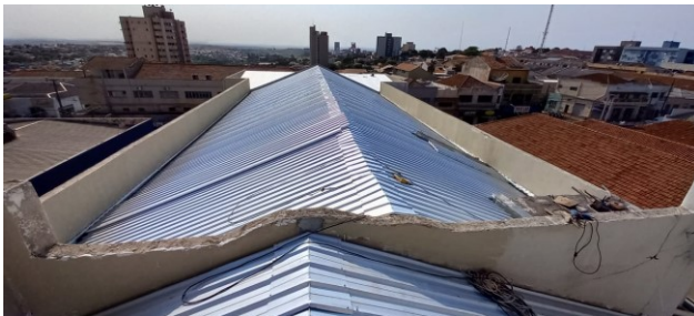
Figura 14C: Telhas metálicas tipo sanduíche, com preenchimento em EPS, instaladas na cobertura lateral e fundos (duas águas e goiva)
