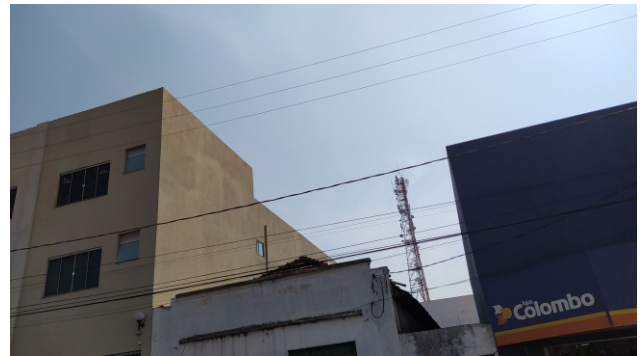
Figura 36C: Aplicação de uma demão de látex acrílico na fachada lateral direita do fórum
