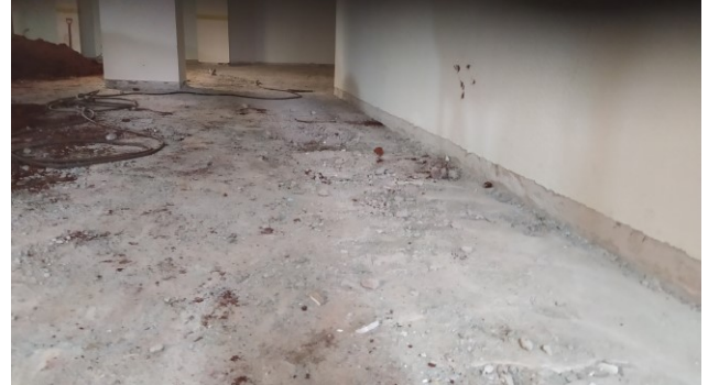
Figura 34C: Piso do subsolo após demolições e picoteamento
