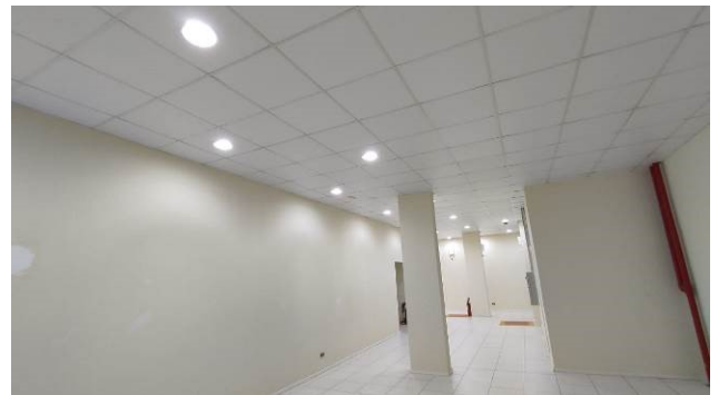
Figura 06E: Lâmpadas LED bulbo bocal E27 instaladas
