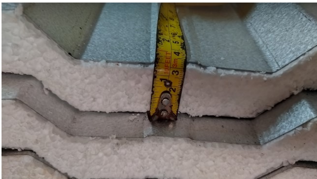
Figura 16C: Aferição do preenchimento de EPS de telhas tipo sanduíche
