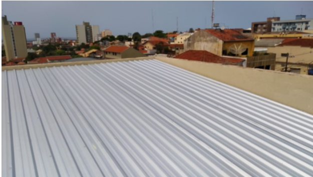
Figura 12C: Telhas metálicas tipo sanduíche, com preenchimento em EPS, instaladas na cobertura de retângulo frontal
