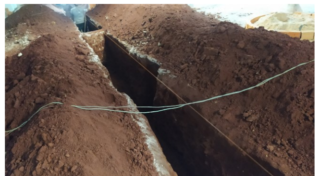
Figura 26C: Abertura de vala para execução das tubulações de drenagem do piso e das caixas de coleta
