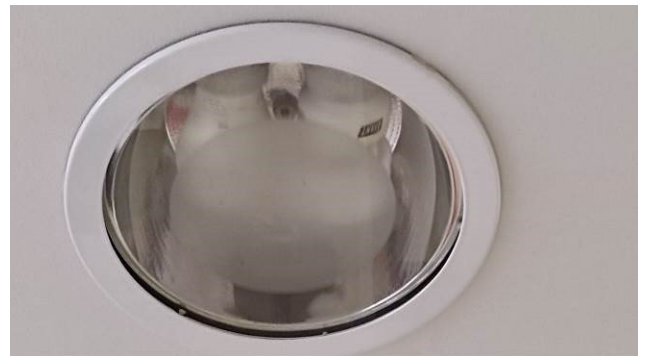
Figura 02E: Substituição de lâmpadas LED bulbo bocal E27
