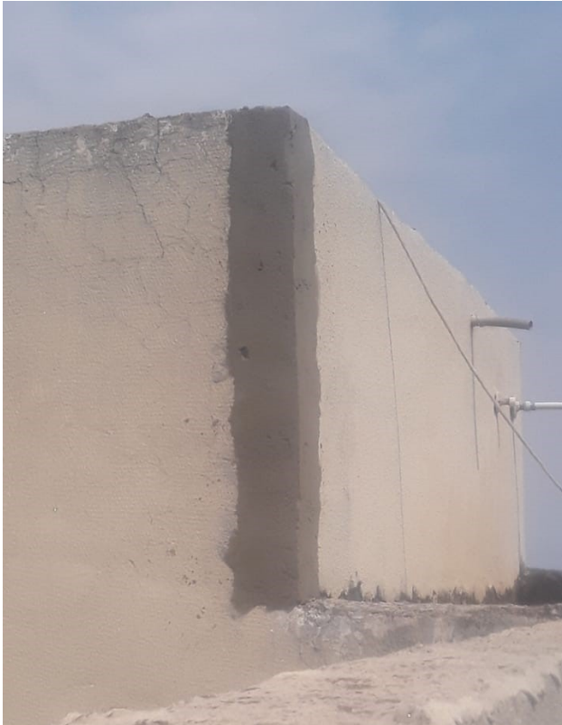
Figura 22C: Revestimento recuperado, após aplicação de reboco sobre tela metálica
