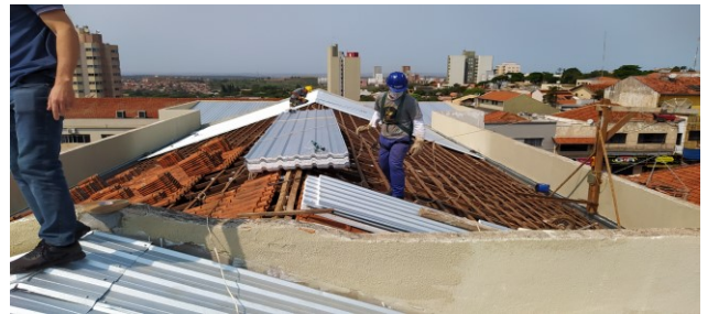
Figura 15C: Detalhe de momento em que telhas de barro eram removidas, realizada a adequação das terças para instalação das telhas metálicas tipo sanduíche
