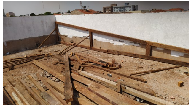
Figura 05C: Demolição do madeiramento da cobertura frontal
