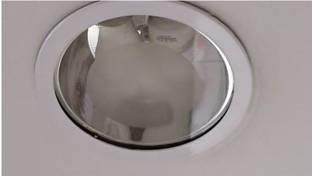
Figura 03E: Substituição de lâmpadas LED bulbo bocal E27
