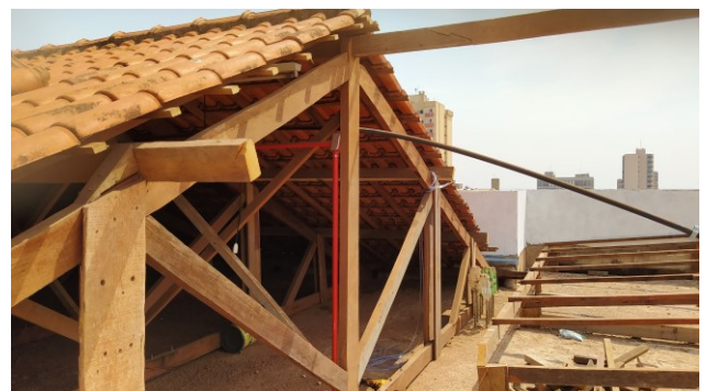
Figura 07C: Região final da demolição do madeiramento (oitão)
