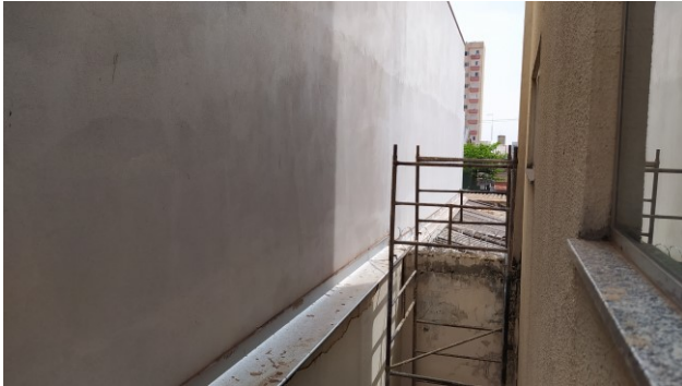
Figura 03C: Utilização de andaime
