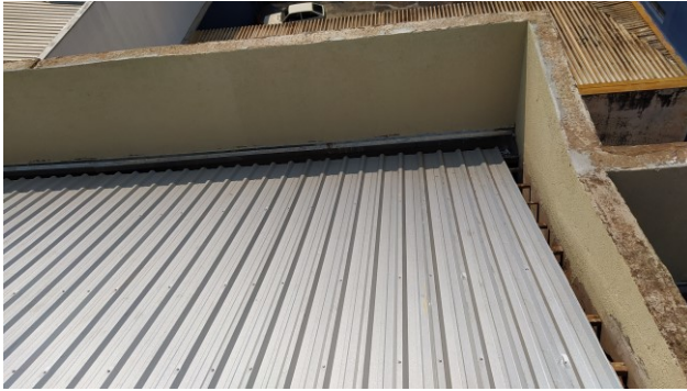
Figura 18C: Aplicação de textura na face interna das platibandas
