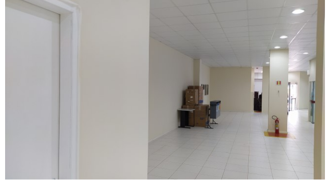
Figura 40C: Aplicação de uma demão de látex acrílico nas paredes e esmalte sintético em portas, no hall público, do pavimento térreo
