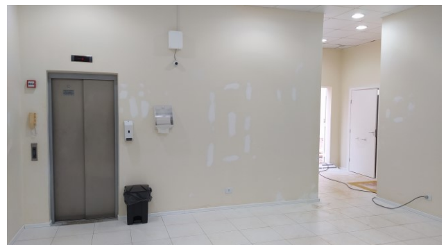
Figura 38C: Preparo de parede com aplicação de massa PVA e lixamento, no pavimento térreo – próximo ao elevador e sanitários públicos
