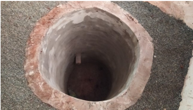
Figura 29C: Poço de drenagem executado
