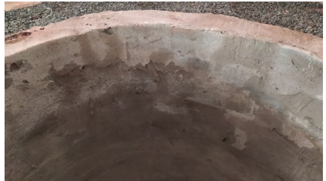
Figura 30C: Detalhe da parede do poço de drenagem, em bloco de concreto, com amarração armada e concretada
