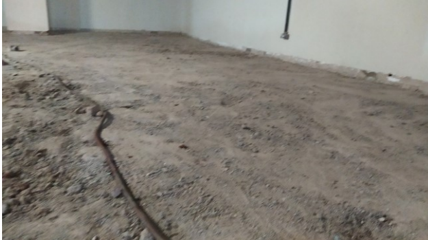
Figura 33C: Piso do subsolo após demolições e picoteamento
