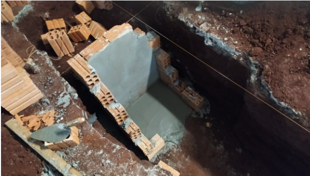
Figura 27C: Execução das caixas de coleta em alvenaria
