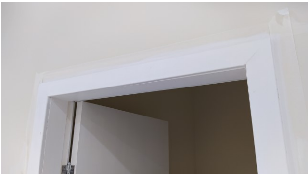
Figura 43C: Detalhe de batente e vistas, após aplicação de uma demão de esmalte sintético branco
