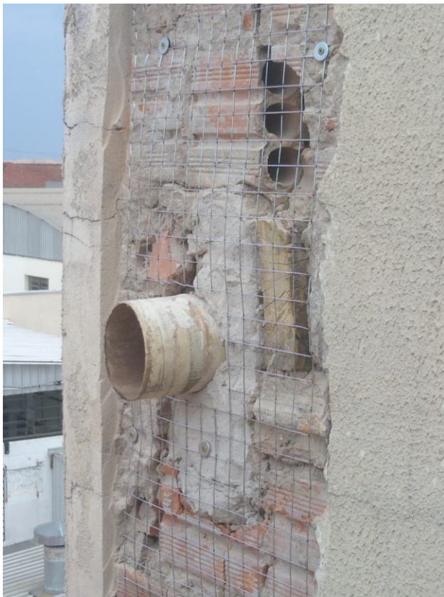
Figura 20C: Remoção do reboco deteriorado e aplicação de tela metálica em região de recuperação do revestimento externo
