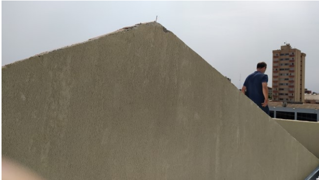
Figura 08C: Oitão de alvenaria já executado, rebocado e texturizado
