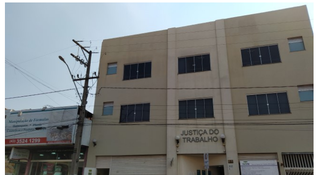
Figura 24C: Face frontal, com revestimento já recuperado
