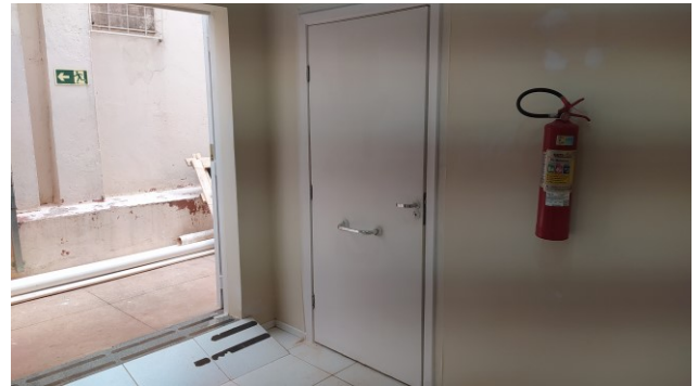
Figura 42C: Aplicação de uma demão esmalte sintético em portas, na região dos sanitários públicos, do pavimento térreo
