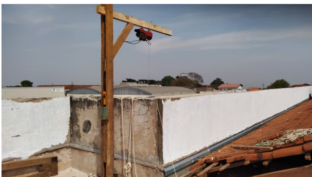
Figura 06C: Sistema de içamento de telhas na retirada das telhas cerâmicas
