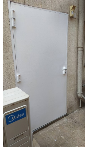
Figura 46C: Detalhe de porta corta-fogo após aplicação de uma demão de esmalte sintético branco, na saída do auditório, no pavimento térreo
