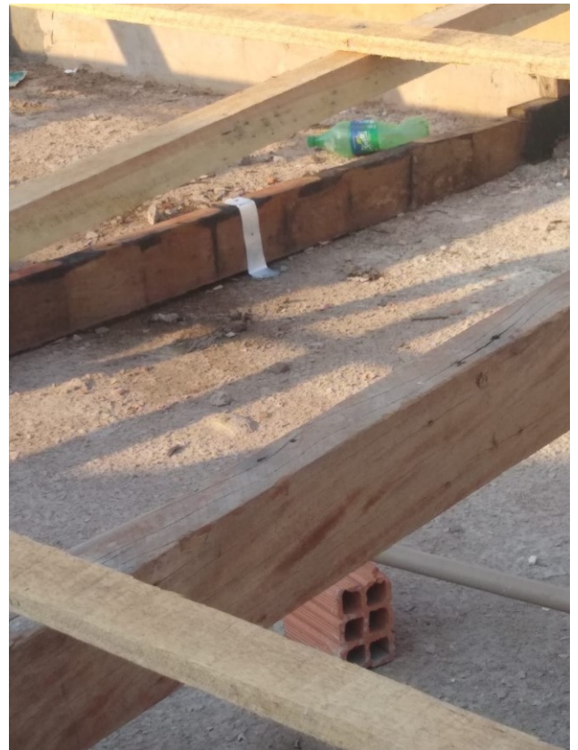
Figura 11C: Detalhe das tesouras e terças do madeiramento
