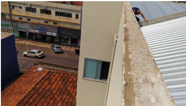
Figura 04C: Demolição das protuberâncias existentes sobre a platibanda
