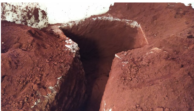
Figura 25C: Abertura de vala para execução do poço de drenagem
