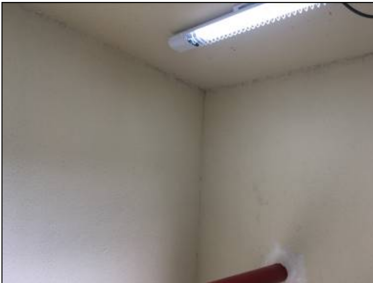
Figura 02 – Pintura interna da casa de máquinas
