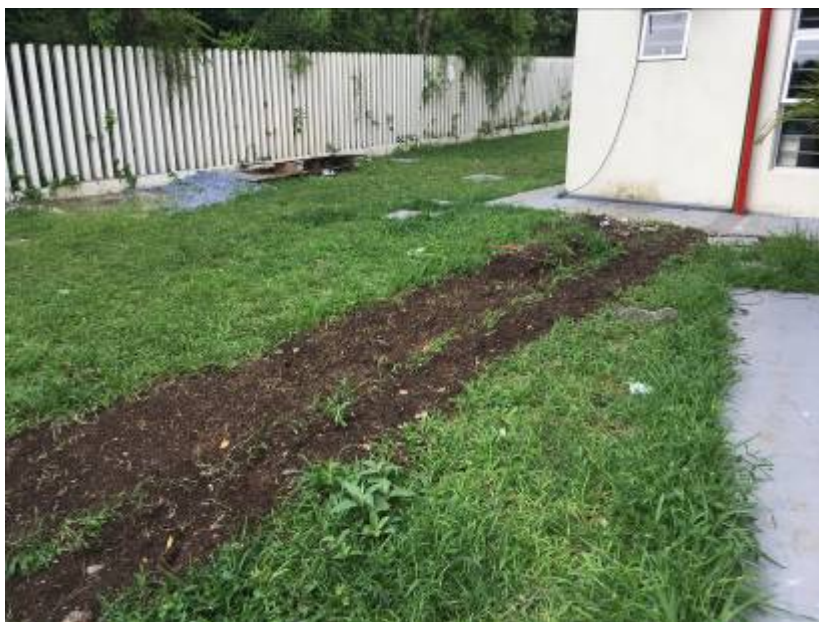
Figura 03 – Escavação/reaterro em virtude de novo posicionamento dos reservatórios
