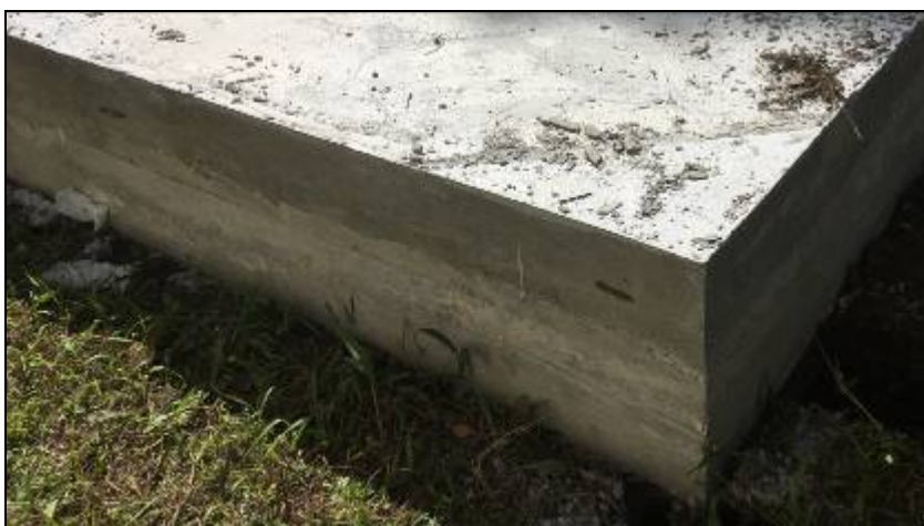
Figura 01 – Aumento nas dimensões da base de concreto
