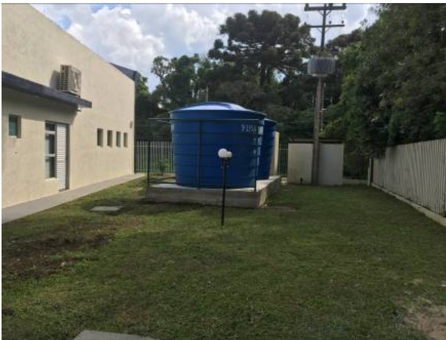
Figura 05 – Novo posicionamento dos reservatórios, com maior distância à edificação, em relação ao inicialmente previsto em projeto
