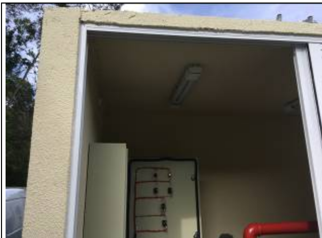
Figura 01: Pintura externa casa de bombas.
