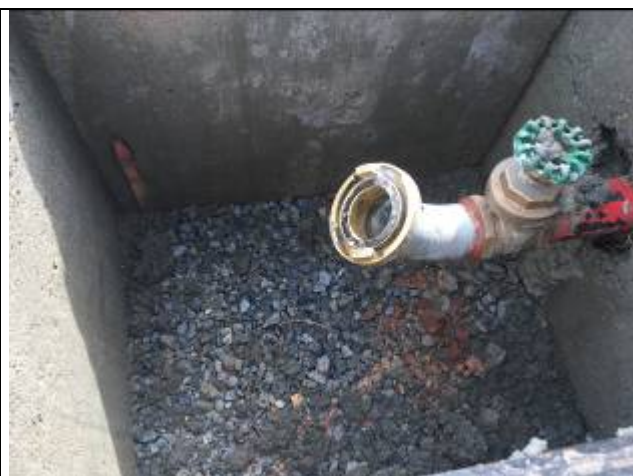
Figura 07: Hidrante subterrâneo instalado
