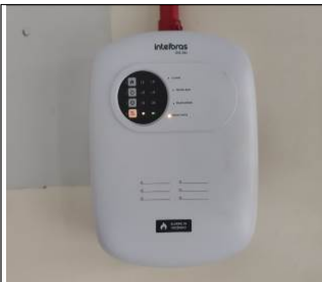
Figura E15: Central de alarme de incêndio
