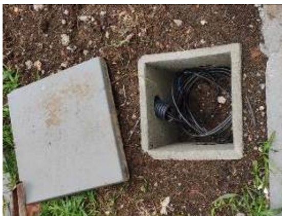
Figura E03: Caixa de passagem 30x30x40 com tampa
