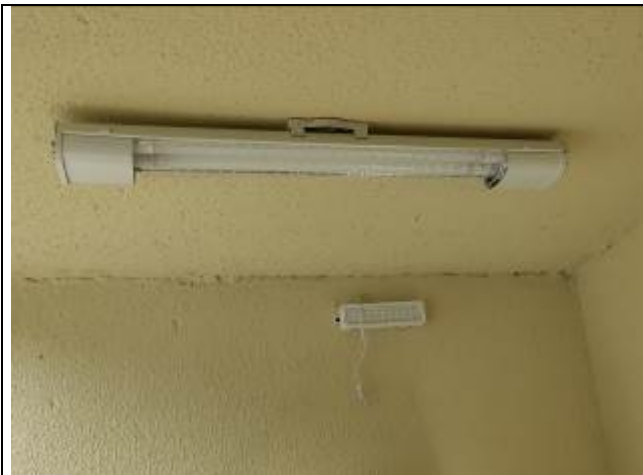
Figura E08: Luminária de sobrepor tipo calha para duas lâmpadas LED
