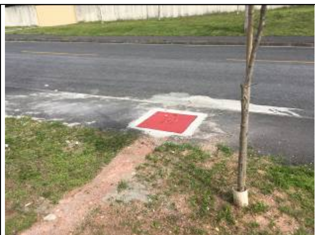
Figura 08: Hidrante subterrâneo instalado
