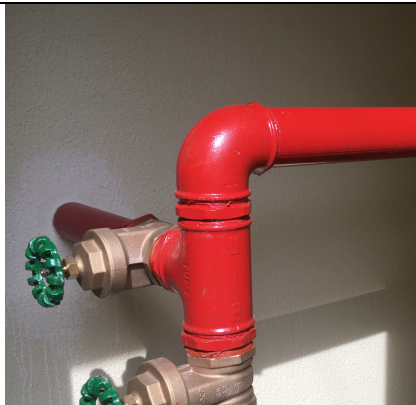
Figura 05: registro de gaveta instalado.
