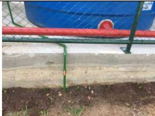
Figura 10: Tubulação de alimentação instalada.
