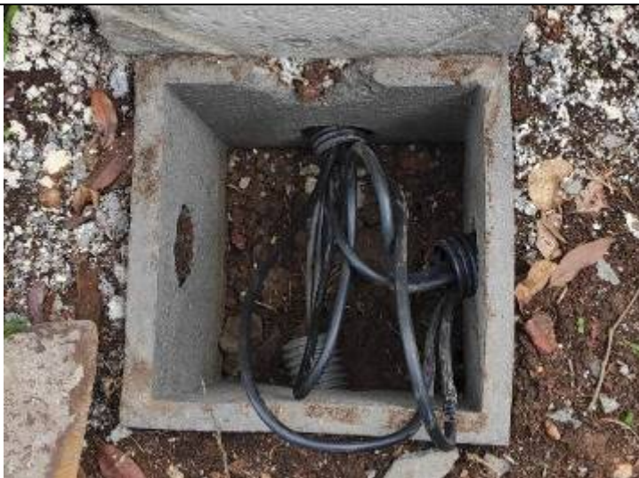
Figura E06: Cabo de cobre flexível seção 25 mm 2
