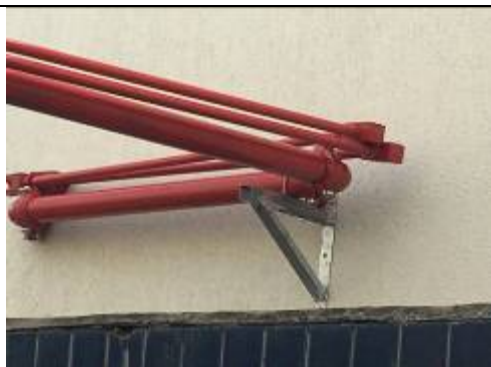
Figura 11: Pintura de tubulação.
