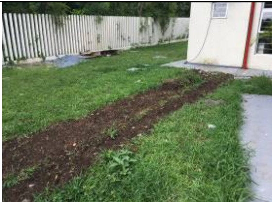
Figura 09: Reaterro executado.
