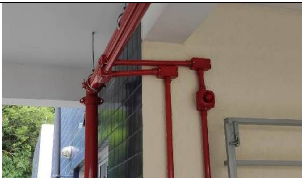
Figura E13: Condutores em liga de alumínio na cor vermelha
