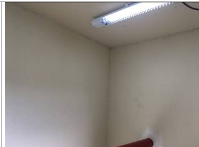
Figura 02: pintura interna casa de bombas.
