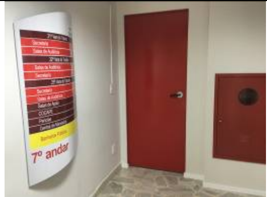
Figura 5: Porta corta-fogo – 7º andar.
