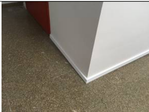
Figura 02: rodapés instalados.
