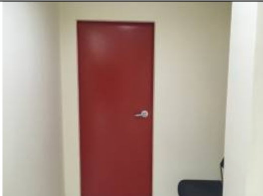
Figura 6: Pintura executada – parede dry-wall.
