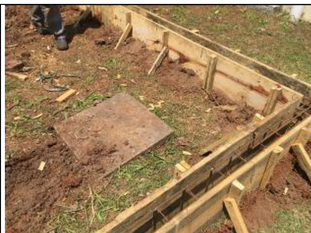
Figura 02: Execução das formas da base.
