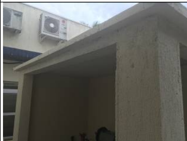
Figura 06: pintura casa de bombas.
