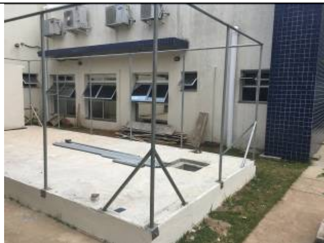
Figura 03: base de concreto executada.
