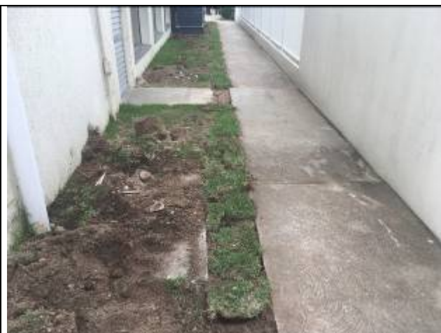
Figura 12: reaterro de valas.
