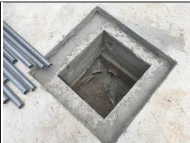
Figura 04: base de concreto / caixa de captação de água pluvial.
