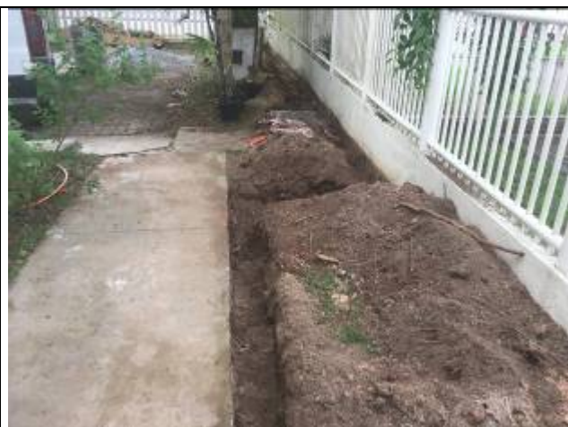
Figura 11: Abertura de valas.
