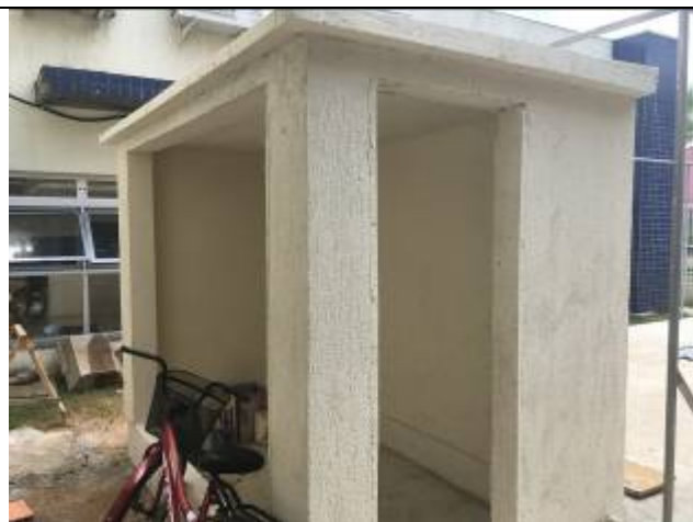
Figura 05: casa de bombas executada.
