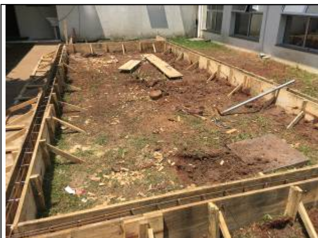
Figura 01: Execução das formas da base.
