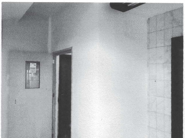
Figura 06: Instalação de parede drywall – escadas – térreo.
