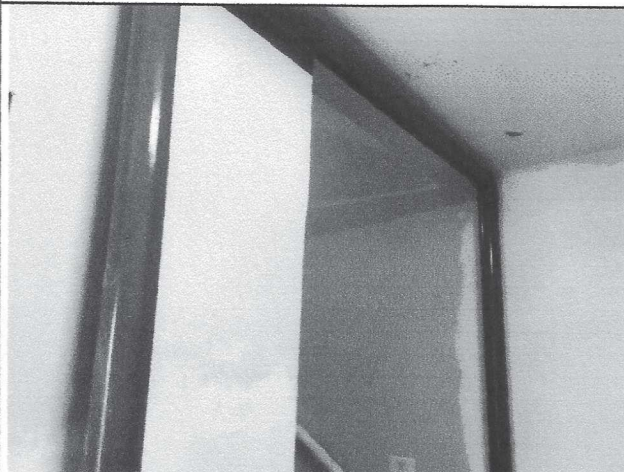
Figura 21: Pintura tubulação – 6º andar.
