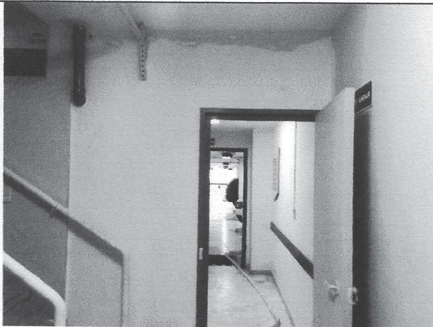
Figura 19: Emassamento parede dry-wall – 1º andar.
