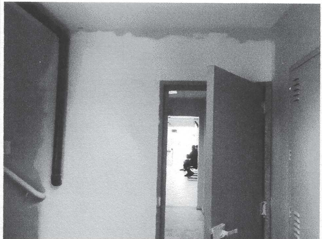
Figura 04: Instalação de parede drywall – escadas – 10º andar.
