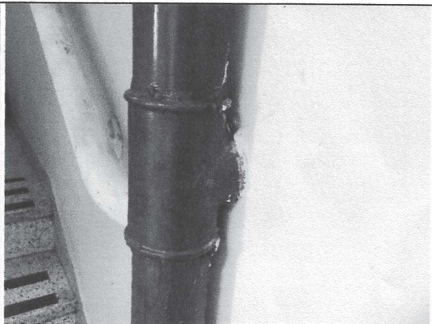
Figura 22: Pintura tubulação – 4º andar.
