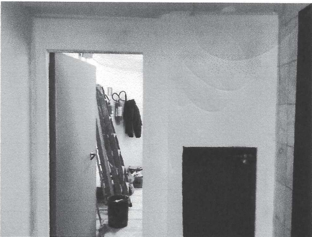
Figura 05: Instalação de parede drywall – escadas – 6º andar.
