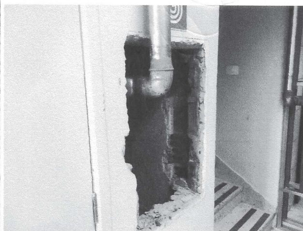
Figura 01: Remoção de hidrante existente.
