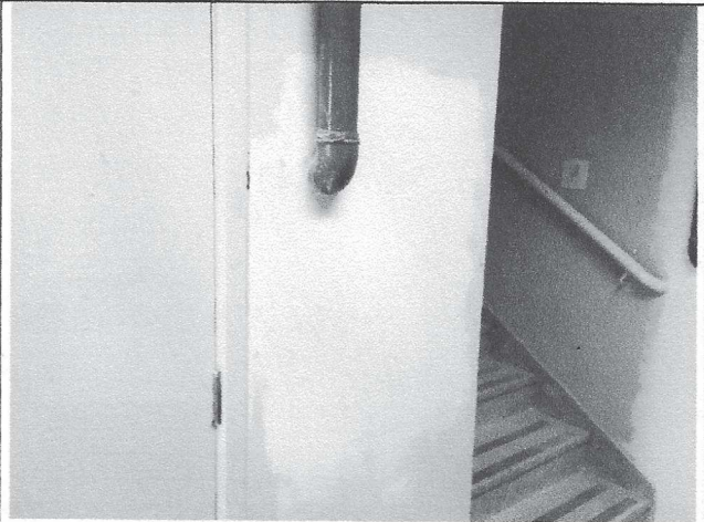
Figura 20 : Emassamento parede alvenaria – 8º andar.
