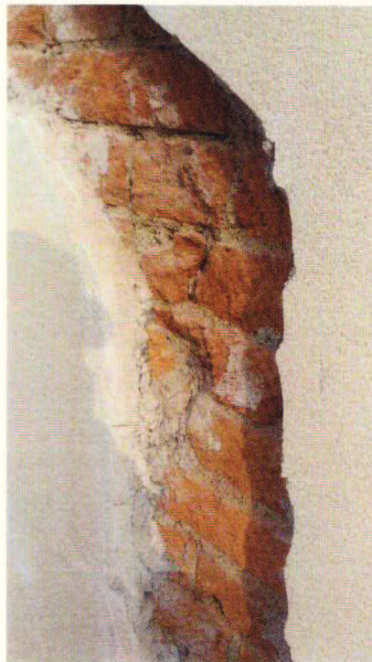
Figura 4 - tratamento de trincas e remoção de revestimento comprometido
