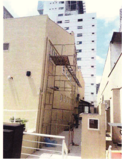
Figura 7 - Geral fachada dos fundos.
