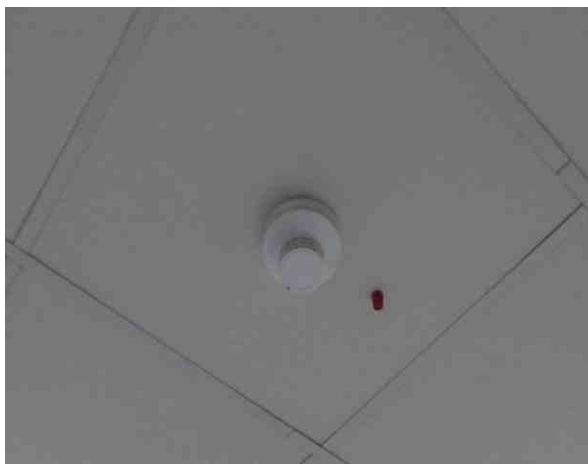
Figura 01: Retirada e recolocação de forro removível
