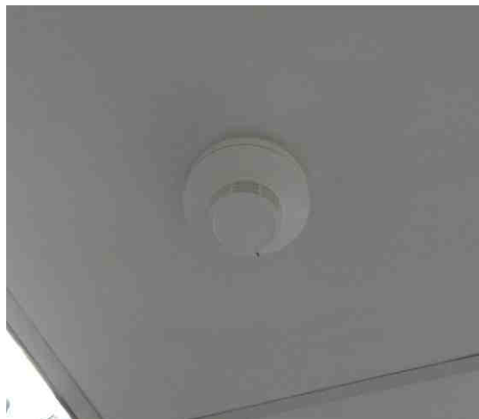
Figura 09: Detector óptico de fumaça
