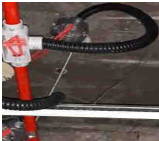
Figura 05: Eletroduto flexível metálico
