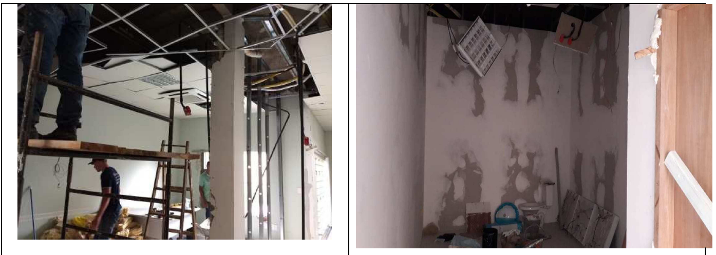
Figura 06 - Remoção de divisórias de gesso acartonado.
