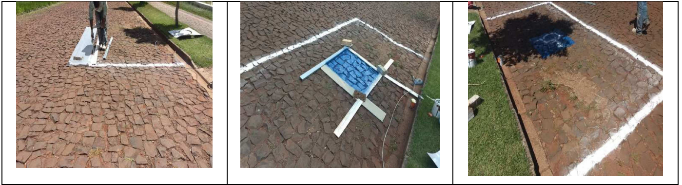
Figura 11 - Execução de vaga de PNE, na rua.
