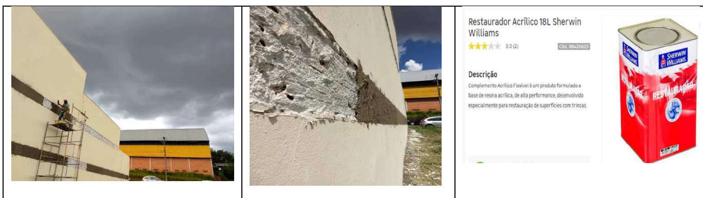
Figura 9 - Entelamento, emboço, restaurador de trincas e pintura em muro lateral.
