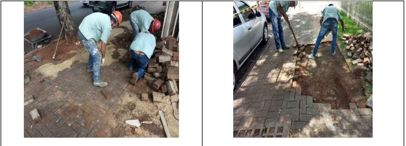
Figura 05 - Remoção calçadas externa
