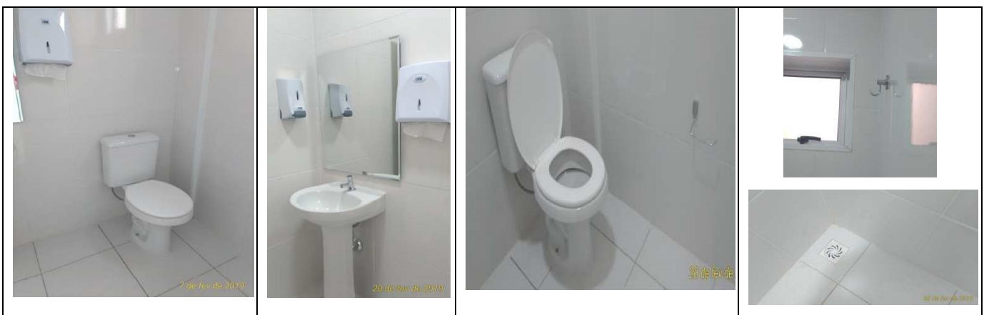
Figura 15 : Vaso Sanitário acessível, assento, válvula de descarga, acabamento Benefit, Lavatório suspenso, barras verticais no lavatório, barras no vaso, espelho, saboneteira, papeleiras, torneira presmatic, kit de emergência, caixa sifonada, toalheiro tipo gancho e ponto de ventilação do esgoto.
