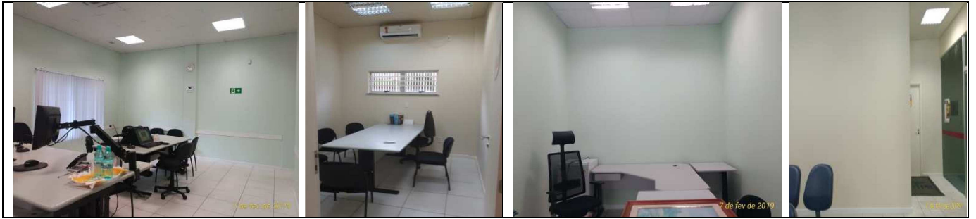
Figura 23 - Pintura interna - sala de audiência, conciliações, gabinete novo.
