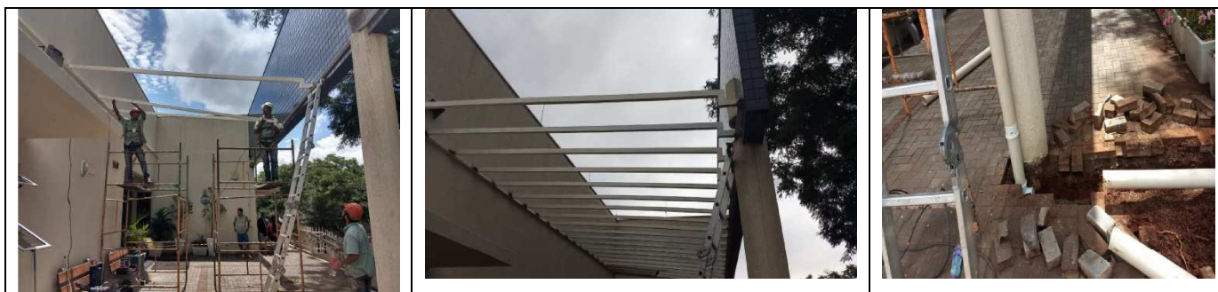
Figura 28 - Instalação de estrutura para cobertura em policarbonato.
