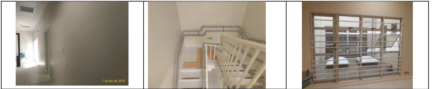
Figura 24 - Circulação, escada, paredes externas jardim.
