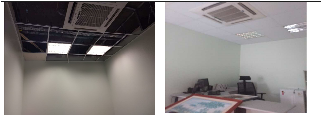
Figura 17: Adaptações no forro nas áreas de intervenções, no gabinete novo e banheiro.
