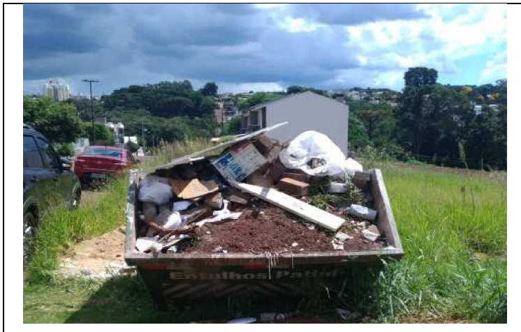
Figura 3 - Caçamba com entulhos da obra.
