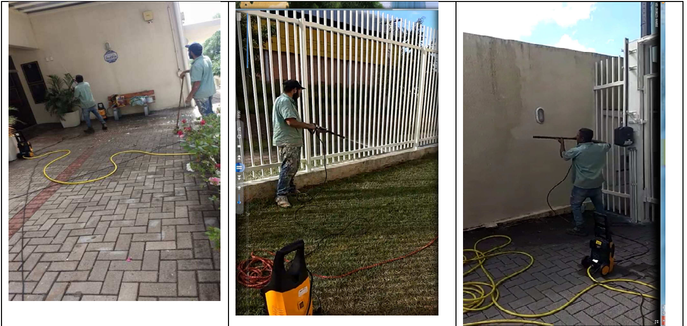
Figura 30 - Limpeza de superfícies e final de obra.
