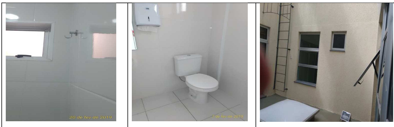
Figura 22 - Azulejos no banheiro do gabinete e peitoril nas janelas do gabinete e banheiro.
