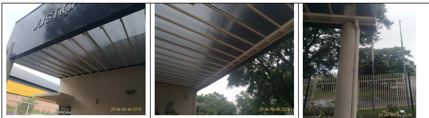
Figura 29 - Instalação de cobertura em policarbonato.
