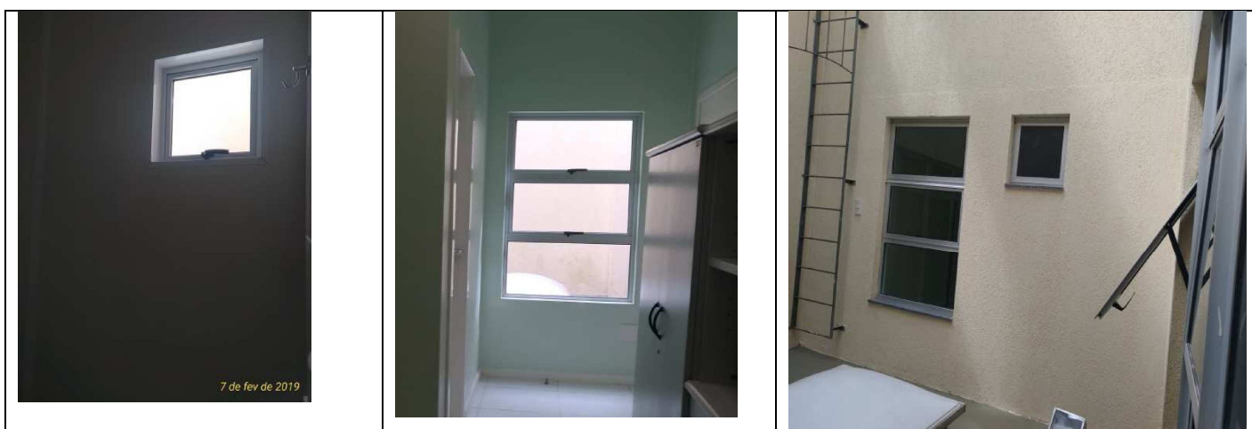
Figura 19: Fornecimento e instalação de janelas máximo ar no gabinete e banheiro do gabinete
