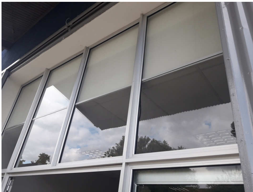
Figura 04: Esquadria DMP colocada.
