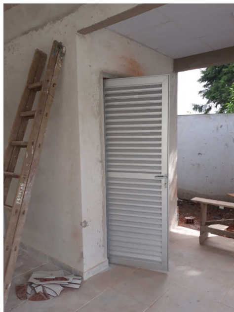
Figura 02: Estrutura do Banheiros já completa.
