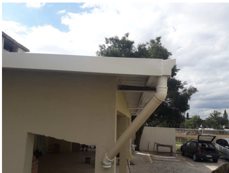
Figura 22 : beirais da cobertura e o acabamento metálico.
