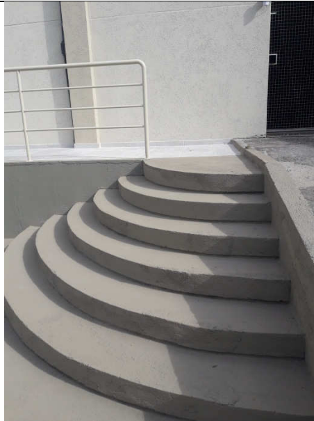
Figura 23: correção no piso de cimento queimado da escada.
