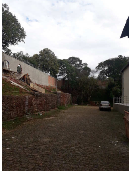
Figura 18 : Muro de arrimo pronto.
