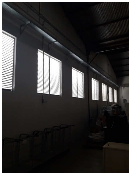
Figura 24: pinturas parede almoxarifado.
