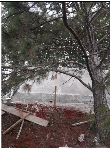
Figura 17 : Muro de arrimo pronto.
