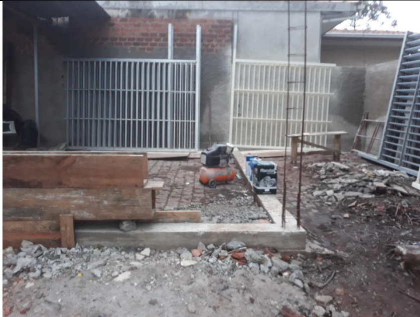
Figura 01: Estrutura do Banheiros sendo realizada.
