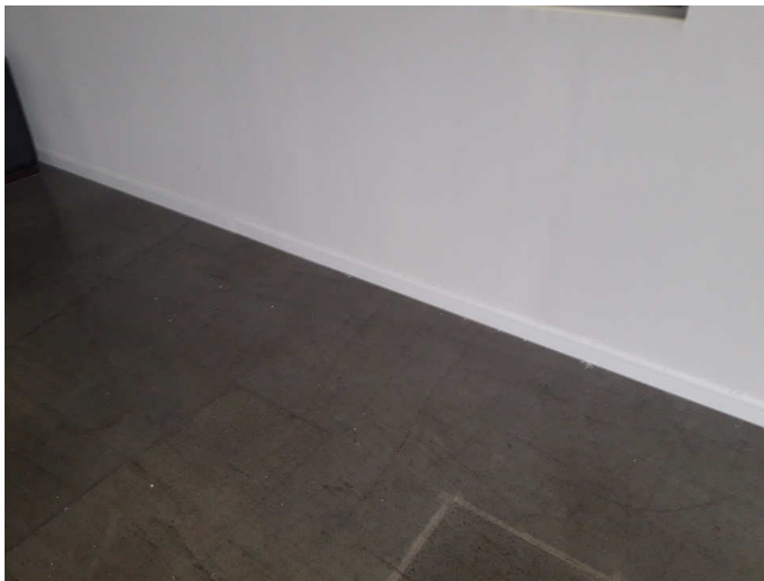
Figura 06: Rodapés DMP colocados.
