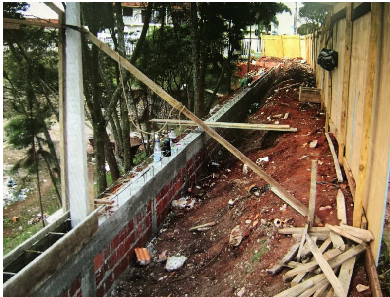
Figura 16 : Construção muro de arrimo.
