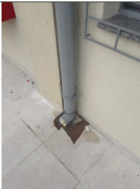
Figura 21 : corte do tubo em aço e instalação de joelho em PVC.
