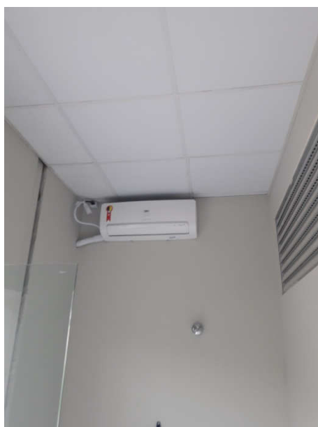
Figura 10: Parede de dry wall recomposta.
