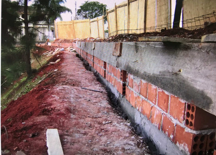
Figura 15 : Construção muro de arrimo.
