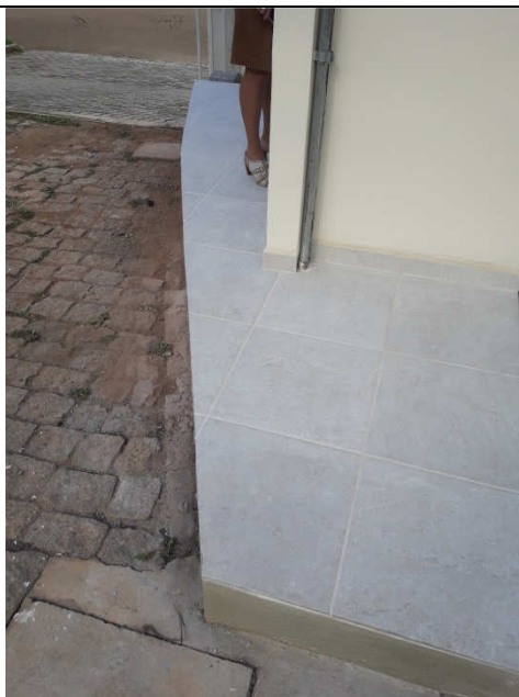
Figura 09: Piso cerâmico guarita central.
