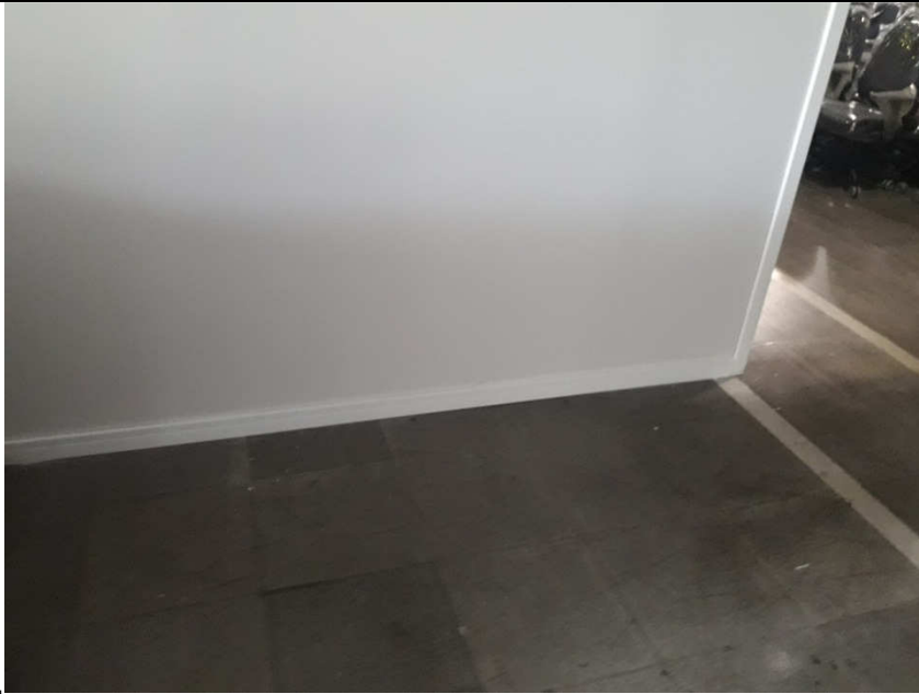
Figura 05: Rodapés DMP colocados.
