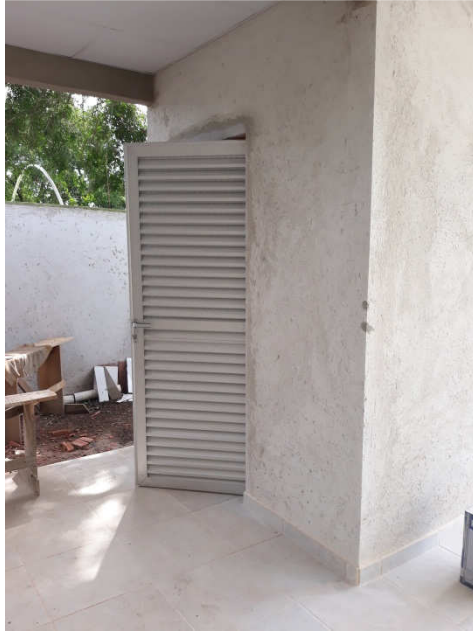
Figura 03: Estrutura dos Banheiros já completa.
