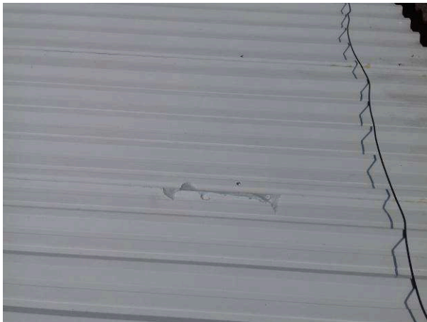
Figura 11: Fixação dos cabos de SPDA nas telhas
