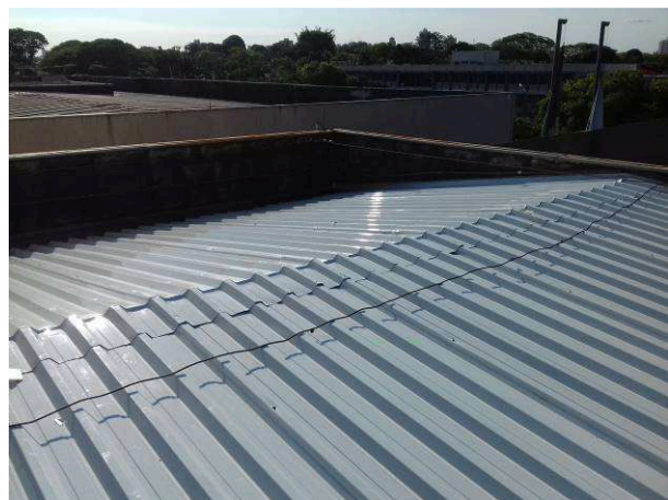
Figura 02: Instalação da telha sanduíche na região prevista - sobre o saguão
