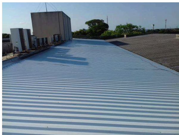
Figura 04: Instalação da telha sanduíche na região prevista - sobre o hall público
