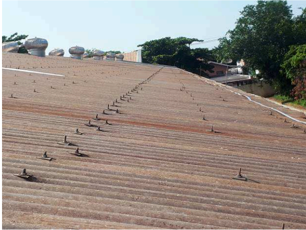
Figura 17: novo SPDA Barracão
