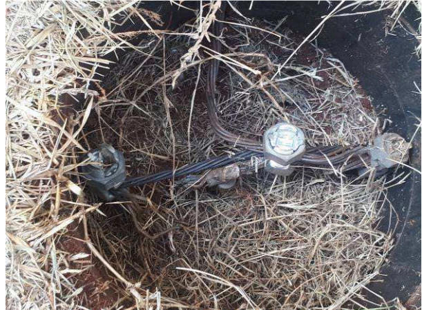
Figura 28: correção cabeamento de descida e malha - parte a ser mantida
