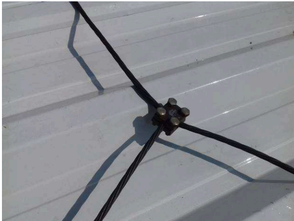
Figura 09: Religação dos elementos de SPDA
