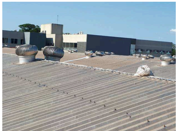
Figura 14: novo SPDA Barracão
