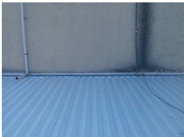
Figura 03: Instalação da telha sanduíche na região prevista - ao lado do reservatório
