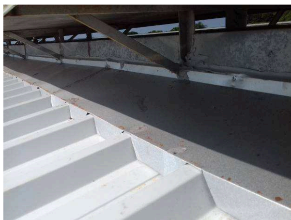
Figura 06: Detalhe dos rufos instalados - região das prateleiras de ar condicionado
