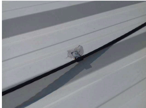
Figura 10: Fixação dos cabos de SPDA nas telhas
