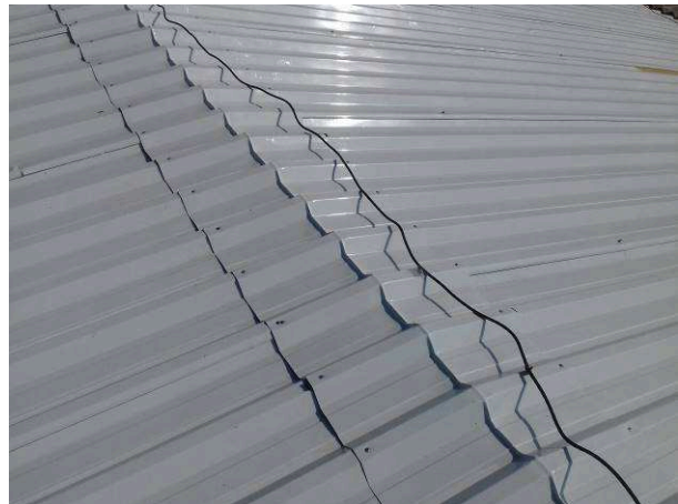
Figura 12: Fixação dos cabos de SPDA nas telhas
