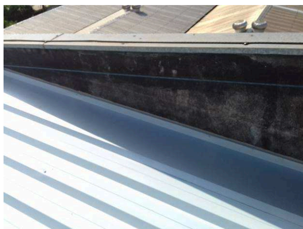
Figura 08: Detalhe dos rufos instalados - região do oitão
