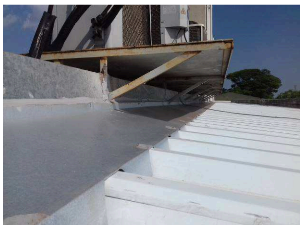
Figura 05: Detalhe dos rufos instalados - região das prateleiras de ar condicionado
