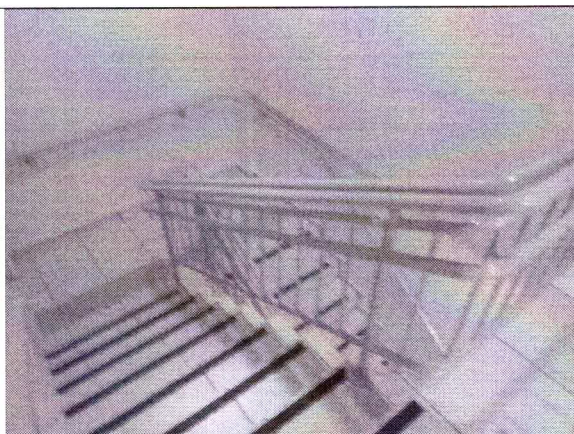
Figura 13 - Piso podotátil nas escadas.
