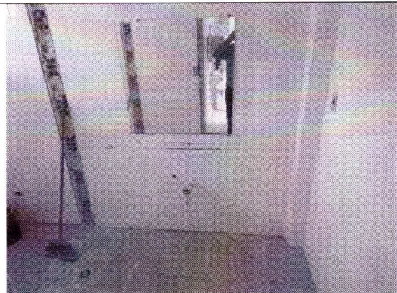
Figura 2: Retirada da bancada de granito do Banheiro da 1ª Vara.
