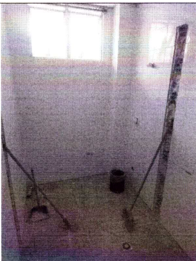
Figura 1: Retirada do piso do Banheiro da 1ª Vara.
