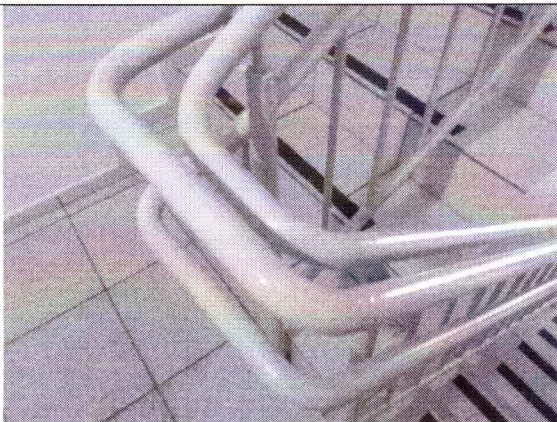
Figura 14 - Corrimão adaptado.
