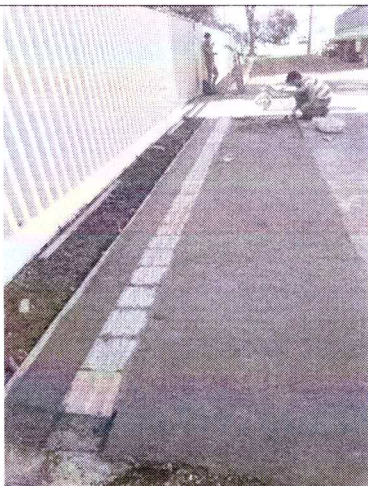
Figura 8 - Execução de piso de concreto não armado nas calçadas da Rua Guaiarica e Paricis.
