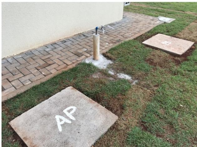
Figura 65C: Torneira de jardim, alimentada pela cisterna de reúso, localizada defronte a sala múltiplo-uso
