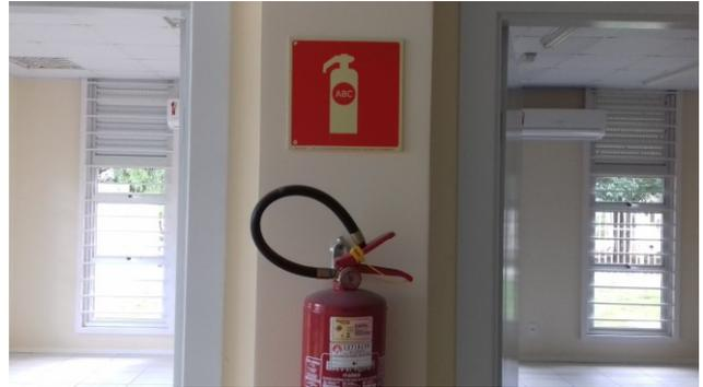
Figura 72C: Detalhe de placa de identificação de extintor
