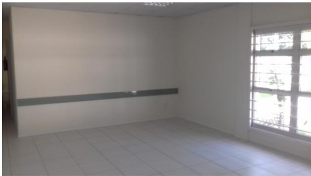
Figura 114C: Bate-cadeira, instalado na sala de audiência 1
