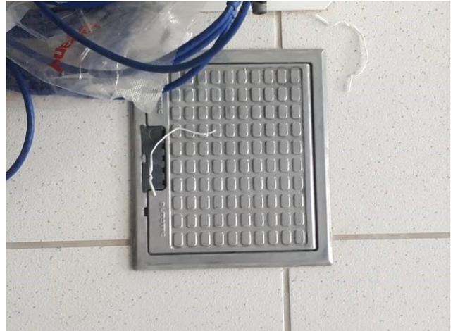
Figura 62E: Caixa de piso Dutotec.
