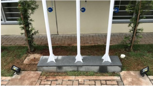
Figura 107C: Envernizamento das pedras da base dos mastros
