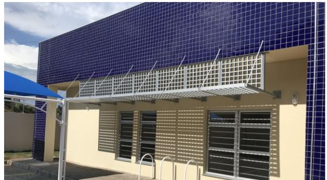
Figura 25C: Brises instalados na fachada esquerda
