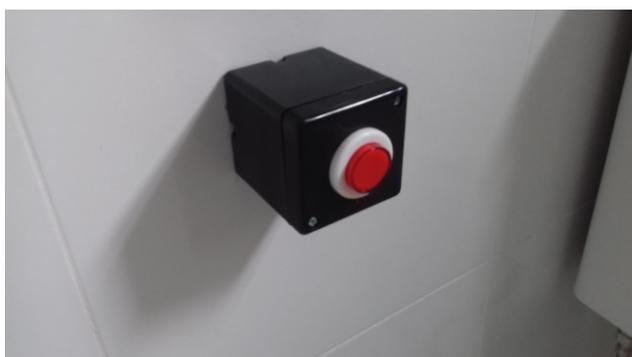
Figura 56C: Detalhe de botoeira para acionamento do kit de emergência, em sanitário PNE
