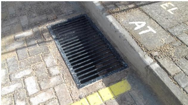
Figura 60C: Grelha metálica, instalada em boca-de-lobo do estacionamento público
