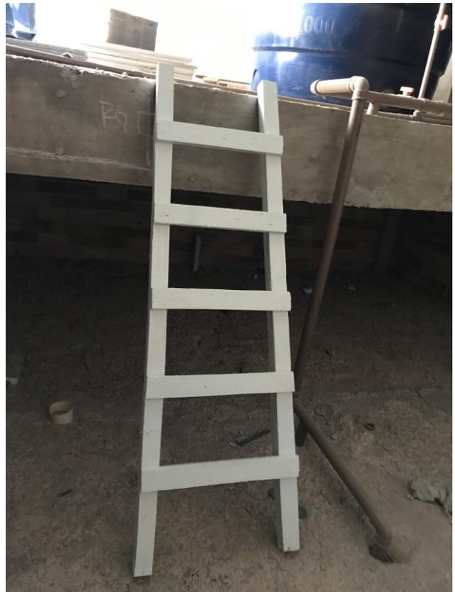
Figura 111C: Escada de madeira, instalada no barrilete
