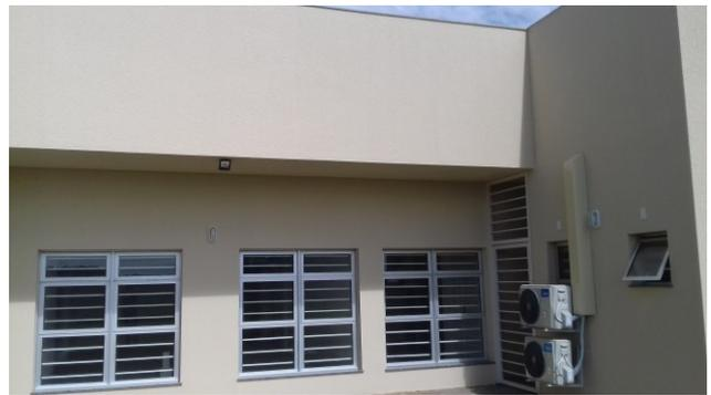
Figura 98C: Finalização da aplicação de textura nas paredes externas - fachada direita
