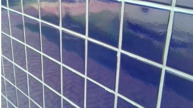
Figura 116C: Detalhe do rejunte epóxi, aplicado nas pastilhas
