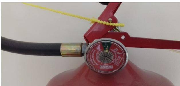
Figura 75C: Detalhe da carga no extintor
