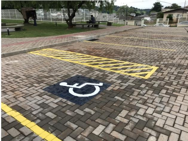
Figura 95C: Demarcação de vaga PNE para veículos no estacionamento público
