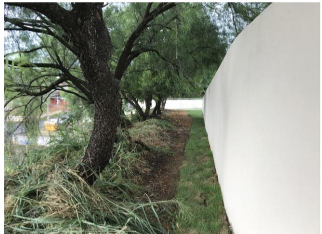
Figura 88C: Face posterior do muro, com segunda demão de pintura finalizada
