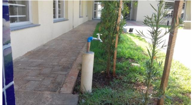
Figura 59C: Torneira de jardim, ligada à rede de água tratada, próxima à entrada principal da vara
