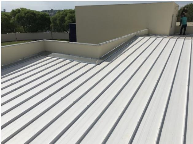
Figura 99C: Pintura da face interna das platibandas
