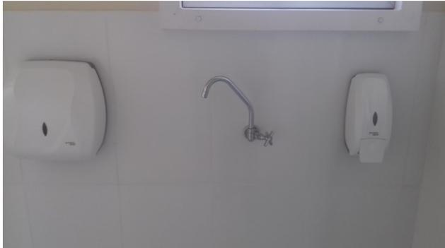
Figura 48C: Copa dos terceirizados, com torneira de bica alta móvel e kit porta papel toalha e saboneteira para sabonete líquido
