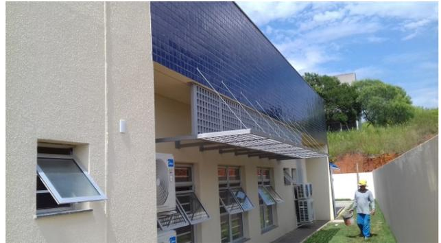
Figura 27C: Brises instalados na fachada dos fundos
