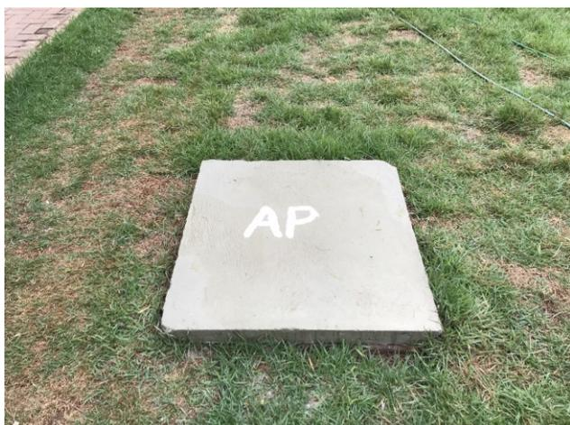
Figura 69C: Tapa de caixa de água pluvial - na parte frontal do imóvel
