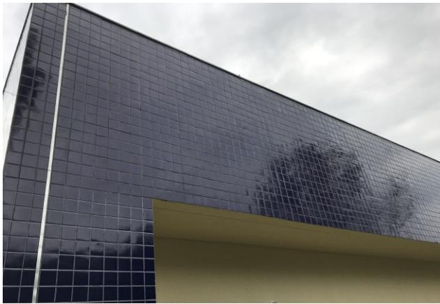
Figura 117C: Rejunte epóxi - lateral direita
