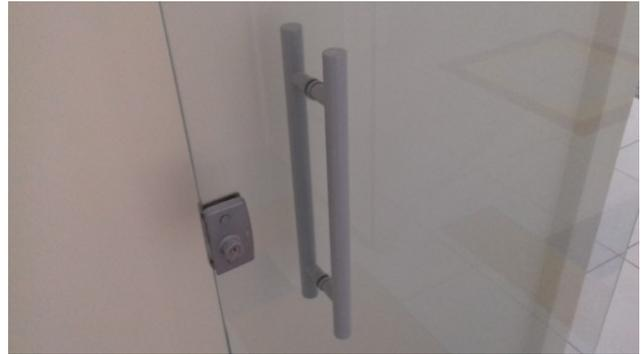
Figura 23C: Detalhe de puxador da porta de vidro temperado
