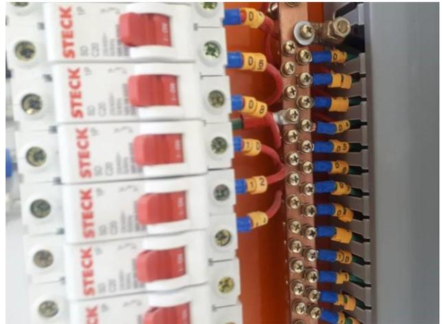
Figura 18E: Cabos elétricos.
