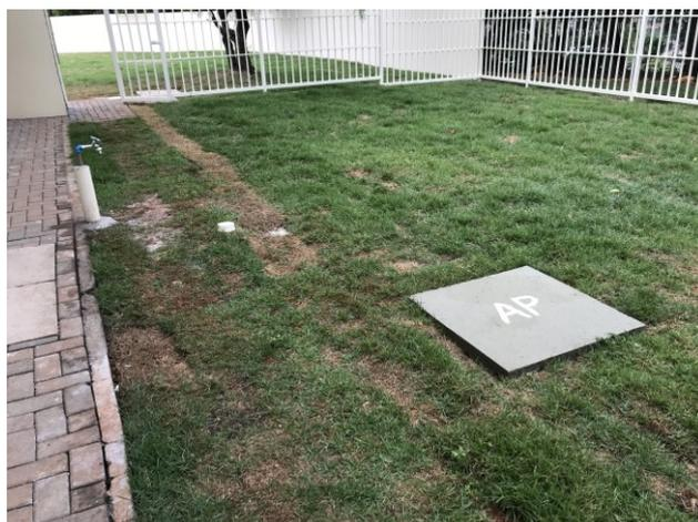
Figura 70C: Tapa de caixa de água pluvial - defronte o arquivo
