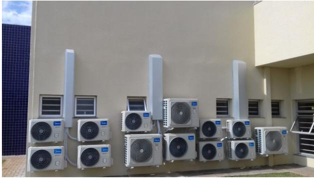
Figura 3C: Shafts dos aparelhos de ar condicionado
