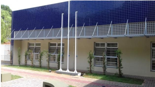
Figura 26C: Brises instalados na fachada frontal
