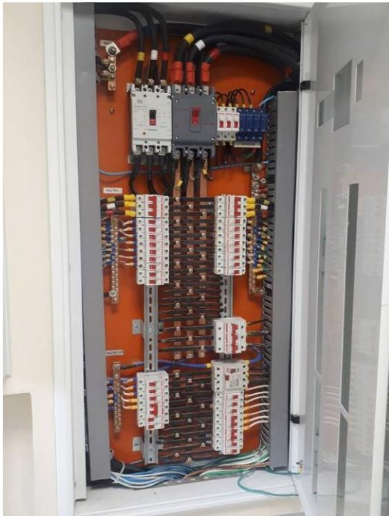
Figura 41E: Quadro elétrico QDG.
