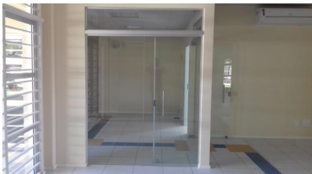
Figura 20C: Painel de vidro fixo, no hall público, junto à entrada principal, com bandeira fixa superior
