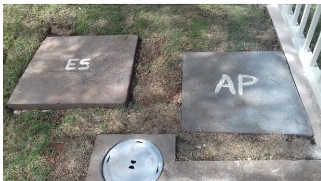
Figura 68C: Tampas de caixas de esgoto e pluvial
