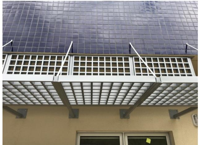
Figura 31C: Brises frontais, vistos de frente
