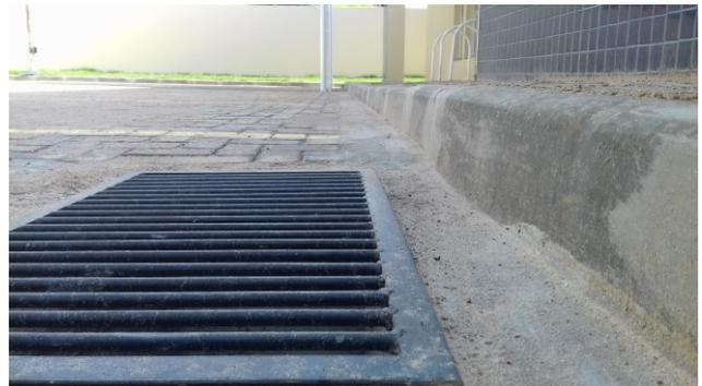
Figura 61C: Grelha metálica, instalada em boca-de-lobo do estacionamento privativo
