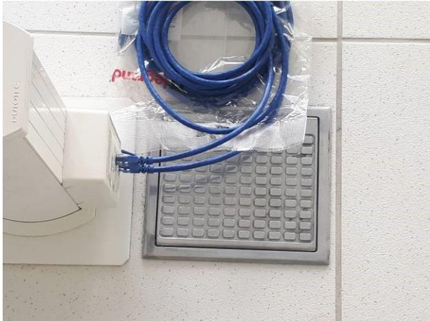
Figura 61E: Caixa de piso Dutotec.
