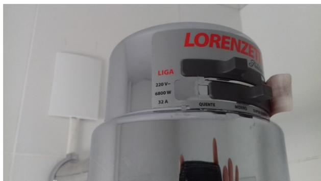
Figura 55C: Detalhe de chuveiro 220V x 6000W, instalado no vestiário feminino
