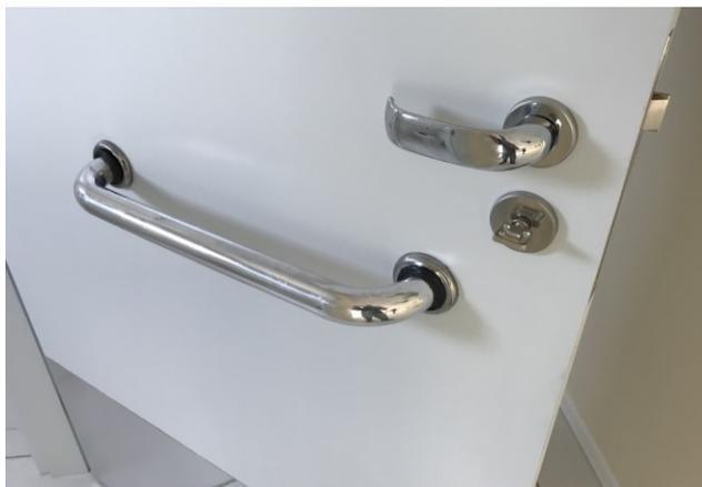
Figura 11C: Detalhe de Porta de banheiro PNE - Com barra de abertura
