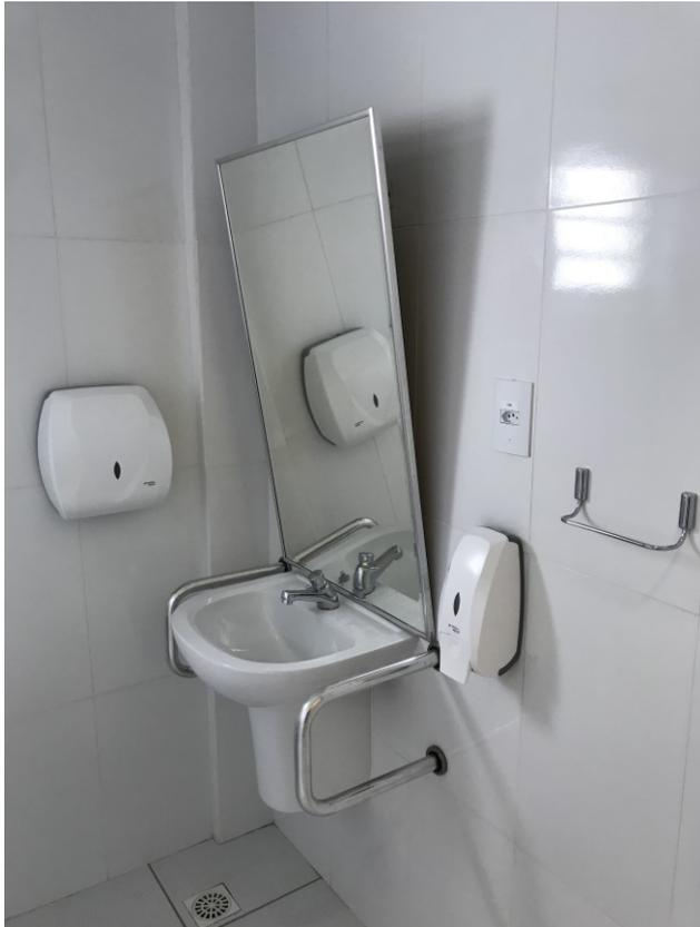
Figura 38C: Sanitário PNE, com lavatório suspenso, espelho inclinado, barras de acessibilidade do lavatório, papelheiro para papel-toalha, dispenser de sabonete líquido e cabideiro metálico
