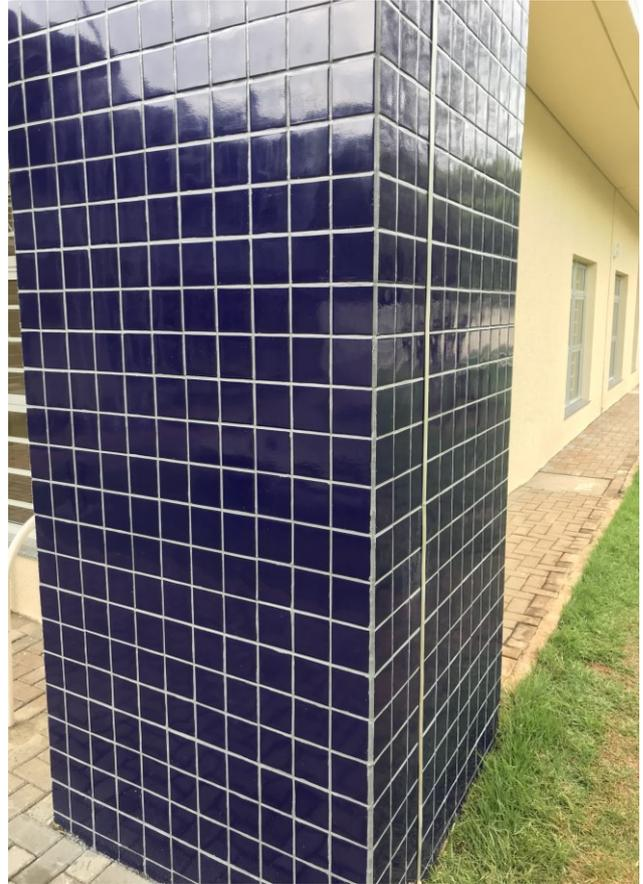
Figura 118C: Rejunte epóxi - coluna
