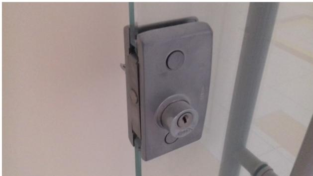
Figura 24C: Detalhe de fechadura da porta de vidro temperado
