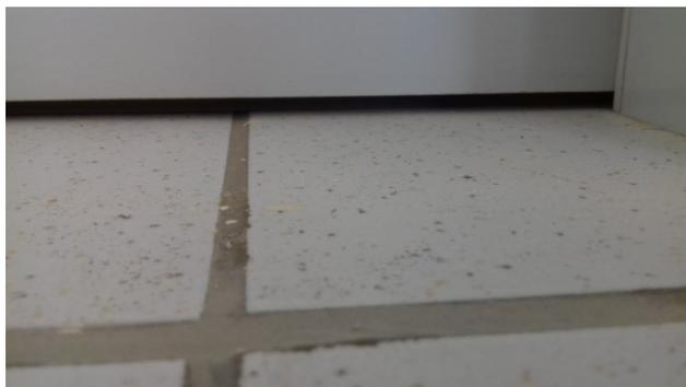
Figura 17C: Porta fechada, com baguete de isolamento acústico acionado
