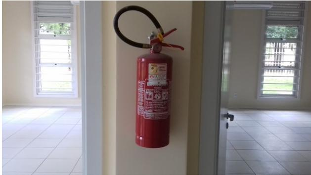
Figura 71C: Extintor ABC, instalado no corredor de acesso ao arquivo e sala múltiplo-uso
