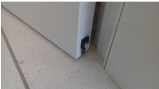
Figura 16C: Detalhe do acionador do baguete de isolamento acústico de piso
