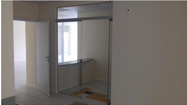
Figura 22C: Porta de vidro temperado, tamanho 90 x 210 cm e painel de vidro fixo ao lado da mesma. Detalhe do painel de vidro fixo acima da porta
