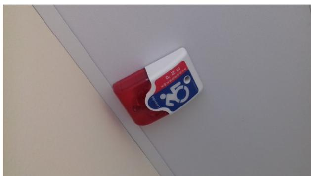
Figura 57C: Detalhe do alarme do kit de emergência, externamente a um sanitário PNE
