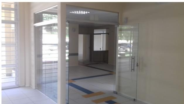
Figura 21C: Porta de vidro temperado, tamanho 180 x 210 cm, sendo duas folhas de 90 x 210 cm. Detalhe do painel de vidro fixo acima da porta
