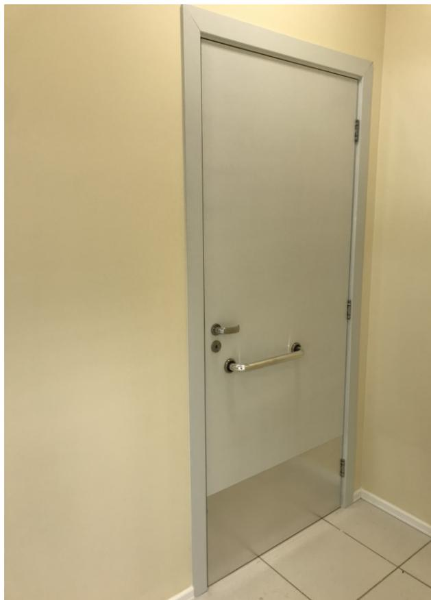
Figura 14C: Porta de sanitário público PNE, com barra de abertura e placa em laminado melamínico.
