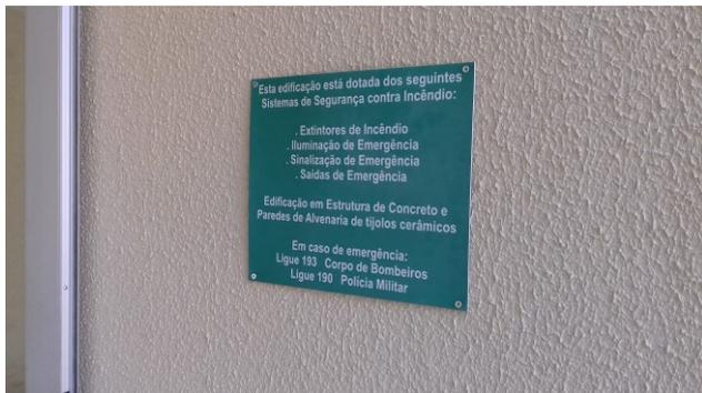
Figura 77C: Placa de orientação
