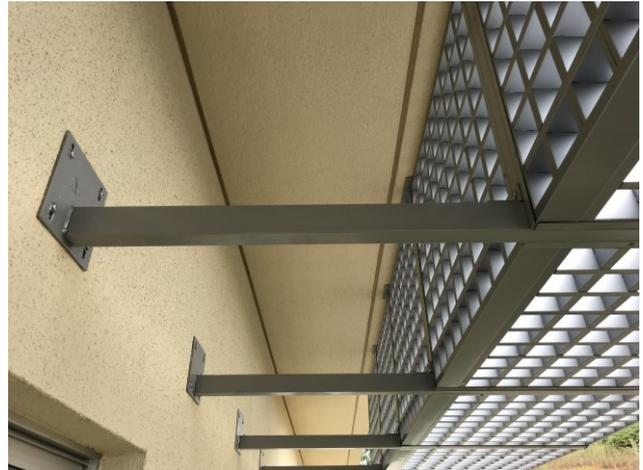
Figura 29C: Brise, no detalhe a estrutura de sustentação
