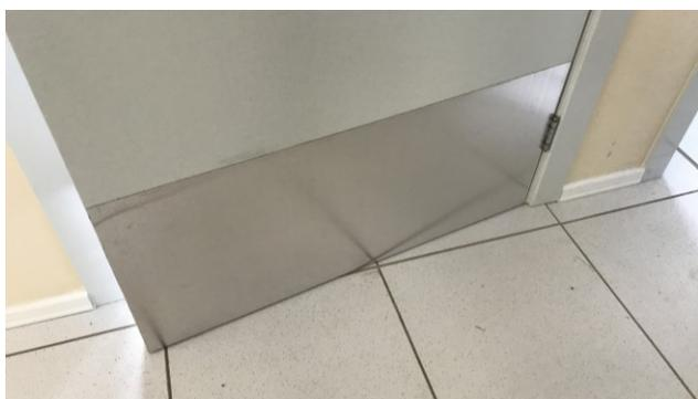
Figura 12C: Detalhe de placa em laminado melamínico - Banheiro PNE
