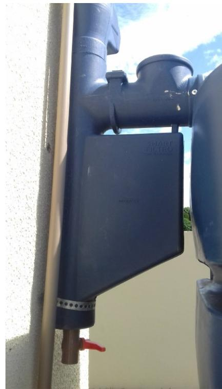
Figura 64C: Detalhe do filtro e do clorador da cisterna
