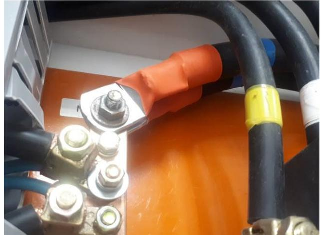
Figura 10E: Cabo alimentador QDG.
