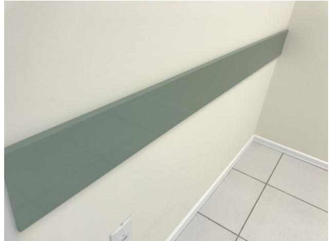
Figura 113C: Bate-cadeira, instalado na sala de audiência 2
