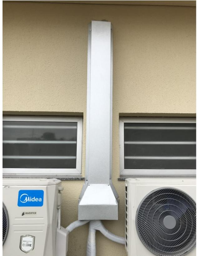
Figura 5C: Shafts dos aparelhos de ar condicionado
