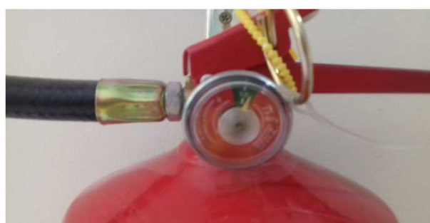
Figura 19C: Detalhe da carga e lacre - extintor do arquivo
