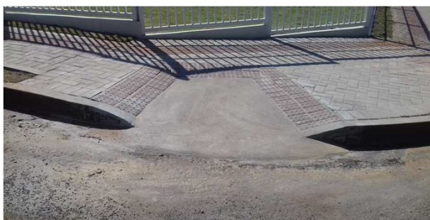
Figura 30C: Rampas de acesso PNE ao passeio público
