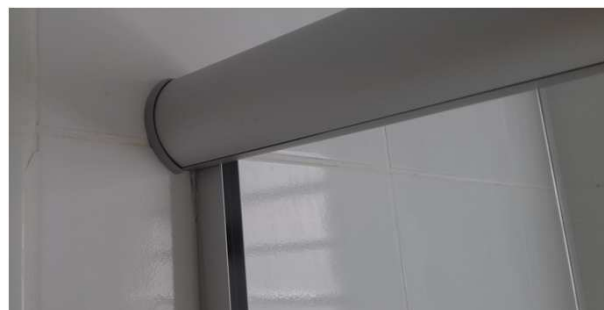
Figura 02C: Detalhe da esquadria de sustentação do box
