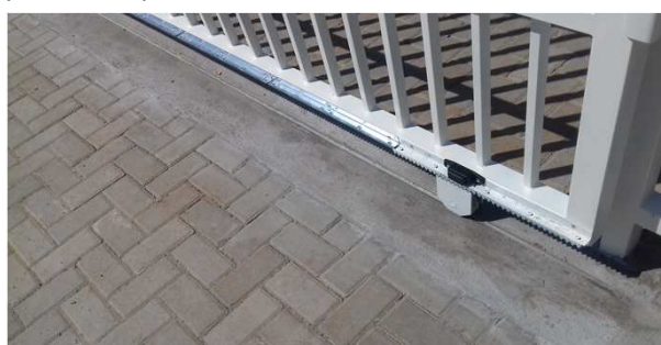
Figura 37C: Detalhe de cremalheira e trilho do portão
