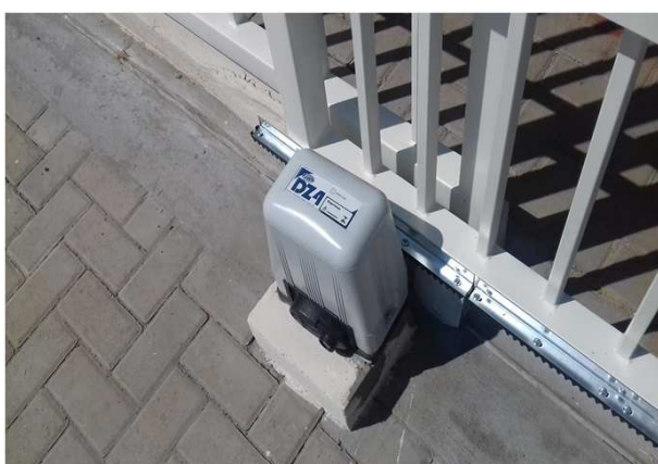
Figura 48C: Motor e cremalheira - automatização do portão de veículos
