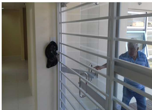
Figura 54C: Detalhe do gradil da porta da frente da VT
