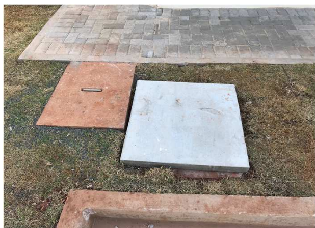
Figura 07E: Infraestrutura externa - cx 50x50
