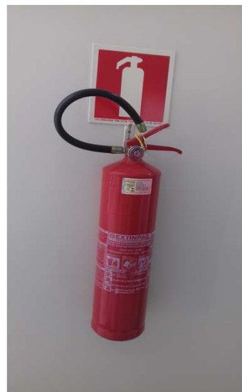
Figura 17C: Extintor ABC em sala de audiência
