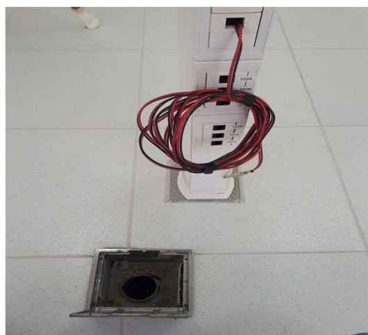
Figura 09E: cabeamento som e plugue p10
