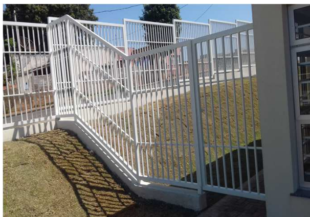
Figura 42C: Gradil, baldrame e portão - lateral esquerda
