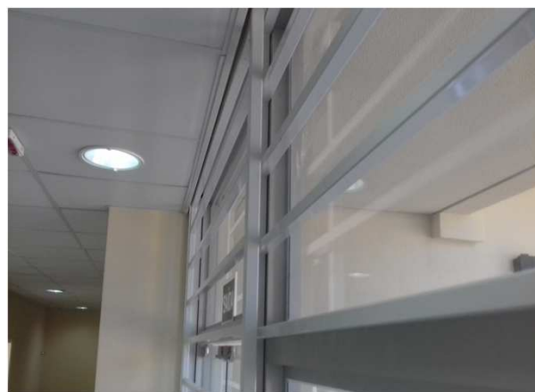
Figura 55C: Detalhe do gradil da porta da frente da VT
