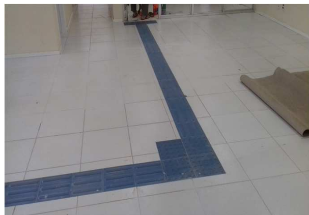
Figura 59C: Piso tátil, alcançando a porta de entrada do balcão de atendimento
