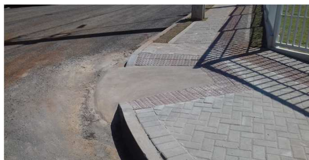
Figura 31C: Rampas de acesso PNE ao passeio público
