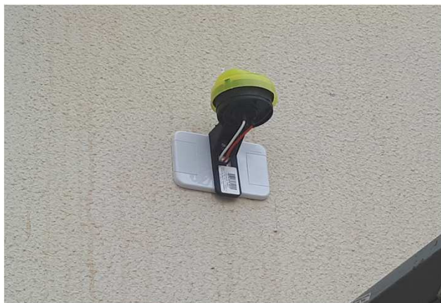
Figura 05E: Iluminação externa - fotocélula
