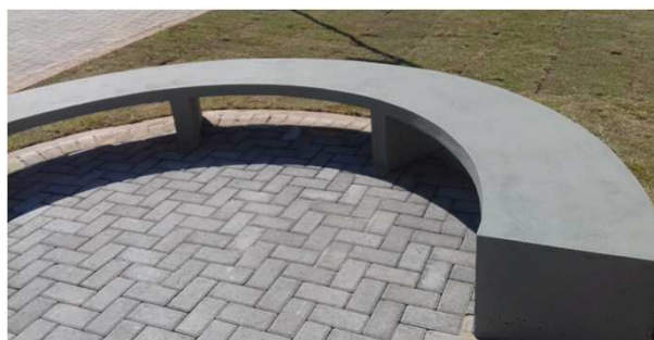
Figura 41C: Pintura em bancos de concreto
