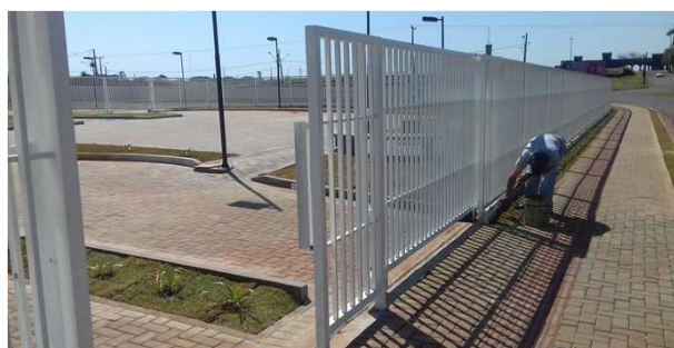
Figura 32C: Portão de acesso de veículos ao interior da vara
