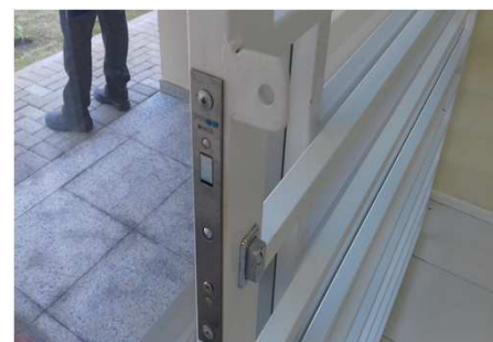
Figura 53C: Fechadura e trincos - grade da porta da frente
