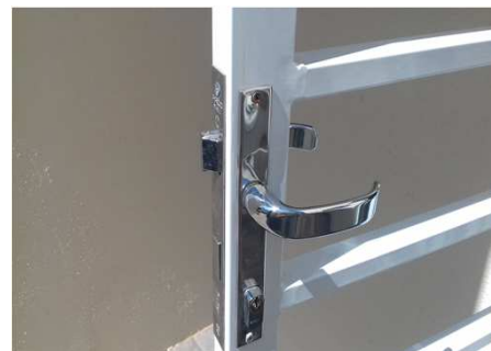
Figura 52C: Detalhe de maçaneta e trinco - grade da porta dos fundos da secretaria
