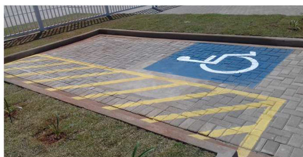
Figura 38C: Demarcação de vaga PNE - Estacionamento público
