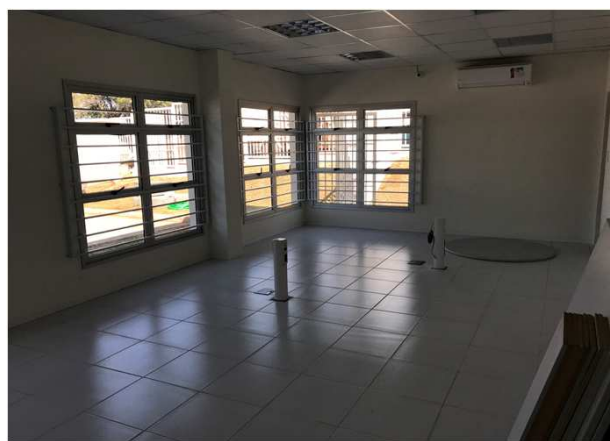
Figura 14E: pontos para CFTV e mic audiências
