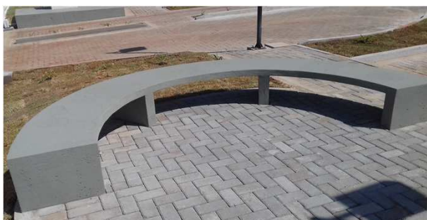
Figura 40C: Pintura em bancos de concreto
