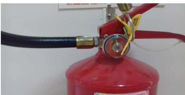
Figura 22C: Detalhe de carga e lacre - extintor do hall público
