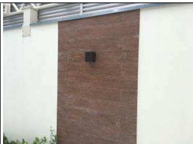
Figura 02C: Revestimento cerâmico - parede
