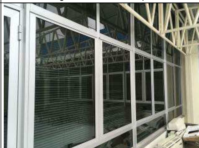
Figura 06C: Novas esquadrias instaladas
