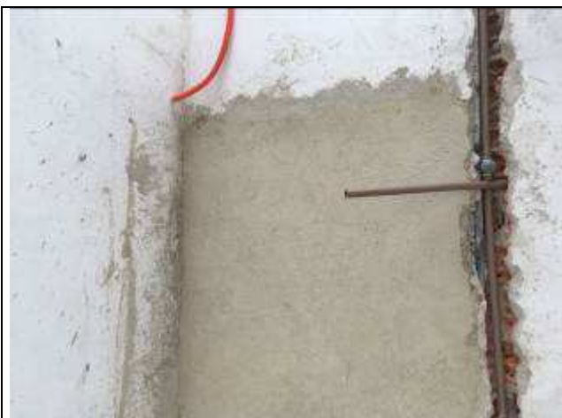
Figura 11C: fechamento de alvenaria
