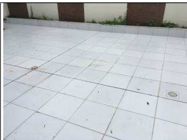
Figura 01C: Piso cerâmico instalado.
