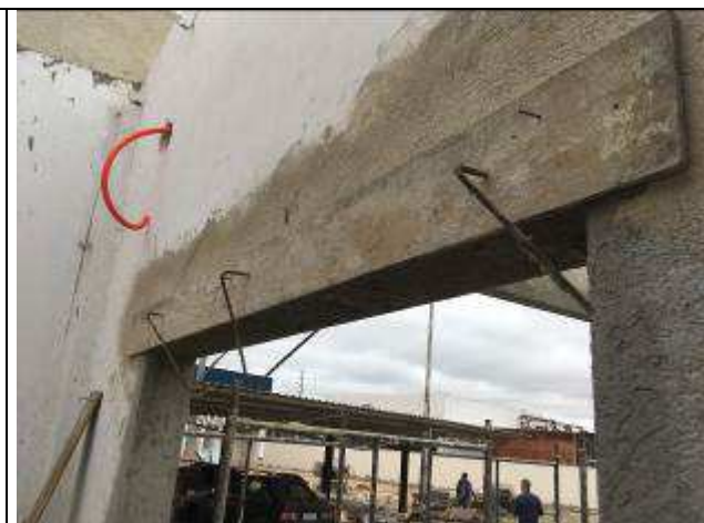
Figura 12C: vergas de concreto
