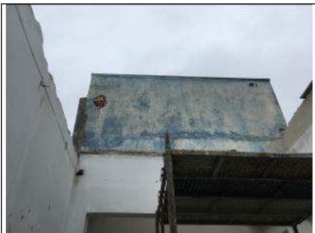
Figura 23C: telhas e caixa d'água removidas
