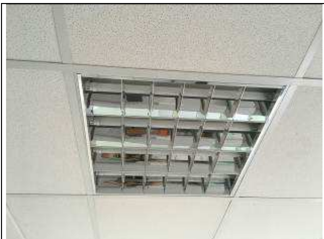
Figura 19C: novas luminárias e novo forro - copa
