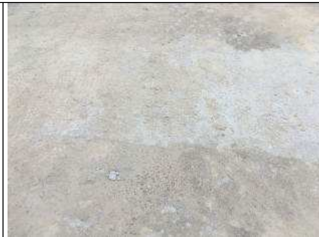
Figura 10C: preenchimento de vazios
