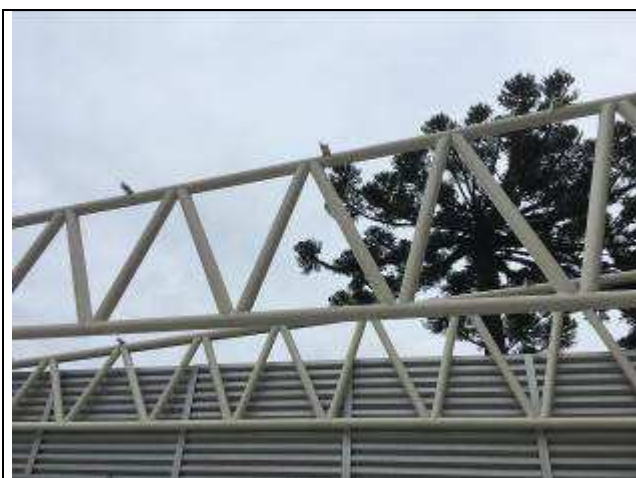
Figura 13C: telhas retiradas
