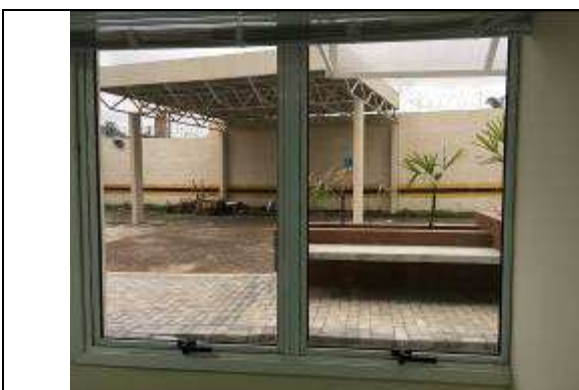
Figura 07C: Nova esquadria instalada
