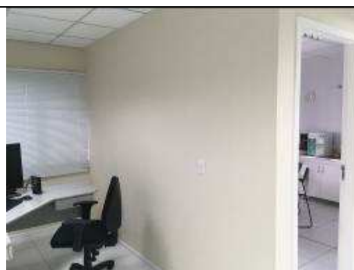
Figura 08C: Parede da ampliação
