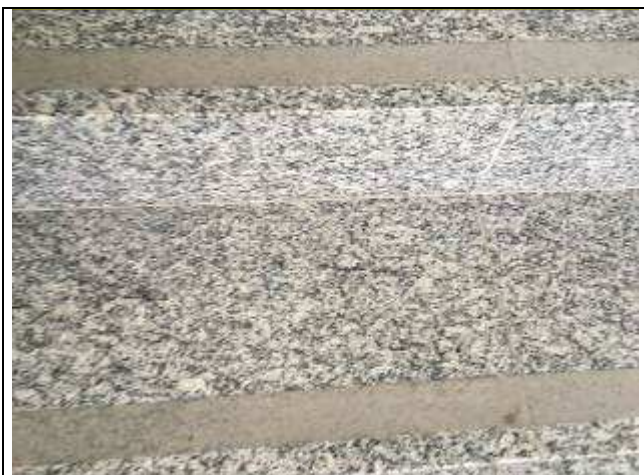
Figura 22C: fita antiderrapante instalada
