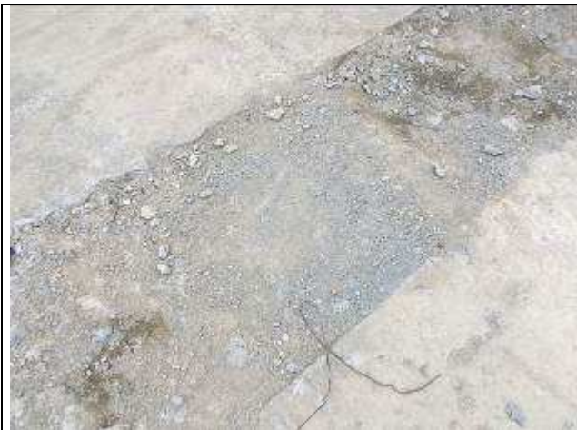
Figura 09C: preenchimento de vazios
