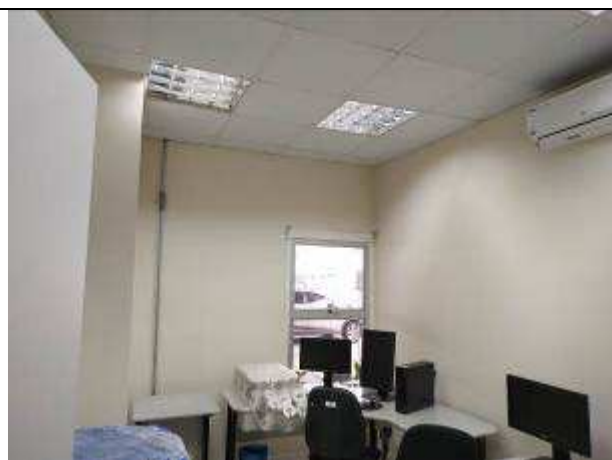
Figura 13E - Substituição de lâmpadas (5ª VT)
