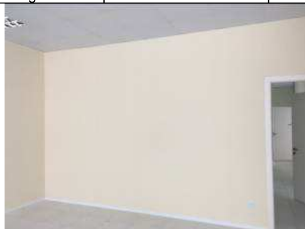
Figura 08C - pintura interna - 4ª VT
