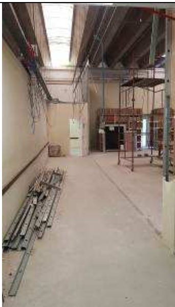
Figura 09C - demolições e retiradas - área da futura COCAPE
