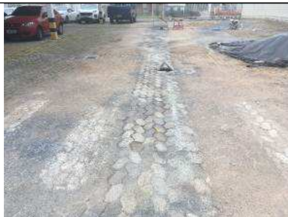
Figura 31C - tubulação de interligação ao hidrante de passeio - finalizada
