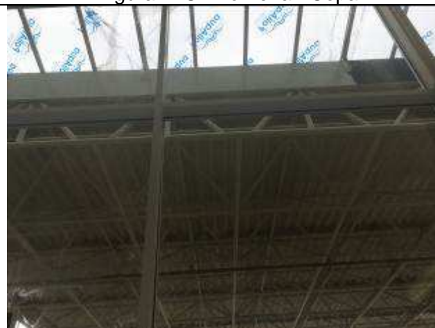
Figura 26C - estrutura de alumínio para fixação de vidros temperados - finalizada
