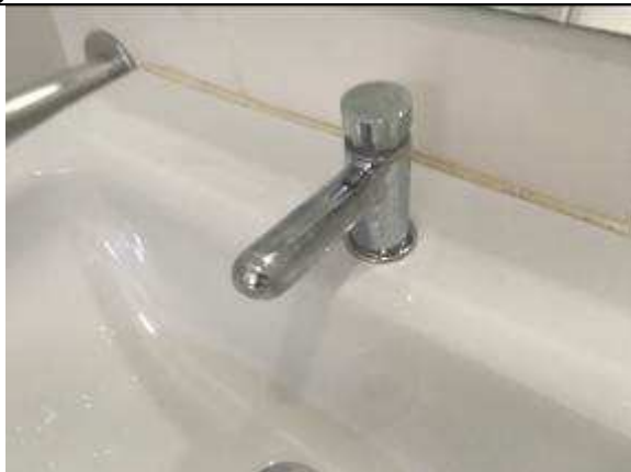
Figura 19C - metais reinstalados - 5ª VT
