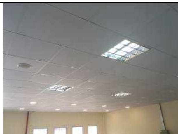
Figura 02C - forro instalado - hall público - 4ª VT
