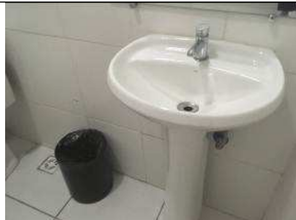
Figura 20C - bacia comum reinstalada - 5ª VT
