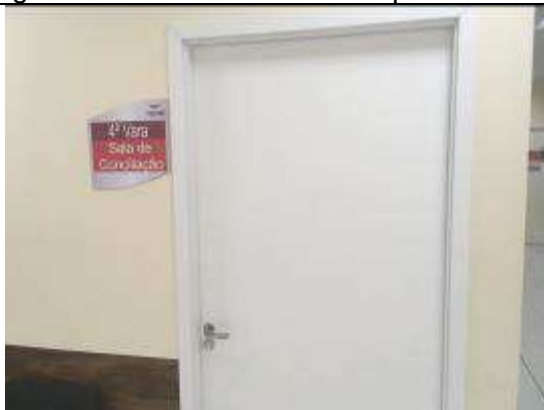
Figura 05C - portas instaladas - 4ª VT
