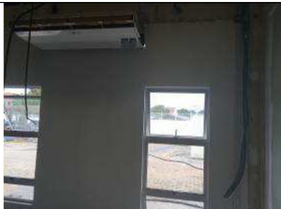
Figura 11C - fechamento alvenaria COCAPE
