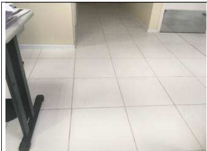
Figura 13C - Piso instalado - 5ª VT
