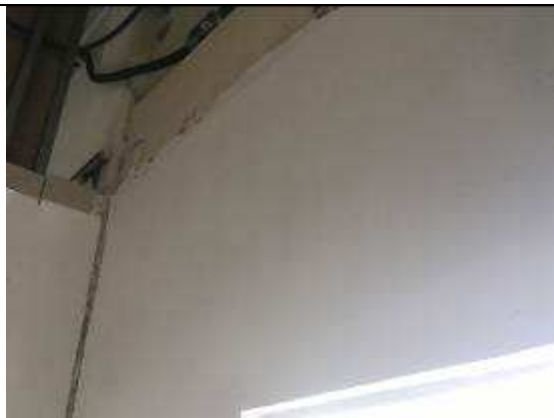
Figura 12C - massa única - fechamento em alvenaria - COCAPE
