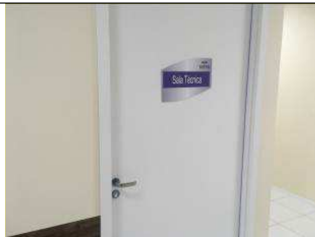
Figura 04C - portas instaladas - 4ª VT
