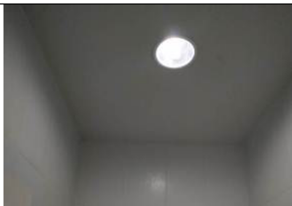
Figura 19E - Substituição de lâmpada bulbo
