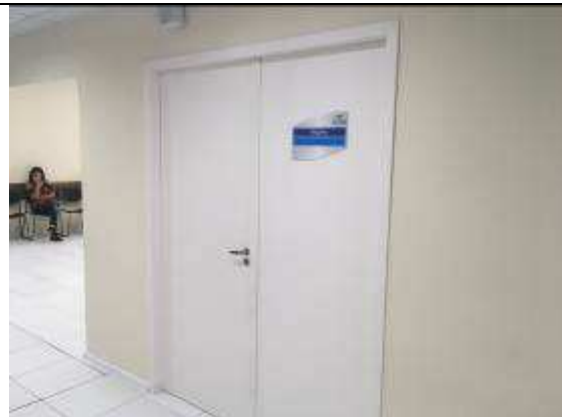
Figura 06C - porta instalada - novo arquivo
