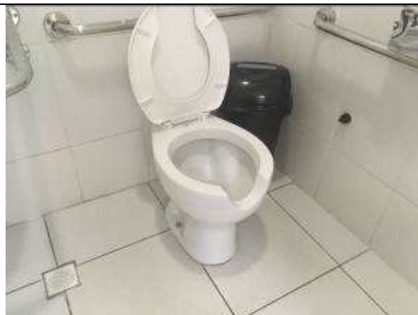
Figura 16C - vasos reinstalados - 5ª VT
