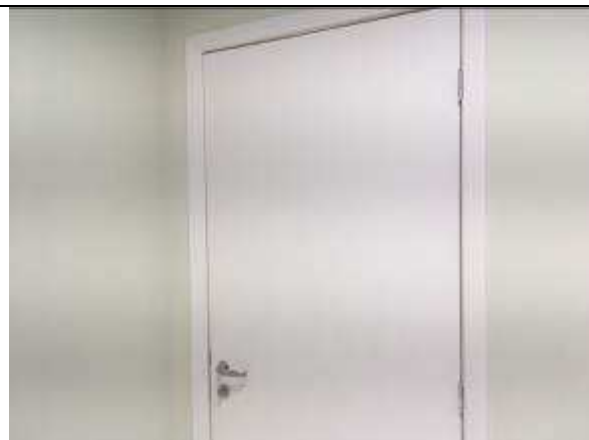
Figura 22C - portas reinstaladas - 5ª VT
