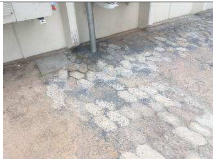
Figura 30C - tubulação de incêndio interligada ao hidrante de passeio
