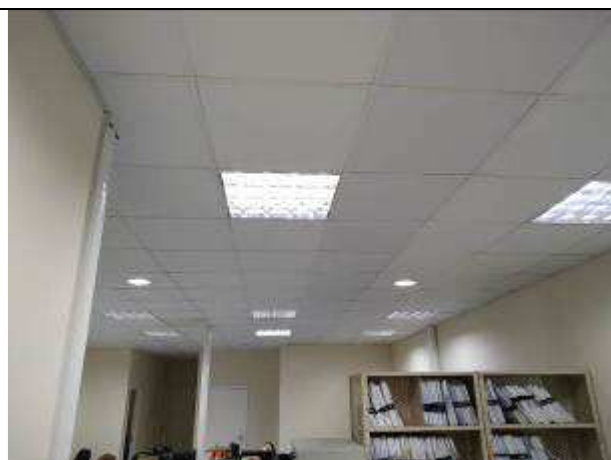
Figura 12E - Substituição de lâmpadas (5ª VT)
