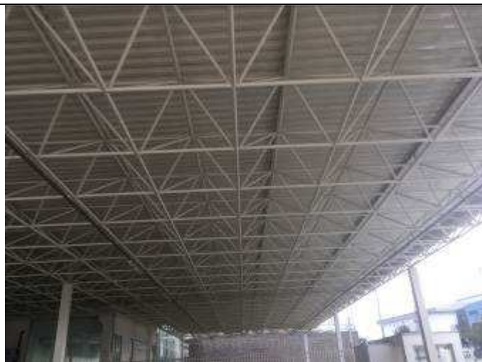
Figura 33C - Pintura estrutura espacial - cobertura de veículos
