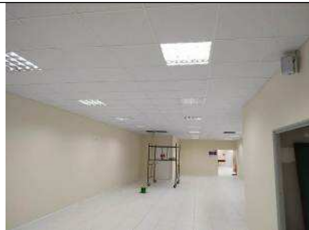
Figura 10E - Substituição de lâmpadas
