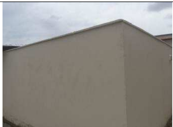
Figura 29C - pintura - muro área de serviço
