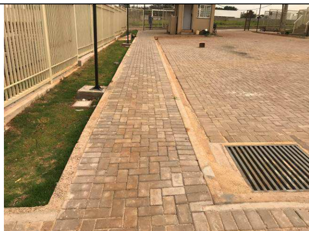
Figura 83C: Pavimentação intertravada - calçadas do estacionamento frontal.
