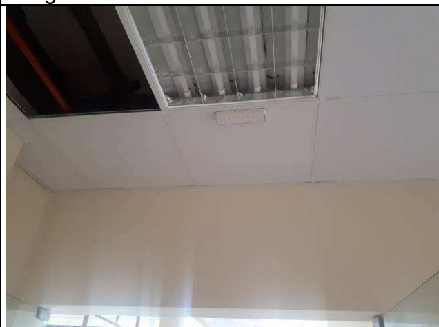
Figura 19E: iluminação interna - blocos de emergência
