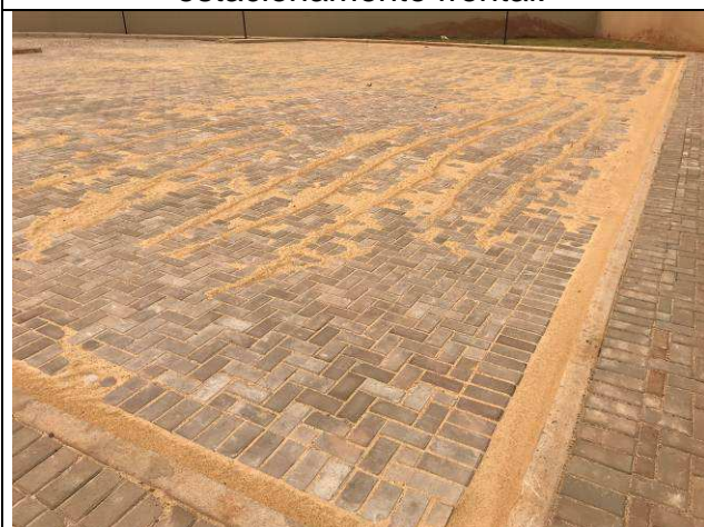
Figura 73C: Pavimentação intertravada - estacionamento frontal.
