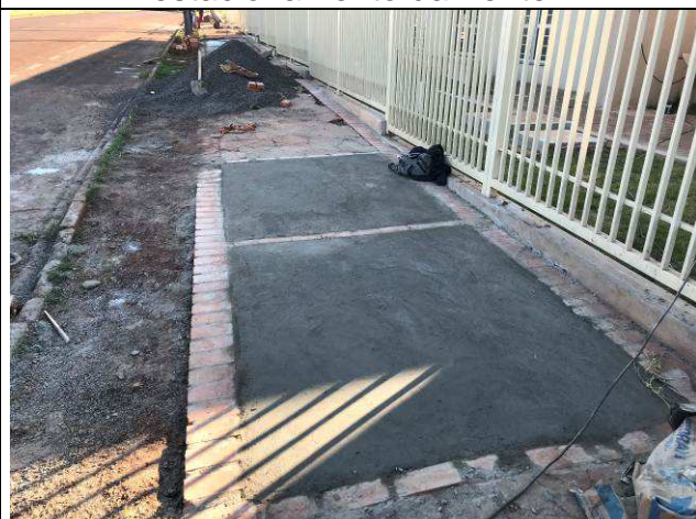
Figura 91C: Refazimento da calçada do passeio público.
