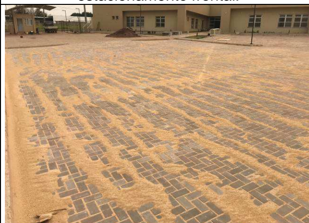
Figura 74C: Pavimentação intertravada - estacionamento frontal.
