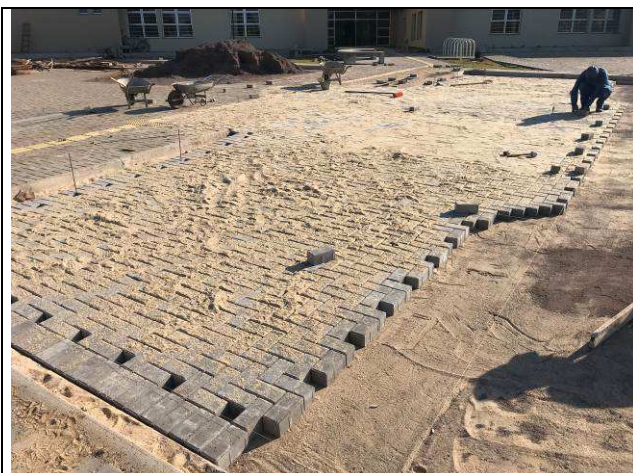
Figura 69C: Pavimentação intertravada - estacionamento frontal.
