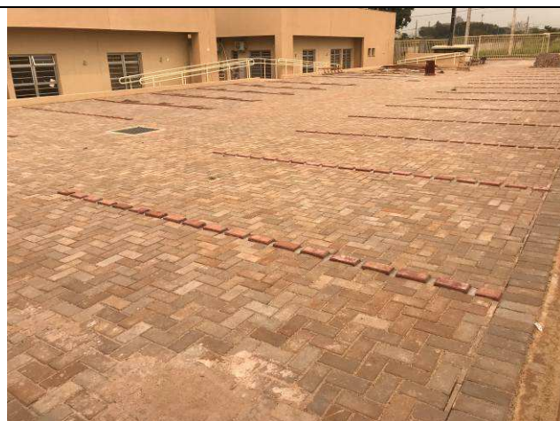
Figura 77C: Pavimentação intertravada - estacionamento fundos.
