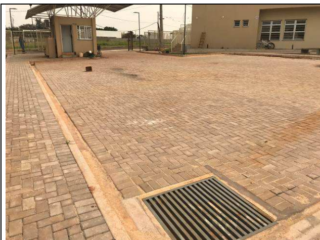
Figura 71C: Pavimentação intertravada - estacionamento frontal.
