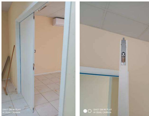
Figura 09C: Porta de madeira - Auditório.
