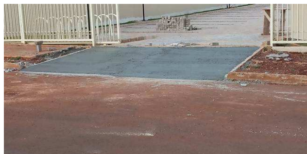
Figura 85C: Entrada de veículos - estacionamento dos fundos.
