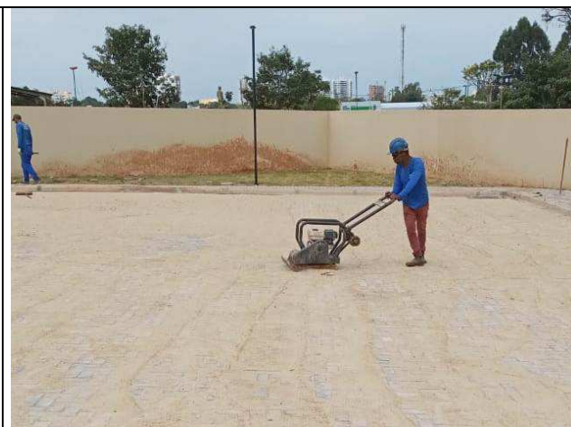
Figura 70C: Pavimentação intertravada - estacionamento frontal.
