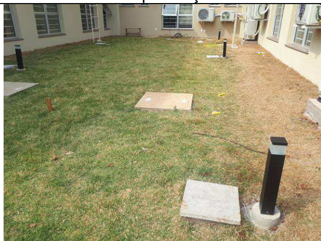
Figura 24E: iluminação externa - postes balizadores
