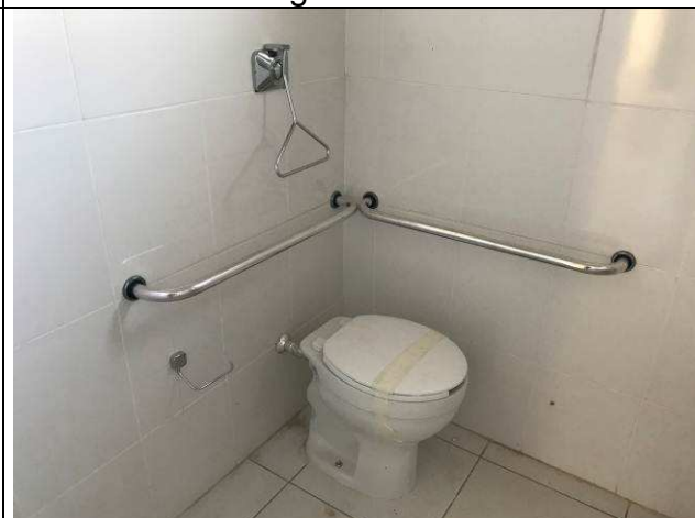
Figura 28C: Acabamento válvula de descarga - BWC PNE.
