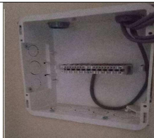
Figura 40E: DG Telefonia e blocos
