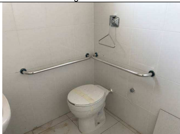
Figura 27C: Acabamento válvula de descarga - BWC PNE.
