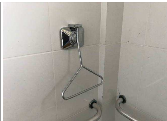
Figura 24C: Acabamento válvula de descarga - BWC PNE.
