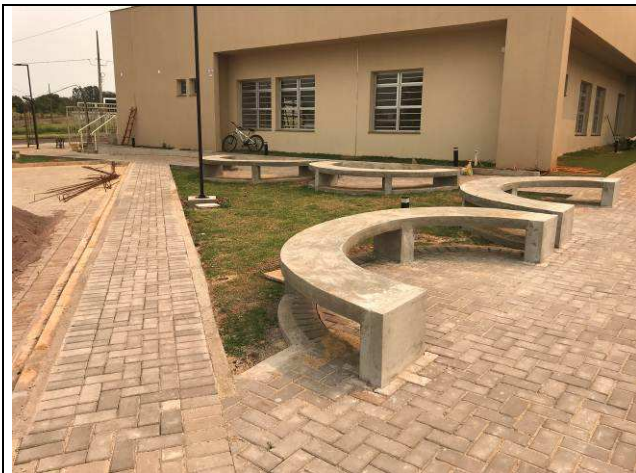
Figura 95C: Bancos de concreto.
