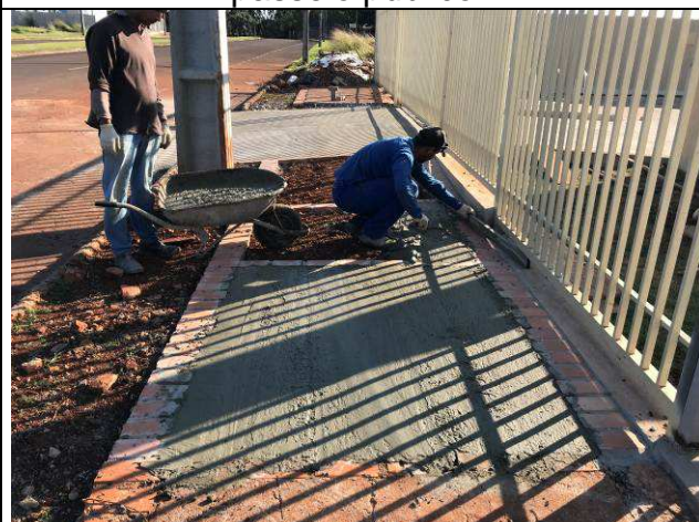
Figura 92C: Refazimento da calçada do passeio público.
