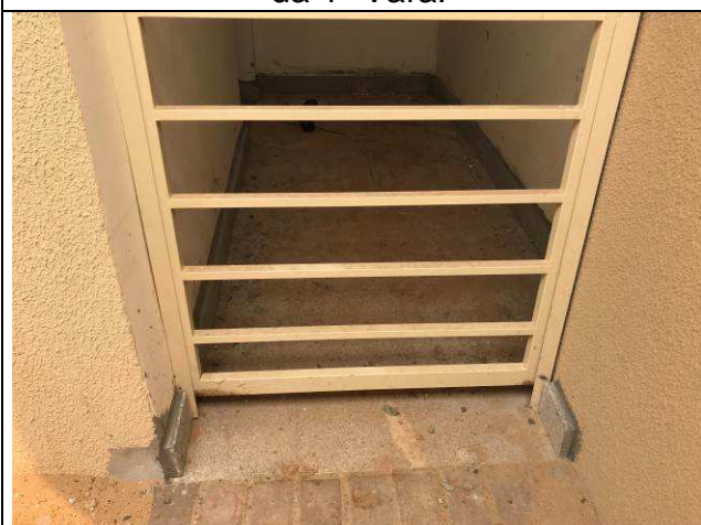
Figura 17C: Rodapés em granito - entrada da área de terceirizados.
