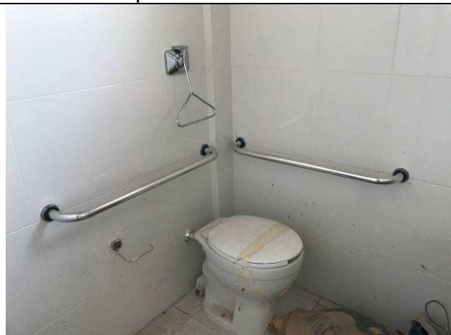
Figura 25C: Acabamento válvula de descarga - BWC PNE.
