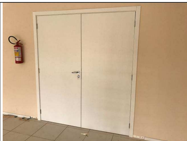
Figura 08C: Porta de madeira - Auditório.
