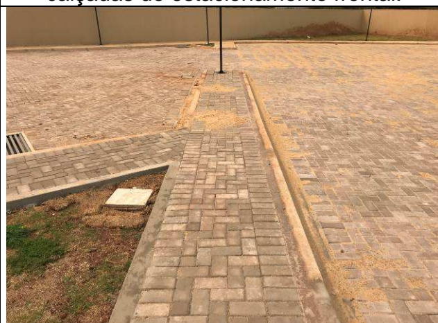
Figura 82C: Pavimentação intertravada - calçadas do estacionamento frontal.
