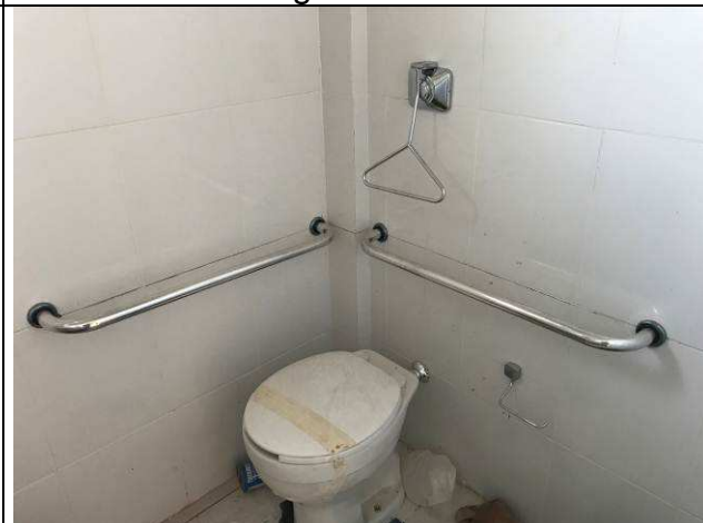
Figura 26C: Acabamento válvula de descarga - BWC PNE.
