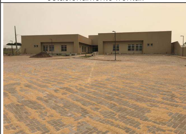
Figura 75C: Pavimentação intertravada - estacionamento frontal.
