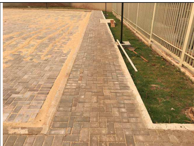
Figura 84C: Pavimentação intertravada - calçadas do estacionamento frontal.
