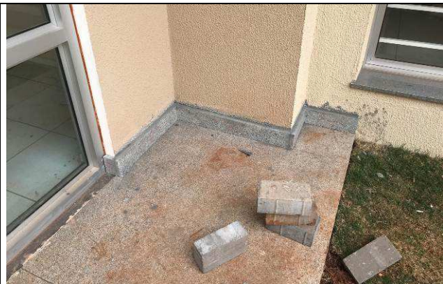
Figura 14C: Rodapés em granito - entrada principal.
