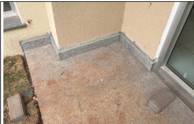
Figura 13C: Rodapés em granito - entrada principal.
