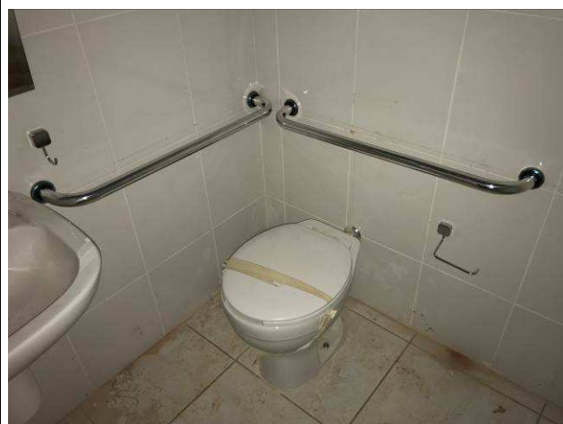
Figura 22C: Barras de apoio - banheiro público feminino.
