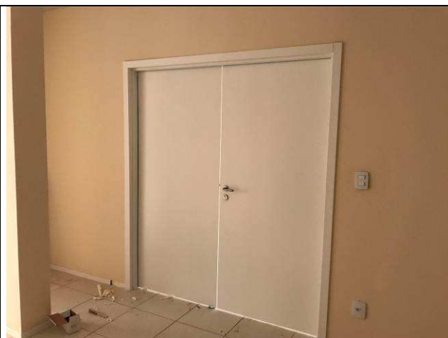
Figura 07C: Porta de madeira - Auditório.
