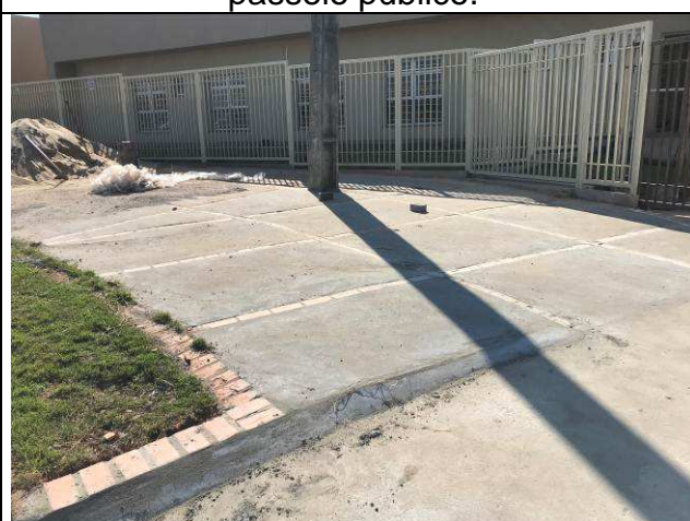
Figura 94C: Refazimento da calçada do passeio público.
