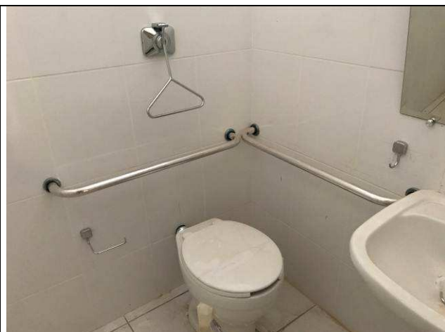
Figura 29C: Acabamento válvula de descarga - BWC PNE.
