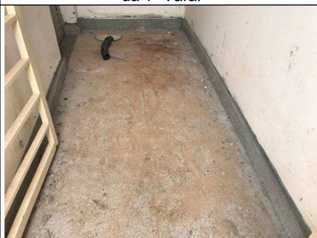
Figura 18C: Rodapés em granito - entrada da área de terceirizados.
