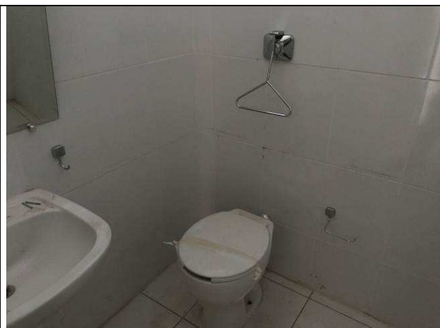
Figura 30C: Acabamento válvula de descarga - BWC PNE.
