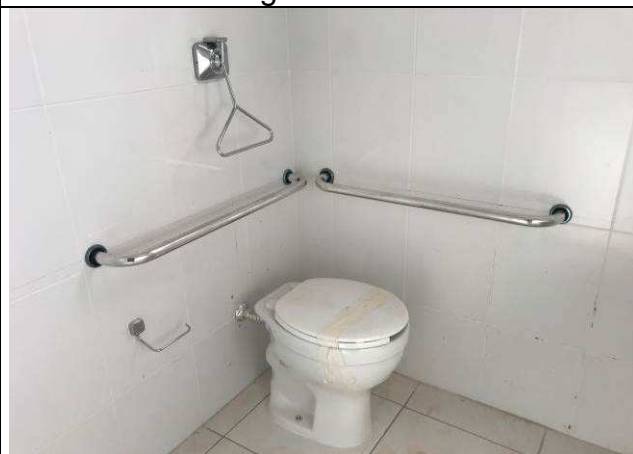
Figura 32C: Acabamento válvula de descarga - BWC PNE.
