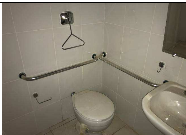
Figura 23C: Barras de apoio - banheiro público masculino.
