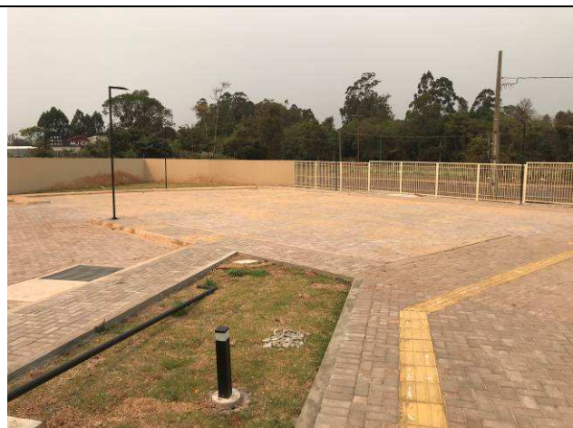
Figura 79C: Pavimentação intertravada - calçadas do estacionamento frontal.
