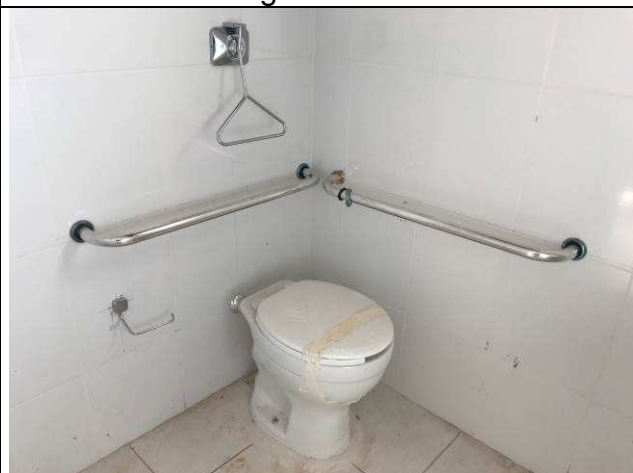
Figura 33C: Acabamento válvula de descarga - BWC PNE.
