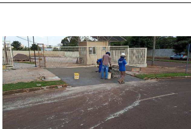
Figura 87C: Entrada de veículos - estacionamento da frente.
