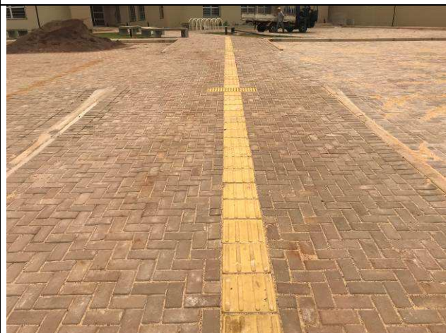
Figura 80C: Pavimentação intertravada - calçadas do estacionamento frontal.
