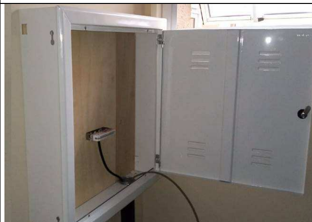
Figura 39E: DG Telefonia e blocos
