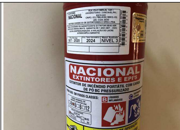
Figura 66C: Extintor de pó - modelo.
