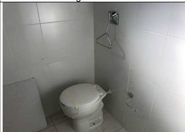
Figura 31C: Acabamento válvula de descarga - BWC PNE.
