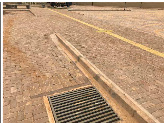
Figura 72C: Pavimentação intertravada - estacionamento frontal.
