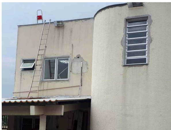
Figura 45C: Local já com o vão de aparelho janelheiro fechado com alvenaria (ver figura 43C)
