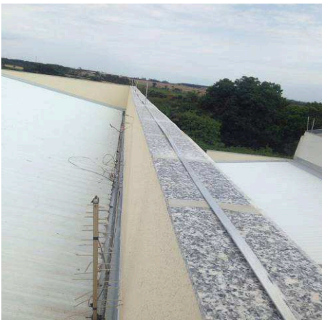
Figura 39E - SPDA captação
