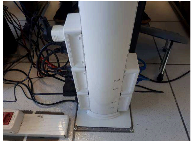
Figura 16E - totens, colunas técnicas e tomadas Dutotec
