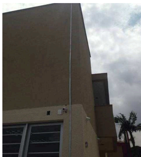
Figura 48E - SPDA descidas
