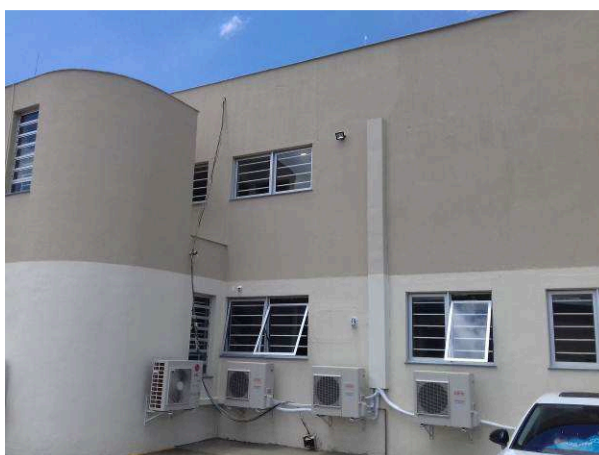
Figura 50C: Aplicação de textura na fachada lateral esquerda
