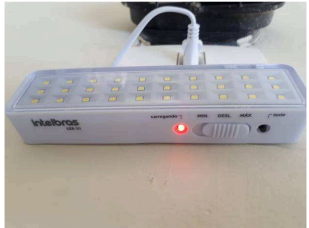
Figura 22E - iluminação - blocos de emergência
