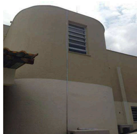
Figura 46E - SPDA descidas
