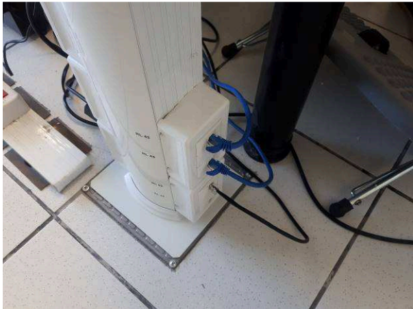
Figura 55E - pontos lógicos cabeamento estruturado
