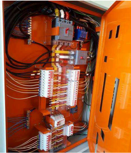
Figura 37E - quadro geral
