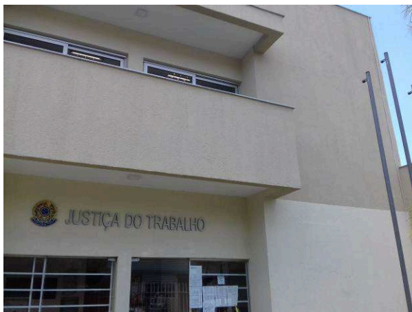
Figura 48C: Aplicação de textura na fachada frontal
