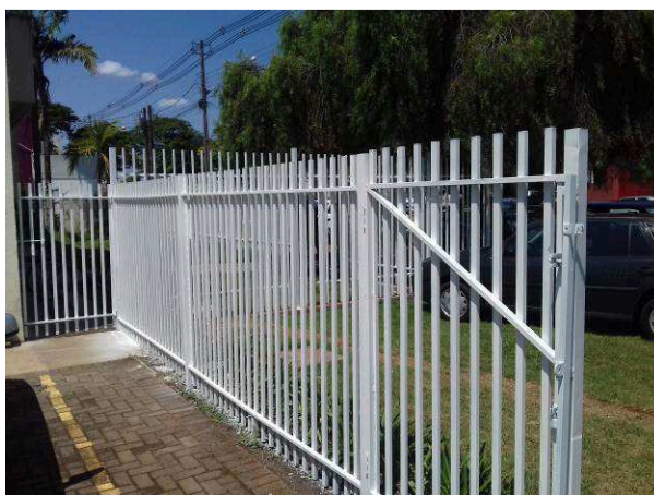
Figura 21C: Pintura do gradil existente
