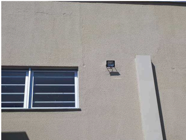
Figura 33E - iluminação - luminárias externas
