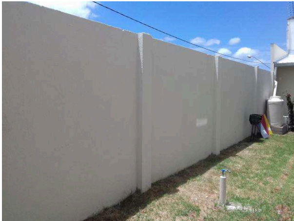
Figura 24C: Pintura do muro localizado nos fundos do imóvel
