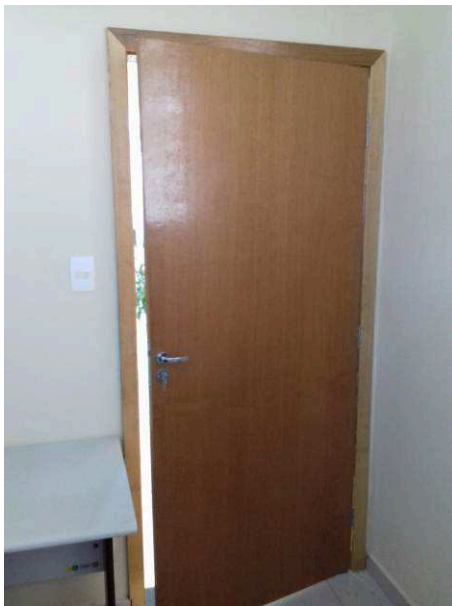
Figura 53C: Aplicação de verniz em portas de madeira
