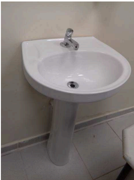
Figura 38C: Instalação de lavatório na sala de perícia
