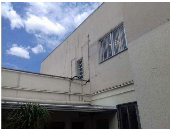
Figura 46C: Local já com o vão de aparelho janelheiro fechado com alvenaria (ver figura 44C)
