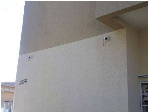
Figura 63E - pontos CFTV
