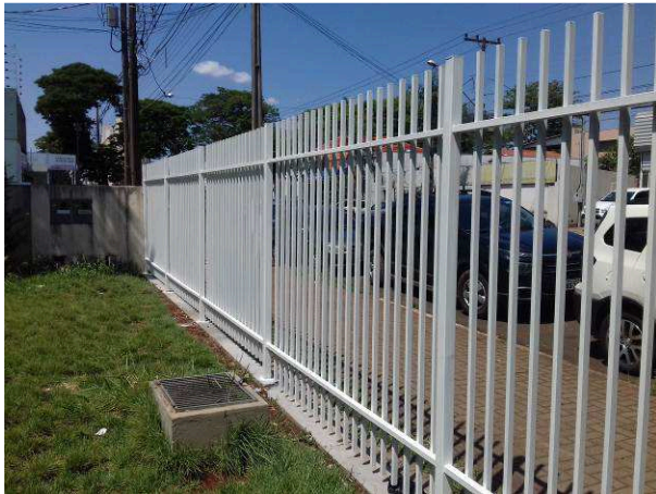
Figura 22C: Pintura do gradil novo
