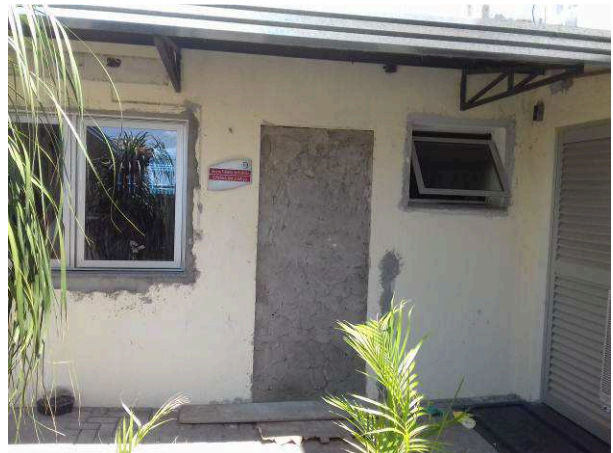
Figura 35C: Emassamento do vão fechado
