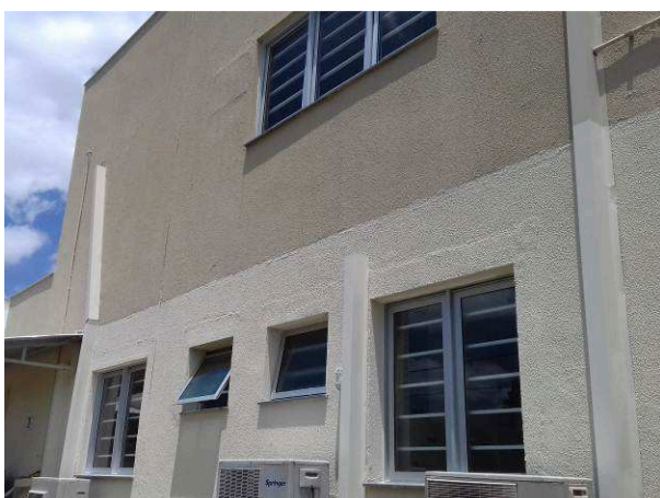
Figura 49C: Aplicação de textura na fachada dos fundos
