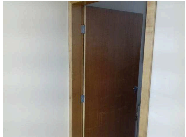
Figura 52C: Aplicação de verniz em portas de madeira
