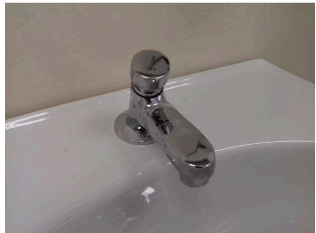
Figura 39C: Instalação de torneira, no lavatório da sala de perícia
