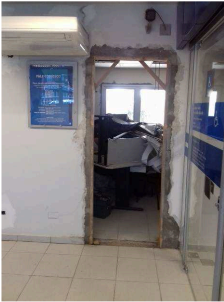
Figura 36C: Abertura de vão de porta entre sala de perícia e hall do PAB
