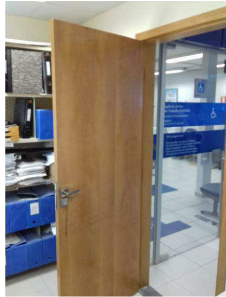
Figura 37C: Instalação de porta na sala de perícia
