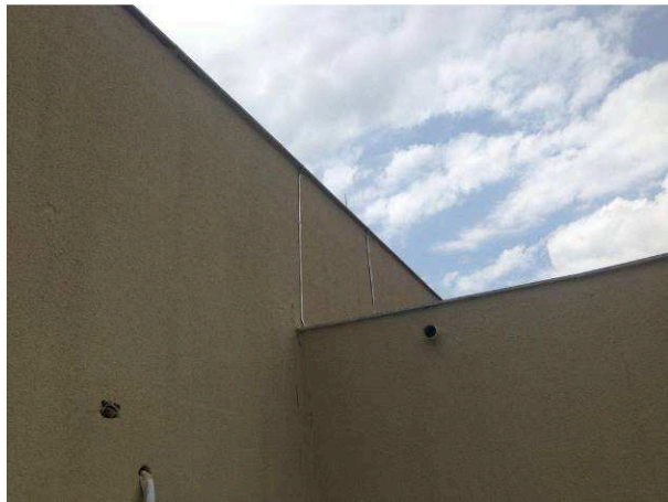
Figura 45E - SPDA descidas
