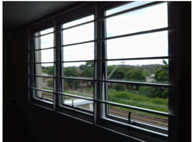
Figura 02C: Gradil em janela do gabinete do juiz titular
