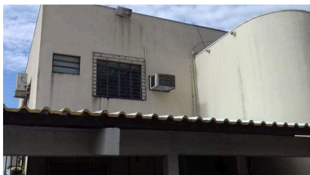
Figura 43C: Local onde havia vão e aparelho janeleiro, ao lado da janela da sala dos assistentes
