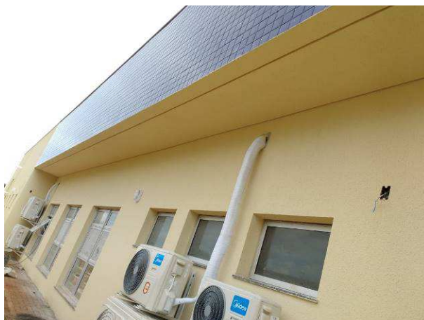
Figura 90C: Forro em drywall, já com textura aplicada - fundos
