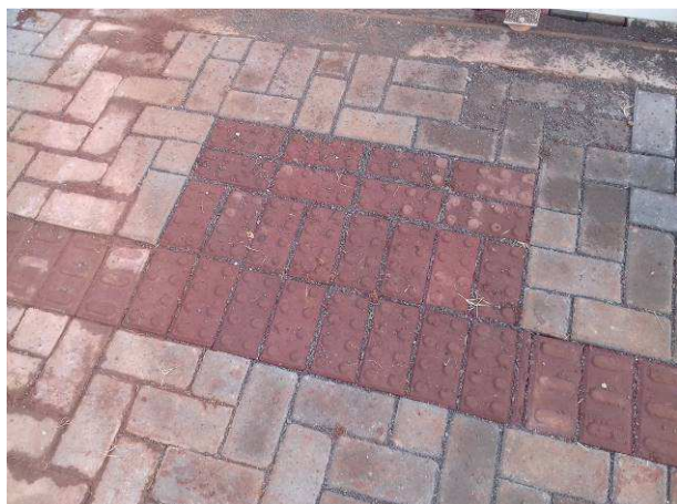
Figura 70C: Piso tátil de alerta, na entrada de pedestres
