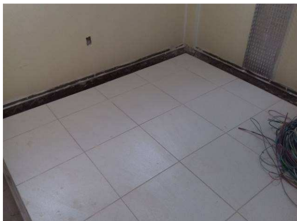
Figura 21C: Canaleta executada na sala técnica
