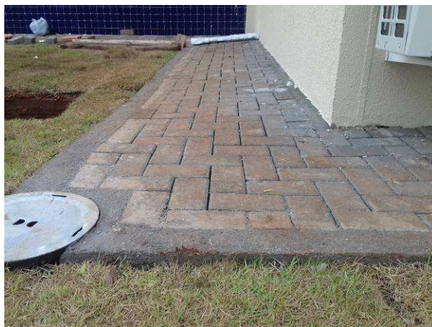
Figura 67C: Vigotes de travamento da calçada que circunda o imóvel
