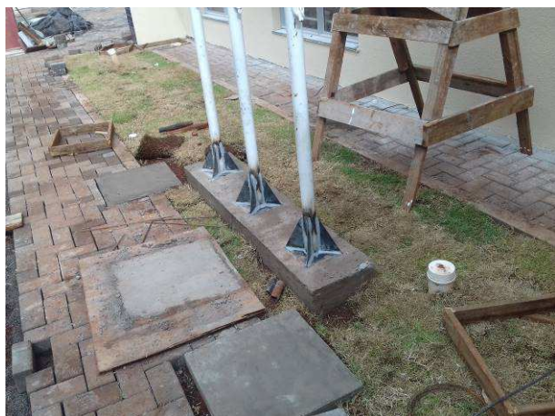
Figura 82C: Base e fixação dos mastros para bandeiras
