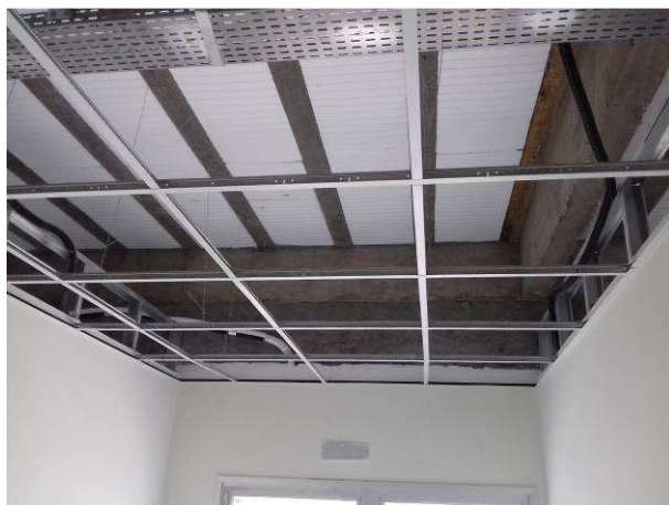
Figura 02C: Montagem dos perfis de forro na sala da OAB
