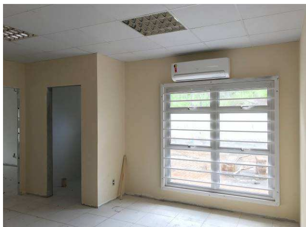
Figura 78C: Gabinete do juiz titular, com primeira demão de pintura concluída
