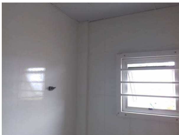
Figura 14C: Azulejo instalado em sanitário público
