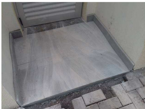
Figura 19C: Piso instalado no hall externo 1
