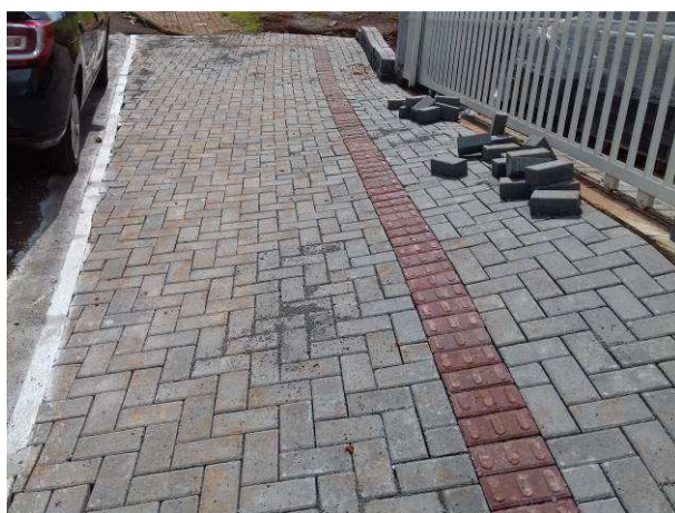
Figura 69C: Paver, meio-fio e piso tátil, no passeio público
