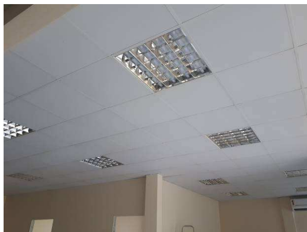
Figura 40E: Iluminação interna - luminárias 4 lâmpadas, com aletas
