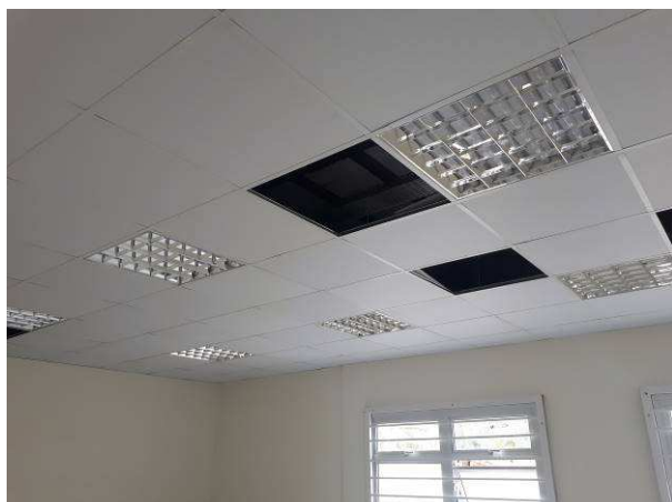
Figura 39E: Iluminação interna - luminárias 4 lâmpadas, com aletas
