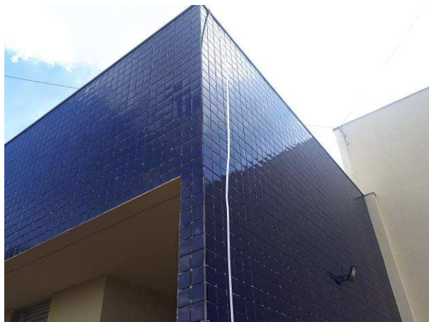
Figura 61E: descidas SPDA
