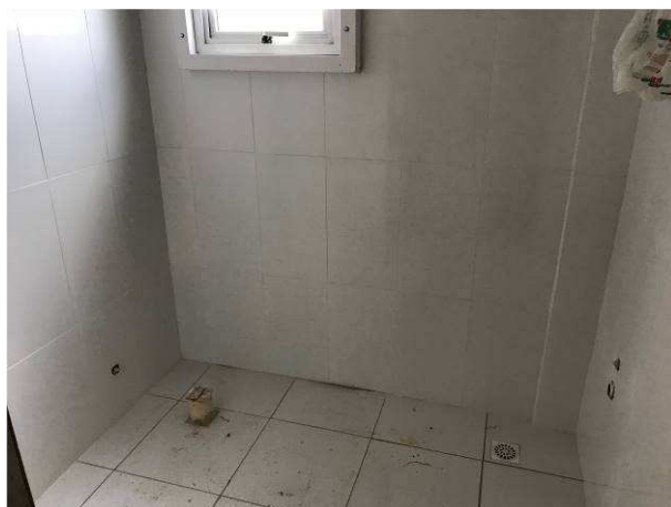
Figura 10C: Azulejo instalado no sanitário masculino da secretaria
