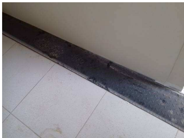
Figura 22C: Fechamento de canaleta
