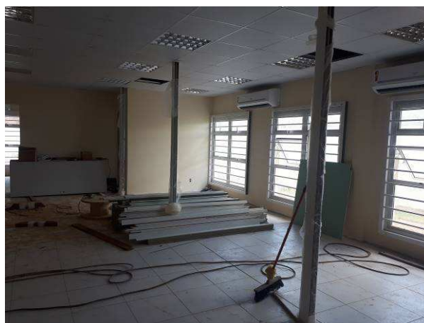
Figura 34E: Colunas técnicas Dutotec
