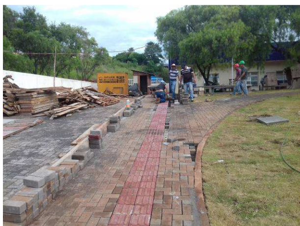
Figura 68C: Visão geral do paver, piso tátil e vigota de travamento, na calçada de acesso ao imóvel
