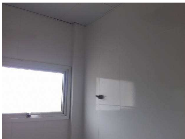
Figura 13C: Azulejo instalado na área de serviço
