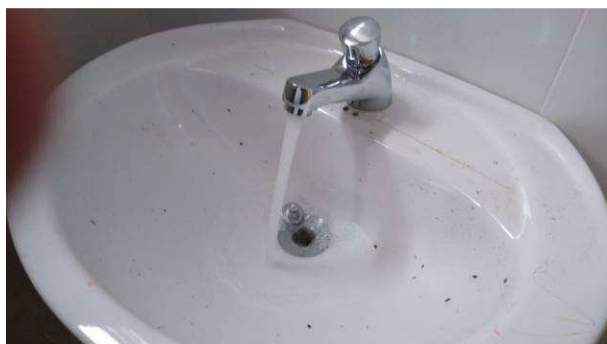
Figura 33C: Lavatório comum com torneira sendo testada
