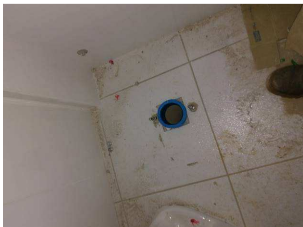
Figura 31C: Detalhe do anel de vedação de bacia sanitária
