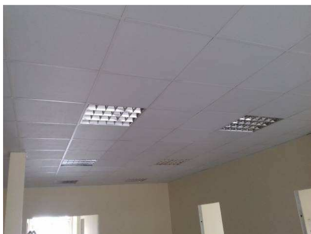
Figura 07C: Forro montado no hall público
