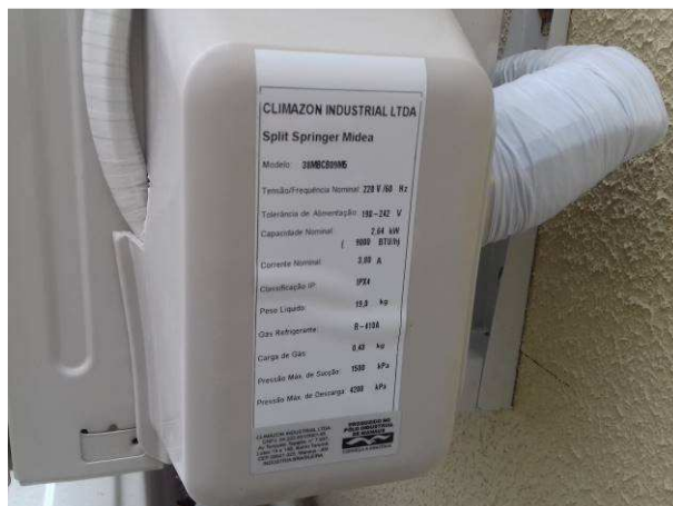
Figura 50C: Etiqueta de equipamento com capacidade de 9.000BTUs/h
