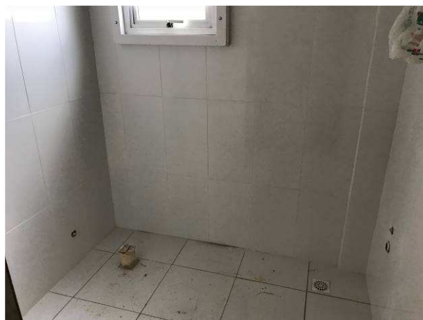
Figura 18C: Piso instalado no sanitário público feminino
