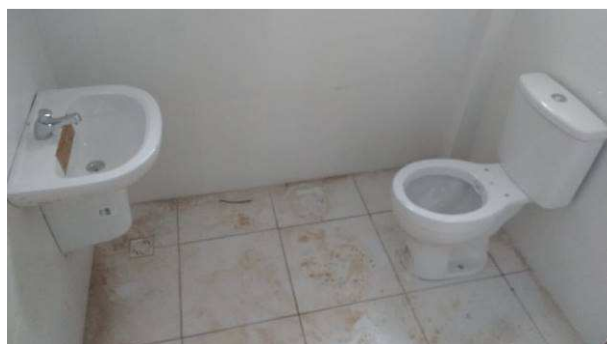
Figura 28C: Bacia com caixa acoplada para PNE, Lavatório para PNE e torneira com desligamento automático em sanitário público masculino
