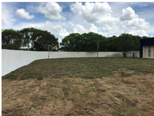
Figura 71C: Pátio gramado, já com o nível do terreno totalmente nivelado e com o plantio de grama
