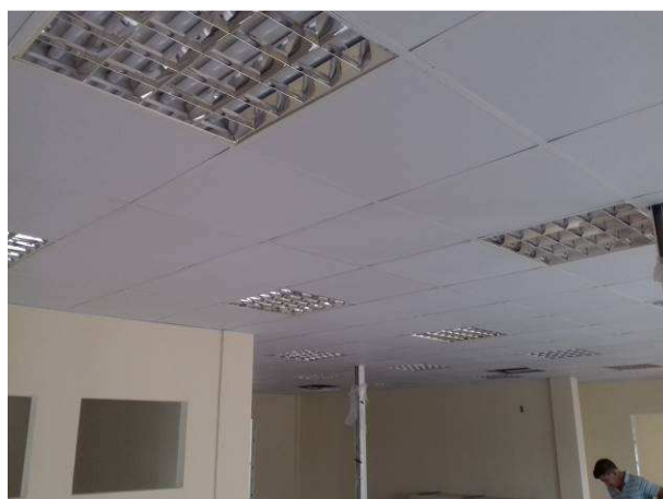
Figura 04C: Forro montado na secretaria
