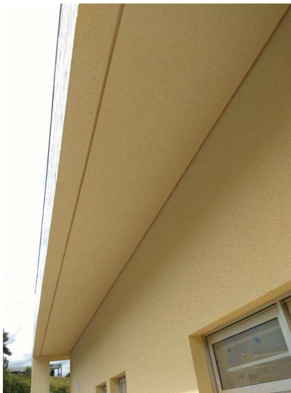
Figura 88C: Forro em drywall, já com textura aplicada - lateral esquerda
