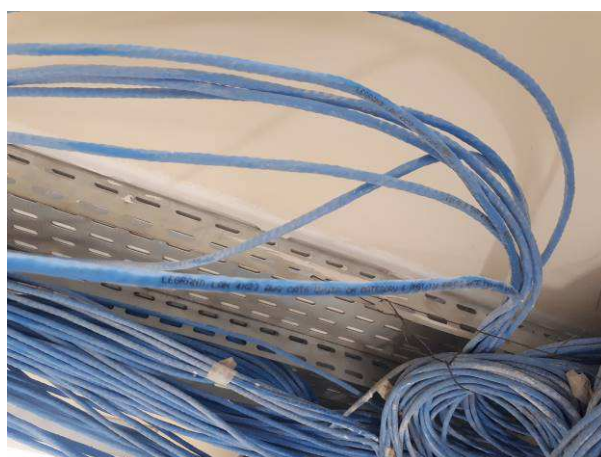
Figura 72E: Cabeamento lógico UTP cat6
