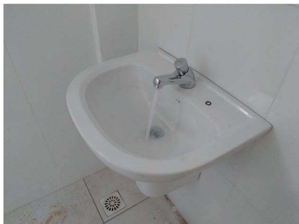
Figura 32C: Lavatório PNE com torneira sendo testada
