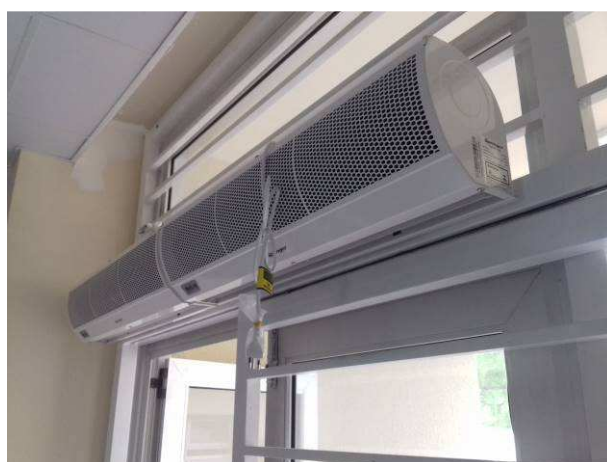
Figura 58C: Cortinas de ar, instaladas sobre a porta principal
