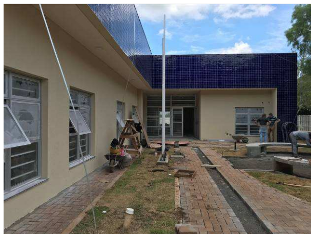
Figura 77C: Parede frontal com textura executada
