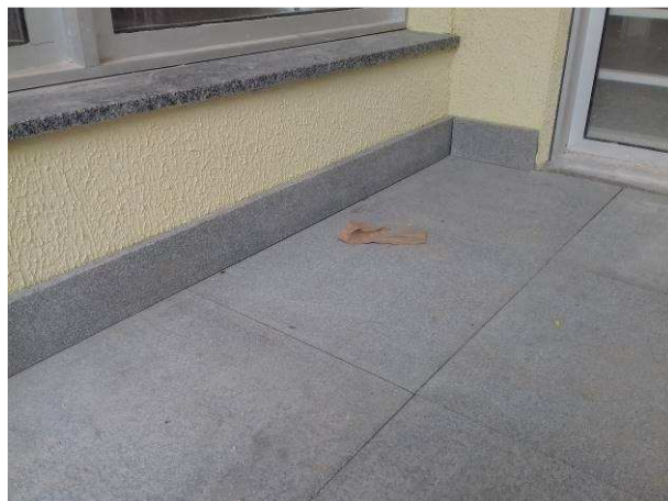
Figura 24C: Rodapé instalado no hall de entrada principal
