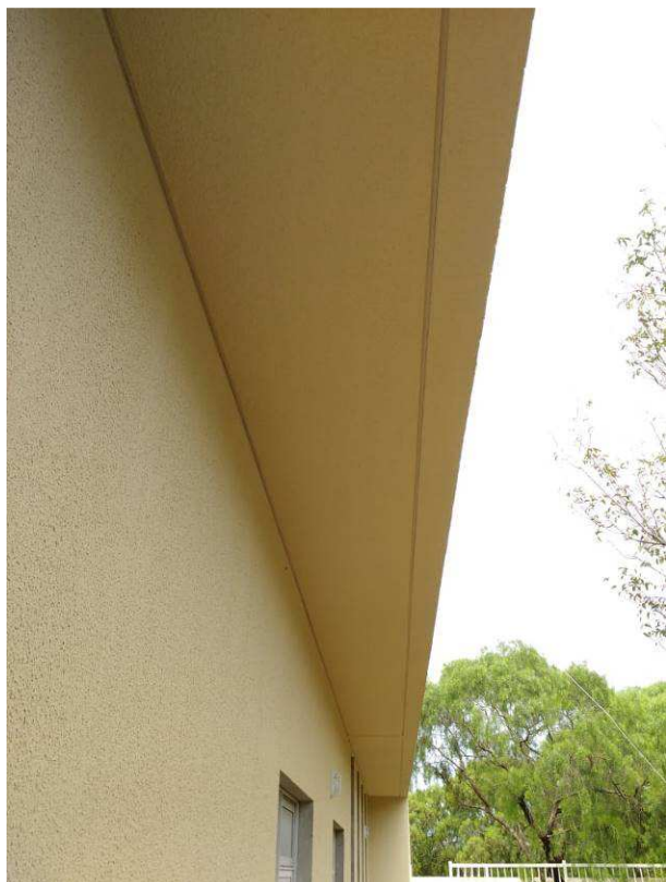
Figura 87C: Forro em drywall, já com textura aplicada - frontal
