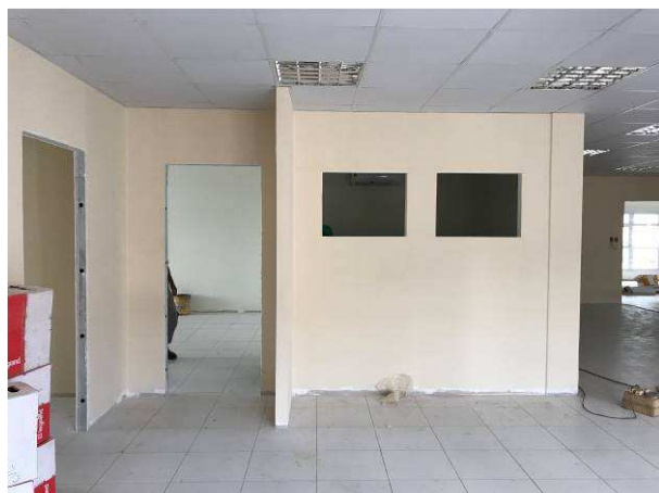
Figura 79C: Paredes da secretaria com primeira demão de pintura executada
