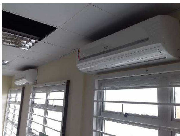
Figura 54C: Evaporadoras instaladas na secretaria
