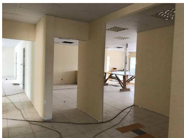
Figura 81C: Espera, com primeira demão de pintura concluída
