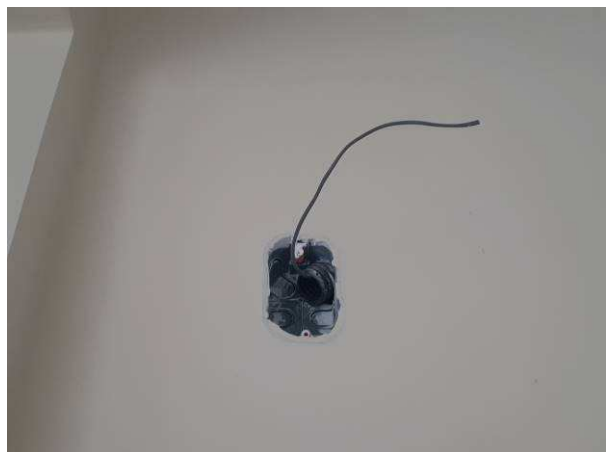
Figura 73E: Cabeamento alarme
