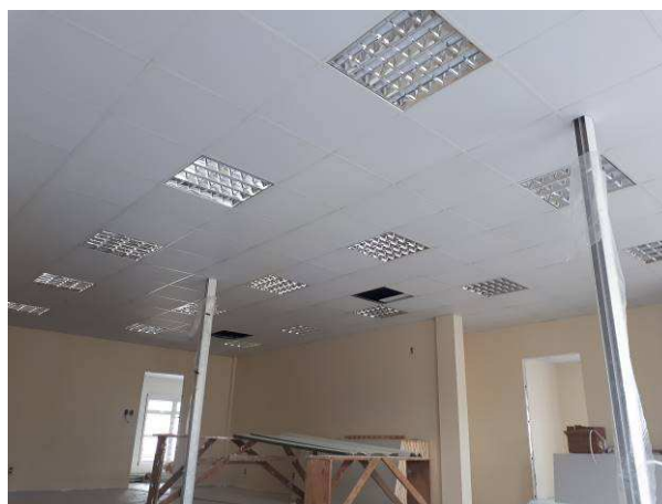
Figura 36E: Colunas técnicas Dutotec
