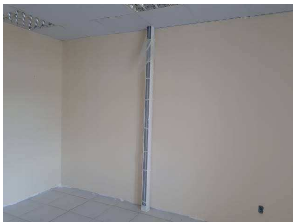
Figura 33E: Colunas técnicas Dutotec
