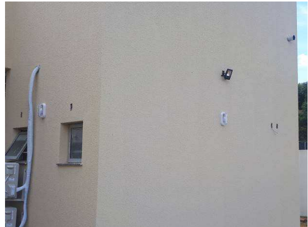
Figura 46E: Iluminação externa - luminárias tartaruga
