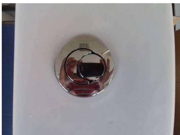
Figura 35C: Detalhe do botão de duplo acionamento, em bacia sanitária
