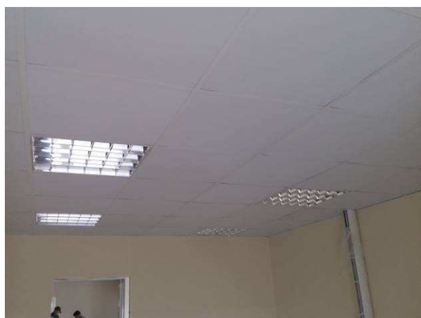
Figura 06C: Forro montado no gabinete do juiz auxiliar
