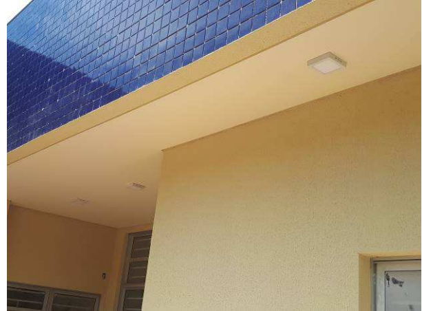
Figura 44E: Iluminação interna - luminárias tipo painel LED sobrepor
