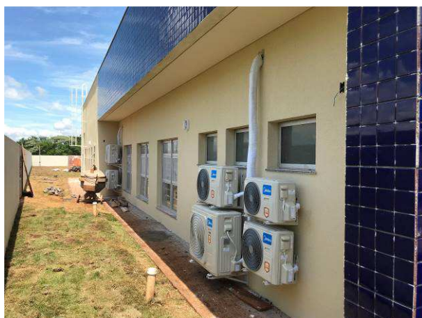
Figura 74C: Parede dos fundos do imóvel com textura concluída
