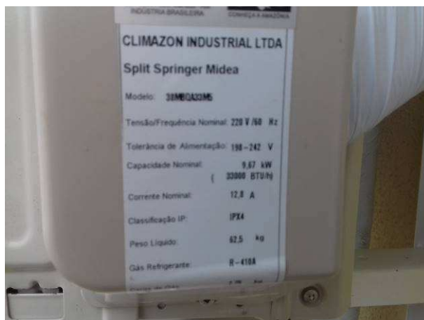
Figura 52C: Etiqueta de equipamento com capacidade de 30.000BTUs/h
