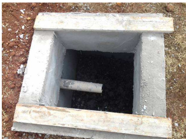
Figura 39C: Descarga para o sumidouro
