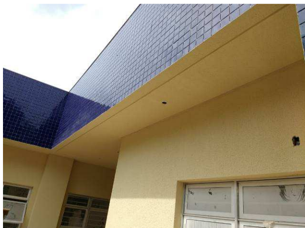
Figura 89C: Forro em drywall, já com textura aplicada - próximo à entrada principal
