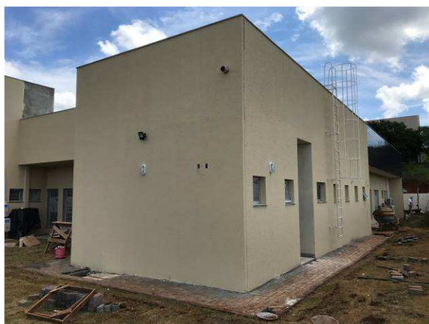
Figura 75C: Paredes dos fundos e lateral direita com textura concluída
