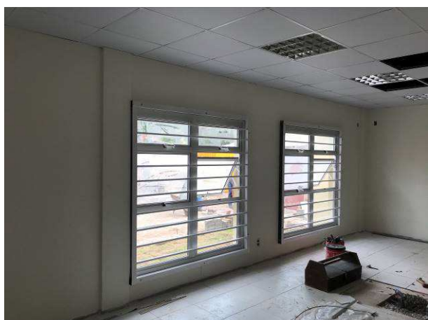
Figura 80C: Paredes da sala de audiência 1, com primeira demão de pintura concluída
