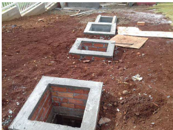
Figura 38C: Sistema Poço/Filtro/Sumidouro, já enterrados
