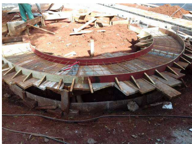
Figura 84C: Fôrmas e armaduras da laje de um dos bancos de concreto
