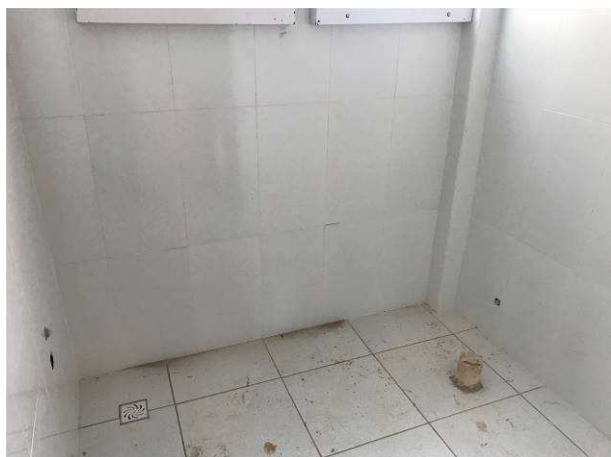
Figura 17C: Piso instalado em sanitário dos terceirizados
