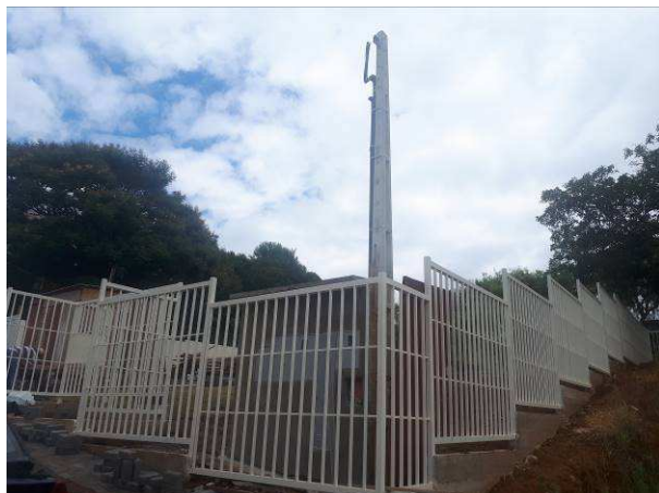
Figura 01E: Entrada de energia - poste
