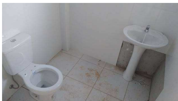
Figura 30C: Bacia sanitária, Lavatório com coluna e torneira com desligamento automático em sanitário do juiz auxiliar
