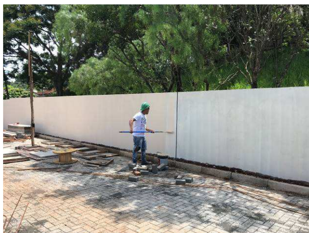
Figura 72C: Operário realizando a pintura do muro
