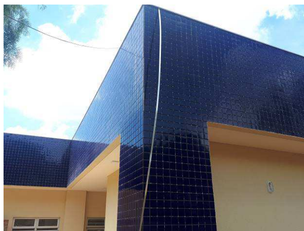
Figura 64E: descidas SPDA
