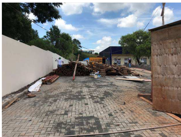
Figura 73C: Detalhe do muro e acesso de veículos
