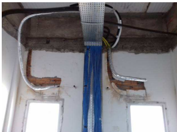
Figura 43C: Redes frigorígenas da sala técnica
