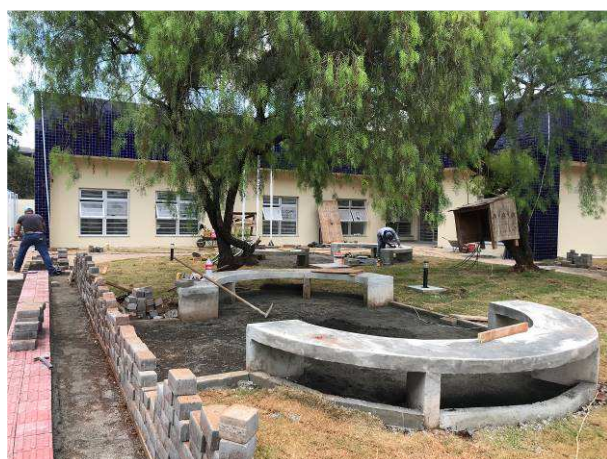
Figura 85C: Bancos de concreto já com suas lajes concretadas
