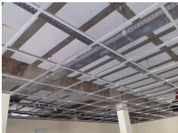
Figura 01C: Montagem dos perfis de forro no hall público
