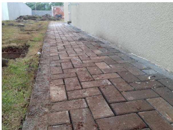
Figura 66C: Vigotes de travamento da calçada que circunda o imóvel
