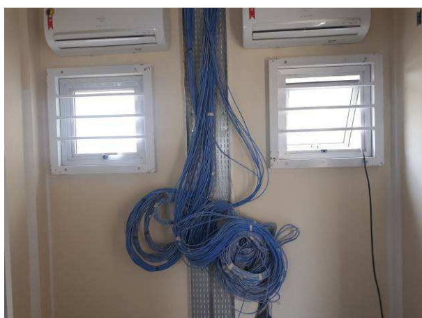
Figura 71E: Cabeamento lógico UTP cat6
