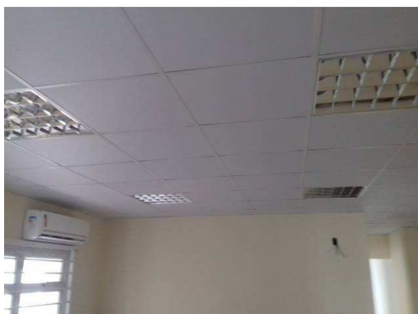
Figura 05C: Forro montado na espera
