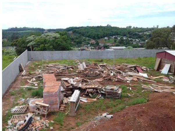
Figura 43C: Emboço/reboco, realizado na face interna do muro da lateral direita
