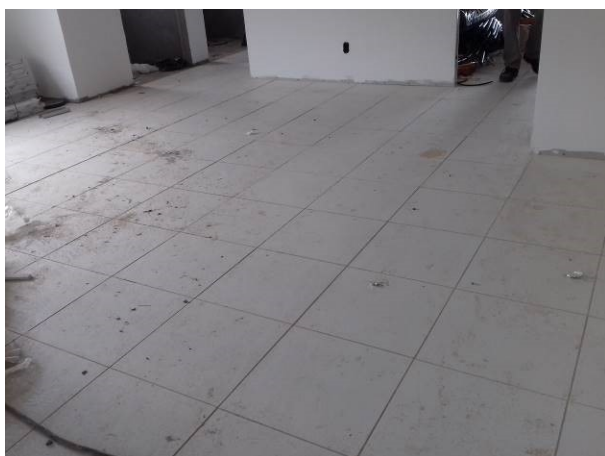
Figura 24C: Piso cerâmico instalado na secretaria
