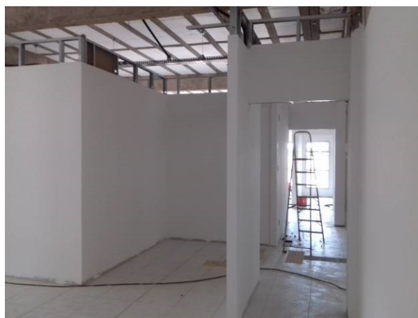
Figura 04C: Parede de gesso acartonado simples, no atendimento e secretaria
