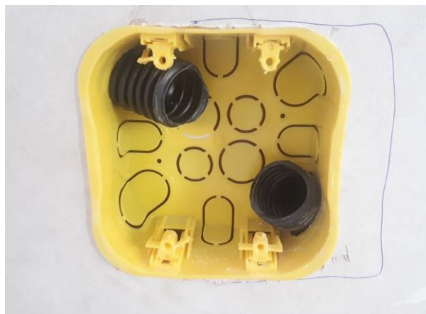
Figura 08E: infraestrutura interna - eletrodutos, caixas 2x4 e 4x4
