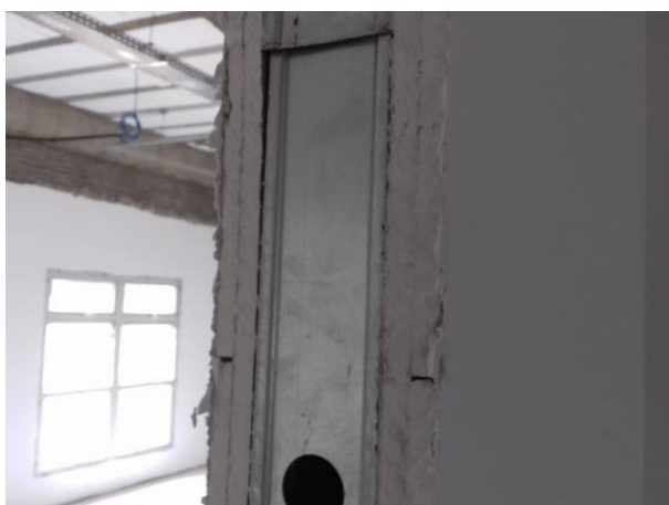
Figura 13C: Parede de gesso acartonado dupla, detalhe das placas
