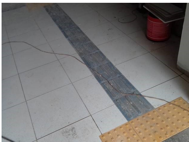
Figura 22C: Piso cerâmico e piso tátil, instalados no hall público
