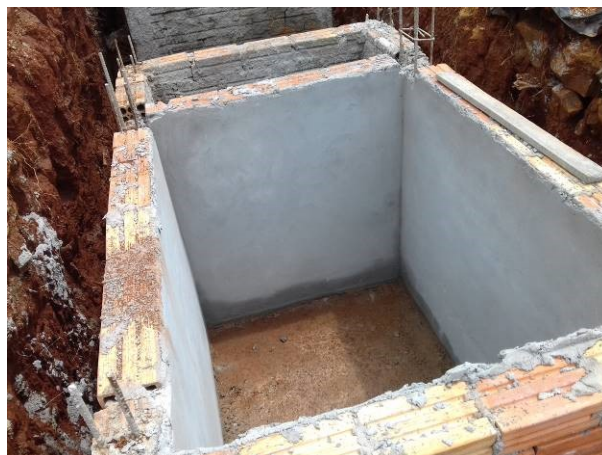
Figura 31C: Filtro anaeróbico, com paredes levantadas
