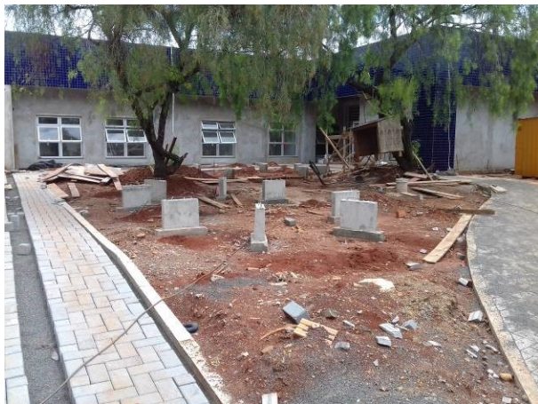
Figura 53C: Pilaretes (pés) dos bancos de concreto
