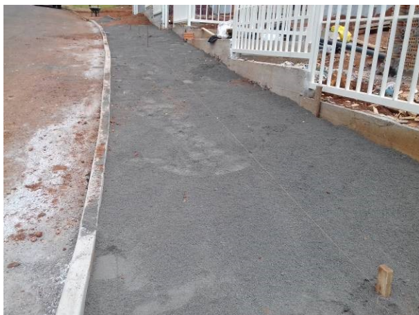
Figura 38C: Meio-fio e base de pó de pedra, no passeio externo
