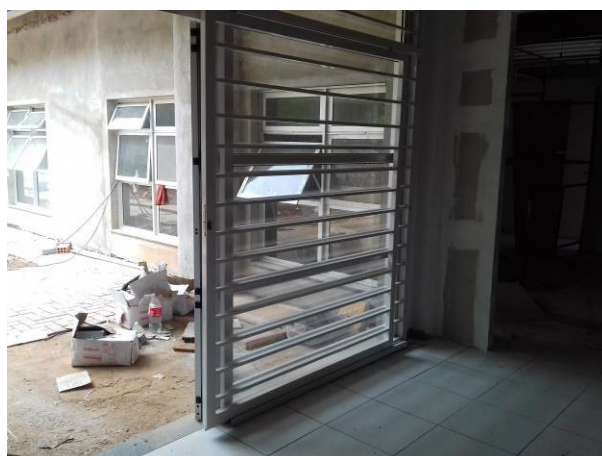
Figura 19C: Gradil de proteção da porta localizada no acesso principal
