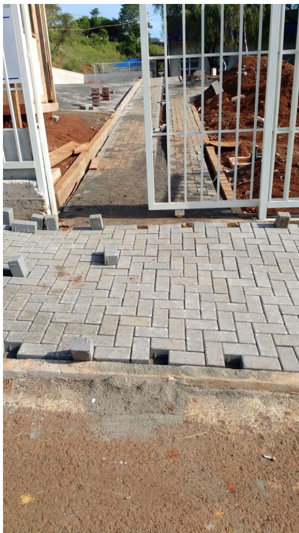
Figura 41C: Paver, sendo instalado no passeio externo
