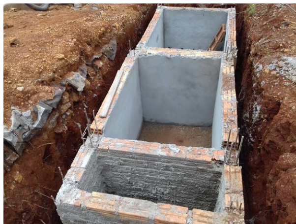
Figura 33C: Filtro anaeróbico e sumidouro
