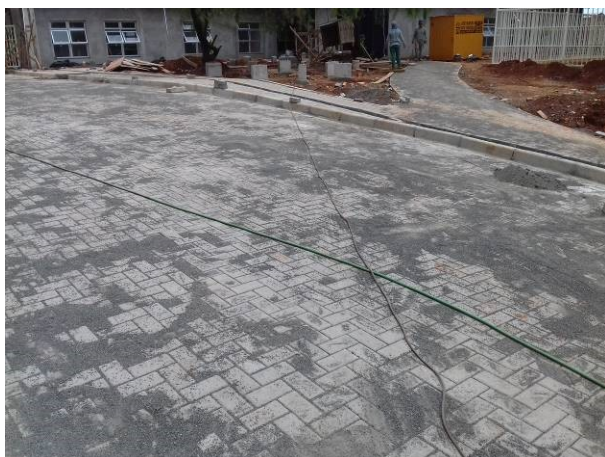
Figura 34C: Paver instalado na rampa do estacionamento
