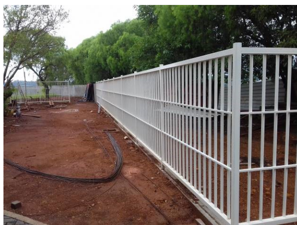
Figura 45C: Pintura dos gradis de fechamento do terreno - Frontal à direita
