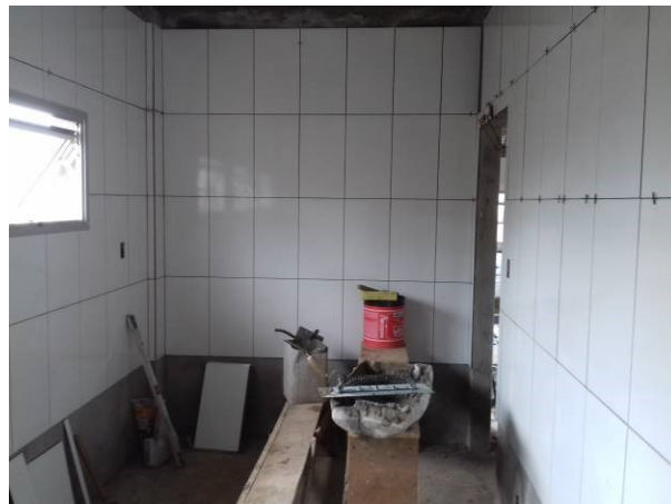
Figura 21C: Azulejos instalados na copa da secretaria
