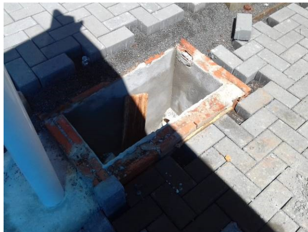
Figura 29C: Boca de lobo, executada no meio do estacionamento público
