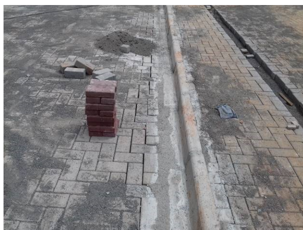
Figura 37C: Detalhe do meio fio no estacionamento público
