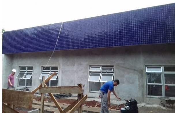
Figura 49C: Pastilhas instaladas na fachada frontal à esquerda
