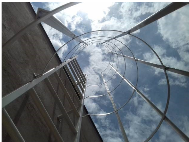
Figura 55C: Escada marinheiro - detalhe do guarda-corpo
