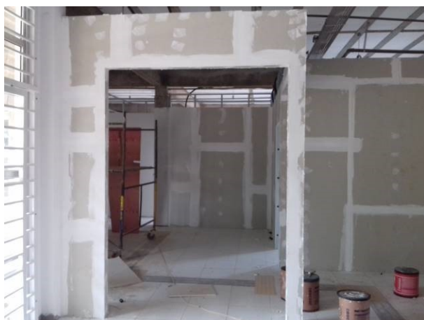
Figura 03C: Parede de gesso acartonado simples, na sala múltiplo uso e arquivo
