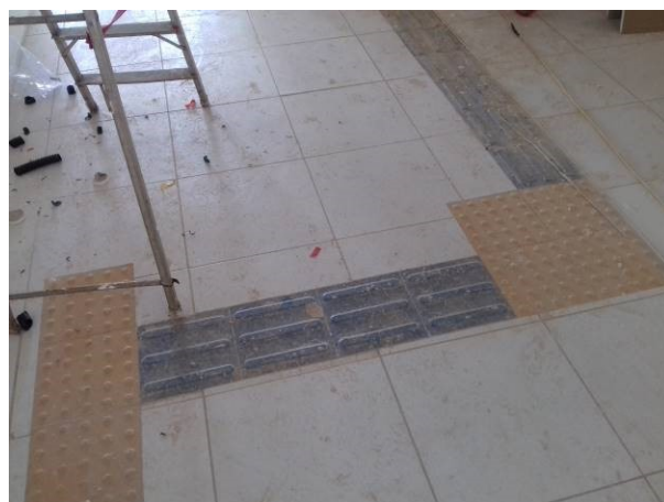
Figura 25C: Piso cerâmico e piso tátil, instalados na circulação
