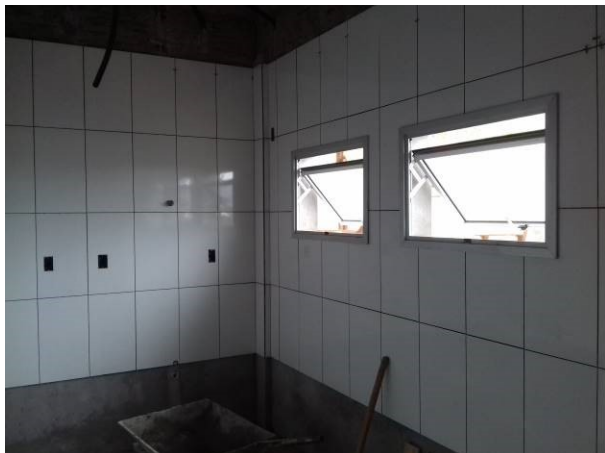
Figura 20C: Azulejos instalados na copa da secretaria
