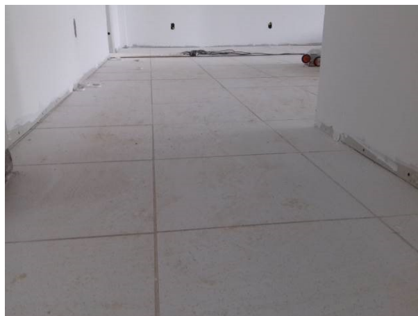
Figura 27C: Piso cerâmico instalado na circulação
