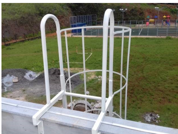
Figura 57C: Escada marinheiro - detalhe do corrimão
