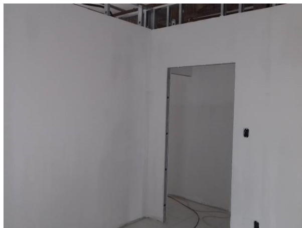
Figura 02C: Parede de gesso acartonado simples, no gabinete do juiz titular
