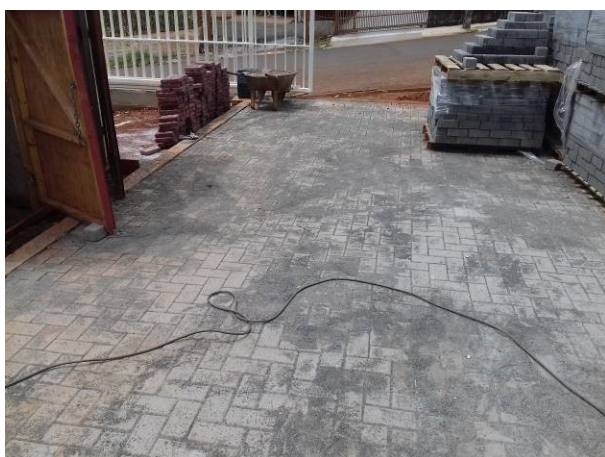
Figura 36C: Paver instalado na rampa do estacionamento
