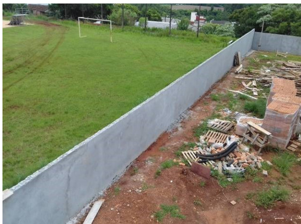
Figura 42C: Emboço/reboco, realizado na porção direita do muro dos fundos
