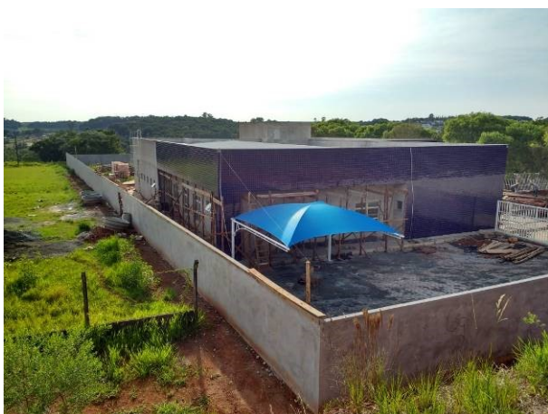
Figura 52C: Pastilhas instaladas na fachada esquerda
