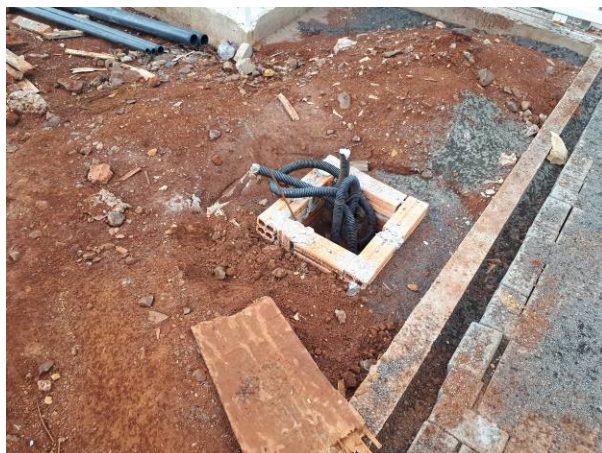
Figura 04E: infraestrutura externa
