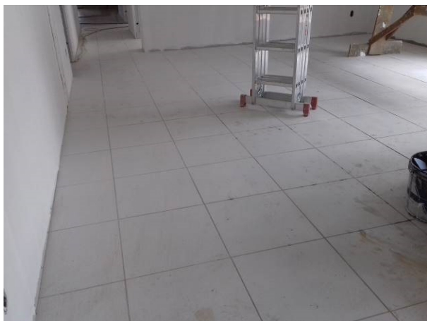
Figura 26C: Piso cerâmico instalado na sala de audiência 1
