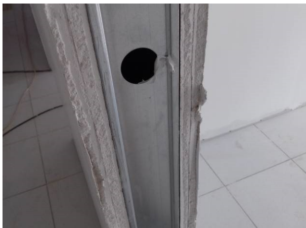
Figura 15C: Parede de gesso acartonado dupla, detalhe das placas - Sala de audiência 2
