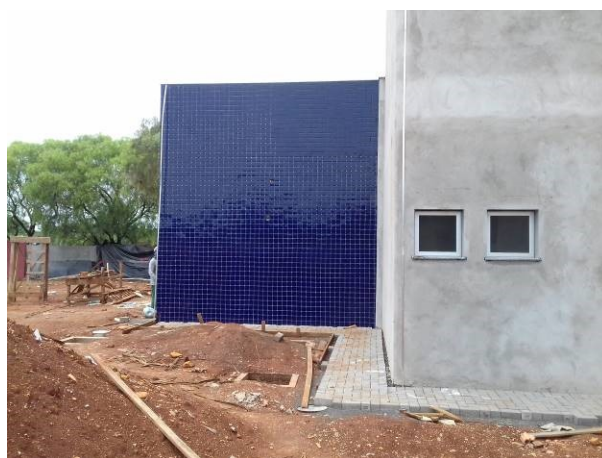
Figura 47C: Pastilhas instaladas no volume da sala múltiplo uso (fundos)
