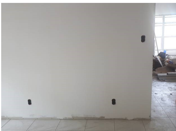
Figura 05E: infraestrutura interna - eletrodutos, caixas 2x4 e 4x4
