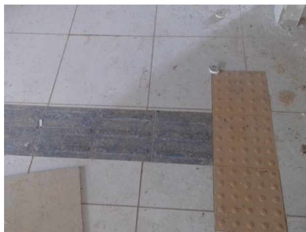
Figura 23C: Piso cerâmico e piso tátil, instalados no atendimento
