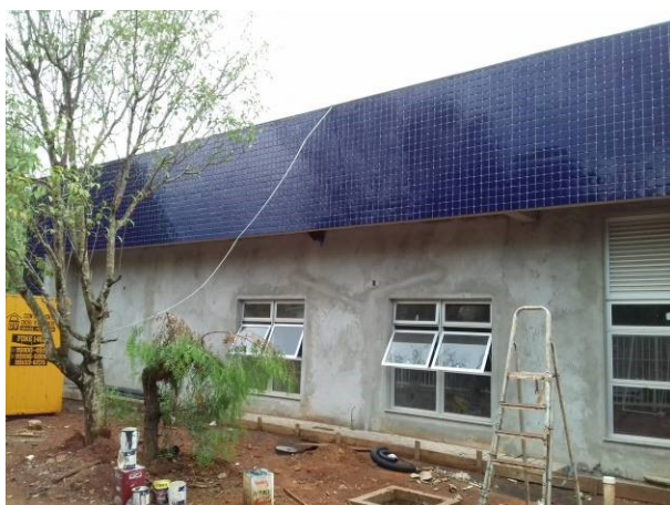
Figura 50C: Pastilhas instaladas na fachada frontal à direita
