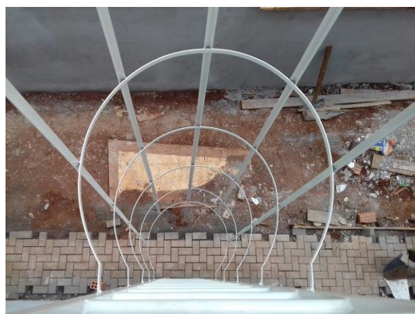
Figura 58C: Escada marinheiro - vista de cima
