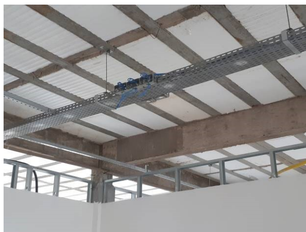
Figura 22E: infraestrutura para cabeamento estruturado - condutores padrão genérico
