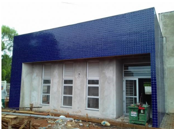
Figura 48C: Pastilhas instaladas no volume da sala múltiplo uso (lateral direita)
