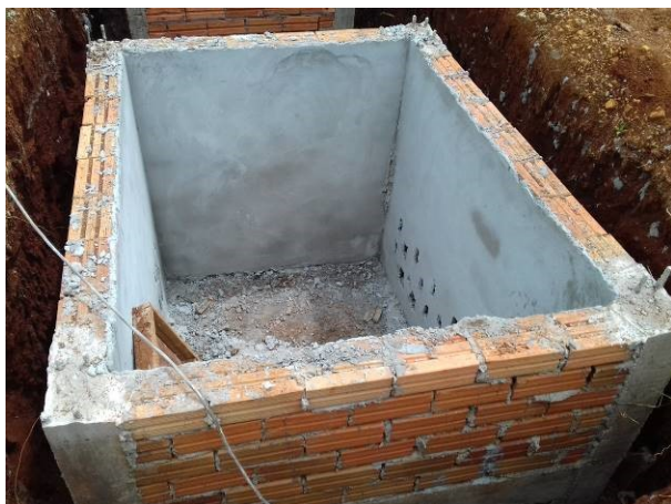
Figura 30C: Sumidouro, com paredes laterais erguidas
