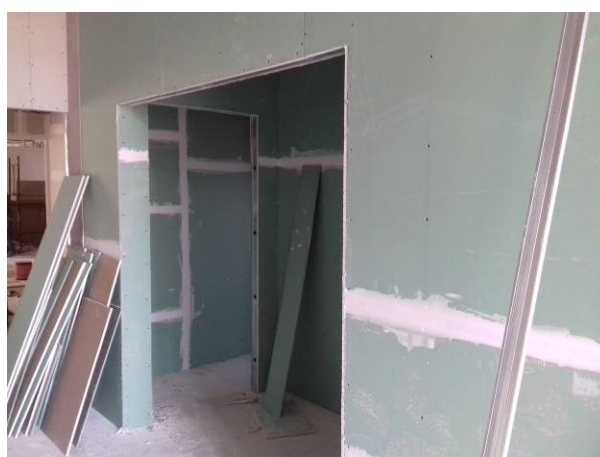
Figura 08C: Parede de gesso acartonado verde, na circulação dos vestiários
