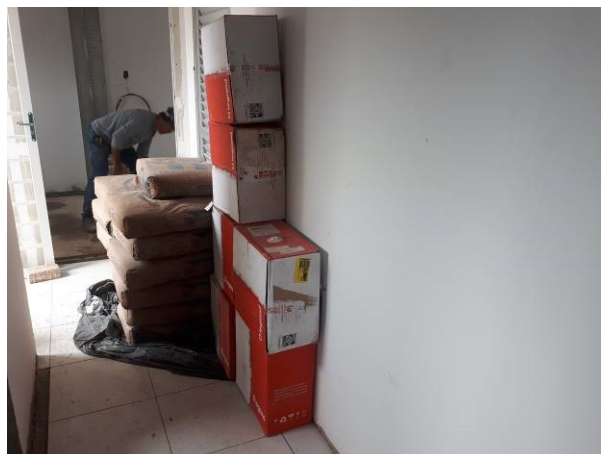
Figura 28E: cabeamento estruturado UTP Cat6
