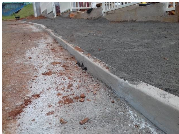
Figura 39C: Meio-fio e base de pó de pedra, no passeio externo
