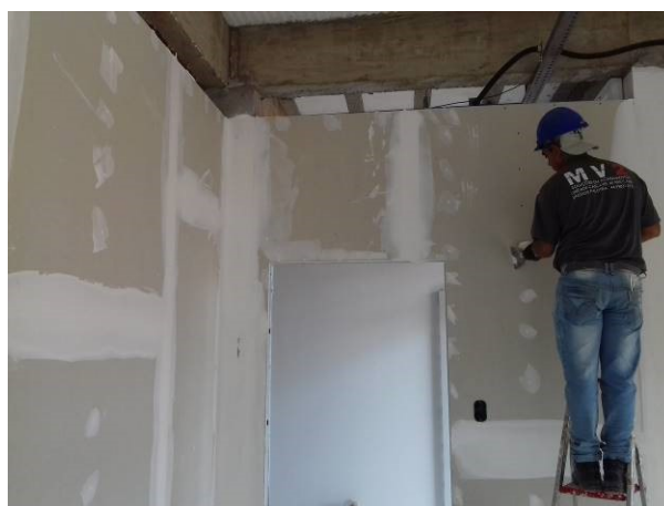
Figura 06C: Parede de gesso acartonado simples, na sala de perícia
