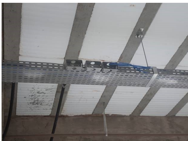
Figura 21E: infraestrutura para cabeamento estruturado - condutores padrão genérico
