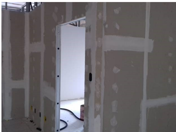
Figura 01C: Parede de gesso acartonado simples, no gabinete do juiz auxiliar
