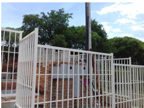
Figura 44C: Pintura dos gradis de fechamento do terreno - Frontal no limite do passeio público
