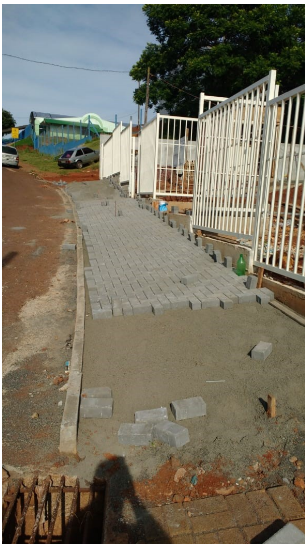
Figura 40C: Início da instalação do paver, no passeio externo
