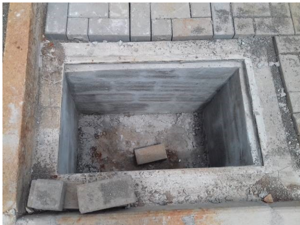
Figura 28C: Boca de lobo, executada no final da rampa de veículos
