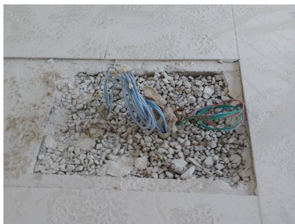
Figura 26E: cabeamento estruturado UTP Cat6
