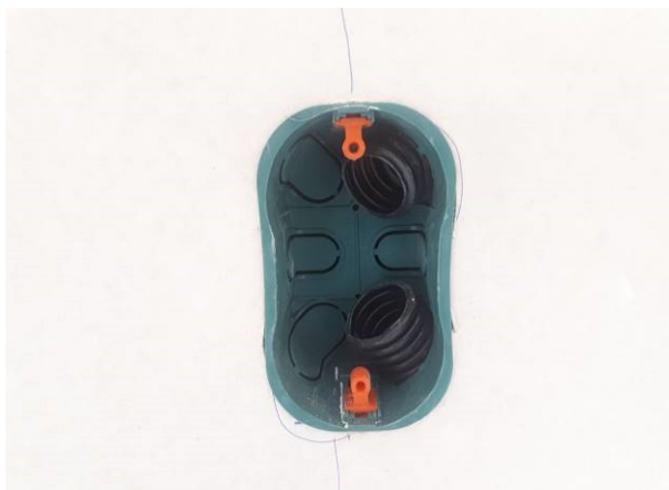
Figura 07E: infraestrutura interna - eletrodutos, caixas 2x4 e 4x4
