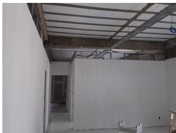
Figura 14C: Parede de gesso acartonado dupla, na sala de audiência 1
