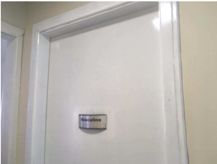
(Figura 01 - Pintura em porta com esmalte acetinado cor branca)
