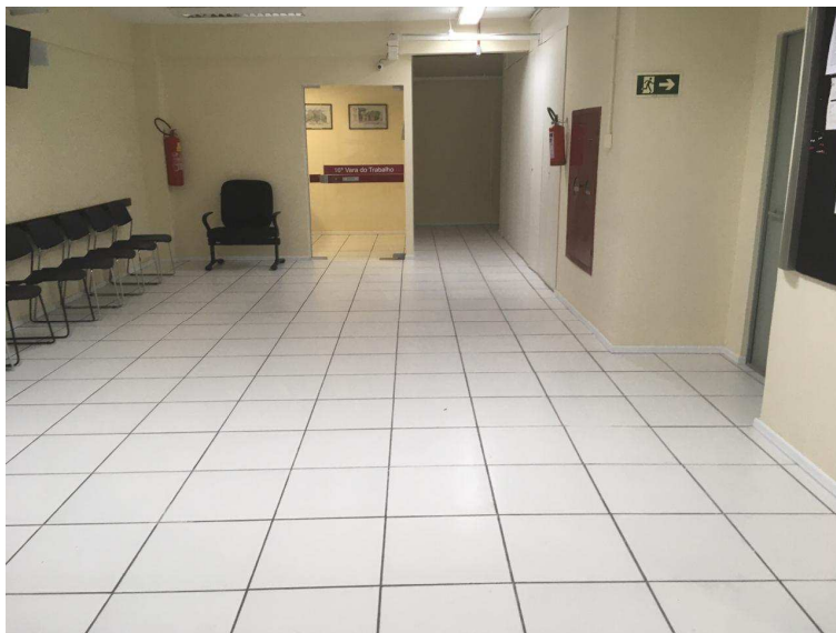
(Figura 02 - Finalização de instalação de piso - 16ª VT )
