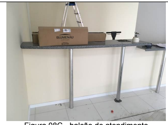
Figura 08C - balcão de atendimento
