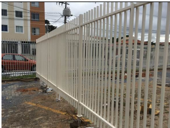
Figura 49C - gradil metalon - delimitação do estacionamento interno
