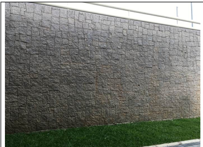
Figura 52C - Limpeza e aplicação de silicone - Muro pedra - jardim de entrada
