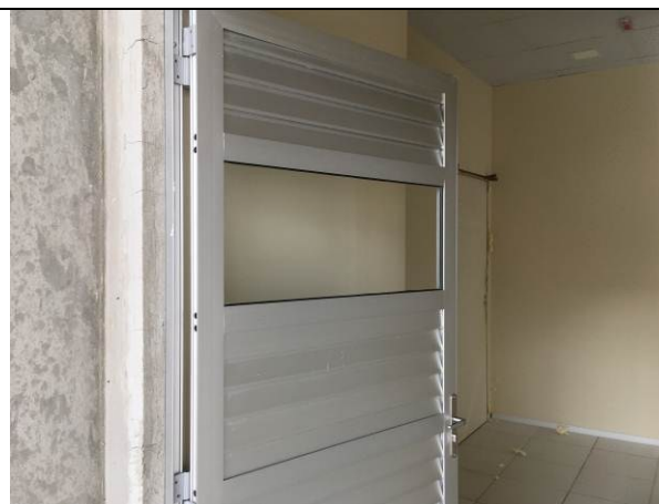
Figura 34C - porta alumínio - acesso à garagem
