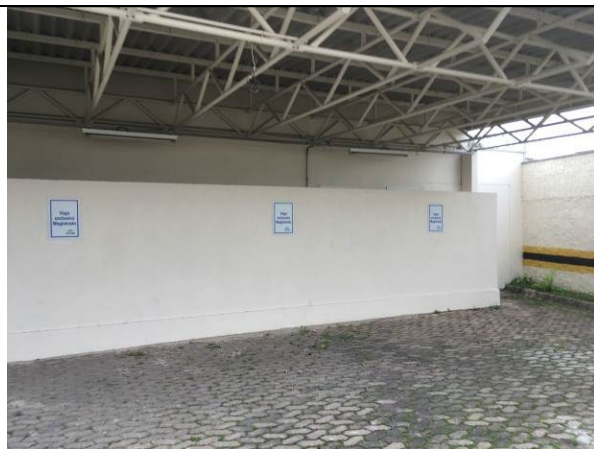
Figura 48C - pintura paredes - estacionamento 3ª VT
