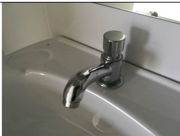
Figura 17C - torneira de pressão automática
