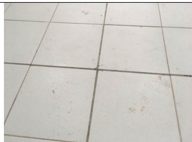
Figura 02C - piso cerâmico - juntas de dilatação
