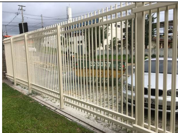
Figura 50C - pintura gradil metalon - fachada Av. das Nações Unidas
