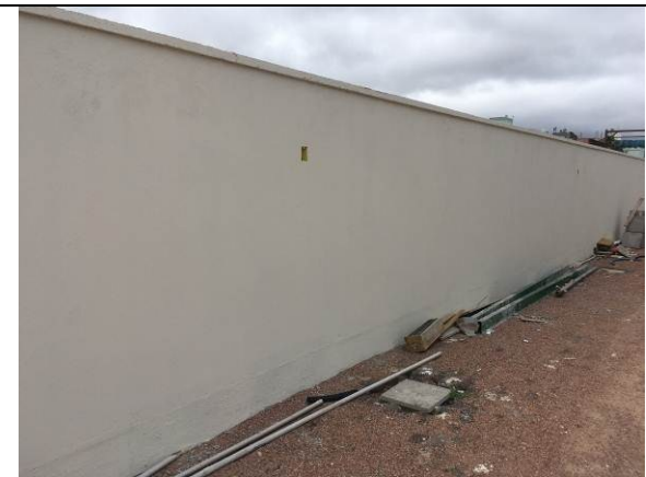
Figura 45C - pintura - muro lateral esquerda
