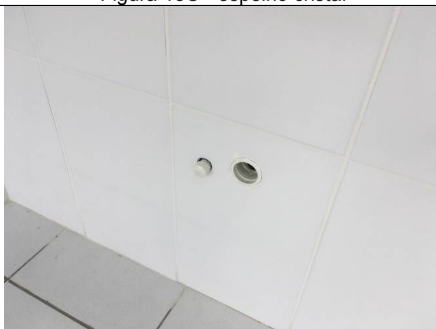
Figura 20C - ponto água e esgoto - Copa
