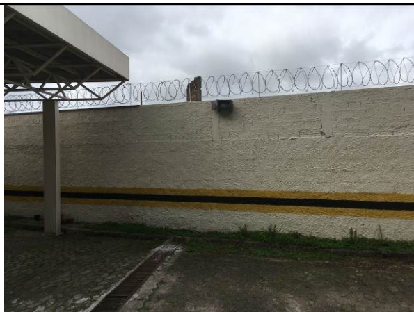
Figura 47C - pintura muro existente - fundos 3ª VT
