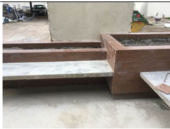
Figura 43C - floreiras de alvenaria/concreto - bancos - lounge externo
