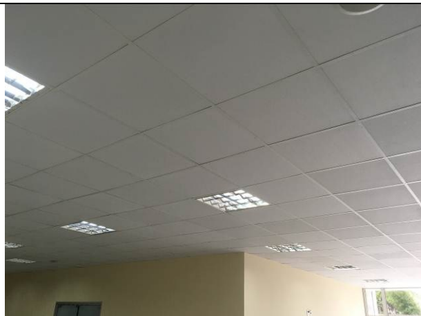
Figura 28C - forro removível
