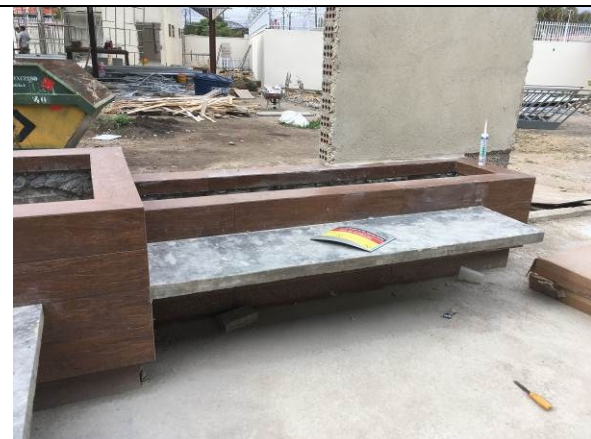
Figura 44C - floreiras de alvenaria/concreto - bancos - lounge externo
