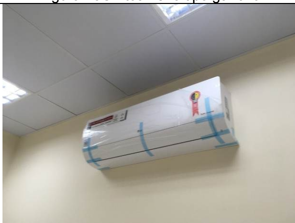
Figura 25C - Evaporadora SPLIT
