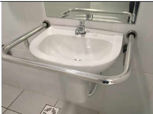
Figura 21C - lavatório PNE - barras de apoio
