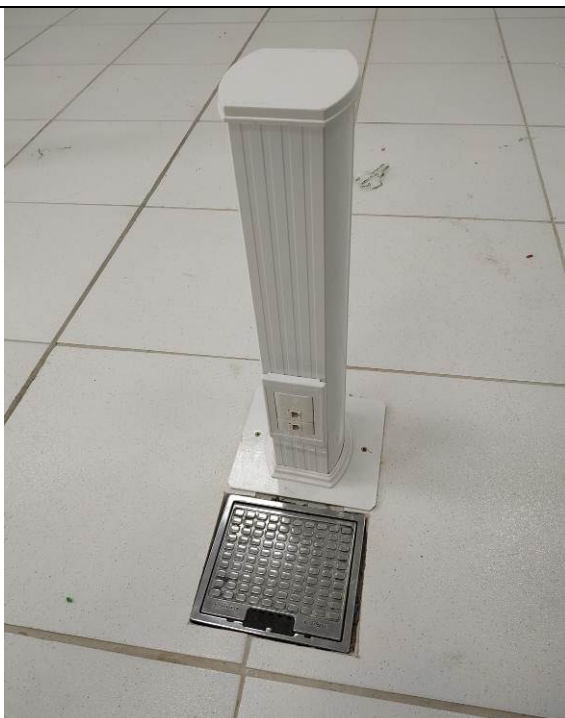
Figura 17E - Totem equipado com pontos lógicos e caixa de passagem
