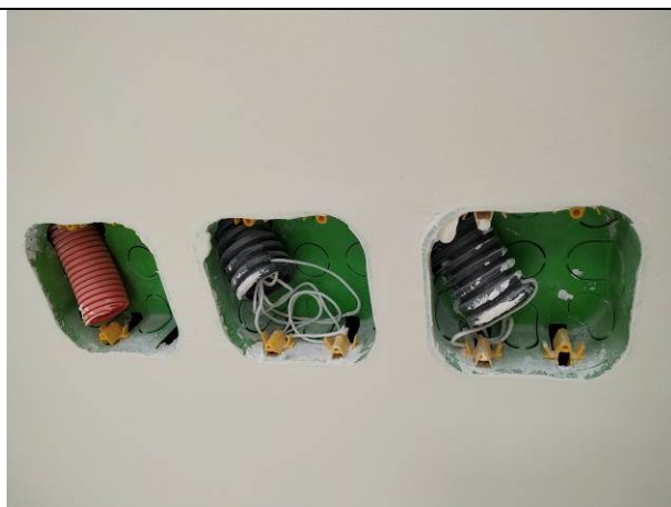
Figura 05E - Infraestrutura interna
