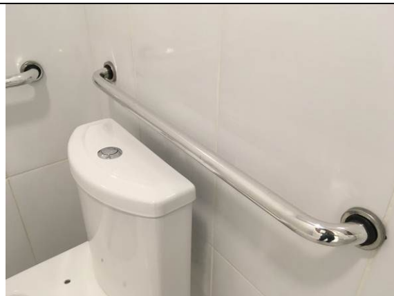
Figura 22C - barras de apoio - bacias
