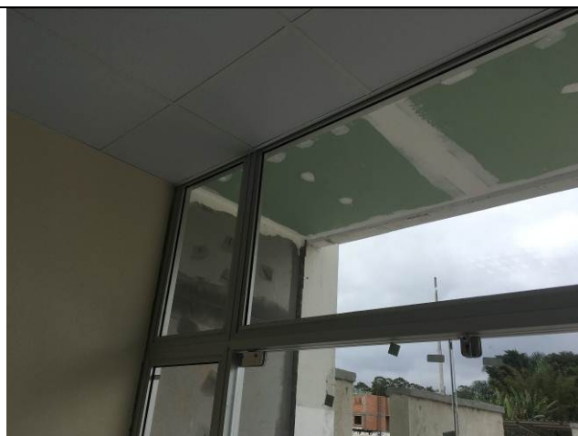
Figura 33C - vidros fixos temperados
