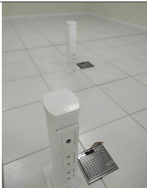
Figura 18E - Pontos lógicos e de sonorização
