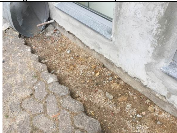
Figura 24C - execução de drenos SPLITS
