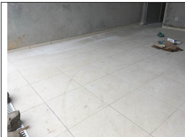
Figura 01C - piso cerâmico - garagem
