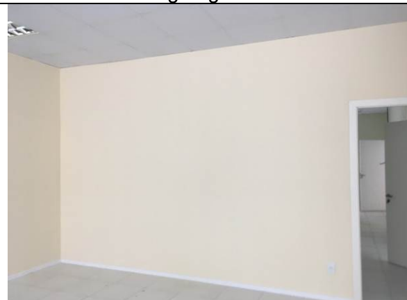
Figura 36C - pintura interna - 4ª VT
