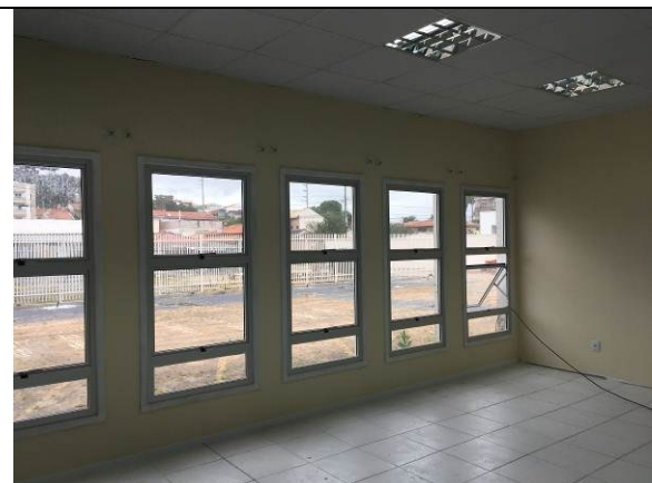
Figura 38C - pintura interna - 4ª VT
