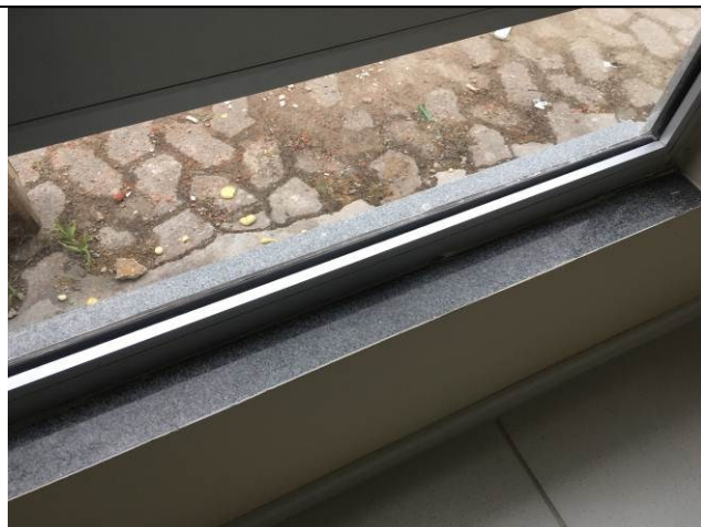
Figura 03C - peitoril de granito - 4ª VT
