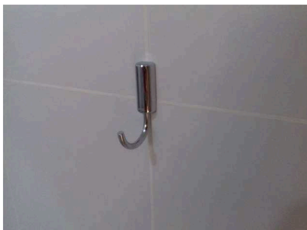
Figura 13C: Cabide tipo gancho, em metal cromado, instalado no sanitário PNE do pavimento superior
