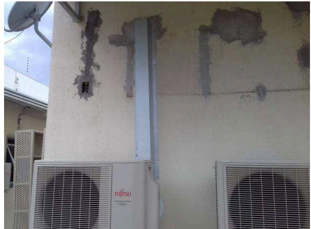
Figura 28C: Aplicação de shaft em parede localizada nos fundos do imóvel
