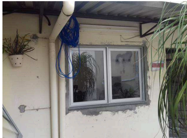
Figura 02C: Instalação de janela e peitoril na sala dos oficiais
