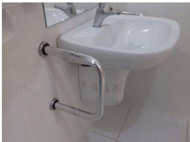
Figura 15C: Barras de apoio para lavatório, instaladas no sanitário PNE do pavimento superior
