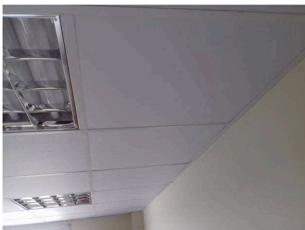
Figura 08C: Forro de gesso acartonado removível, instalado no gabinete do juiz titular
