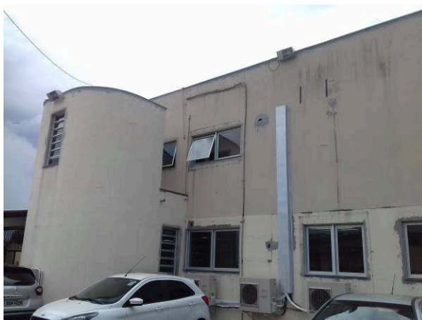
Figura 26C: Aplicação de shaft em parede da lateral esquerda
