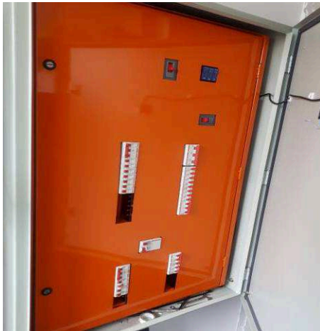
Figura 17E: Quadros elétricos - subtampa com dobradiças
