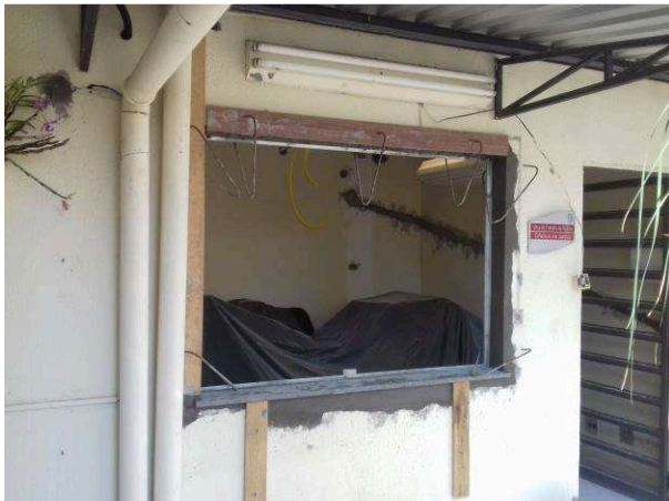
Figura 01C: Requadro da janela da sala dos oficiais
