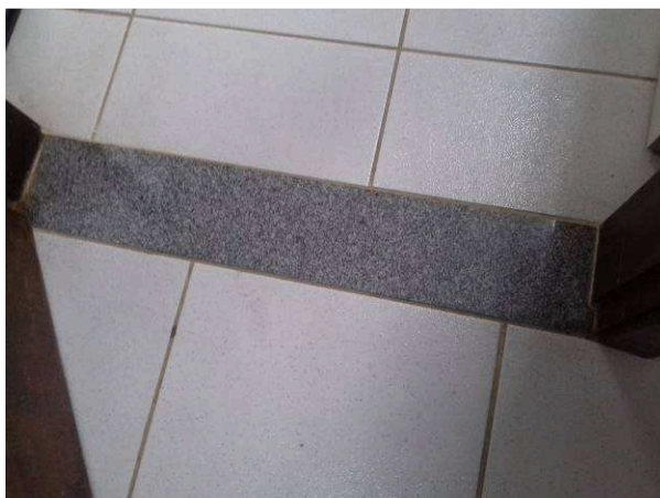
Figura 10C: Soleira em granito, instalada na porta da sala técnica
