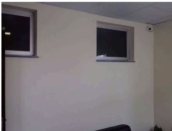
Figura 20C: Pintura das paredes do lobby, no segundo pavimento
