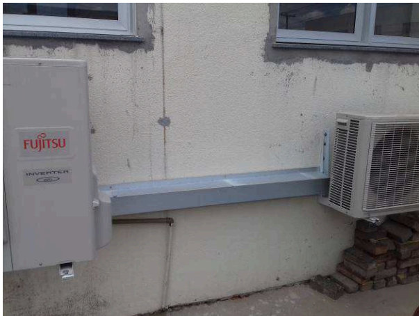
Figura 29C: Aplicação de shaft em parede localizada nos fundos do imóvel
