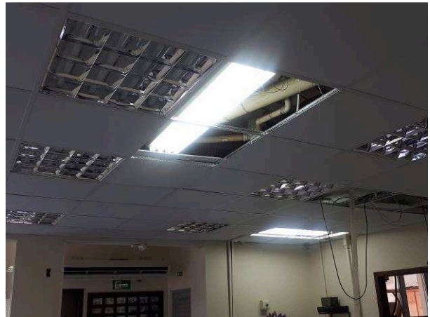
Figura 12E: luminárias com aletas
