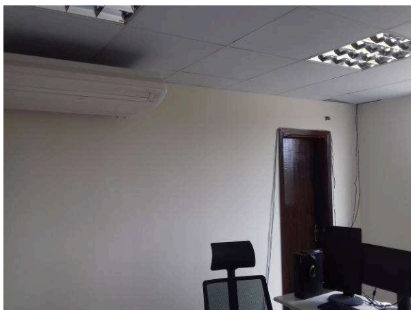
Figura 22C: Pintura das paredes do gabinete do juiz titular, no segundo pavimento
