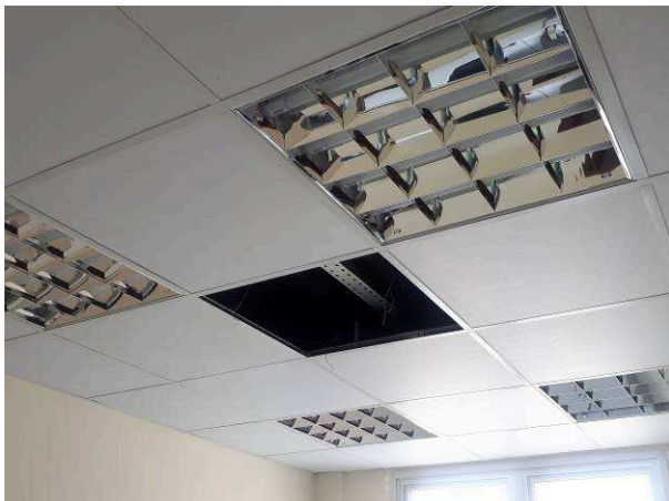
Figura 13E: luminárias com aletas
