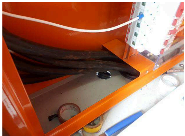
Figura 02E: Ramal alimentador QDG
