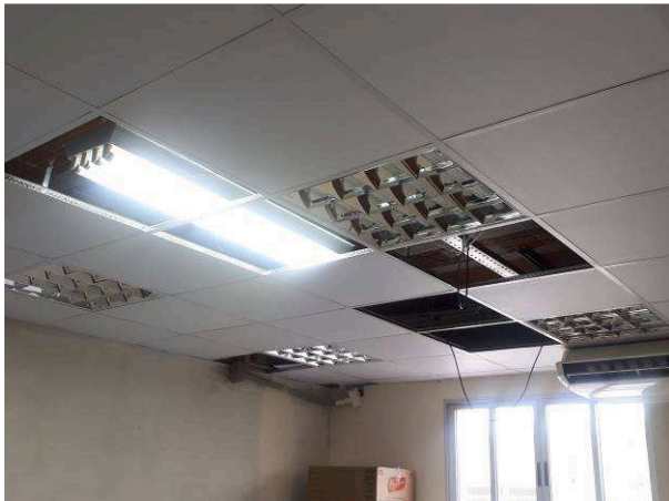
Figura 11E: luminárias com aletas
