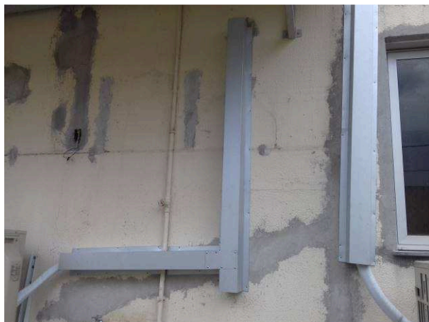
Figura 25C: Aplicação de shaft em parede da lateral direita
