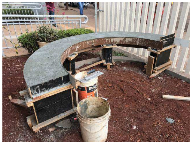
Figura 139C: Bancos em concreto.
