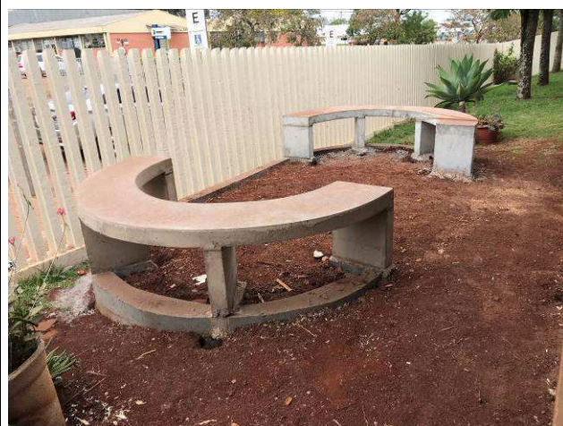
Figura 142C: Bancos em concreto.
