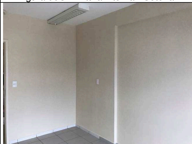
Figura 98C: Pintura interna - Setorial.
