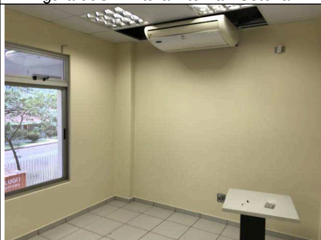
Figura 92C: Pintura interna - Setorial.
