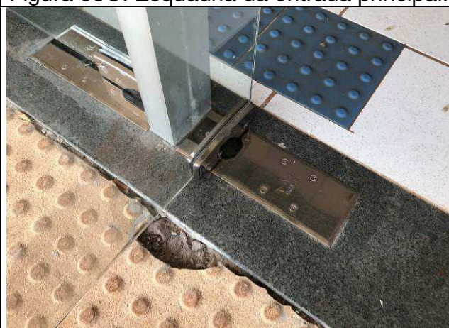
Figura 55C: Esquadria da entrada principal - molas de piso.
