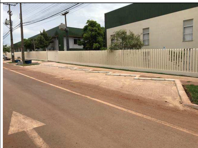
Figura 137C: Estacionamento - Rua Paricis.
