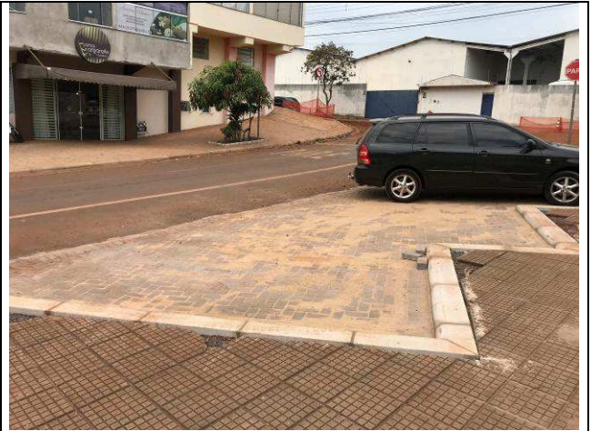
Figura 134C: Estacionamento - Rua Paricis.
