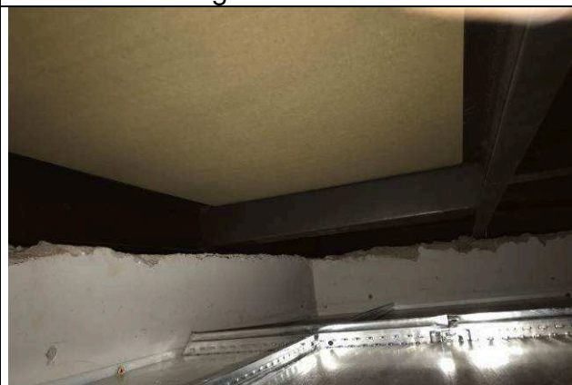
Figura 30C: Estrutura de apoio e caixa de água - Setorial.
