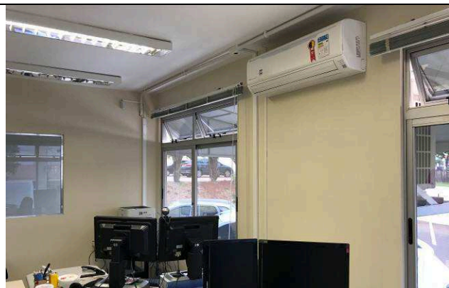
Figura 129C: Evaporadoras - Térreo da Setorial.
