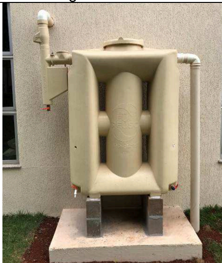
Figura 31C: Kit cisterna de polietileno - aproveitamento de águas pluviais.
