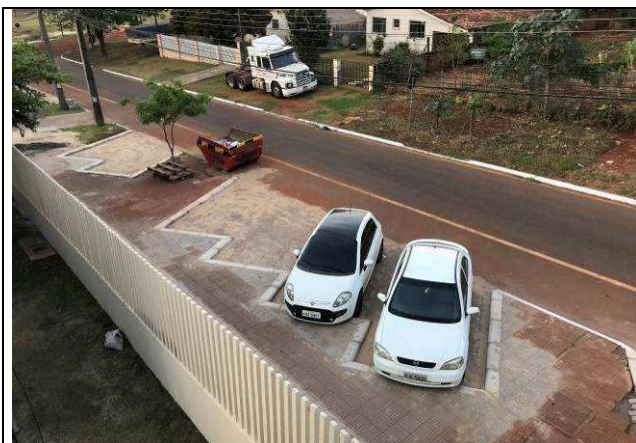
Figura 131C: Estacionamento - Rua Paricis.
