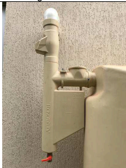
Figura 32C: Kit cisterna de polietileno - filtros - aproveitamento de águas pluviais.
