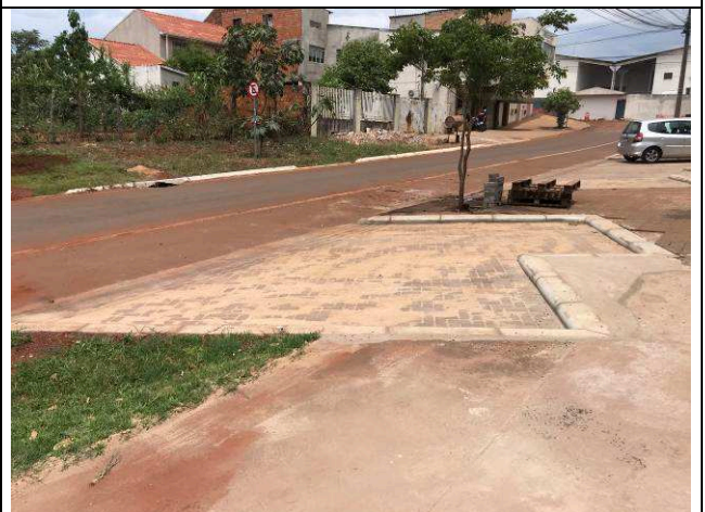
Figura 136C: Estacionamento - Rua Paricis.
