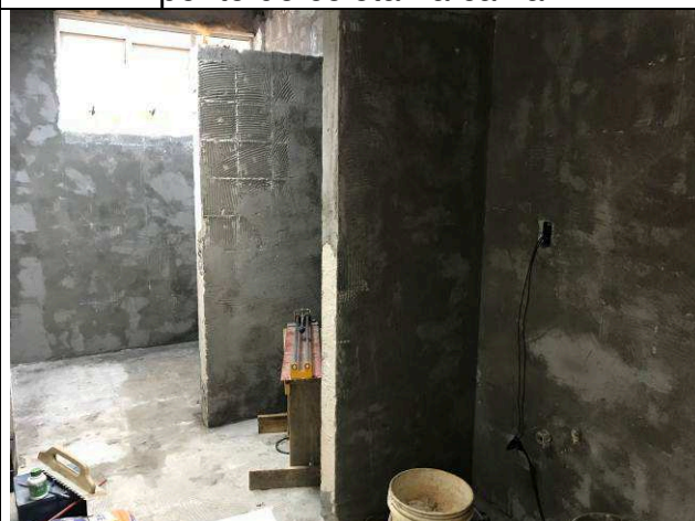
Figura 36C: Demolição do banheiro público masculino.
