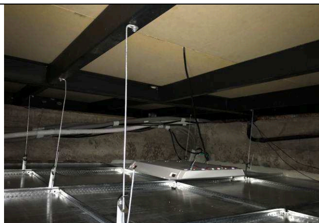
Figura 27C: Estrutura de apoio e caixas de água - 1ª Vara.
