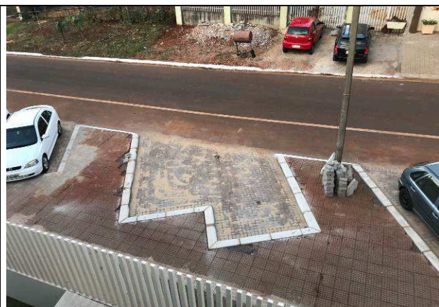
Figura 132C: Estacionamento - Rua Paricis.
