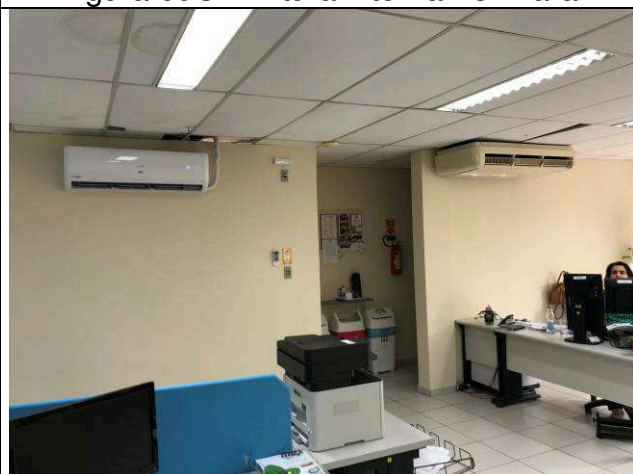
Figura 71C: Pintura interna - 3ª Vara.
