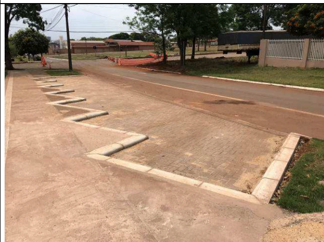
Figura 135C: Estacionamento - Rua Paricis.
