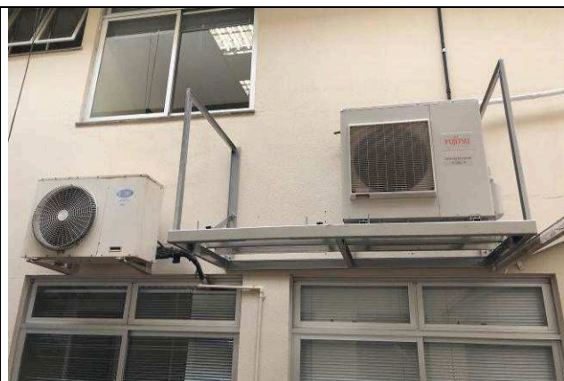
Figura 128C: Rede frigorígena nova e condensadora - Distribuição.
