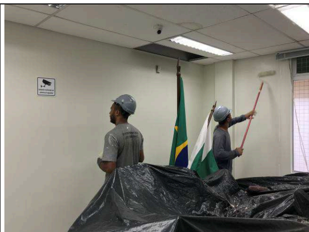
Figura 81C: Pintura interna - 4ª Vara.
