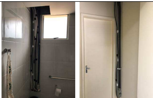
Figura 121C: Rede frigorígena nova - 3ª Vara.
