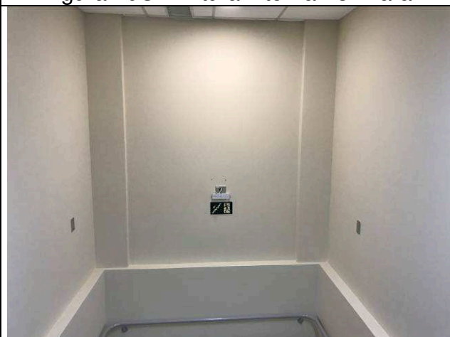
Figura 72C: Pintura interna - 3ª Vara.
