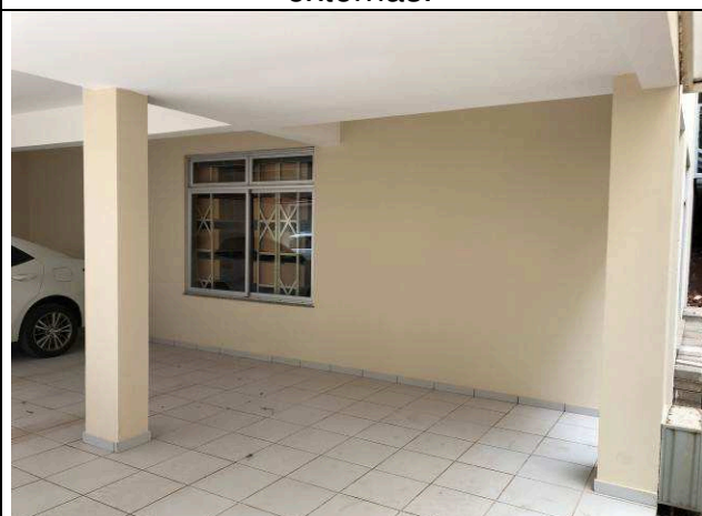
Figura 112C: Pintura das fachadas externas.
