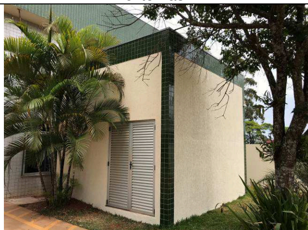
Figura 105C: Pintura das fachadas externas.
