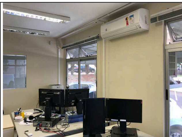
Figura 94C: Pintura interna - Setorial.
