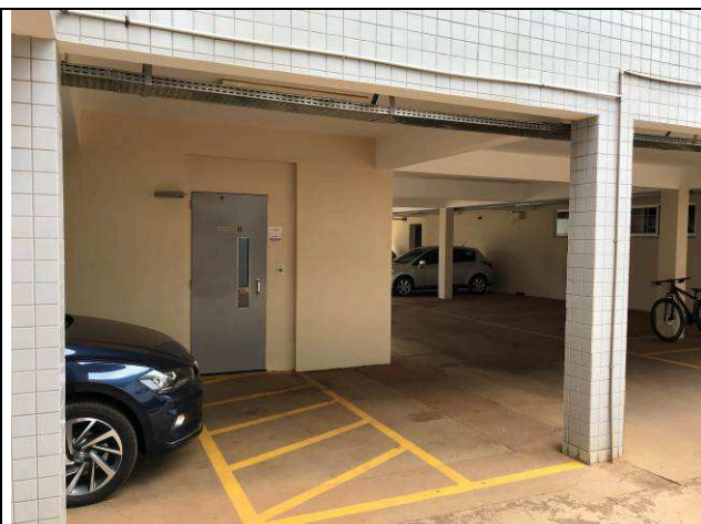
Figura 110C: Pintura das fachadas externas.
