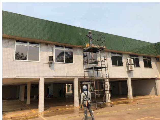
Figura 02C: Andaime metálico.
