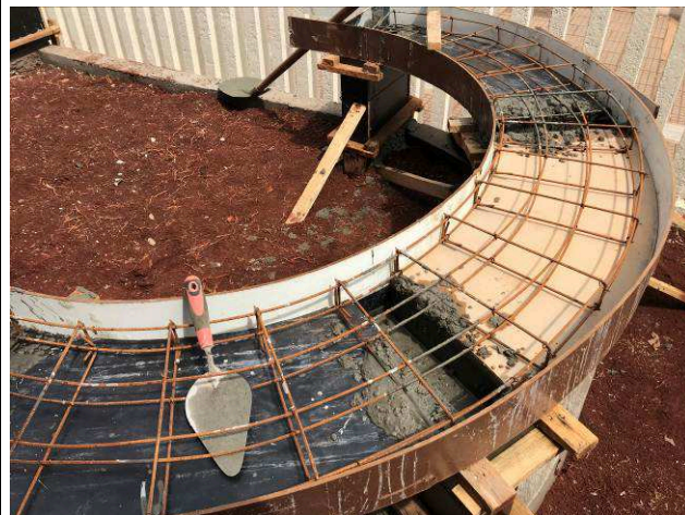
Figura 140C: Bancos em concreto.
