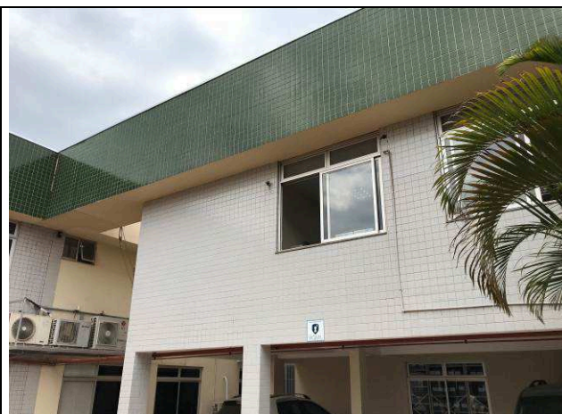
Figura 104C: Lavagem das pastilhas e pintura das fachadas externas.
