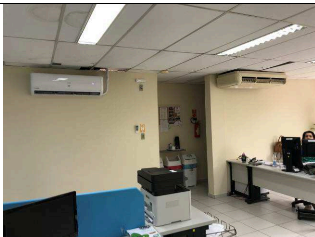
Figura 123C: Evaporadoras - 3ª Vara.
