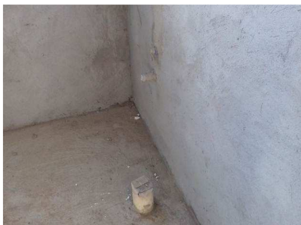
Figura 30C: Contrapiso executado em sanitário da secretaria
