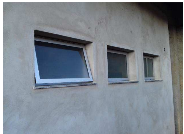
Figura 14C: Janelas 90x60cm, instaladas na copa da vara
