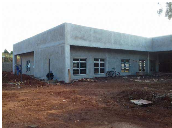
Figura 04C: Lateral esquerda (estacionamento), com valas já fechadas
