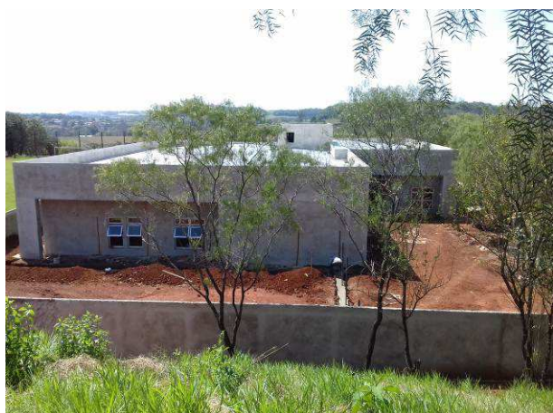
Figura 25C: Rebôco de parede externa - lateral esquerda
