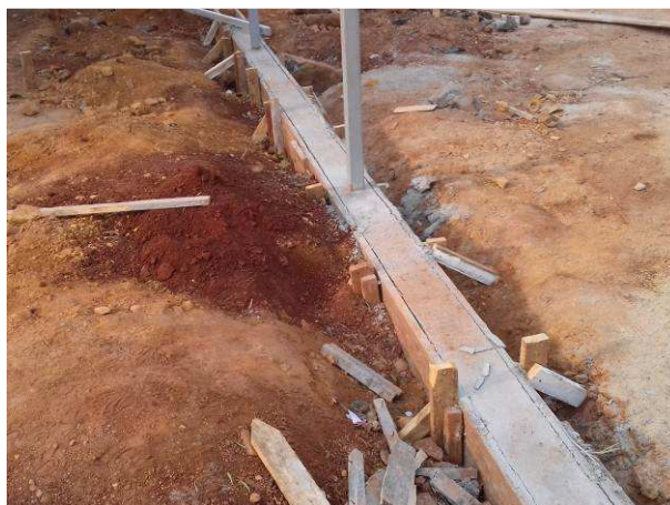
Figura 44C: Viga baldrame já concretada, na lateral direita do imóvel
