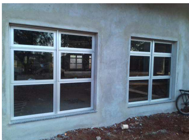
Figura 07C: Janelas 180x180cm, instaladas na sala de audiência 1
