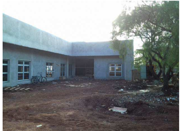
Figura 10C: Janelas 180x180cm, instaladas no PAB, sala de audiência 1, conciliação 1 e testemunhas
