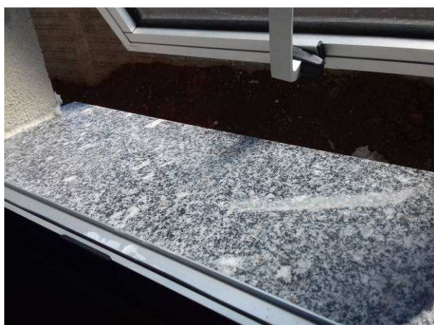
Figura 37C: Detalhe de peitoril instalado em janela da copa
