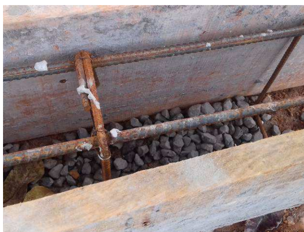
Figura 42C: Preparo de fôrmas e armaduras para execução das vigas baldrames do gradil
