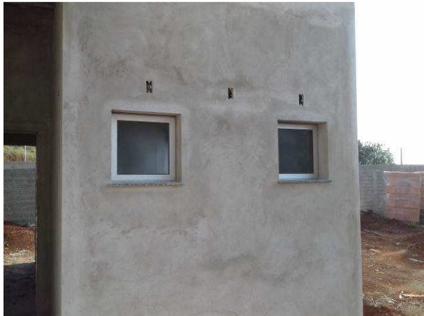
Figura 11C: Janelas 60x60cm, instaladas na sala técnica
