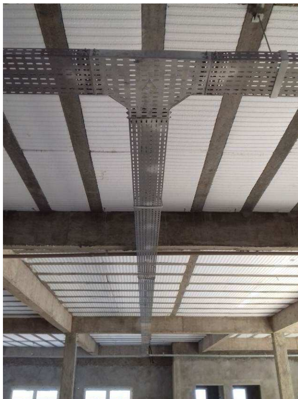
Figura 15E: Tê U #200x50, sobre sala de conciliação 1
