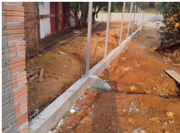
Figura 45C: Viga baldrame concretada, com os montantes do gradil chumbados
