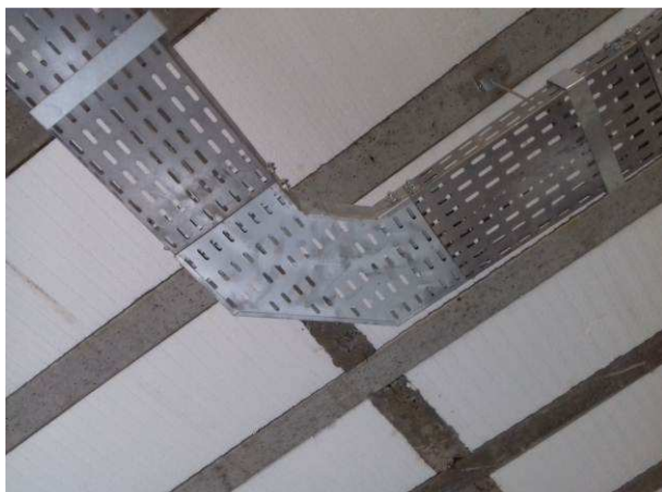
Figura 07E: Curva de 90º #200x50, sobre a sala de audiência 1
