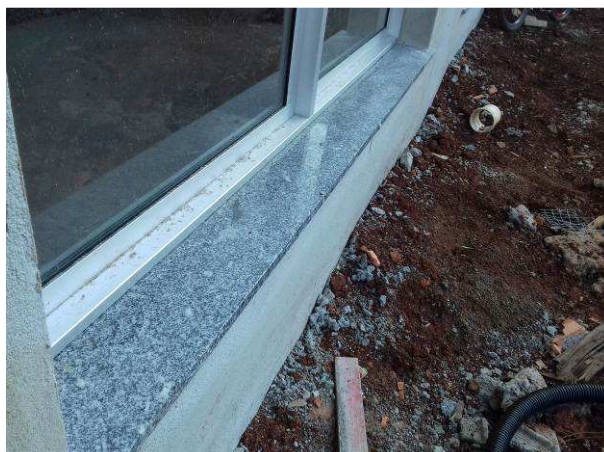
Figura 34C: Peitoril instalado na janela da OAB
