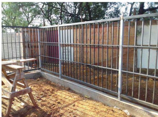
Figura 47C: Gradil instalado na parte frontal e lateral direita
