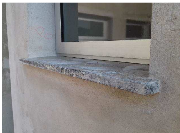
Figura 35C: Peitoril instalado em janela de BWC público
