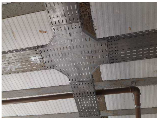
Figura 12E: Cruzeta #200x50, instalada sobre a sala de conciliação 2
