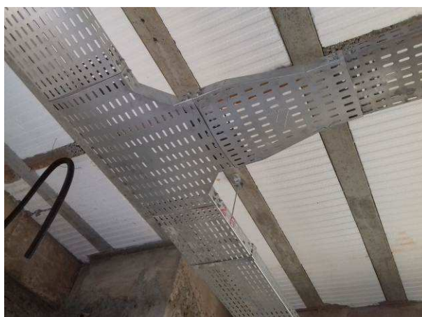
Figura 14E: Tê U #300x50 e Redução concêntrica de U #300x50 para U #200x50
