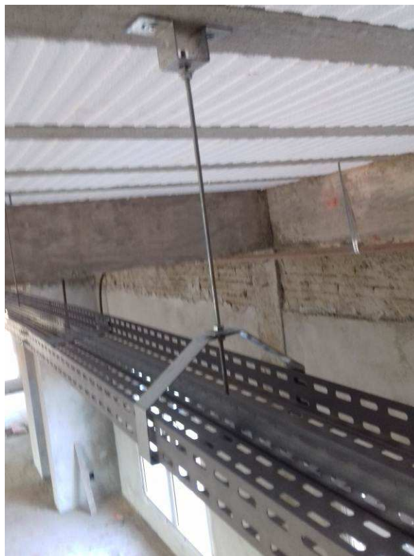
Figura 16E: Detalhe de eletrocalha e seu septo divisor
