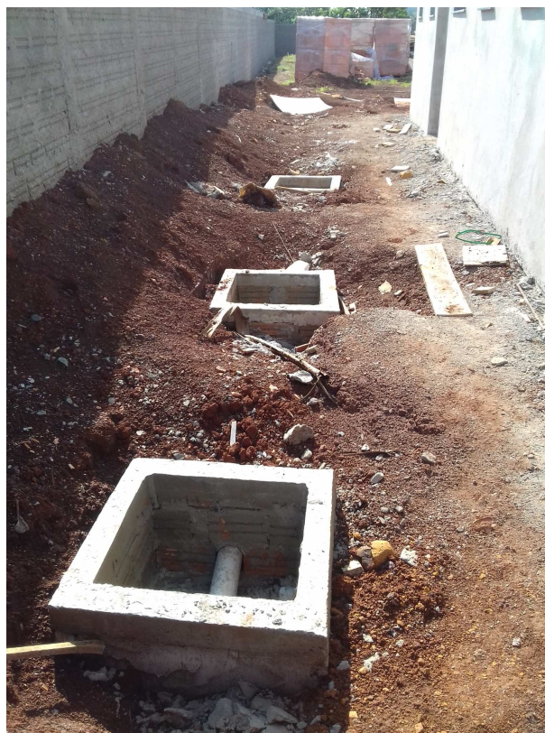
Figura 02C: Valas já fechadas, na parte posterior do imóvel
