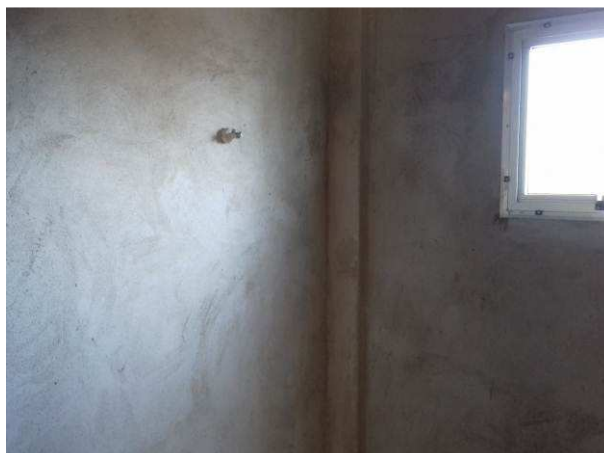
Figura 22C: Rebôco de parede em sanitário do juiz auxiliar
