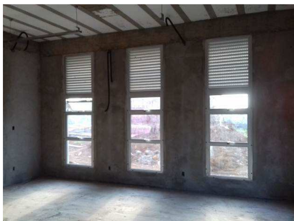
Figura 18C: Janelas 90x175cm e venezianas 90x145cm, instaladas na sala múltiplo uso
