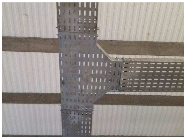
Figura 09E: Tê de #200x50, sobre a sala de audiência 1
