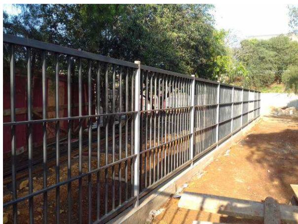
Figura 48C: Gradil instalado na parte frontal
