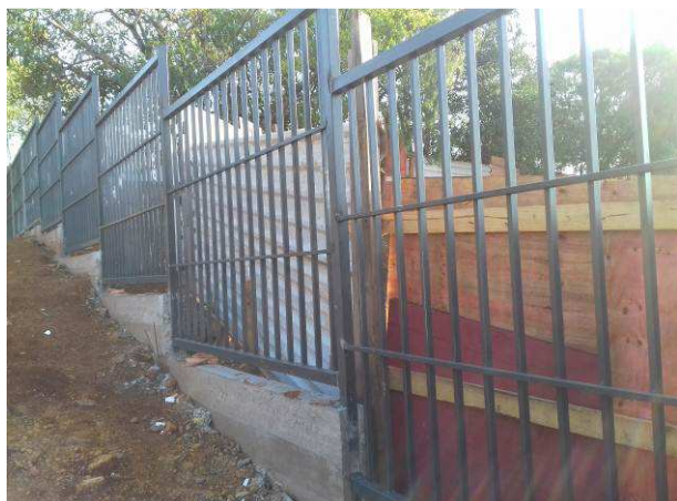
Figura 49C: Gradil instalado na parte frontal, escalonado na porção em rampa
