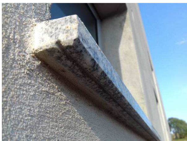
Figura 32C: Detalhe de pingadeira, sob o peitoril em granito
