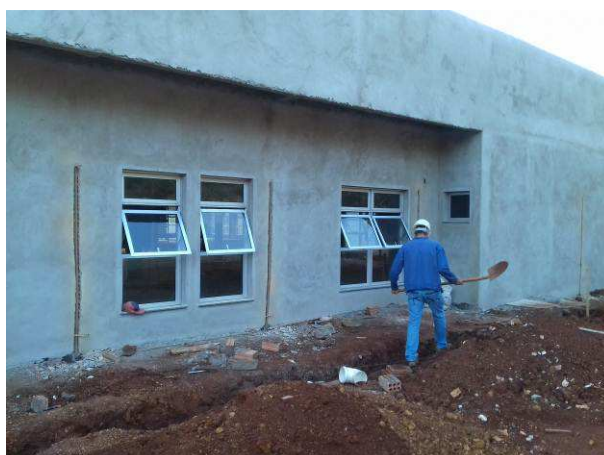
Figura 24C: Rebôco de parede externa - lateral esquerda
