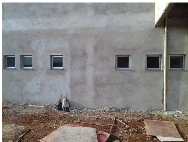
Figura 06C: Lateral direita após fechamento das valas
