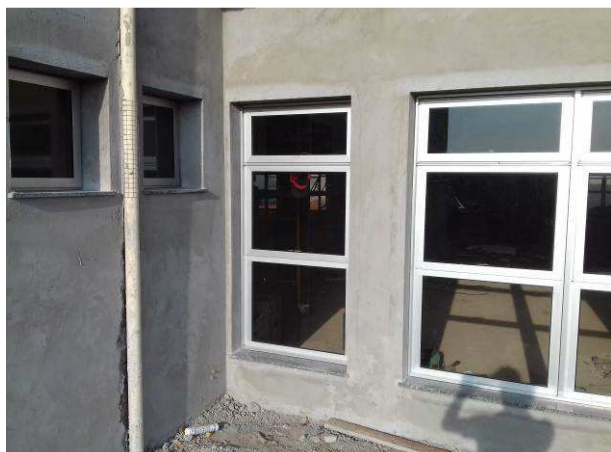
Figura 15C: Janela 90x180cm, instalada na sala de conciliação 2
