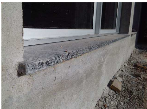
Figura 31C: Detalhe de peitoril executado em janela tamanho 180x180cm, na secretaria
