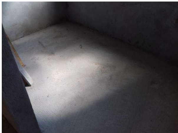
Figura 28C: Contrapiso executado na copa
