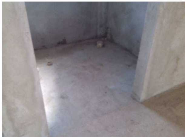
Figura 27C: Contrapiso executado em sanitário público
