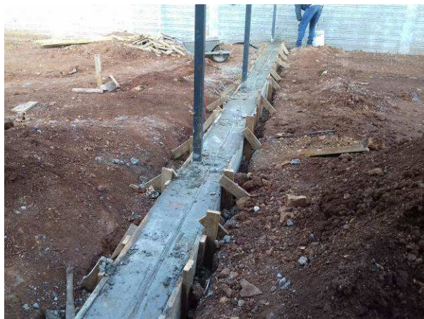
Figura 46C: Viga baldrame concretada, na lateral esquerda (estacionamento)
