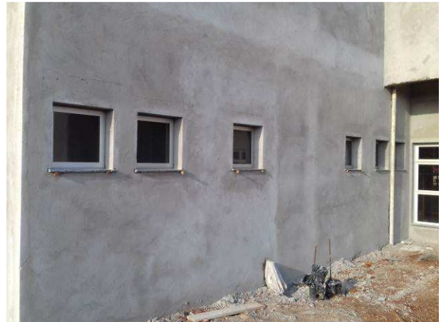
Figura 12C: Janelas 60x60cm, instaladas nos sanitários públicos e terceirizados
