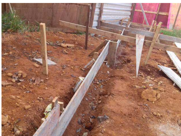
Figura 41C: Preparo de fôrmas para execução das vigas baldrames do gradil
