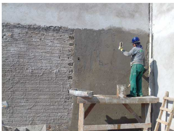
Figura 26C: Operário executando reboco na lateral esquerda
