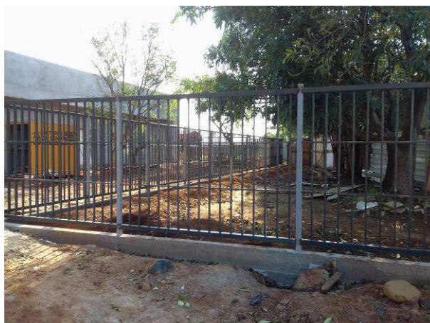
Figura 52C: Gradil instalado na parte frontal plana
