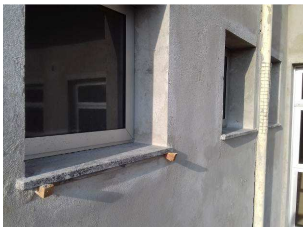
Figura 36C: Peitoris instalados em janelas de BWCs públicos
