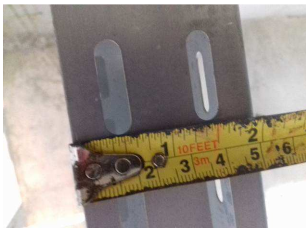
Figura 11E: Aferição da altura de eletrocalha U #200x50
