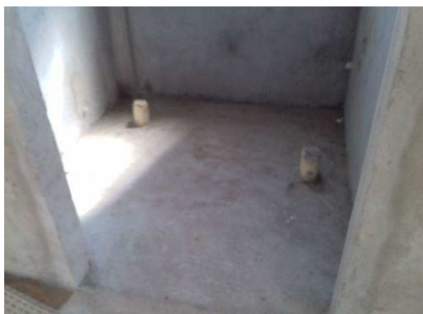
Figura 29C: Contrapiso executado em sanitário da secretaria
