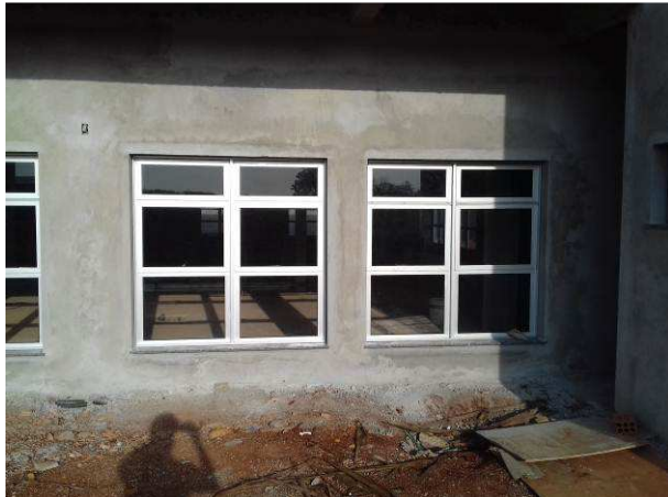
Figura 09C: Janelas 180x180cm, instaladas na sala de audiência 2 e gabinete do juiz auxiliar
