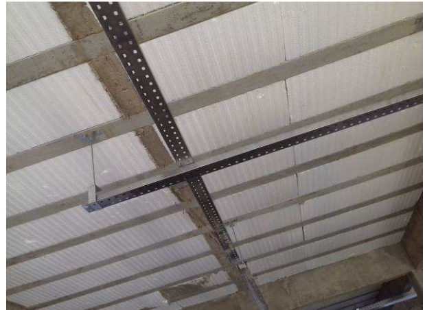
Figura 04E: Perfilados #38x76mm, na região do hall público
