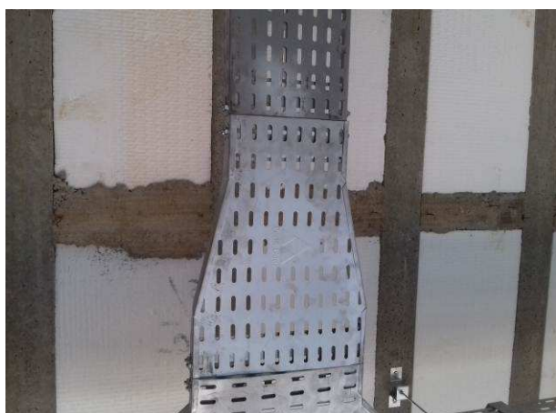
Figura 13E: Redução concêntrica de U #300x50 para U #200x50
