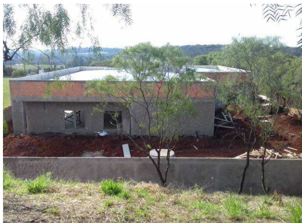
Figura 03C: Lateral esquerda (estacionamento), com valas abertas para passagem da rede pluvial
