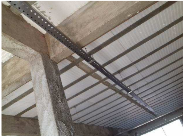
Figura 03E: Perfilado #38x76mm, na região do PAB
