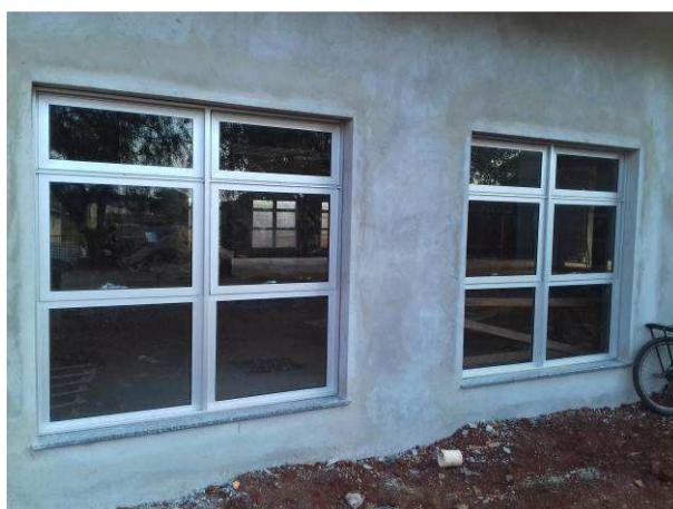
Figura 38C: Peitoris instalados em janelas da sala de audiência principal
