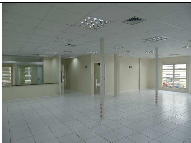
Figura 102C: Pintura paredes internas - Fórum.
