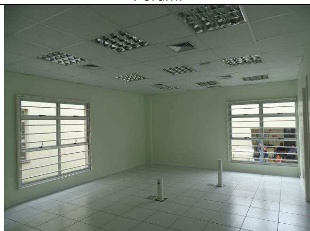
Figura 97C: Pintura paredes internas - Fórum.
