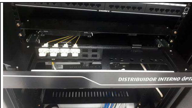
Figura 34E: racks, DIOs, fusão fibras
