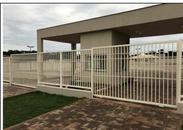
Figura 88C: Pintura portões de veículos.
