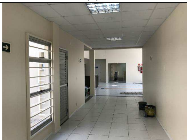
Figura 115C: Pintura paredes internas - Fórum.
