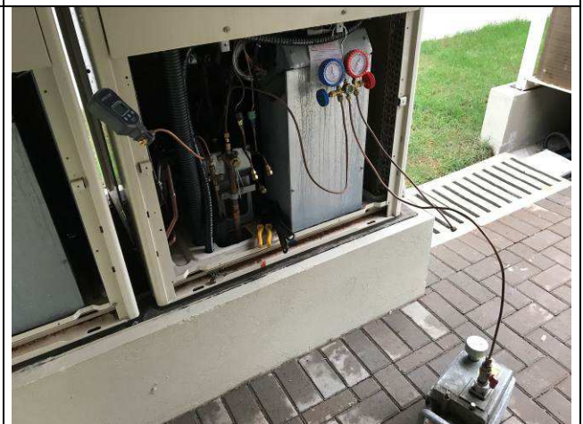
Figura 46C: Execução de vácuo nas linhas do sistema VRF.
