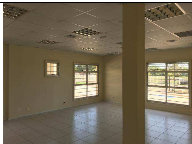
Figura 112C: Pintura paredes internas - Fórum.
