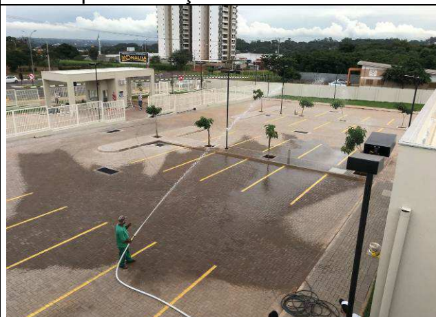
Figura 62C: Teste de funcionamento da pressurização do sistema.
