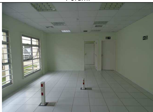
Figura 105C: Pintura paredes internas - Fórum.
