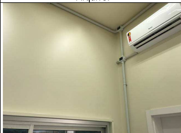
Figura 118C: Pintura paredes internas - Guarita.
