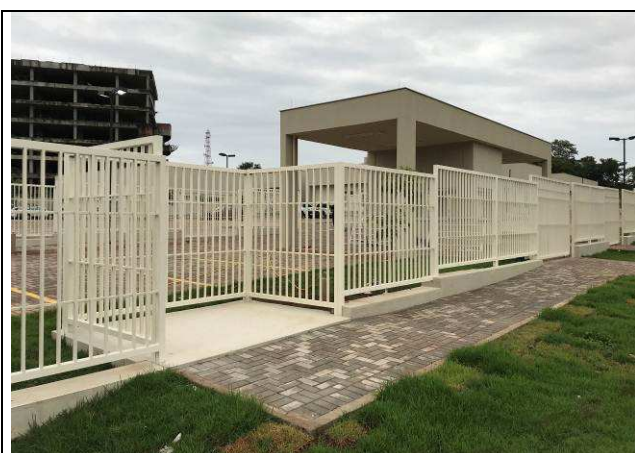
Figura 87C: Pintura do gradil externo.
