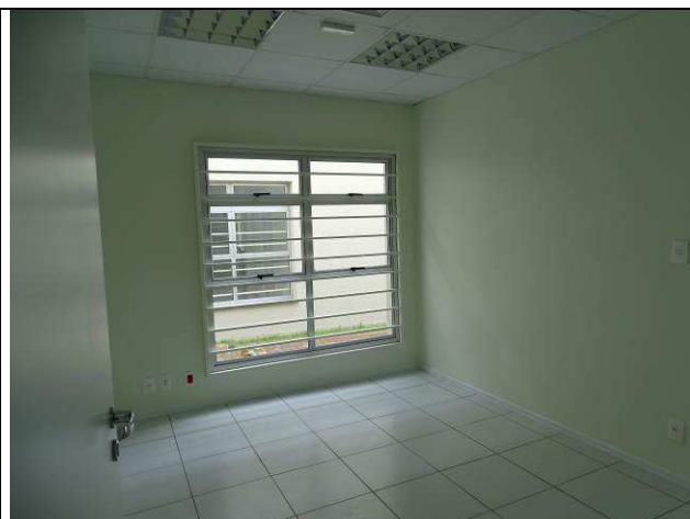
Figura 96C: Pintura paredes internas - Fórum.
