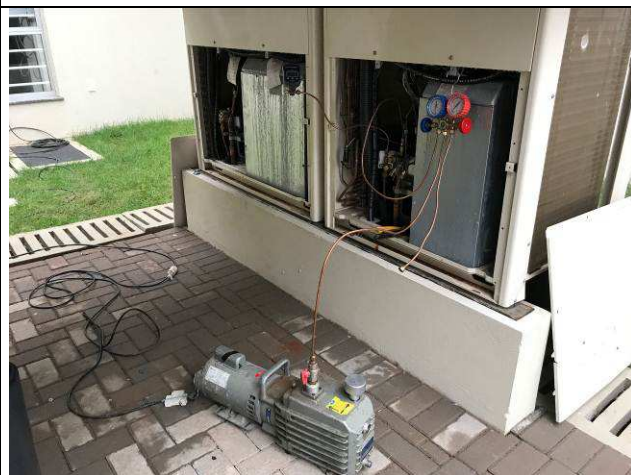
Figura 45C: Execução de vácuo nas linhas do sistema VRF.
