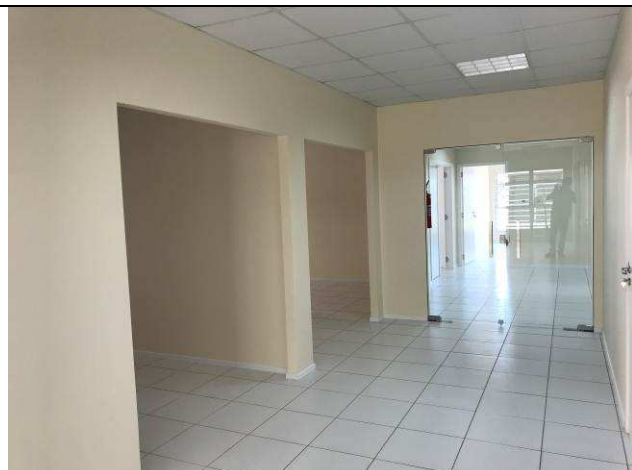
Figura 109C: Pintura paredes internas - Fórum.
