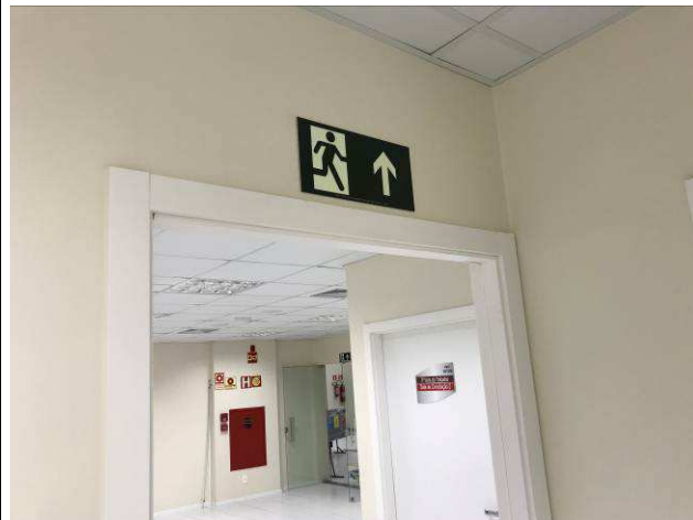
Figura 74C: Placas de sinalização.
