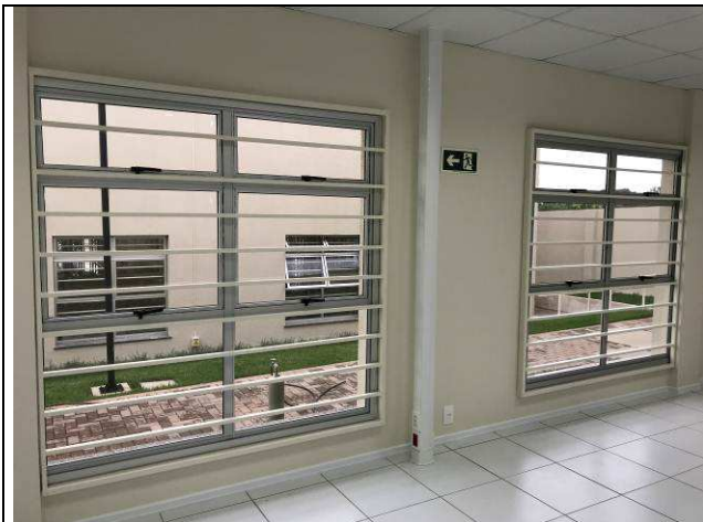
Figura 03C: Janela de alumínio - limitador de abertura.
