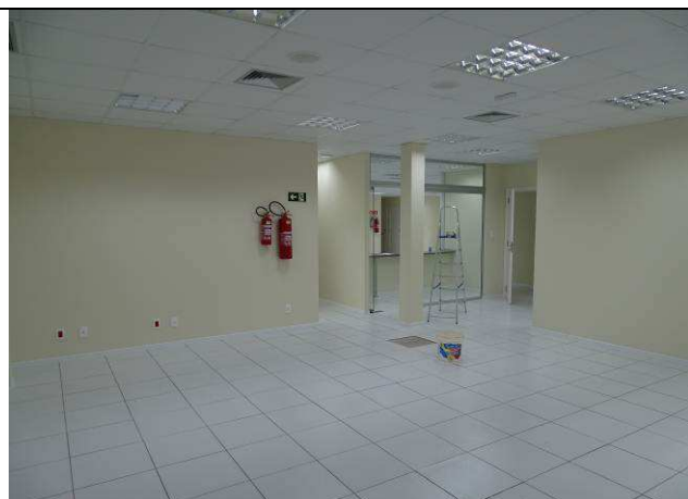
Figura 107C: Pintura paredes internas - Fórum.
