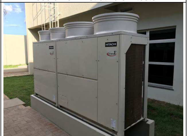
Figura 52C: Conjunto de condensadoras da 2ª Vara em teste.
