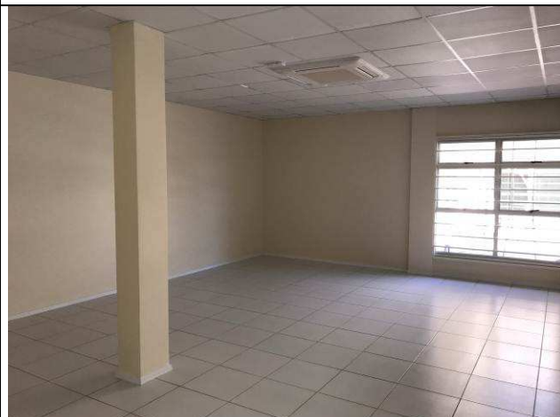
Figura 110C: Pintura paredes internas - Fórum.
