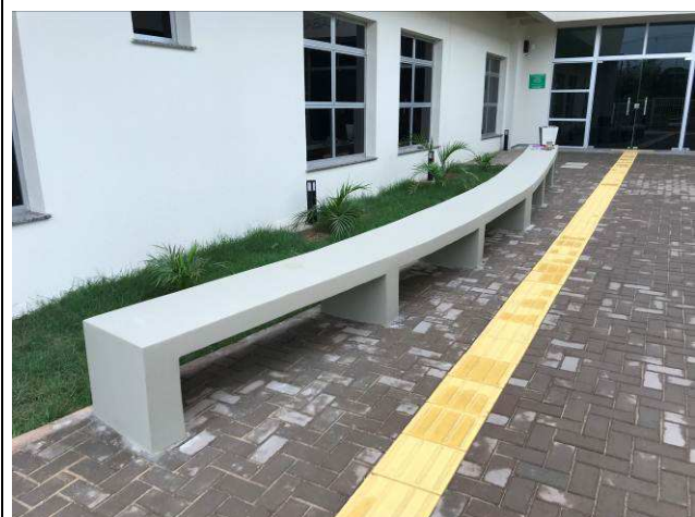
Figura 121C: Bancos de concreto.
