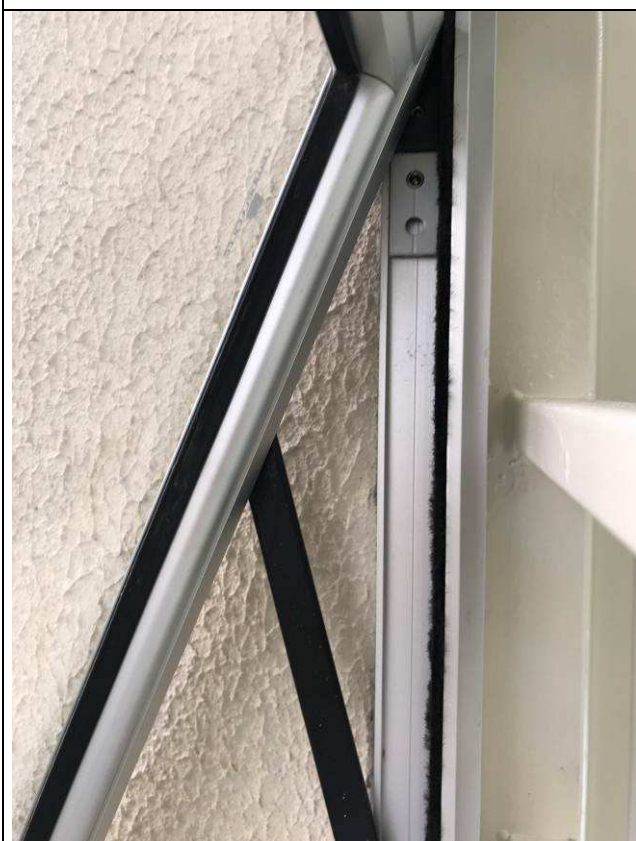
Figura 05C: Janela de alumínio - limitador de abertura da folha inferior.
