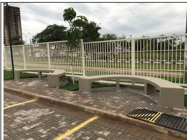
Figura 123C: Bancos de concreto.
