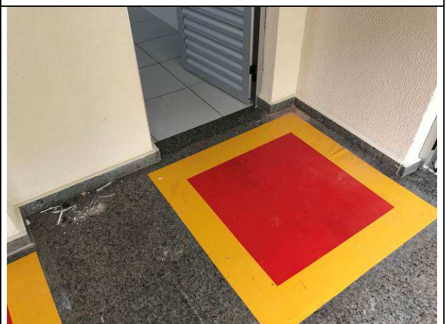
Figura 24C: Rodapé em granito - Arquivo.
