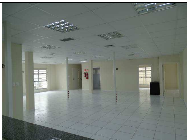
Figura 95C: Pintura paredes internas - Fórum.
