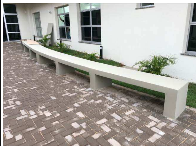
Figura 122C: Bancos de concreto.
