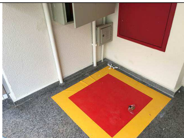
Figura 23C: Rodapé em granito - Arquivo.
