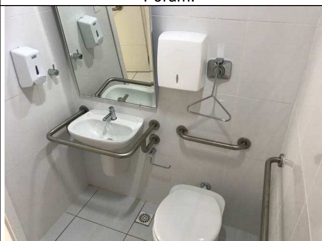
Figura 37C: Banheiro público feminino PNE - Fórum.
