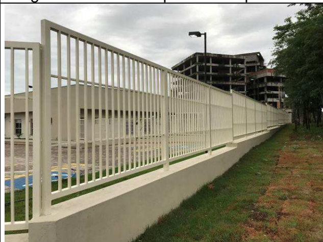
Figura 91C: Pintura do gradil externo.
