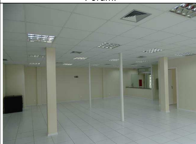
Figura 100C: Pintura paredes internas - Fórum.
