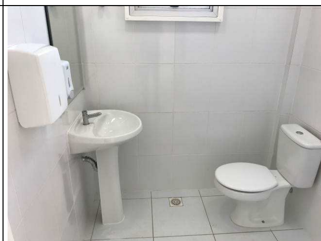
Figura 32C: Banheiro de secretaria - Fórum.
