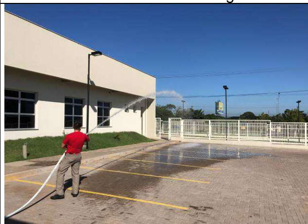
Figura 61C: Teste de funcionamento da pressurização do sistema.
