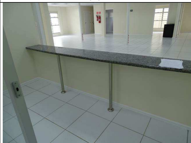
Figura 94C: Pintura paredes internas - Fórum.
