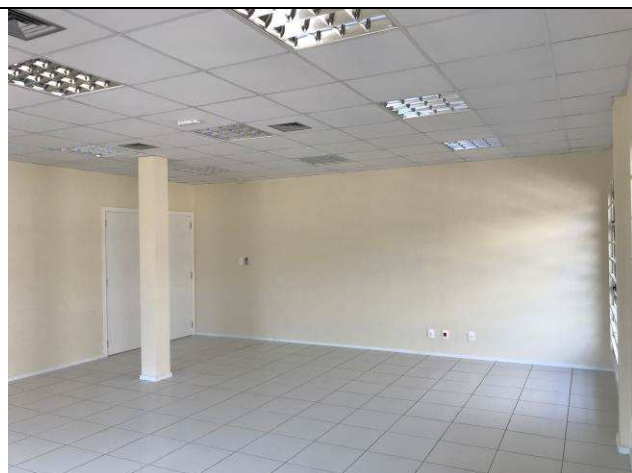
Figura 113C: Pintura paredes internas - Fórum.
