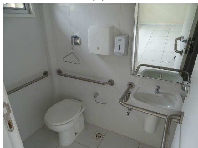
Figura 35C: Banheiro gabinete de juiz PNE - Fórum.
