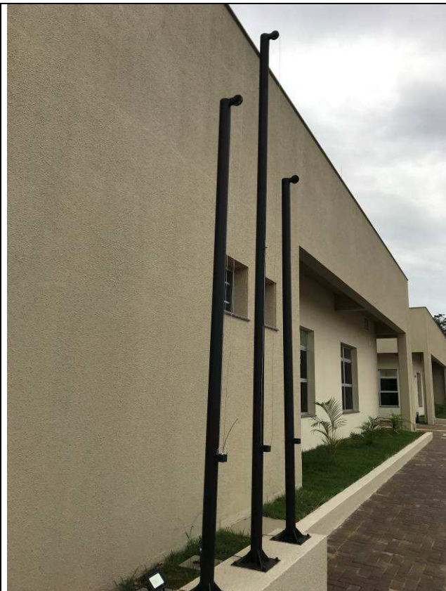
Figura 120C: Mastros de bandeiras.
