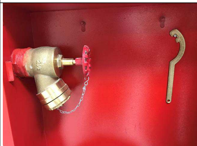
Figura 59C: Registro globo angular e chave storz no interior dos abrigos.
