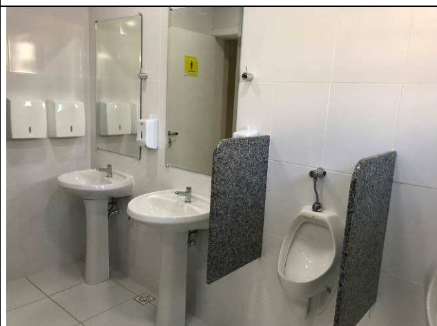
Figura 36C: Banheiro público masculino - Fórum.
