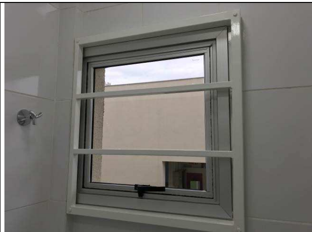
Figura 04C: Janela de alumínio - limitador de abertura.
