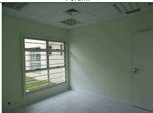
Figura 106C: Pintura paredes internas - Fórum.
