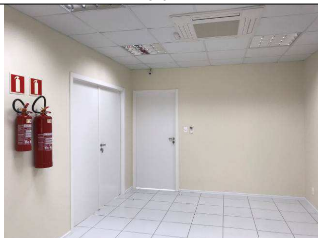
Figura 111C: Pintura paredes internas - Fórum.
