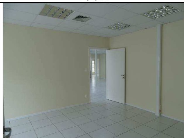
Figura 98C: Pintura paredes internas - Fórum.
