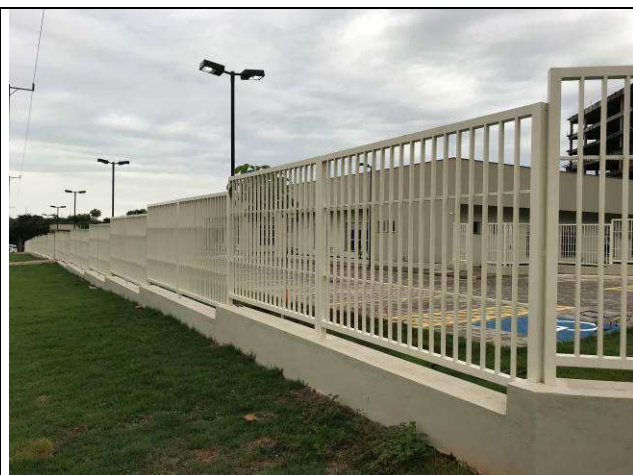
Figura 90C: Pintura do gradil externo.
