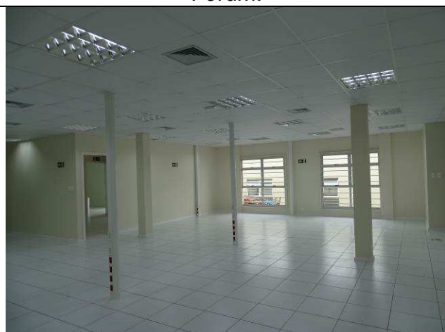
Figura 103C: Pintura paredes internas - Fórum.
