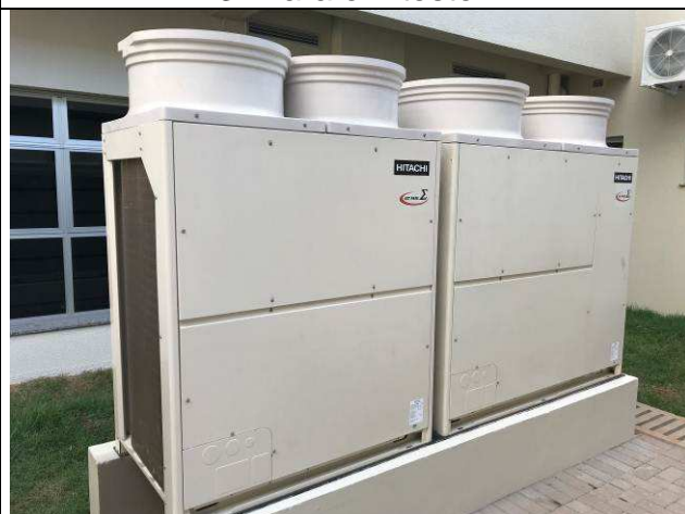
Figura 51C: Conjunto de condensadoras da 1ª Vara em teste.
