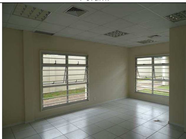
Figura 104C: Pintura paredes internas - Fórum.
