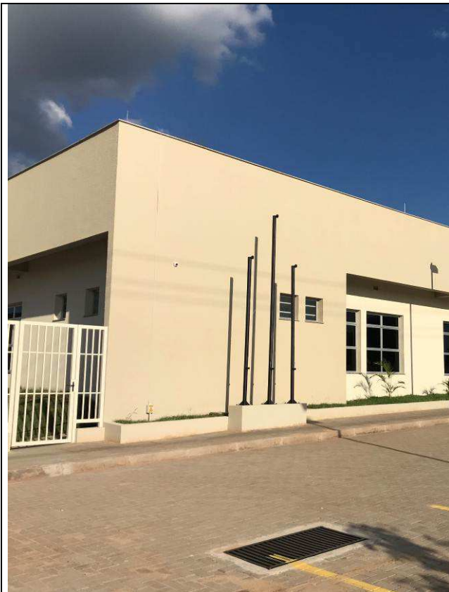
Figura 119C: Mastros de bandeiras.
