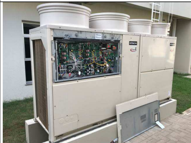
Figura 49C: Conjunto de condensadoras da 3ª Vara em teste.
