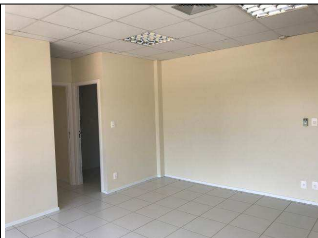
Figura 114C: Pintura paredes internas - Fórum.
