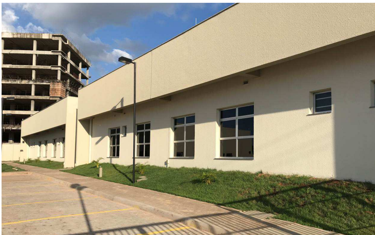
Figura 4 – Prédio do Fórum – vista externa.
