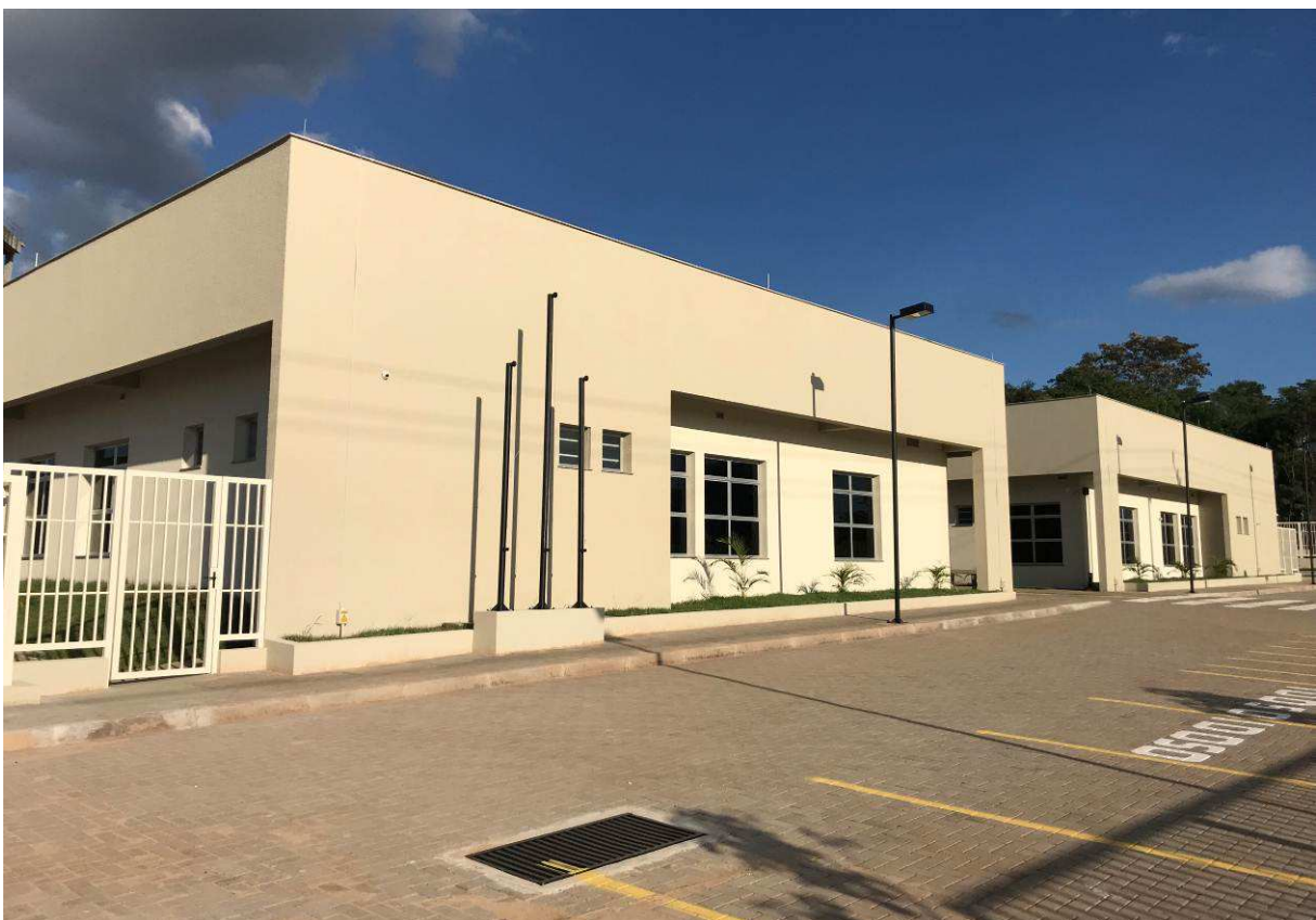
Figura 3 – Prédio do Fórum – vista externa.
