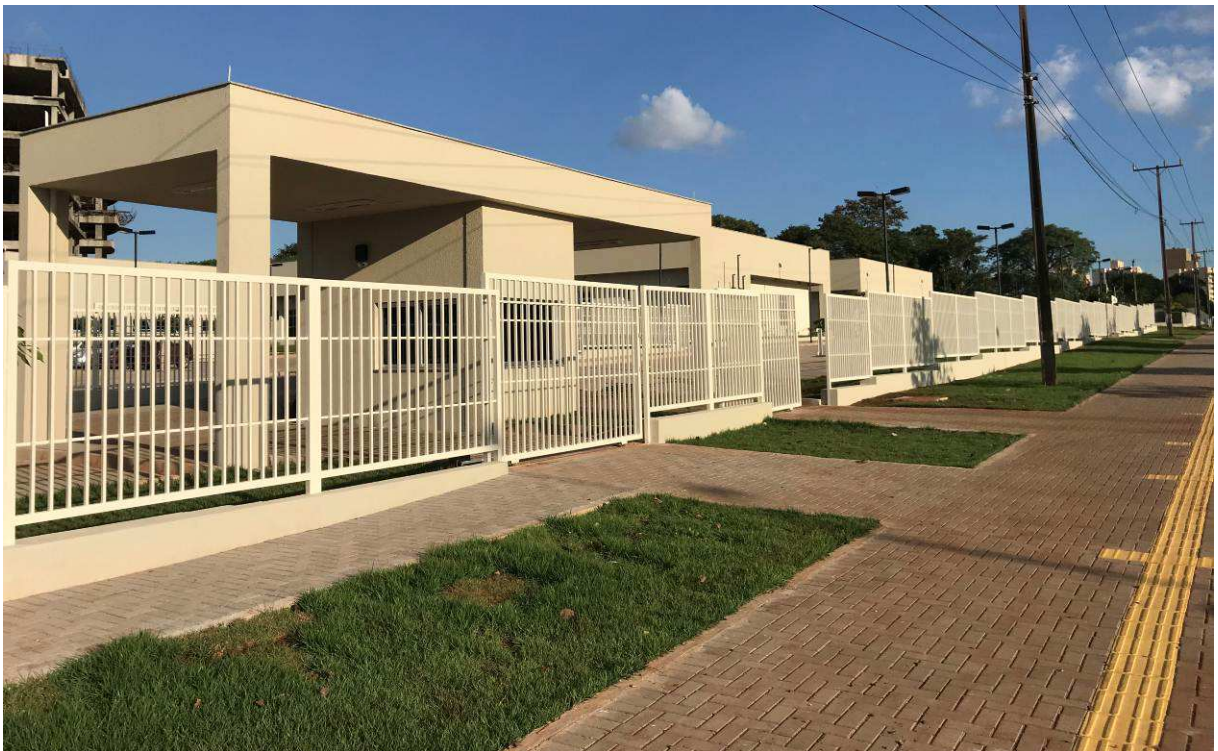
Figura 6 – Guarita – vista externa.
