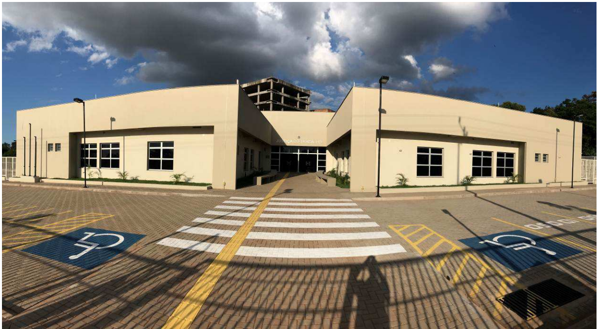
Figura 2 – Prédio do Fórum – vista externa.
