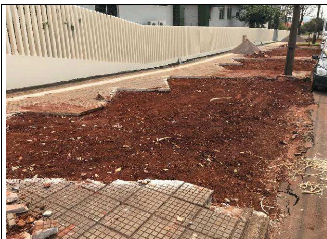
Figura 101C: Estacionamento - Rua Paricis.
