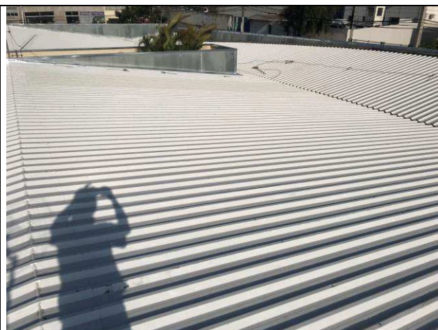
Figura 20C: Cobertura - Hall Público / PAB / OAB.
