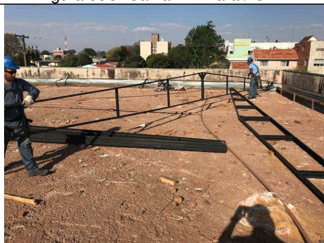
Figura 35C: Estrutura metálica de cobertura - 3ª Vara.
