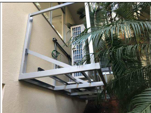
Figura 88C: Rede frigorígena nova e condensadoras - 1ª Vara.
