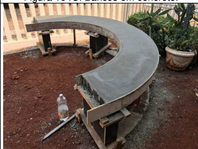
Figura 106C: Bancos em concreto.
