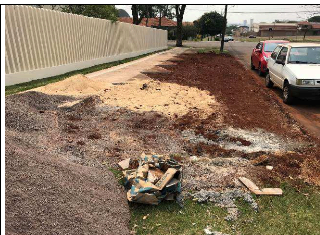
Figura 102C: Estacionamento - Rua Paricis.
