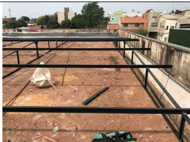
Figura 37C: Estrutura metálica de cobertura - 3ª Vara.
