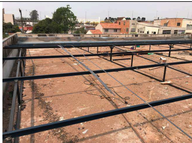
Figura 39C: Estrutura metálica de cobertura - 3ª Vara.
