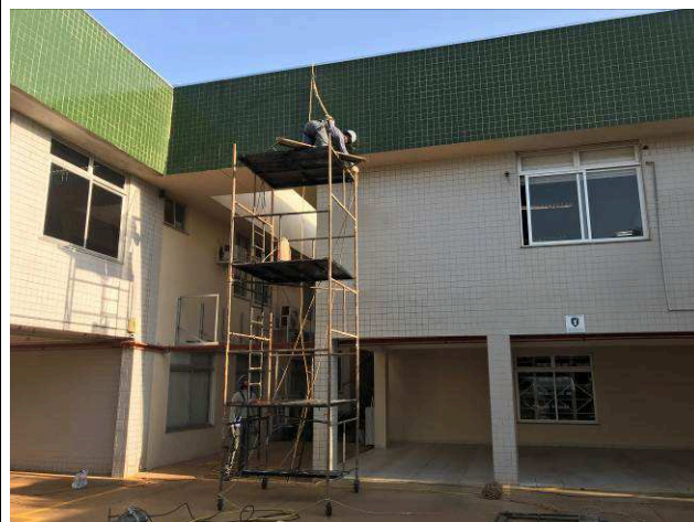
Figura 02C: Andaime metálico.
