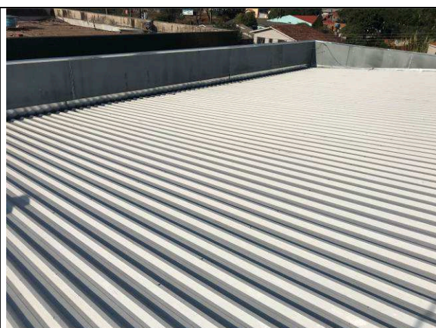
Figura 07C: Cobertura - 1ª Vara.
