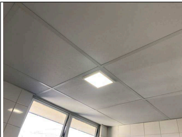
Figura 59C: Forro - 1ª Vara.
