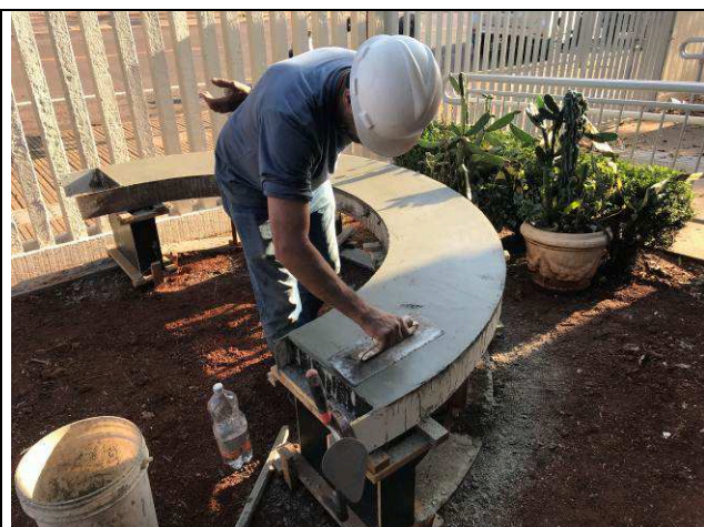
Figura 104C: Bancos em concreto.
