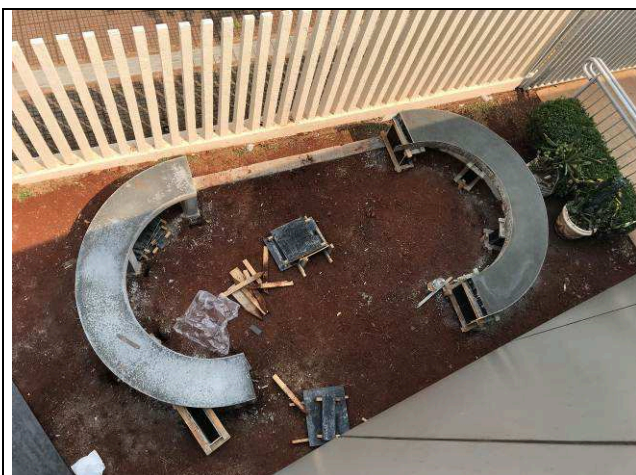
Figura 103C: Bancos em concreto.
