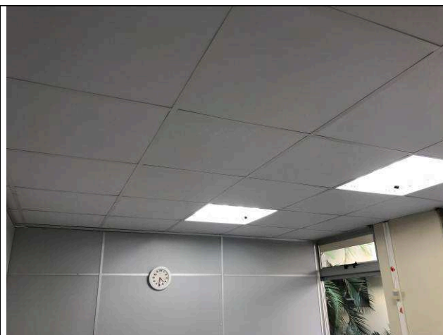
Figura 66C: Forro - 1ª Vara.
