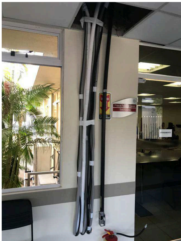
Figura 91C: Rede frigorígena nova - 1ª Vara.
