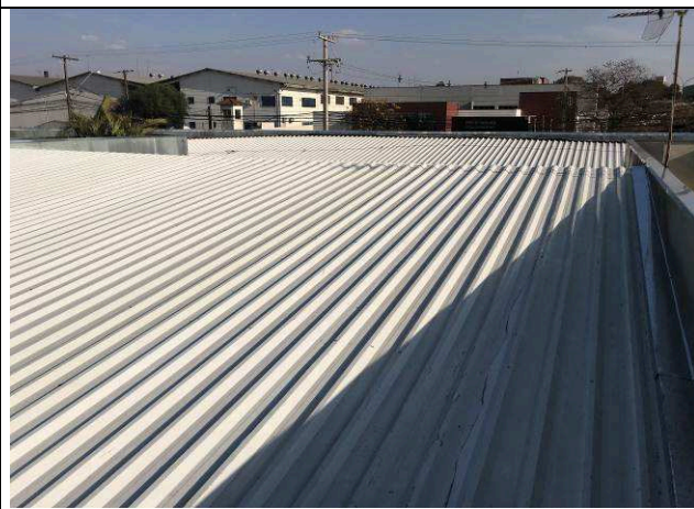
Figura 22C: Cobertura - Hall Público / PAB / OAB.
