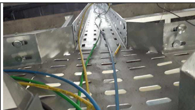
Figura 16E: infraestrutura e circuitos iluminação
