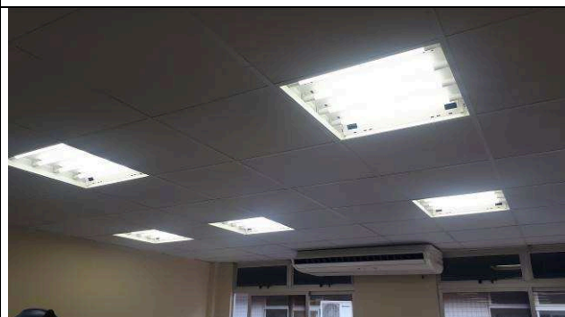
Figura 22E: luminárias 1ª VT - Lumicenter 4 lâmpadas com aletas
