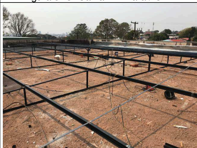
Figura 36C: Estrutura metálica de cobertura - 3ª Vara.
