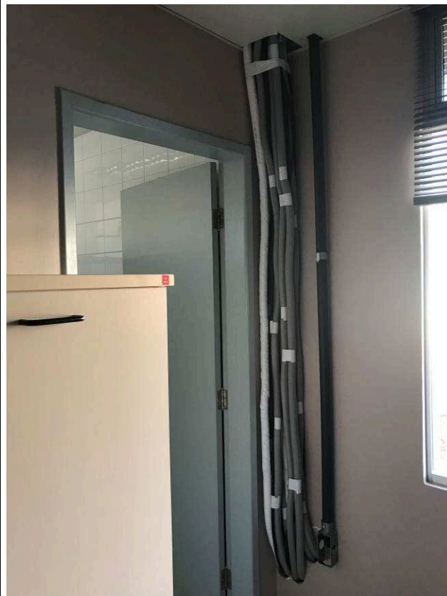
Figura 94C: Rede frigorígena nova - 2ª Vara.
