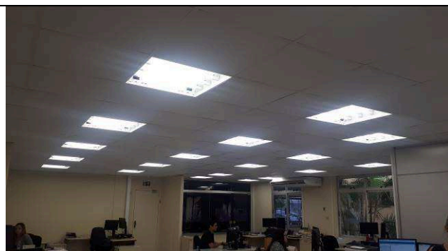
Figura 21E: luminárias 1ª VT - Lumicenter 4 lâmpadas com aletas
