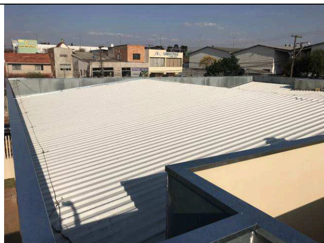
Figura 09C: Cobertura - 1ª Vara.
