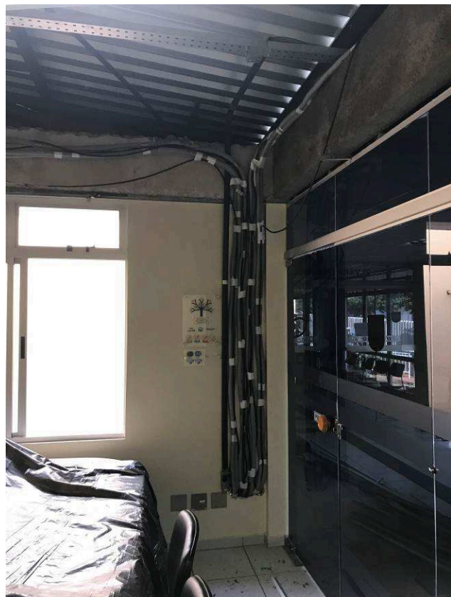
Figura 93C: Rede frigorígena nova - 2ª Vara.
