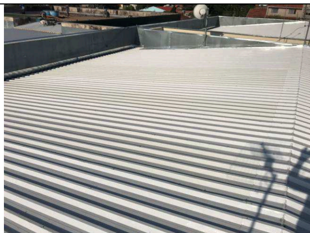
Figura 19C: Cobertura - Hall Público / PAB / OAB.
