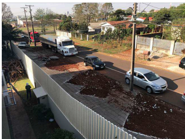
Figura 99C: Estacionamento - Rua Paricis.
