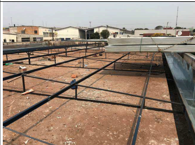
Figura 40C: Estrutura metálica de cobertura - 3ª Vara.
