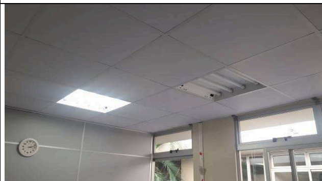
Figura 24E: luminárias 1ª VT - Lumicenter 4 lâmpadas com aletas
