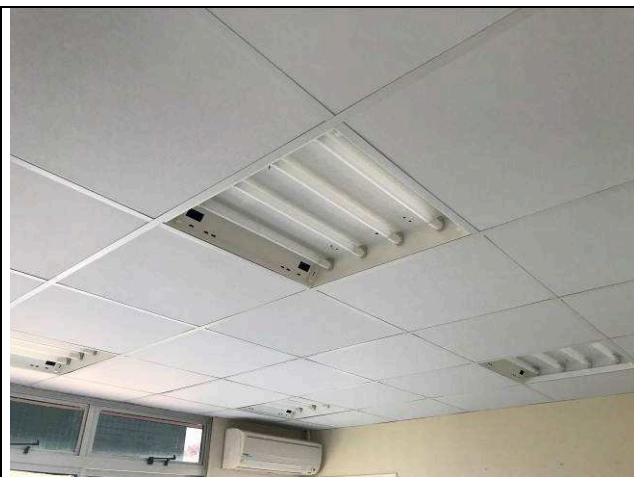
Figura 60C: Forro - 1ª Vara.
