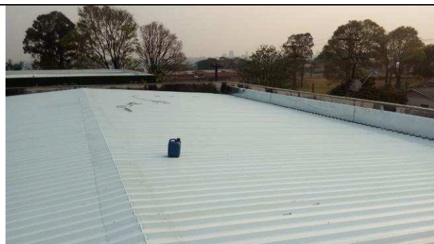
Figura 41C: Cobertura - 3ª Vara.
