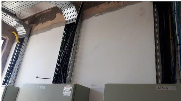
Figura 19E: Infraestrutura e cabeamento elétrico - QDEG, QDG, QDACG.
