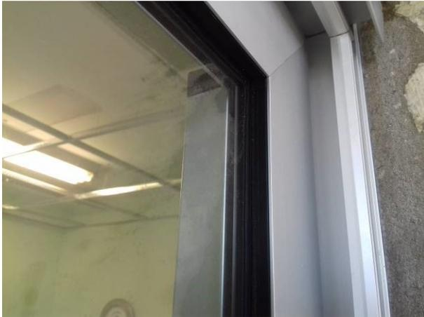
Figura 15C: Detalhe do sistema de isolamento acústico de uma das portas antirruído
