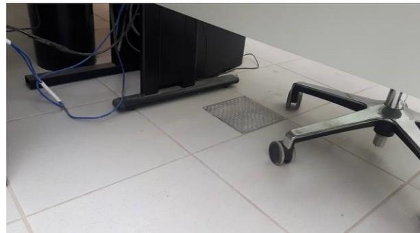
Figura 20E: Infraestrutura - caixa de piso sala de audiências, para instalação de totem.
