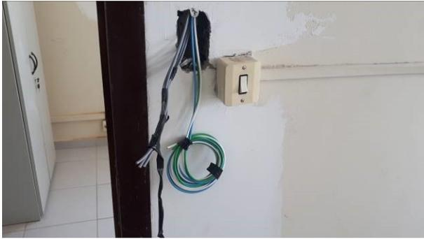
Figura 11E: Infraestrutura e cabeamento elétrico - rede comum, iluminação, estabilizada, ar condicionado.
