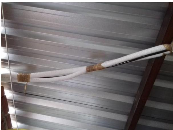
Figura 35C: Rede frigorígena e de retorno, instalada no arquivo
