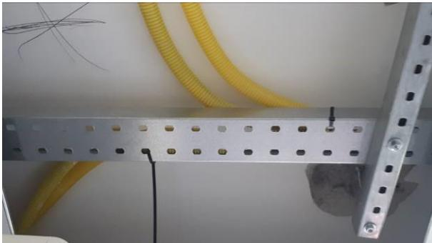
Figura 05E: Infra estrutura - eletrodutos corrugados, caixas.
