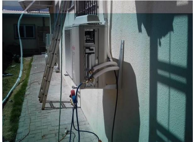
Figura 28C: Detalhe da tomada de pressão da linha, em processo de calibração da rede frigorígena
