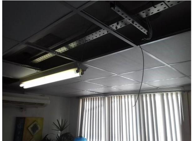
Figura 22C: Estrutura de sustentação do forro e algumas placas de forro, instalada na sala da OAB
