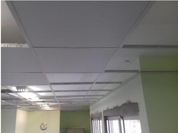
Figura 21C: Estrutura de sustentação do forro e algumas placas de forro, instalada na sala de audiência 1
