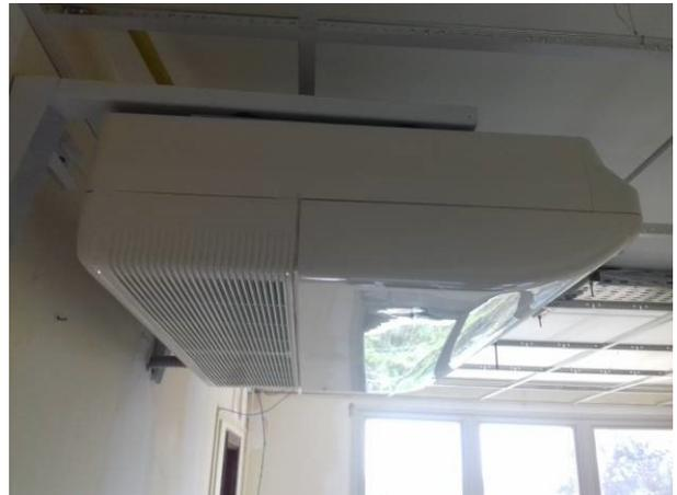
Figura 42C: Unidade evaporadora, instalada no gabinete do juiz 1
