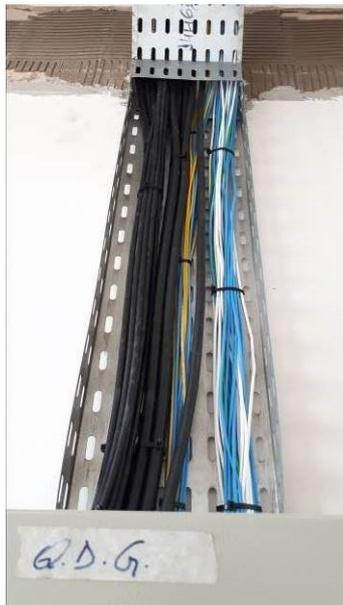
Figura 17E: Infraestrutura e cabeamento elétrico - rede comum, iluminação, ramais alimentadores.
