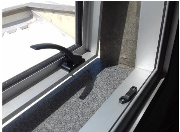
Figura 12C: Detalhe do sistema de fechamento da janela antirruído
