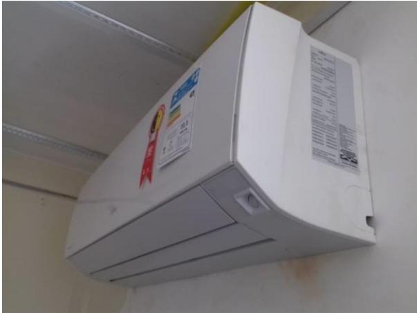
Figura 39C: Unidade evaporadora, instalada na sala dos assistentes
