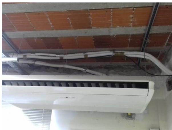
Figura 38C: Unidade evaporadora instalada no "gabinete do juiz 3"
