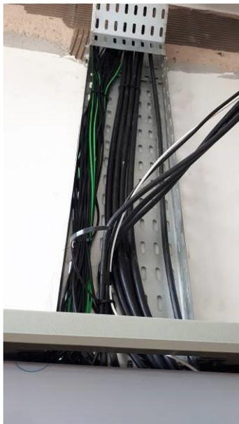
Figura 15E: Infraestrutura e cabeamento elétrico - condicionadores de ar, alimentador QDAR.
