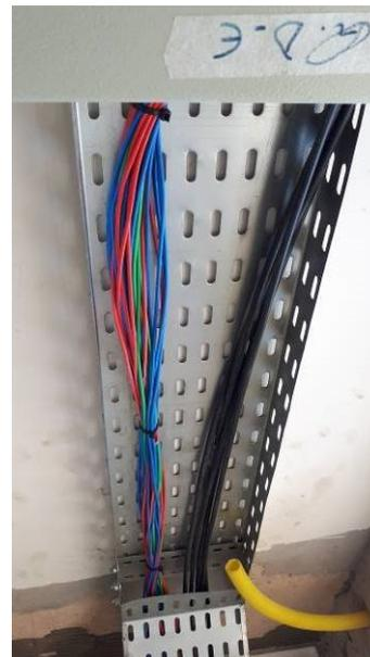
Figura 16E: Infraestrutura e cabeamento elétrico - rede estabilizada, alimentador QDE.
