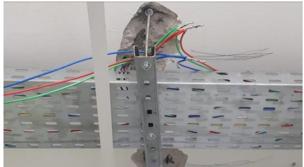
Figura 08E: Cabeamento elétrico - rede comum, iluminação, estabilizada, ar condicionado, emendas com estanho.
