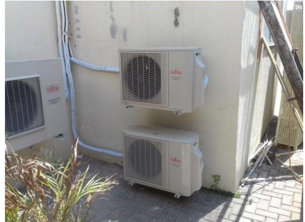
Figura 46C: Unidades condensadoras, instaladas na parede lateral direita
