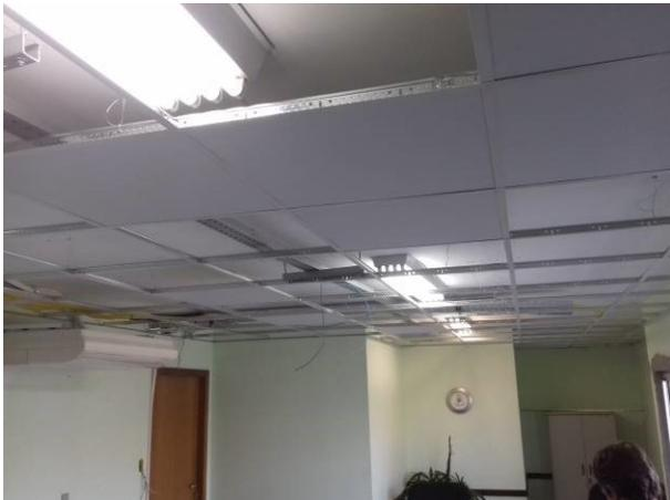
Figura 23C: Estrutura de sustentação do forro e algumas placas de forro, instalada na sala de audiência 1
