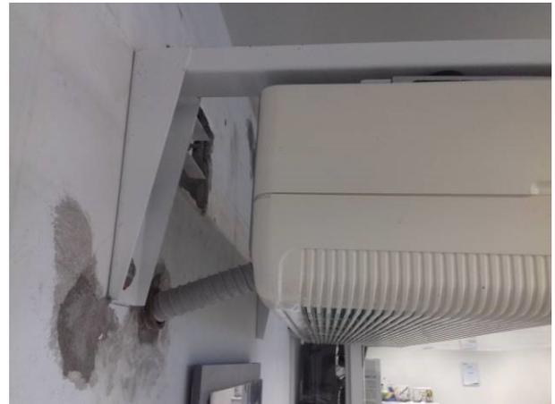
Figura 48C: Detalhe de suporte para sustentação de unidade evaporadora tipo piso/teto
