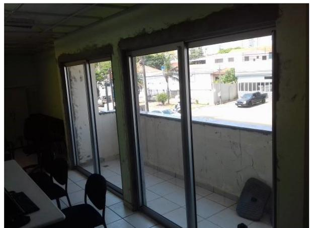
Figura 14C: Par de portas de vidro, tamanho 195x210cm, antirruído, instaladas na sala de audiência principal
