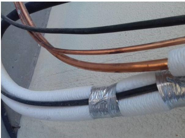
Figura 25C: Rede frigorígena e de retorno, no detalhe
