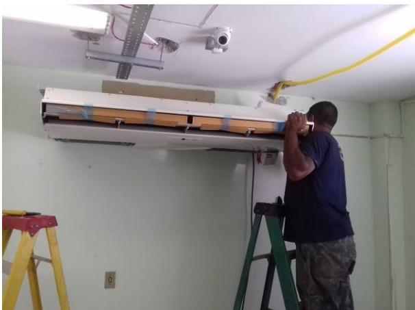
Figura 33C: Técnico realizando a instalação de unidade evaporadora, na sala de audiência 1
