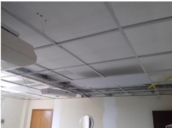
Figura 19C: Estrutura de sustentação do forro, instalada no gabinete do juiz 1
