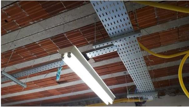
Figura 03E: Infra estrutura - eletrodutos corrugados, caixas.
