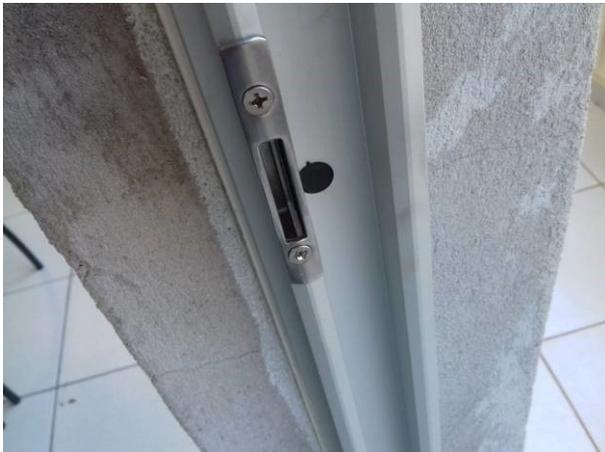
Figura 17C: Detalhe do sistema de fechamento de uma das portas antirruído
