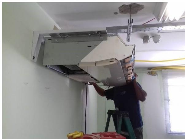
Figura 34C: Técnico realizando a instalação de unidade evaporadora, na sala de audiência 2
