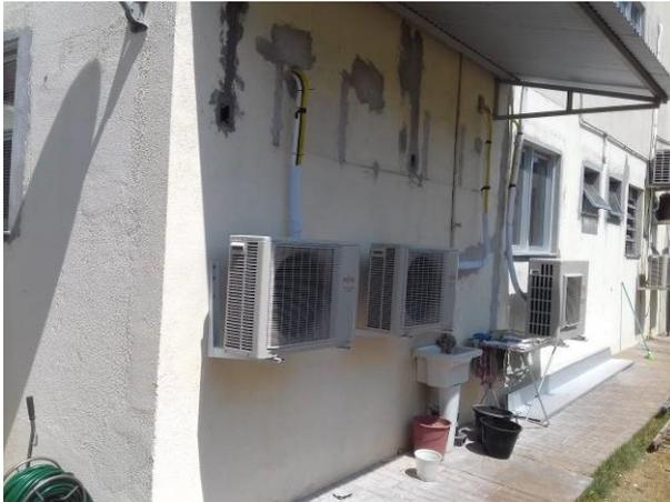
Figura 45C: Unidades condensadoras, instaladas na parede dos fundos
