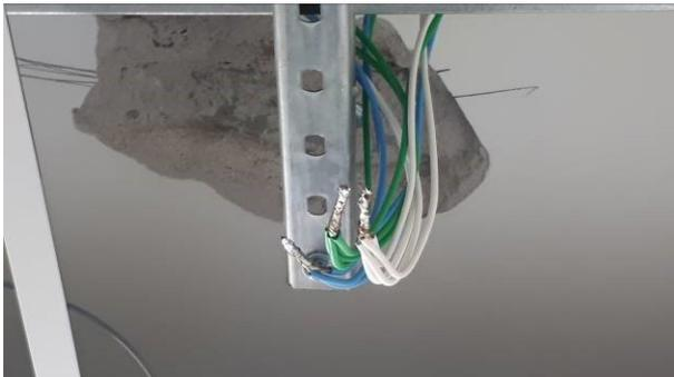
Figura 07E: Cabeamento elétrico - rede comum, iluminação, estabilizada, ar condicionado, emendas com estanho.
