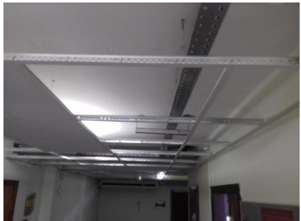
Figura 20C: Estrutura de sustentação do forro, instalada no hall público do segundo pavimento
