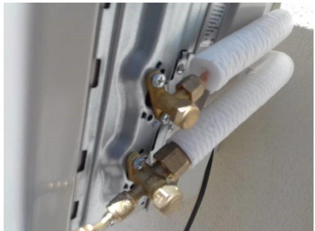
Figura 26C: Detalhe do acoplamento da rede frigorígena e de retorno em unidade condensadora
