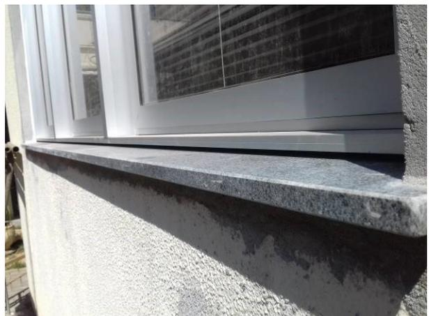
Figura 08C: Detalhe de peitoril em granito cinza andorinha
