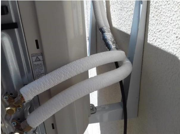
Figura 27C: Rede frigorígena e de retorno, conectadas em unidade condensadora e devidamente isoladas termicamente
