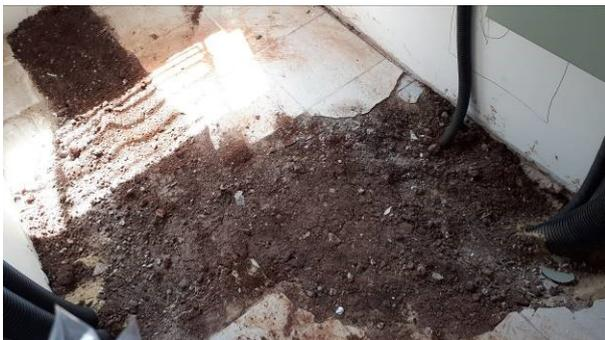
Figura 01E: Eletrodutos entre QDG, BEP, DG telefonia, e caixas externas.
