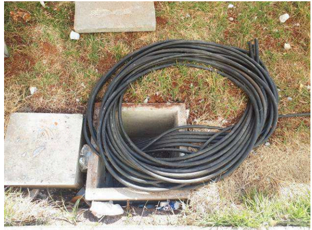
Figura 02E: Ramal alimentador 120/70mm²
