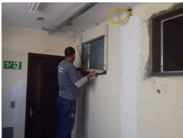
Figura 04C: Operário realizando o requadro e aplicação de peitoril em BWC público do pavimento superior
