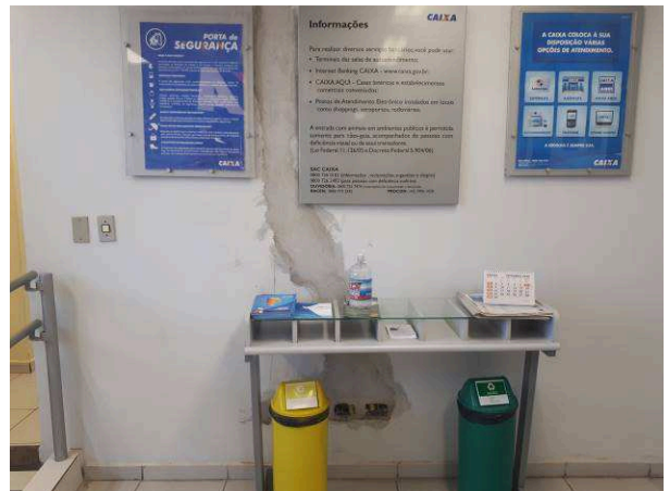
Figura 12E: Infraestrutura eletrodutos e caixas 2x4"
