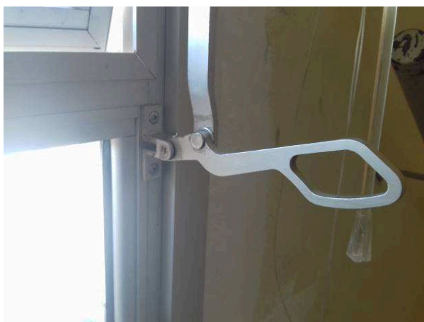
Figura 08C: Detalhe de puxador da janela basculante
