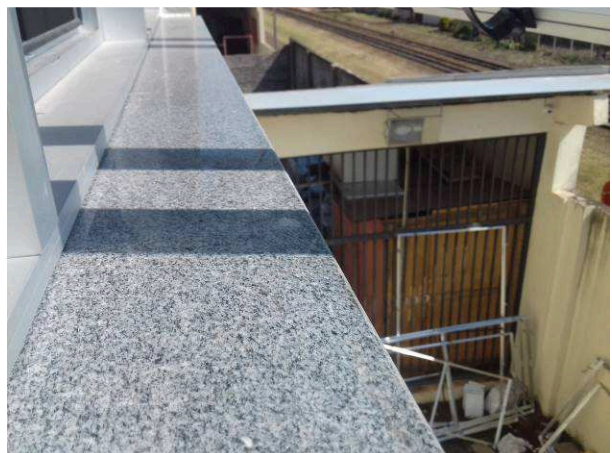
Figura 20C: Peitoril em granito, junto a janela do gabinete do juiz
