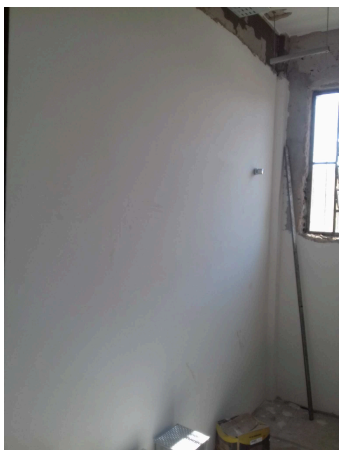
Figura 26C: Parede da sala técnica, já emboçada e emassada
