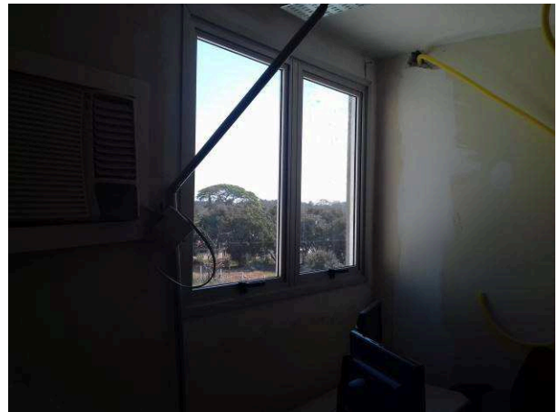
Figura 18C: Janela instalada na sala dos assistentes
