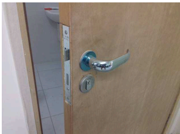
Figura 24C: Fechadura e maçaneta, na porta do banheiro PNE do segundo pavimento
