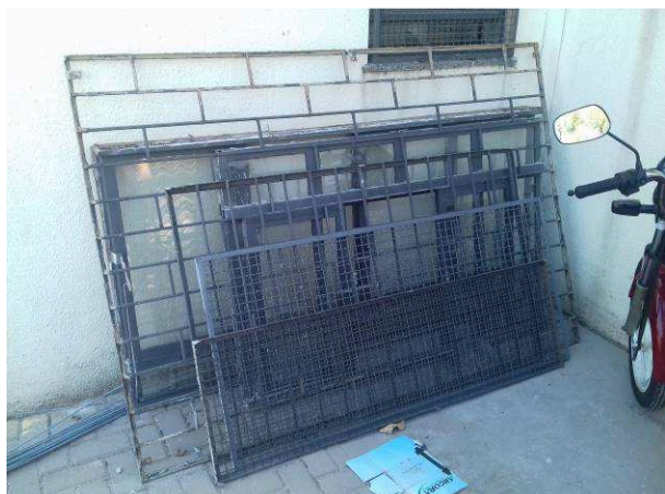
Figura 03C: Esquadrias de ferro, removidas do pavimento superior
