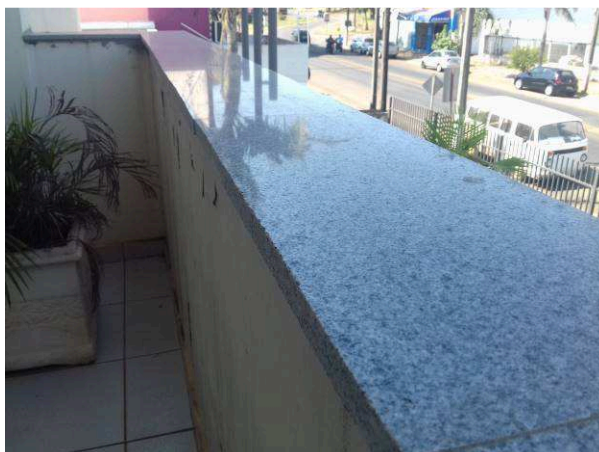
Figura 22C: Peitoril instalado no parapeito da sacada (sala de audiência 1)
