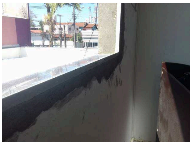
Figura 05C: Vão de janela com peitoril e requadro executados, na sala da OAB
