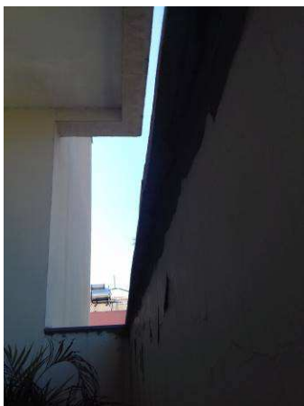
Figura 22C: Peitoril instalado no parapeito da sacada (sala de audiência 1), visto por baixo para conferir pingadeira
