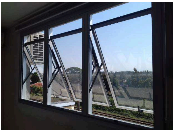
Figura 19C: Janela maxim-ar instalada no gabinete do juiz
