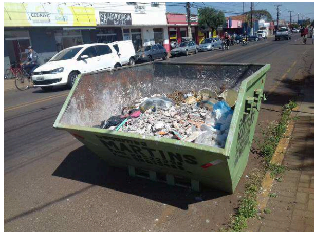
Figura 02C: Caçamba para remoção de entulho
