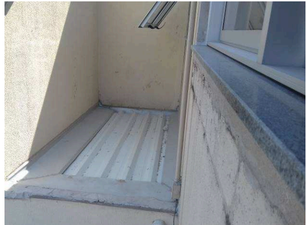
Figura 16C: Peitoril em granito cinza andorinha - janela maxim-ar do corredor de acesso à sala de audiência 1
