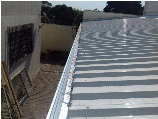
Figura 36C: Cobertura e calha do arquivo
