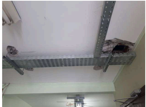
Figura 04E: Infraestrutura eletrocalhas
