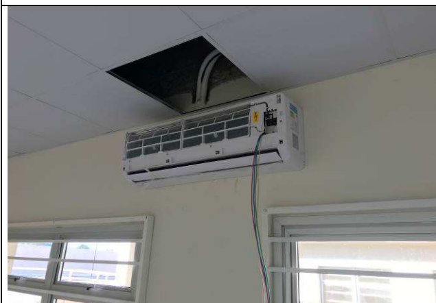
Figura 47C: Evaporadora 30.000 BTUs - Sala de audiências 2 da 2ª VT.
