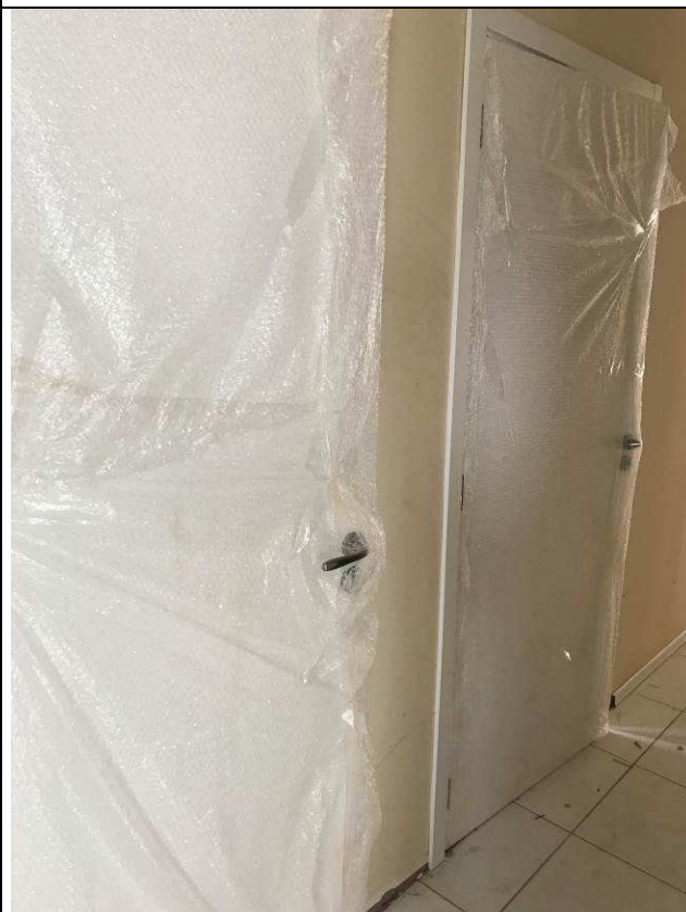
Figura 16: Portas de madeira - banheiros da área de terceirizados.
