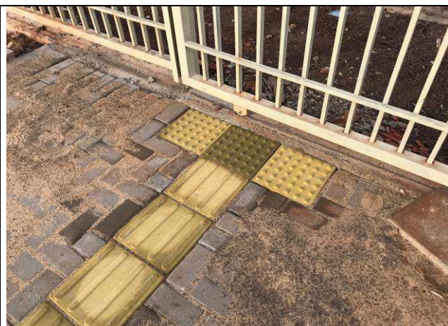
Figura 72C: Pavimentação intertravada - piso podotátil.
