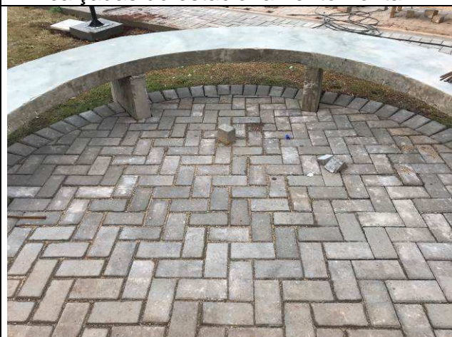
Figura 70C: Pavimentação intertravada - calçadas do estacionamento frontal.
