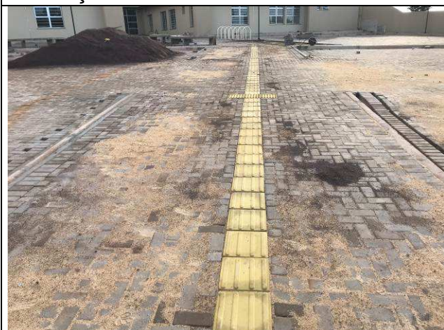
Figura 73C: Pavimentação intertravada - piso podotátil.
