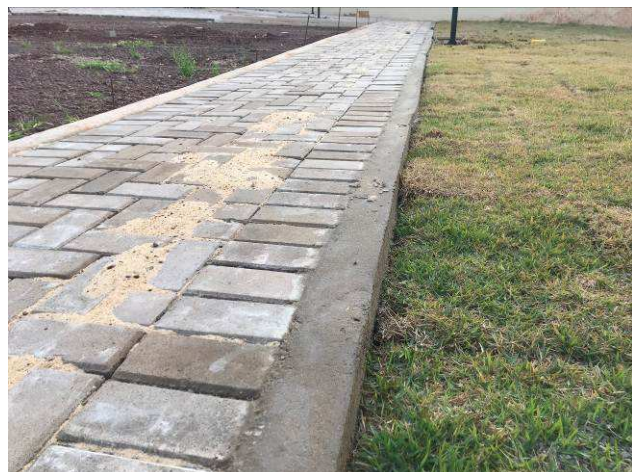
Figura 63C: Pavimentação intertravada - calçadas do estacionamento frontal.
