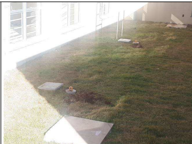
Figura 08E: caixas externas 30x30
