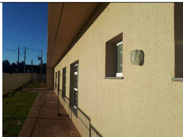
Figura 43E: arandelas tipo tartaruga fachada edificação
