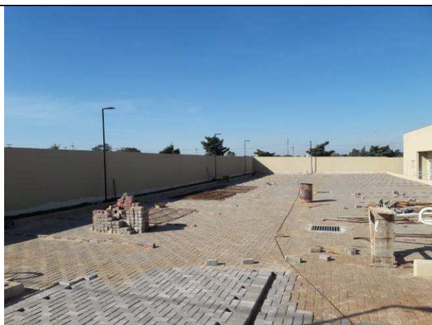
Figura 50E: postes de iluminação externa - estacionamento
