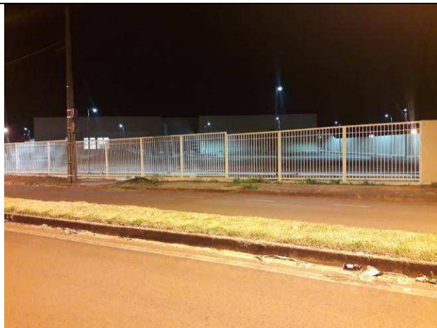
Figura 52E: postes de iluminação externa - estacionamento
