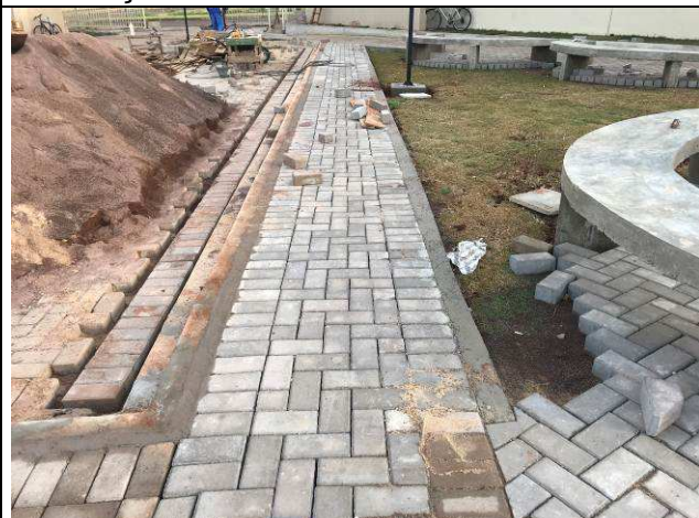
Figura 68C: Pavimentação intertravada - calçadas do estacionamento frontal.
