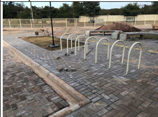
Figura 67C: Pavimentação intertravada - calçadas do estacionamento frontal.
