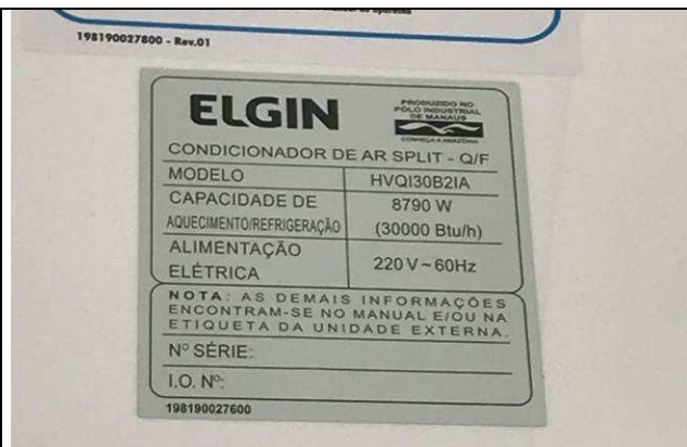
Figura 46C: Evaporadora 30.000 BTUs - Sala de audiências 1 da 2ª VT.
