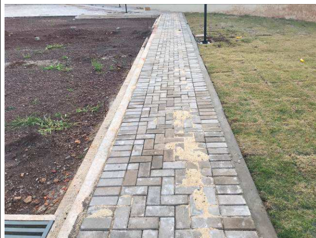
Figura 62C: Pavimentação intertravada - calçadas do estacionamento frontal.
