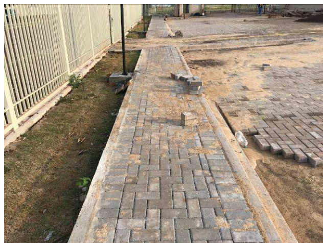
Figura 61C: Pavimentação intertravada - calçadas do estacionamento frontal.
