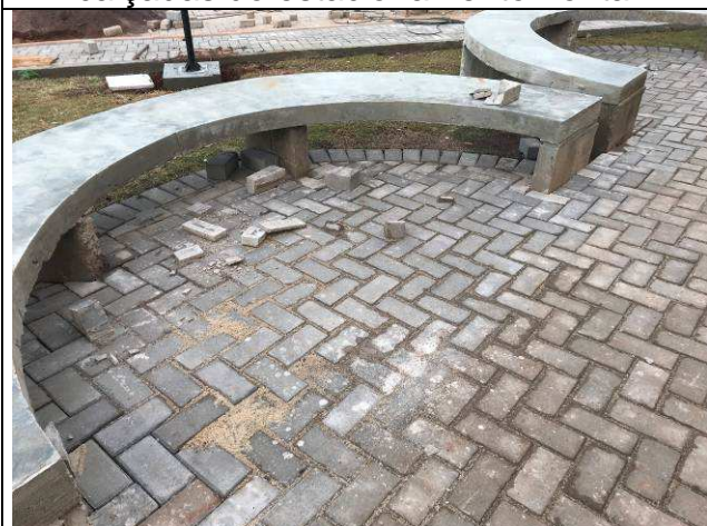
Figura 69C: Pavimentação intertravada - calçadas do estacionamento frontal.
