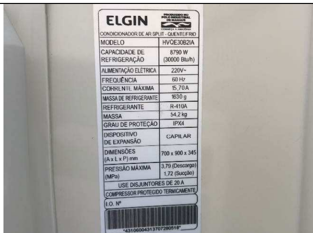
Figura 58C: Condensadora 30.000 BTUs - Salas de audiências da 2ª VT.
