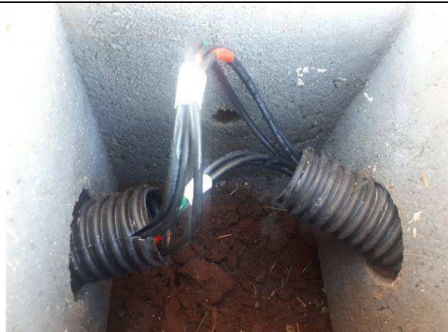
Figura 15E: circuitos externos iluminação e portão
