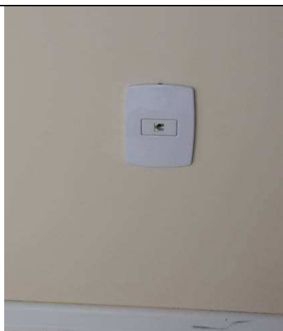
Figura 61E: conectores RJ11 OAB
