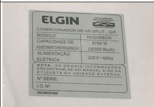
Figura 48C: Evaporadora 30.000 BTUs - Sala de audiências 2 da 2ª VT.
