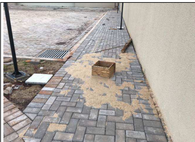
Figura 65C: Pavimentação intertravada - calçadas do estacionamento frontal.
