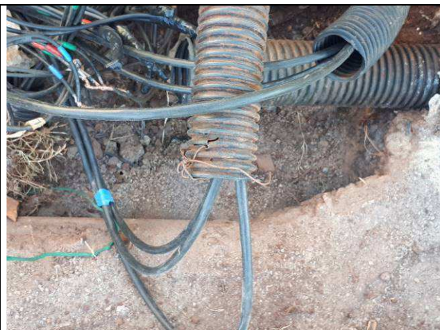
Figura 56E: cabo UTP área externa
