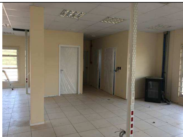
Figura 27C: Portas de madeira - Distribuição / sala de oficiais.
