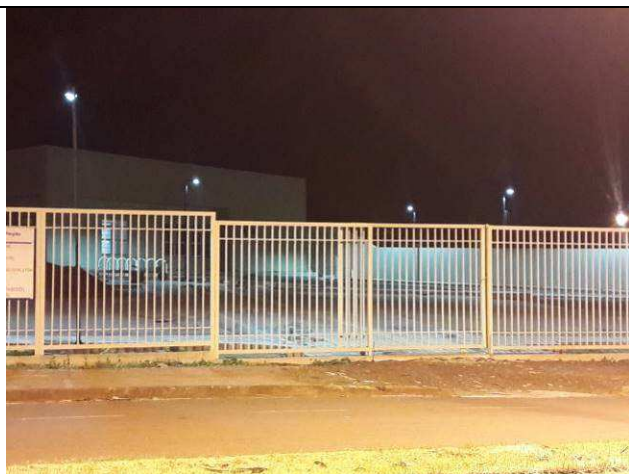
Figura 54E: postes de iluminação externa - estacionamento
