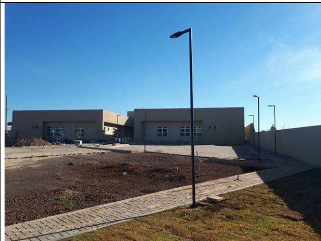
Figura 48E: postes de iluminação externa - estacionamento
