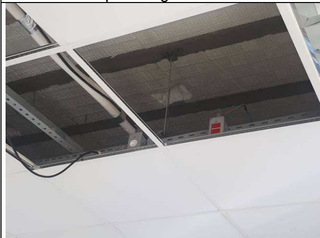
Figura 27E: tomadas elétricas condutores padrão genérico
