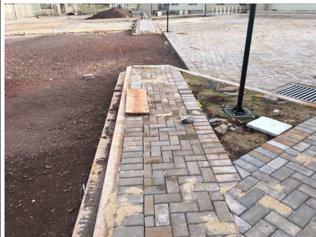
Figura 64C: Pavimentação intertravada - calçadas do estacionamento frontal.
