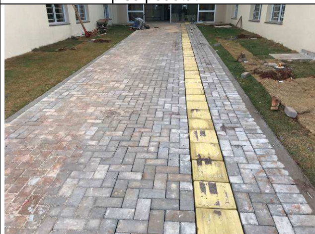
Figura 74C: Pavimentação intertravada - piso podotátil.
