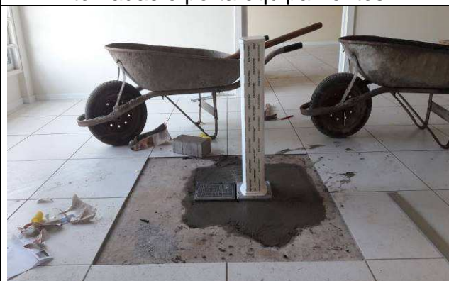
Figura 36E: totens Dutotec salas de audiências e caixas de piso
