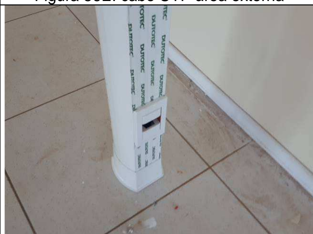
Figura 58E: porta equipamentos Dutotec
