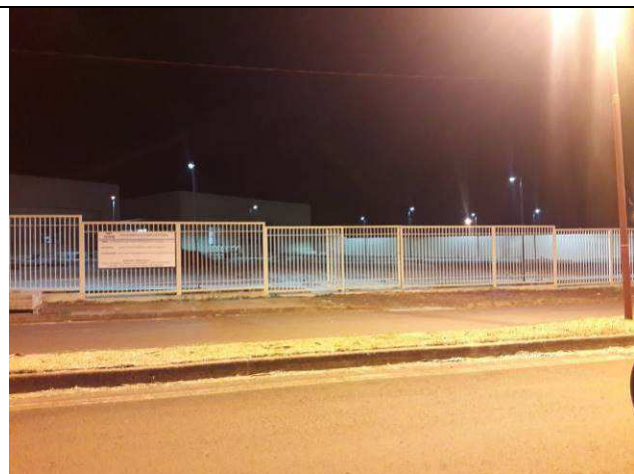
Figura 53E: postes de iluminação externa - estacionamento
