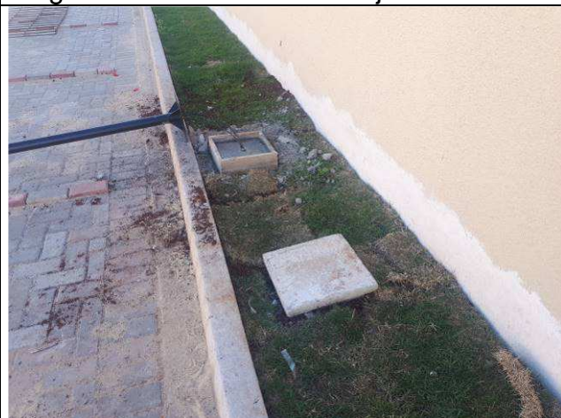
Figura 06E: caixas externas 30x30
