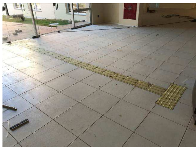
Figura 31C: Piso podotátil interno.
