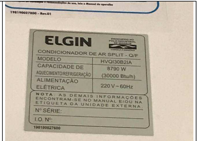
Figura 50C: Evaporadora 30.000 BTUs - área do PAB I.
