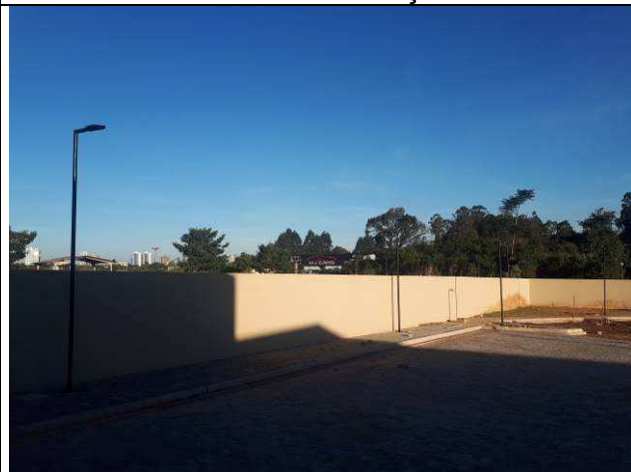
Figura 46E: postes de iluminação externa - estacionamento
