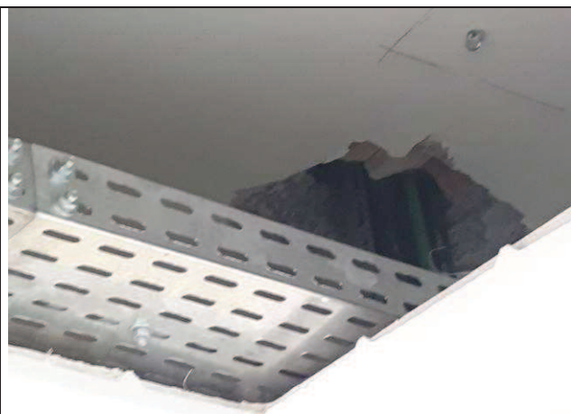
Figura 05E: Infraestrutura - eletrocalhas para ramais alimentadores QDE, QDAR1, QDAR2
