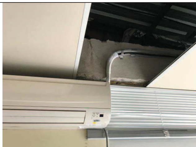
Figura 78C: Rede frigorígena nova - 2ª Vara.
