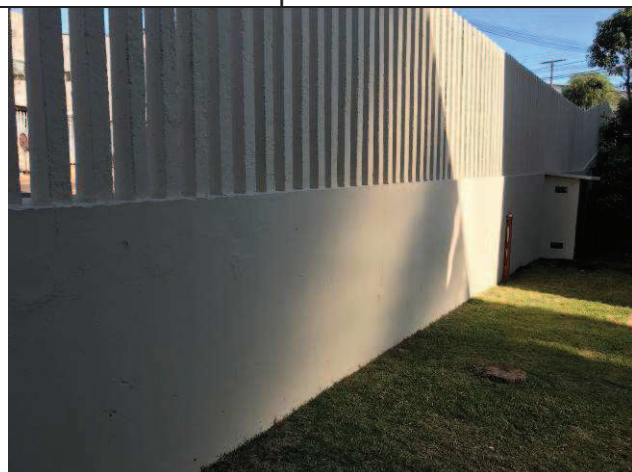
Figura 69C: Pintura do muro de arrimo / palito.
