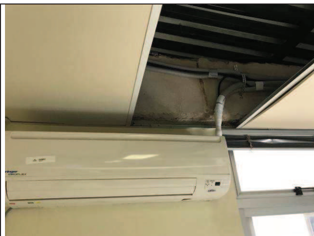
Figura 79C: Rede frigorígena nova - 2ª Vara.
