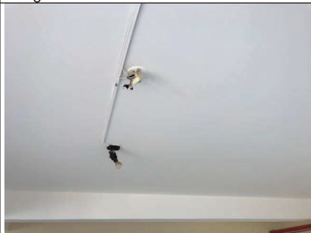
Figura 52C: Pintura do teto da garagem do subsolo - Fórum.
