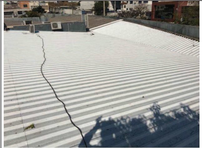
Figura 16C: Cobertura - 2ª Vara.
