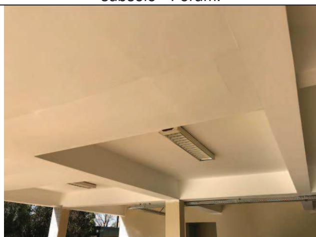
Figura 59C: Pintura do teto da garagem do subsolo - Fórum.
