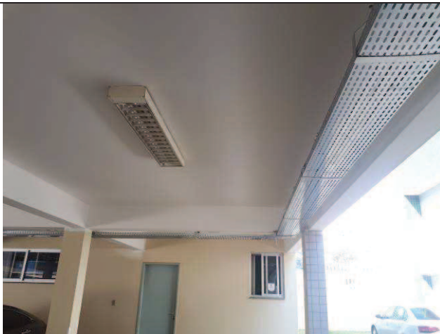
Figura 03E: Infraestrutura - eletrocalhas para ramais alimentadores QDE, QDAR1, QDAR2
