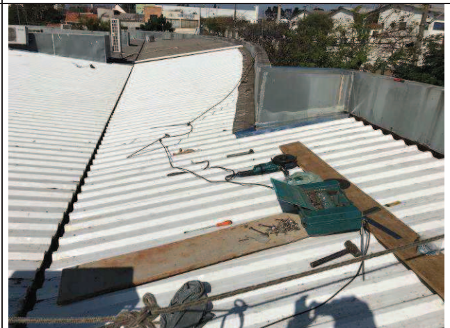
Figura 18C: Cobertura - 2ª Vara.
