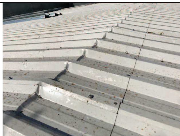
Figura 14C: Cobertura - 2ª Vara.
