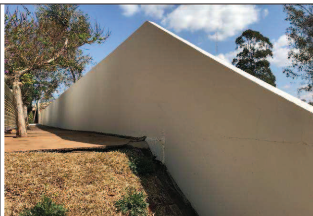
Figura 74C: Pintura do muro de alvenaria.
