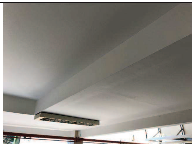
Figura 54C: Pintura do teto da garagem do subsolo - Fórum.
