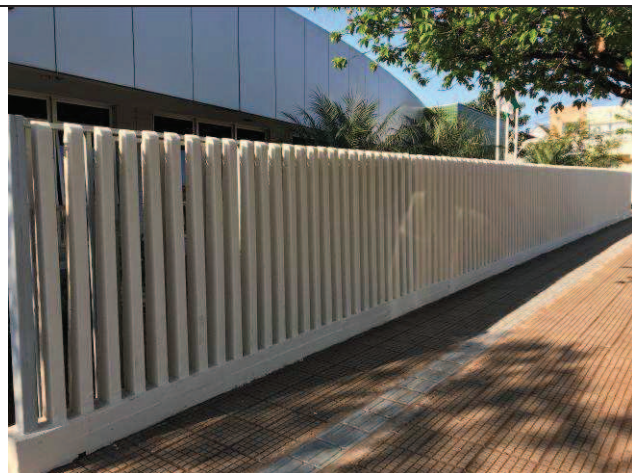
Figura 61C: Pintura do muro palito.
