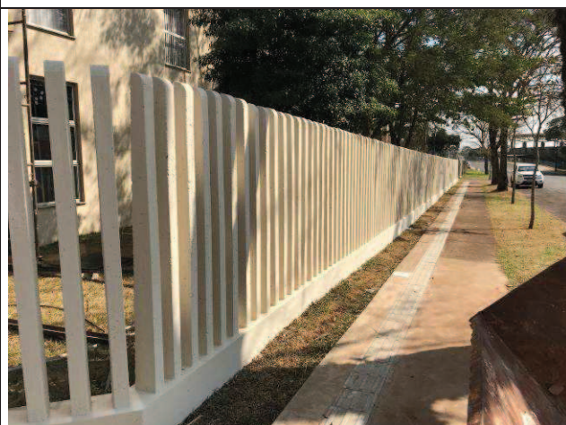
Figura 64C: Pintura do muro palito.
