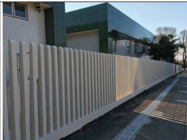
Figura 62C: Pintura do muro palito.
