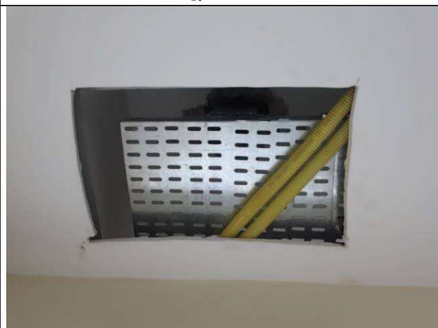
Figura 07E: Infraestrutura - eletrocalhas para ramais alimentadores QDE, QDAR1, QDAR2
