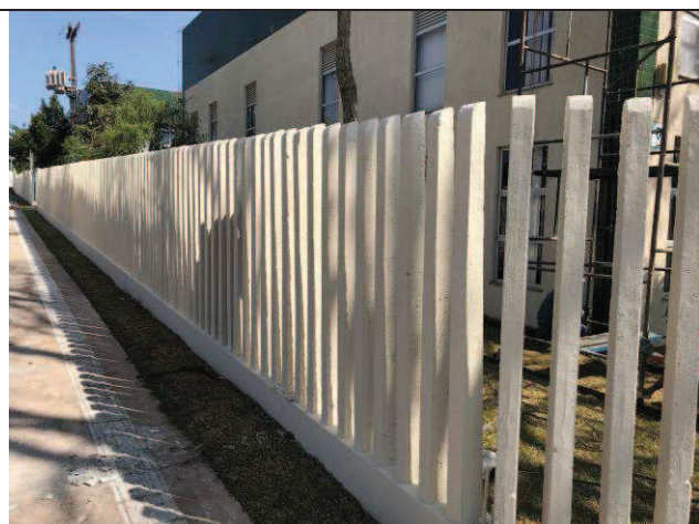
Figura 63C: Pintura do muro palito.
