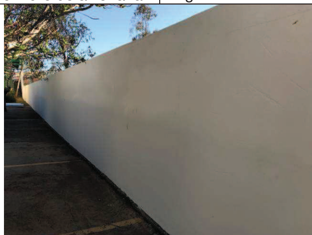
Figura 75C: Pintura do muro de alvenaria.
