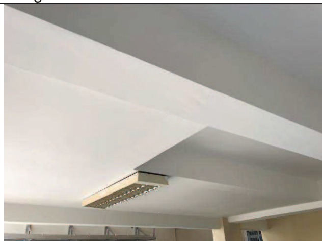
Figura 51C: Pintura do teto da garagem do subsolo - Fórum.
