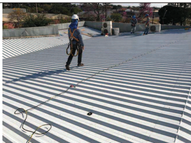
Figura 13C: Cobertura - 2ª Vara.
