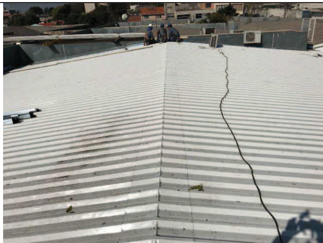
Figura 17C: Cobertura - 2ª Vara.
