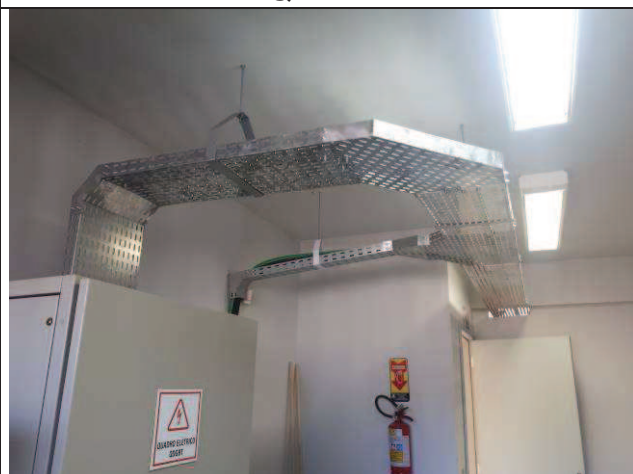
Figura 08E: Infraestrutura - eletrocalhas para ramais alimentadores QDE, QDAR1, QDAR2
