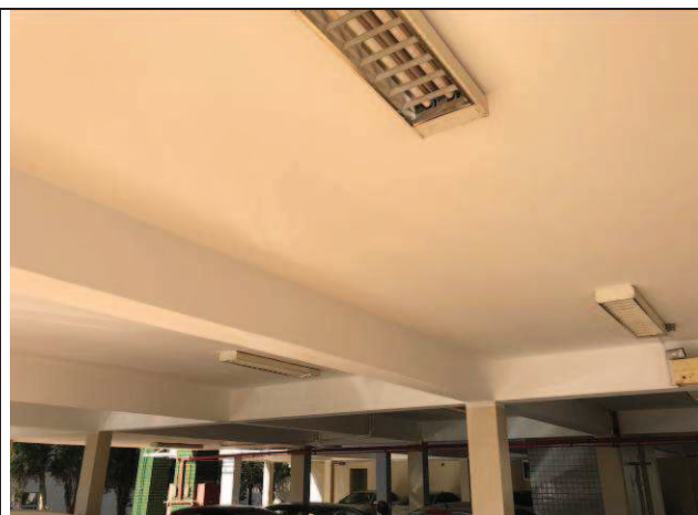
Figura 56C: Pintura do teto da garagem do subsolo - Fórum.
