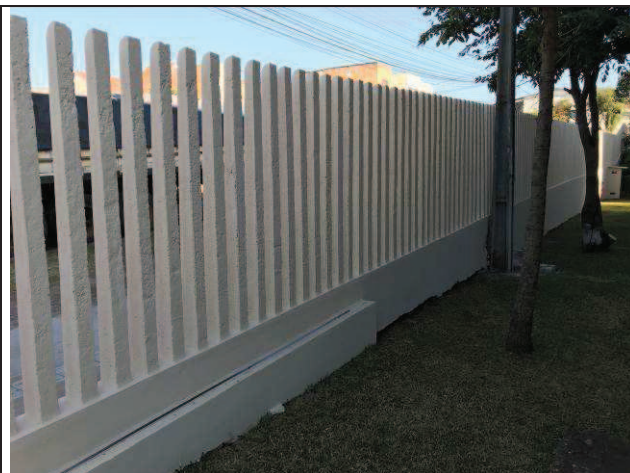
Figura 68C: Pintura do muro de arrimo / palito.
