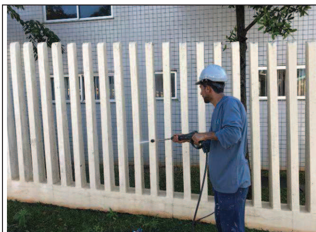
Figura 41C: Lavagem do muro palito.
