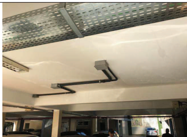
Figura 55C: Pintura do teto da garagem do subsolo - Fórum.
