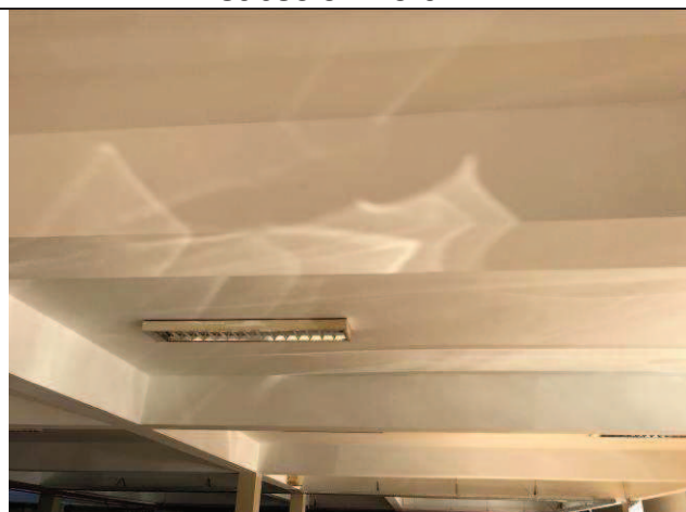
Figura 57C: Pintura do teto da garagem do subsolo - Fórum.
