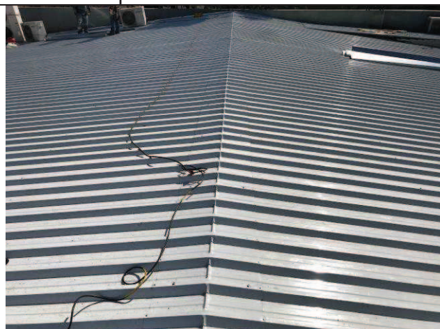
Figura 11C: Cobertura - 2ª Vara.
