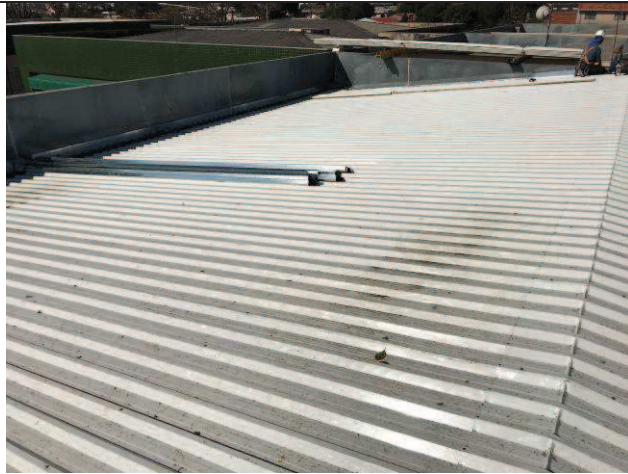
Figura 15C: Cobertura - 2ª Vara.
