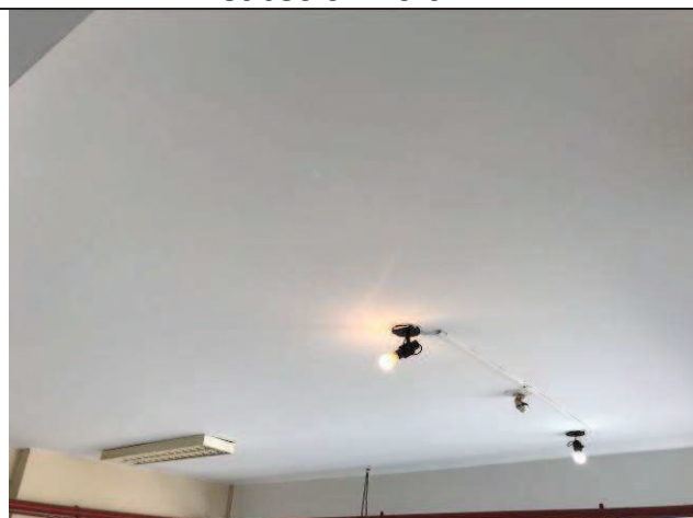
Figura 53C: Pintura do teto da garagem do subsolo - Fórum.
