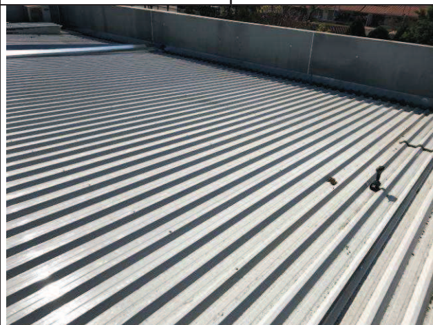
Figura 12C: Cobertura - 2ª Vara.
