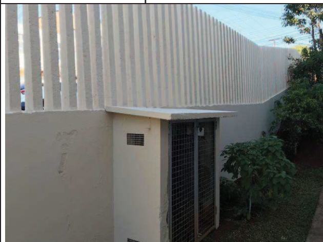
Figura 70C: Pintura do muro de arrimo / palito.
