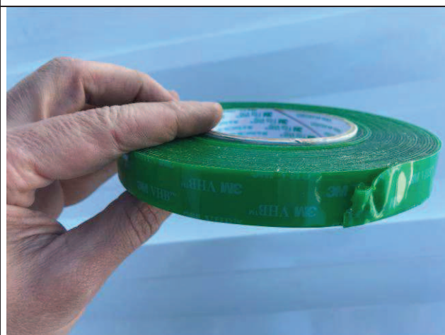
Figura 24C: Cobertura - instalação das fitas dupla-face nas emendas - Setorial.
