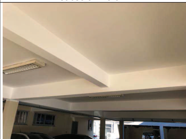
Figura 58C: Pintura do teto da garagem do subsolo - Fórum.
