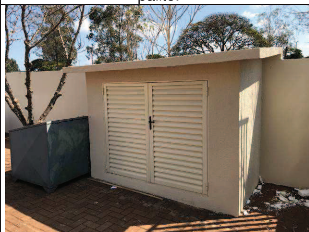
Figura 72C: Pintura do muro de alvenaria.
