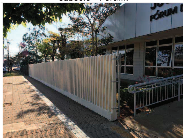
Figura 60C: Pintura do muro palito.
