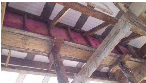
Figura 05C: Fôrma e escoramento de viga e laje
