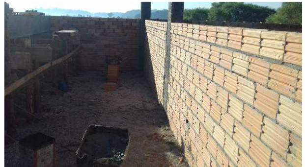
Figura 24C: Alvenaria da platibanda – junto ao reservatório
