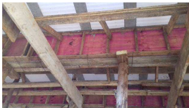
Figura 06C: Fôrma e escoramento de viga e laje
