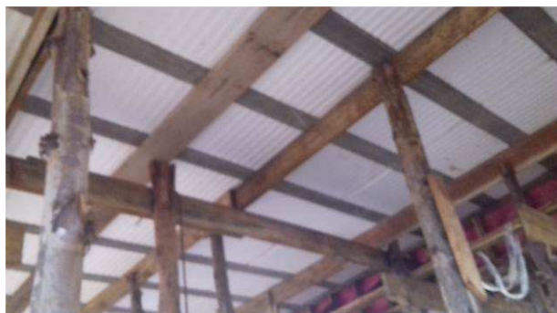
Figura 11C: Detalhe de vigotas, EPS e escoramento da laje
