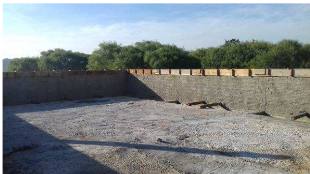
Figura 25C: Chapisco interno de platibanda – frontal e lateral direita
