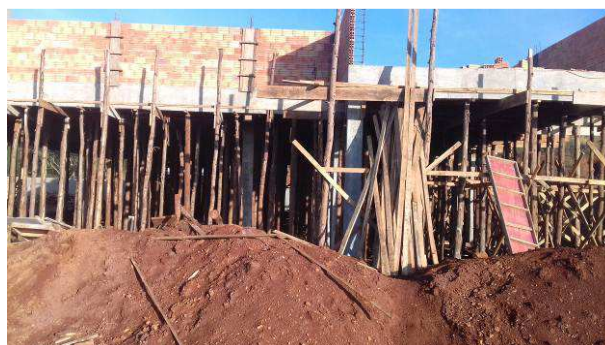
Figura 10C: Vigas de cobertura e pilaretes da platibanda
