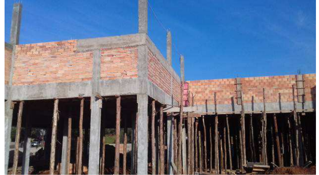
Figura 22C: Alvenaria da platibanda – lateral direita
