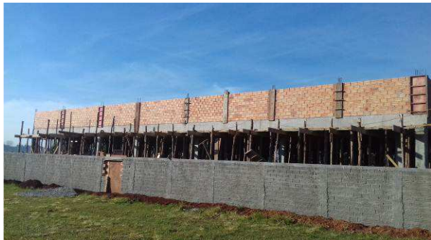
Figura 23C: Alvenaria da platibanda – fundos
