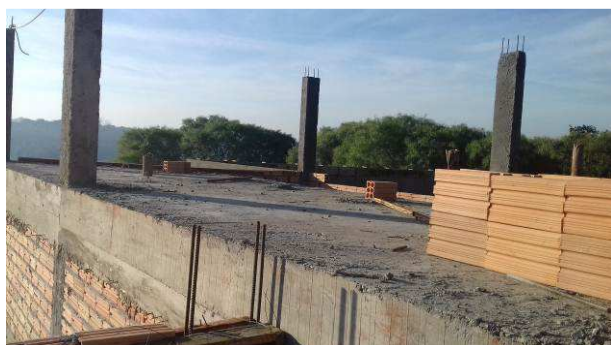
Figura 09C: Vigas e laje da cobertura, além de pilaretes do barrilete
