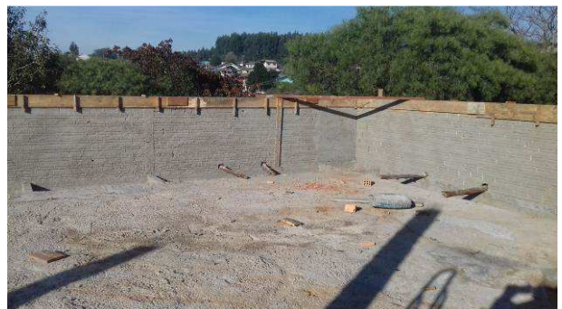
Figura 26C: Chapisco interno de platibanda – fundos e lateral esquerda
