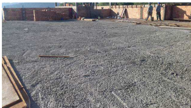
Figura 13C: Laje de cobertura, após concretagem
