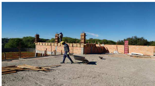
Figura 17C: Operários concretando pilar do barrilete
