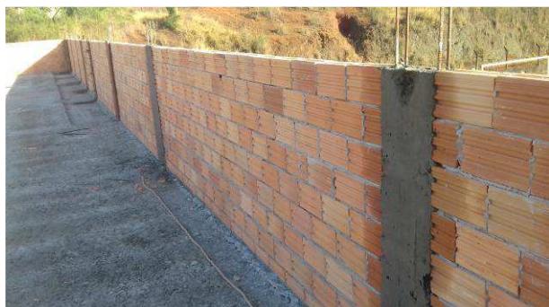
Figura 19C: Pilaretes de travamento da platibanda
