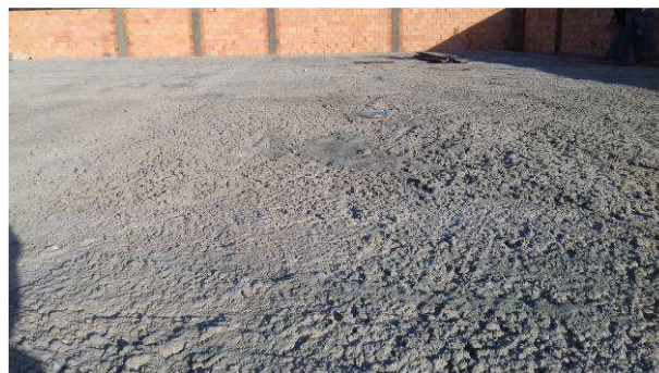
Figura 12C: Laje de cobertura, após concretagem
