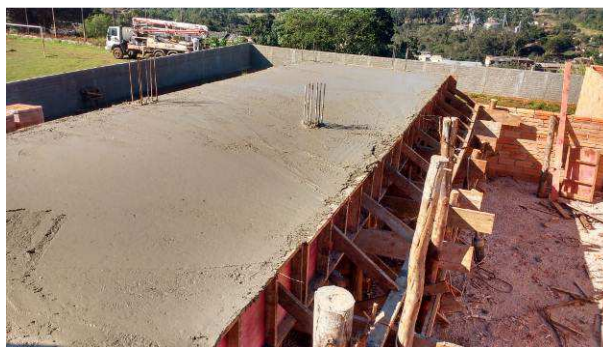
Figura 14C: Laje e vigas de cobertura, após concretagem - fundos
