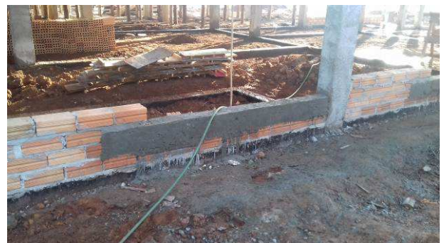
Figura 04C: Detalhe de contraverga em janela da sala da OAB
