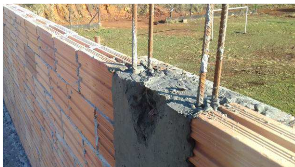
Figura 20C: Detalhe de um pilarete de travamento da platibanda
