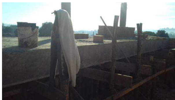
Figura 08C: Vigas e laje do barrilete, após concretagem
