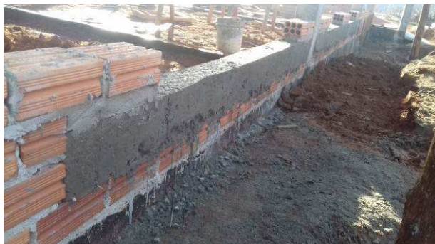
Figura 01C: Detalhe de contraverga em janela da sala de perícias
