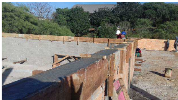
Figura 18C: Concretagem de viga de coroamento da platibanda
