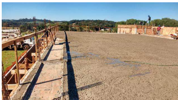
Figura 15C: Laje de cobertura, após concretagem - fundos
