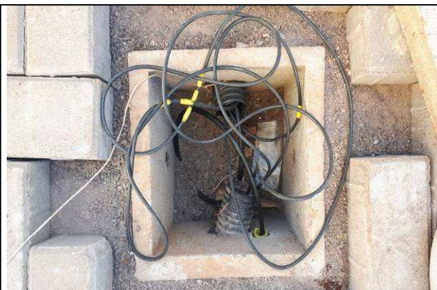
Figura 08E: cabeamento 1kV circuitos externos iluminação, CFTV, portão
