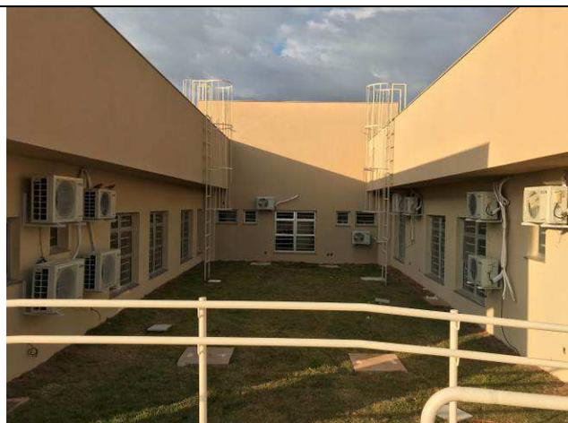
Figura 86C: Condensadoras - salas múltiplo uso / vivência / técnica e 2ª VT.
