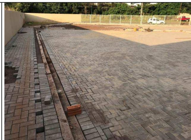
Figura 93C: Pavimentação intertravada - Estacionamento frontal.
