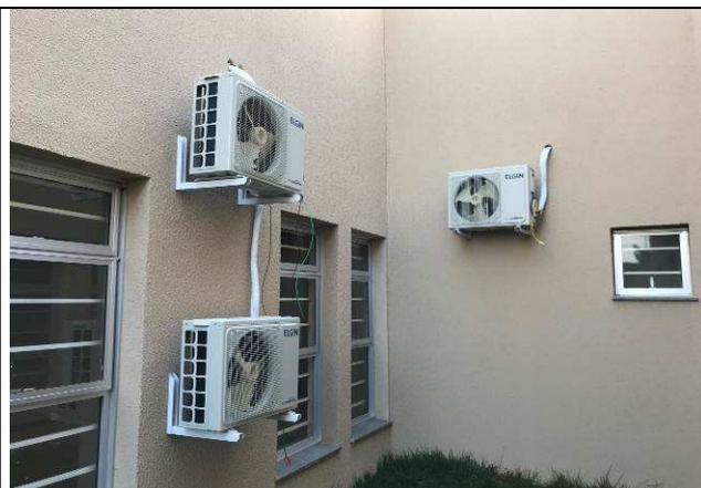
Figura 81C: Condensadoras 12.000 BTUs - 1ª VT e sala técnica de informática.
