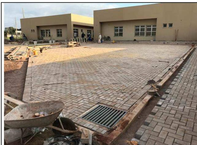
Figura 92C: Pavimentação intertravada - Estacionamento frontal.
