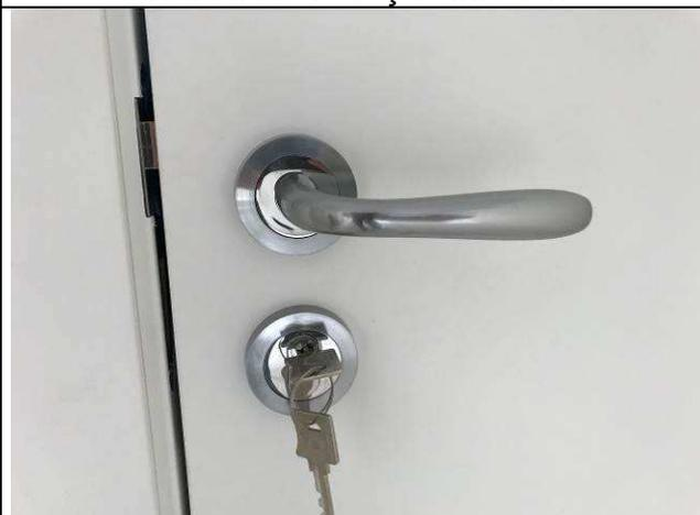
Figura 37C: Portas de madeira - Fechadura interna 55mm.
