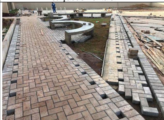
Figura 105C: Pavimentação intertravada - calçadas frontais.
