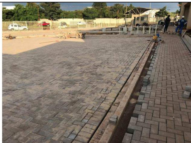
Figura 94C: Pavimentação intertravada - Estacionamento frontal.
