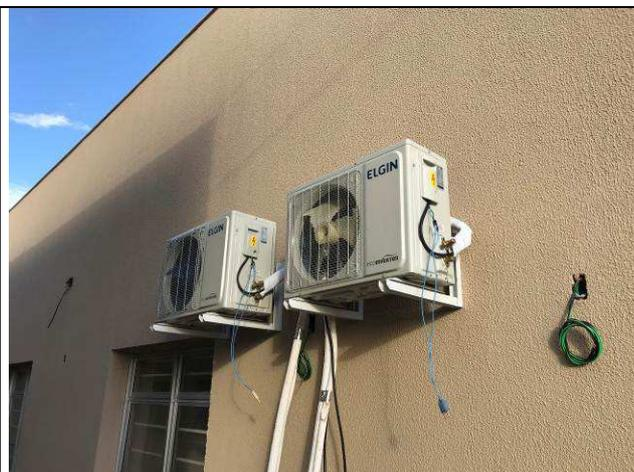
Figura 87C: Condensadoras 12.000 e 18.000 BTUs - OAB e sala de perícias.
