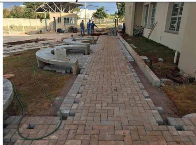
Figura 103C: Pavimentação intertravada - calçadas frontais.
