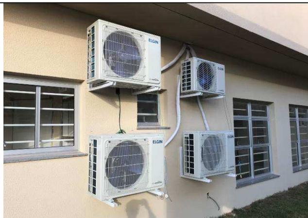
Figura 82C: Condensadoras 18.000 e 30.000 BTUs - Sala de espera, sala múltiplo uso e área de vivência.
