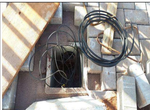
Figura 24E: cabeamento UTP cat6 especial para uso externo - CFTV
