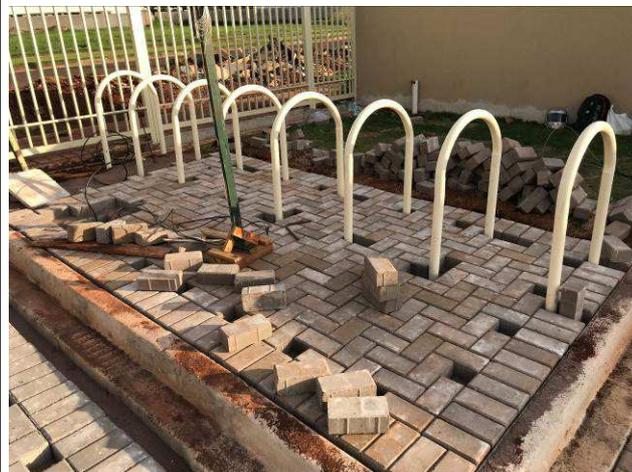
Figura 107C: Pavimentação intertravada - calçadas dos fundos.
