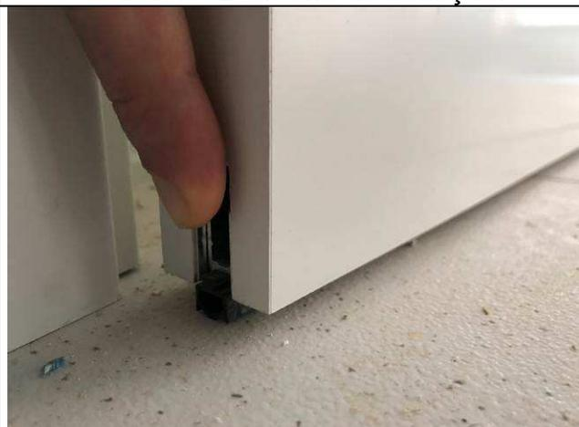
Figura 36C: Porta acústica - borracha retrátil de vedação inferior acionada.
