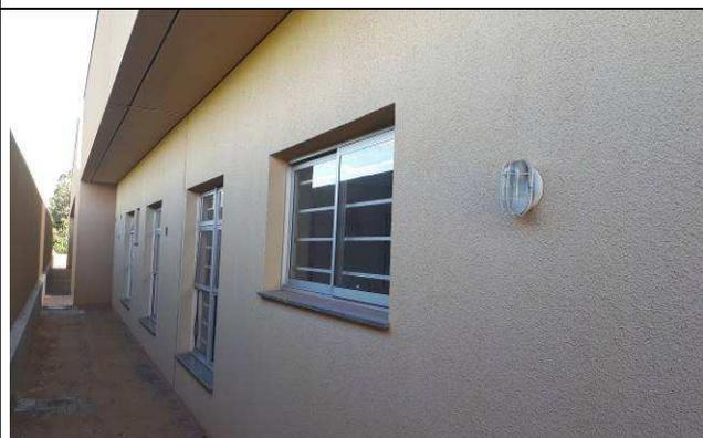
Figura 22E: luminárias externas tipo tartaruga
