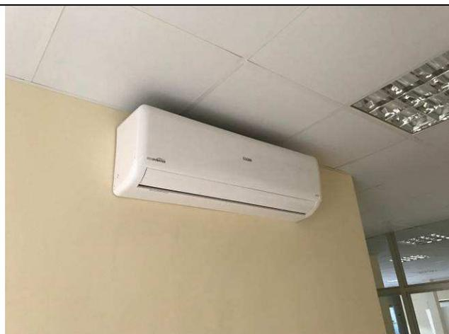
Figura 62C: Evaporadora 30.000 BTUs - Sala de espera da 1ª VT.
