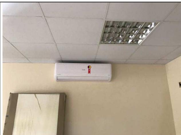
Figura 69C: Evaporadora 30.000 BTUs - Sala de espera da 2ª VT.
