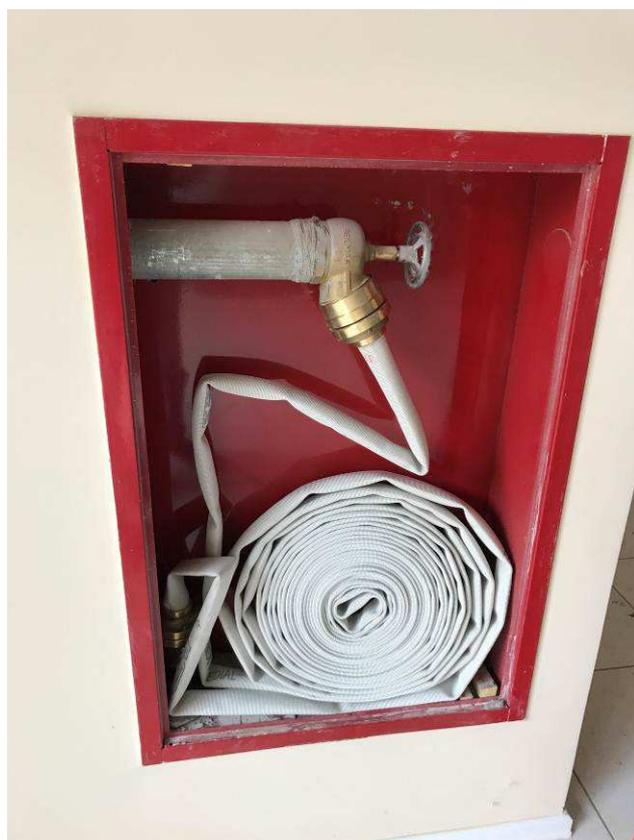
Figura 88C: Abrigo de incêndio - Hall Central.
