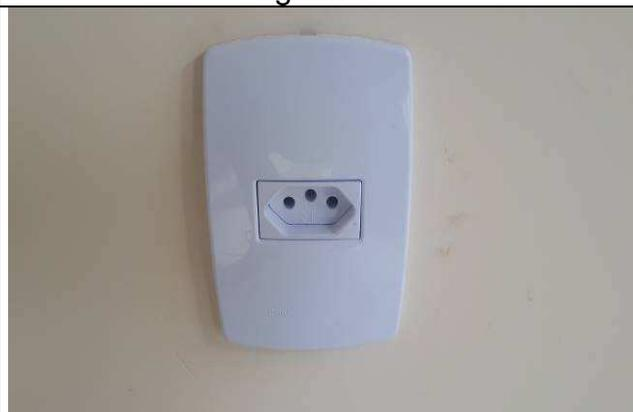
Figura 17E: interruptores, tomadas elétricas padrão modular
