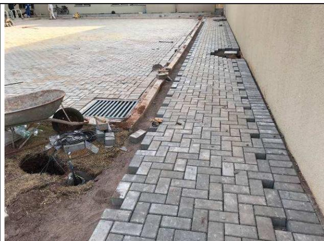
Figura 101C: Pavimentação intertravada - calçadas frontais.
