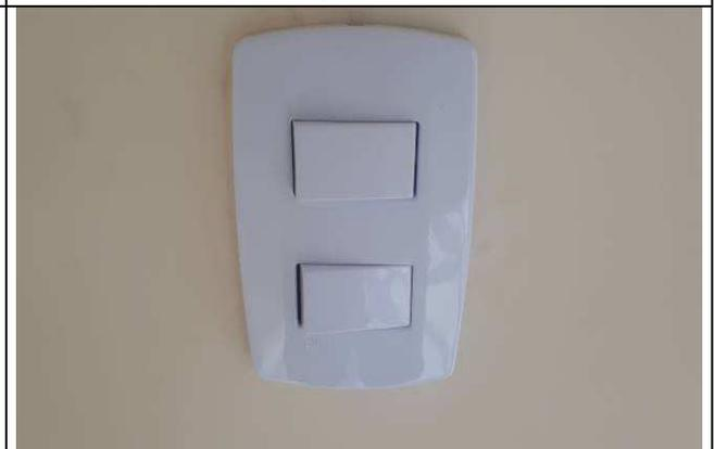
Figura 16E: interruptores, tomadas elétricas padrão modular
