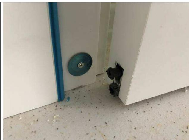
Figura 35C: Porta acústica - borracha retrátil de vedação inferior.
