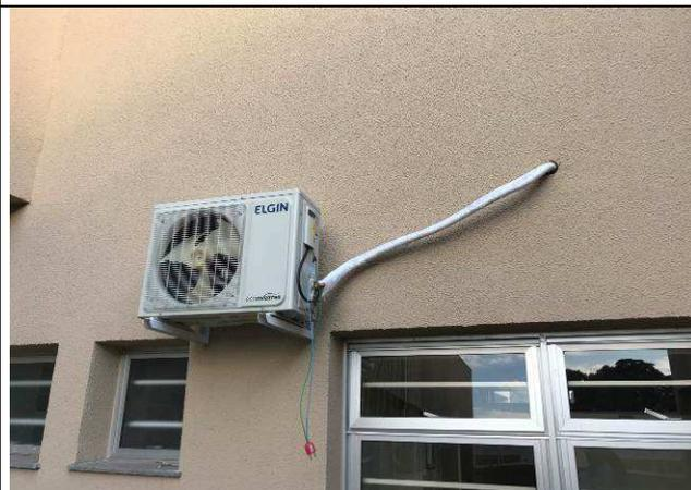
Figura 83C: Condensadora 12.000 BTUs - sala técnica de elétrica.
