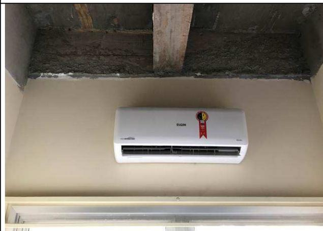
Figura 77C: Evaporadora 12.000 BTUs - Sala técnica de elétrica.
