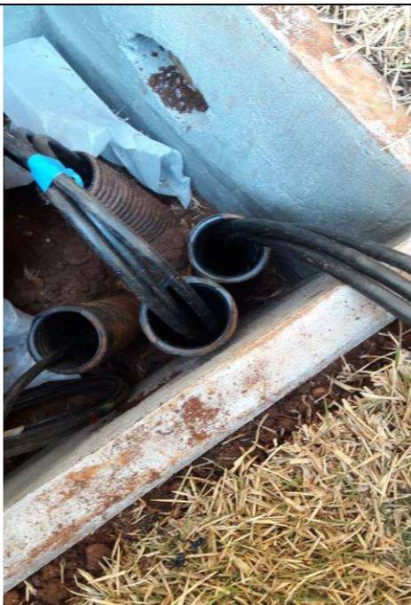
Figura 25E: cabeamento UTP cat6 especial para uso externo - frente edificação - CFTV e guarita
