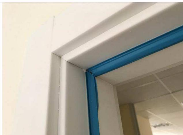
Figura 34C: Portas de madeira - Porta acústica - Borracha de vedação.
