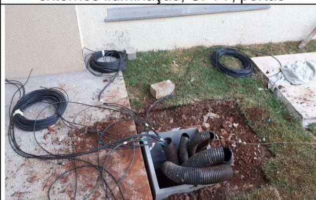
Figura 12E: cabeamento 1kV circuitos externos iluminação, CFTV, portão
