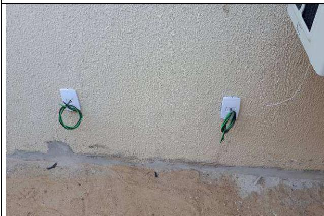
Figura 05E: cabeamento alimentação condicionadores de ar
