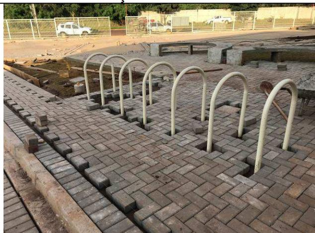
Figura 102C: Pavimentação intertravada - calçadas frontais.
