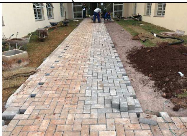
Figura 104C: Pavimentação intertravada - calçadas frontais.
