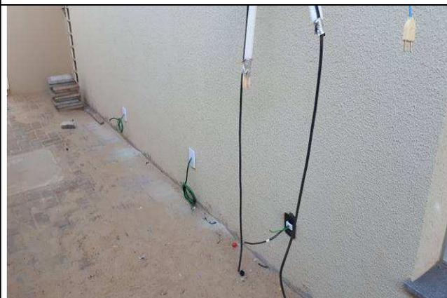
Figura 06E: cabeamento alimentação condicionadores de ar
