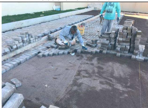
Figura 98C: Pavimentação intertravada - Estacionamento frontal.
