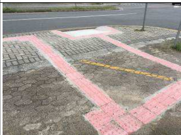
Figura 48C: rampa de acesso à PNEs finalizada e piso podotátil instalado
