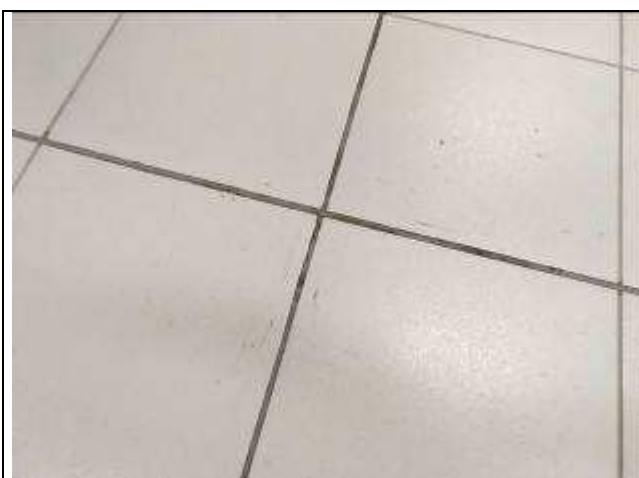
Figura 29C: Juntas de dilatação - hall público.
