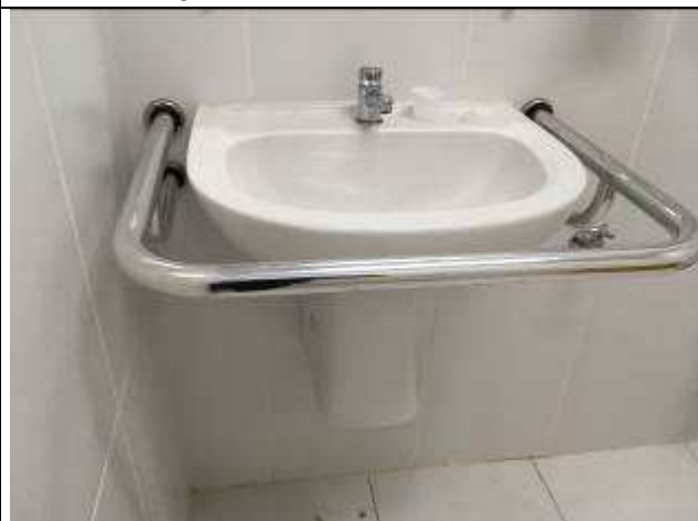
Figura 18C: barra de apoio - lavatório - BWC PNEs
