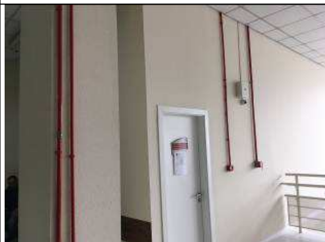
Figura 39C: Pintura interna - hall público
