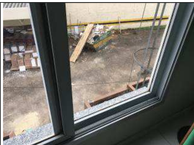
Figura 10C: Janela reinstalada - Sala de Audiências.
