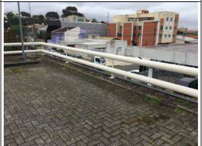
Figura 52C: Pintura gradil externo - testada Rua das Nações.
