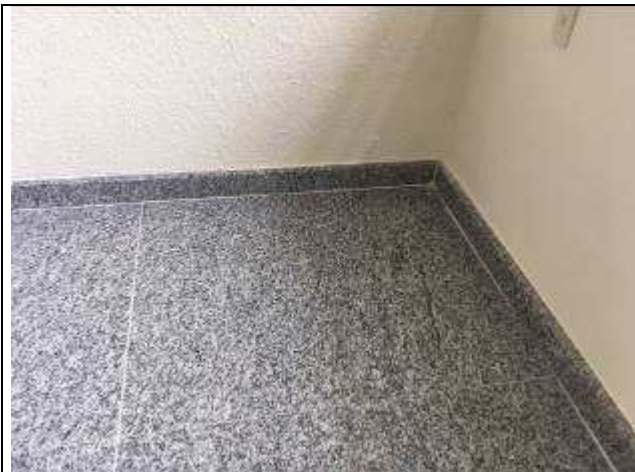
Figura 41C: Rodapé granito - escada
