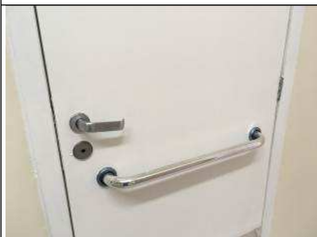
Figura 07C: barras de apoio retos - BWC PNEs.
