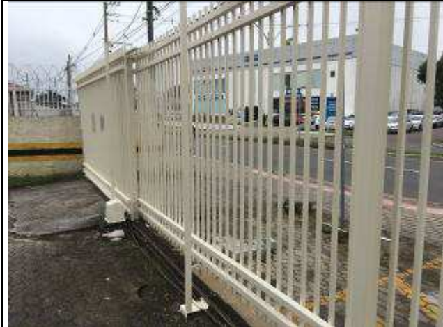
Figura 49C: pintura gradil externo - testada Rua Joaquim Nabuco.
