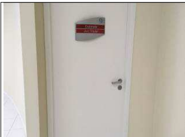
Figura 28C: pintura - portas existentes.
