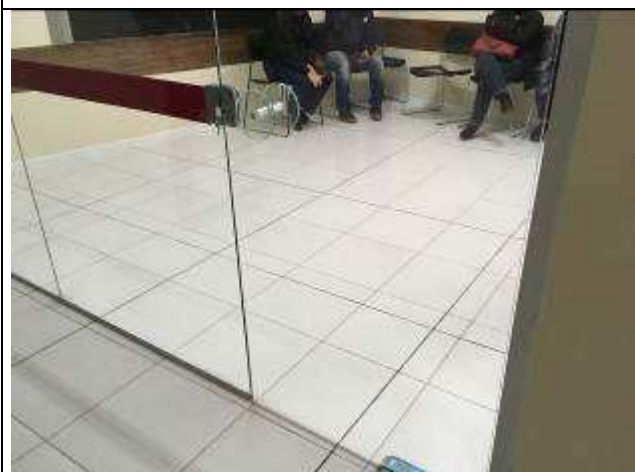
Figura 11C: Porta de vidro temperado - Balcão de atendimento.
