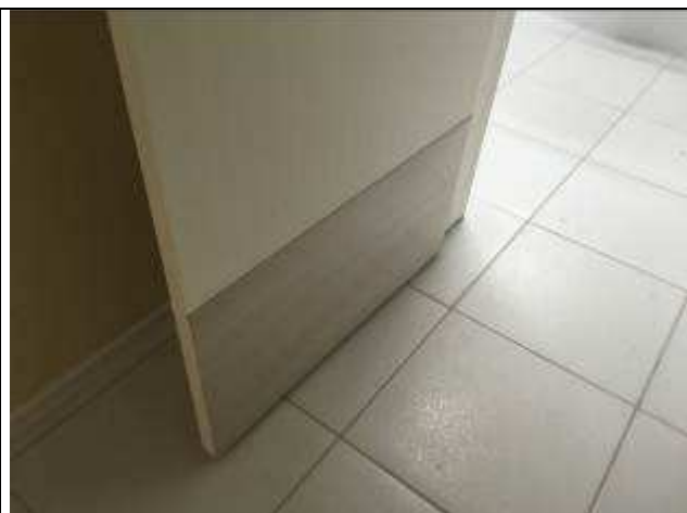
Figura 38C: chapa laminado - portas - BWC PNEs público.
