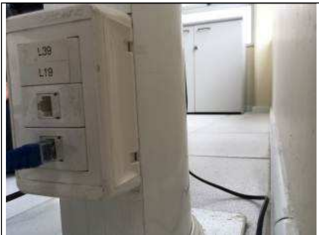
Figura 01E: tomadas RJ 45 - coluna técnica - gabinete do Juiz.
