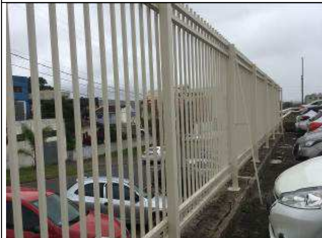
Figura 51C: Pintura gradil externo - testada Rua das Nações.
