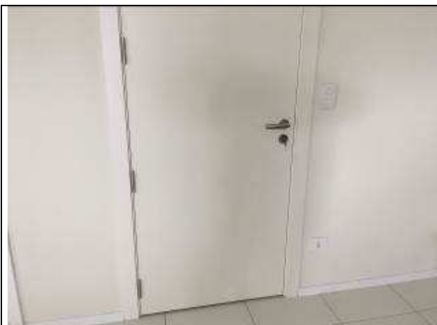
Figura 09C: Porta acústica instalada - Sala de Audiências.
