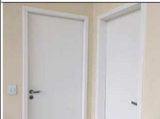
Figura 13C: Pintura - portas existentes.
