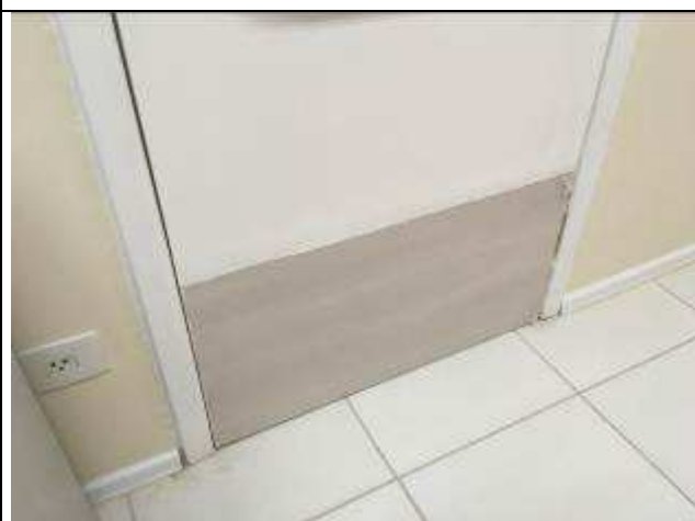
Figura 08C: Chapas laminado - BWC PNEs.
