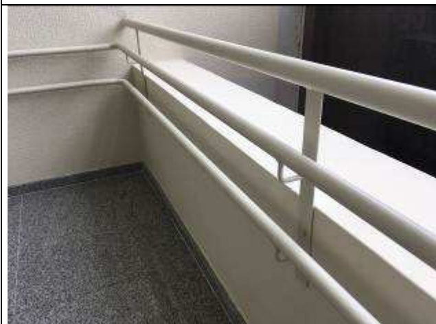
Figura 43C: Instalação de corrimão - escada de acesso
