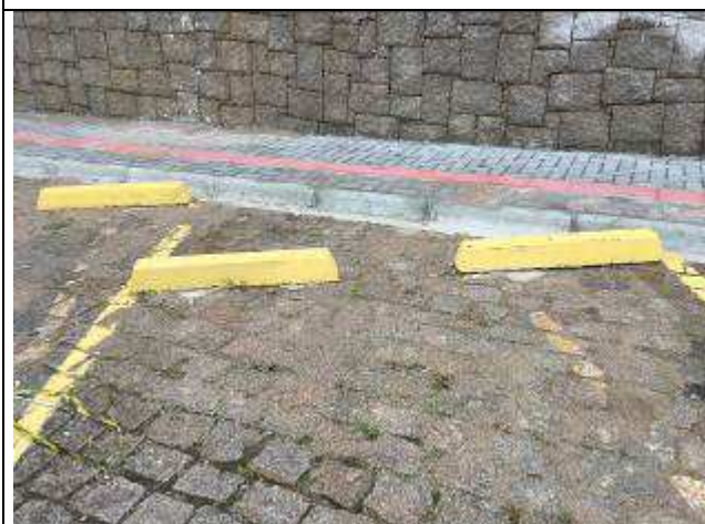
Figura 47C: Bate-rodas em concreto instalados.
