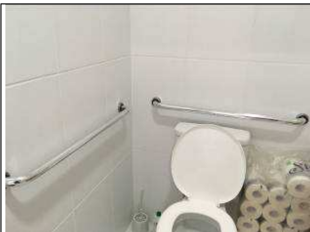
Figura 03C: barras de apoio - PNEs.
