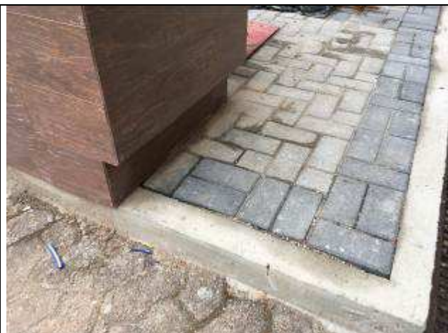
Figura 46C: pavimentação finalizada no acesso à 3ª VT.
