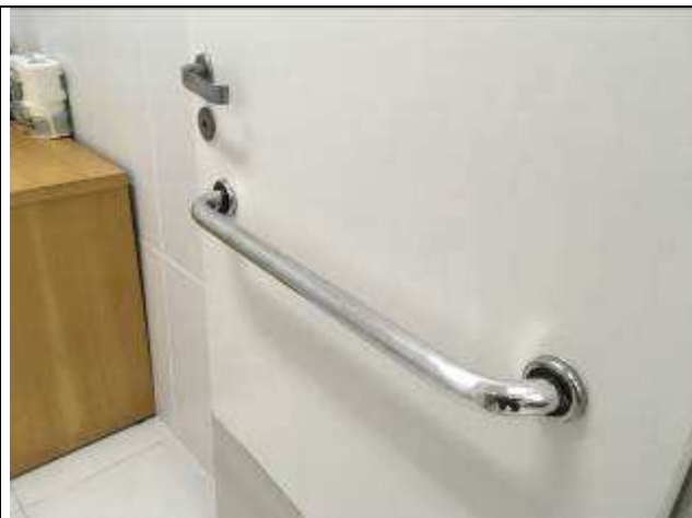
Figura 22C: barras de apoio reto - BWC PNEs
