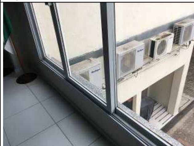
Figura 25C: janela reinstalada - Sala de audiências.
