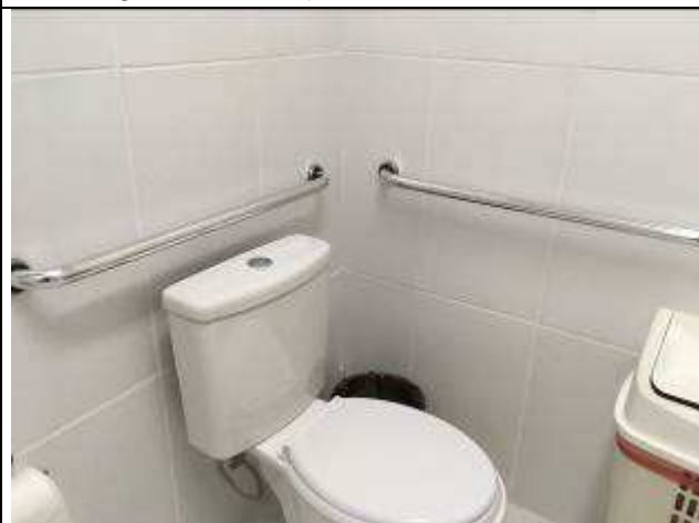
Figura 19C: barras de apoio - bacia - BWC PNEs.
