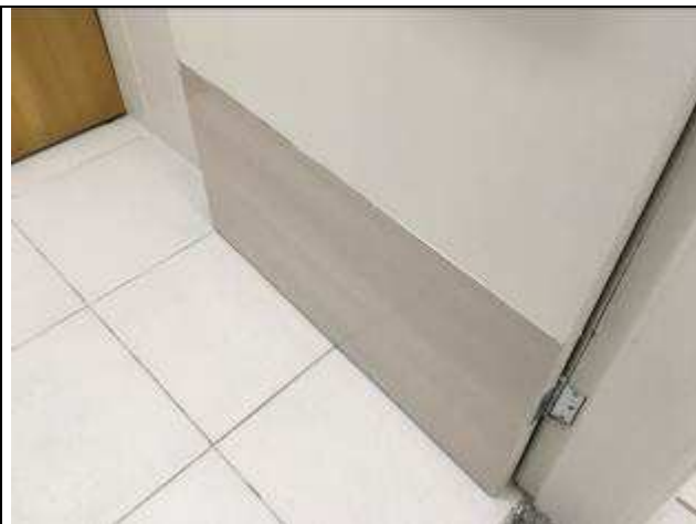
Figura 23C: Chapa de laminado - BWC PNEs.
