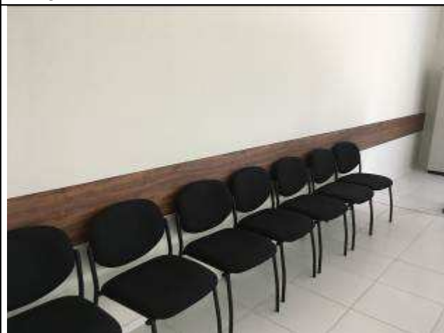
Figura 06C: protetores de parede - Sala de Audiências.
