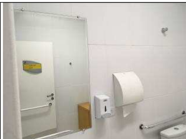
Figura 17C: Espelho cristal instalado.
