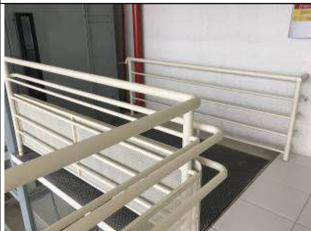
Figura 44C: Pintura de corrimões e guarda-corpos
