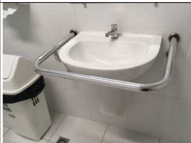
Figura 34C: barra de apoio - BWC PNEs público.
