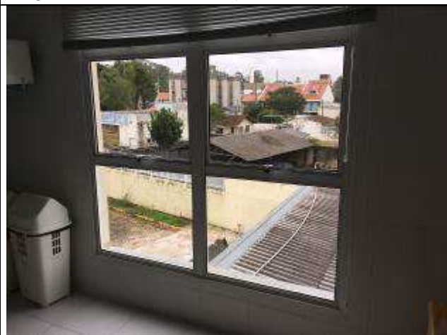
Figura 24C: janela reinstalada - copa
