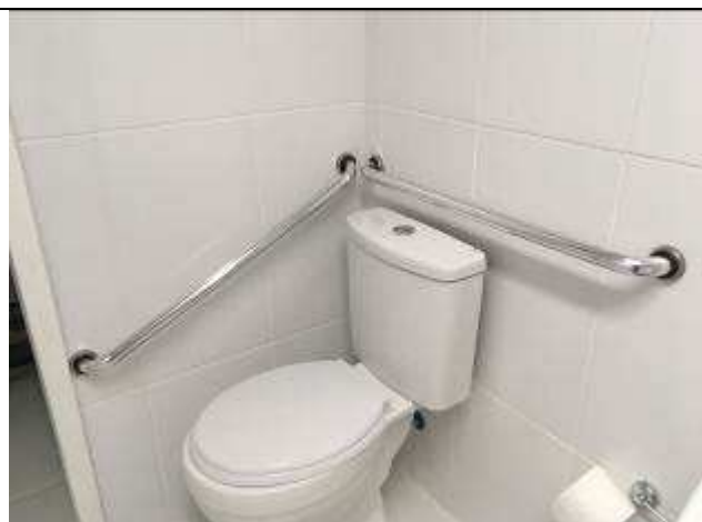
Figura 33C: barras de apoio - bacia - BWC PNEs público
