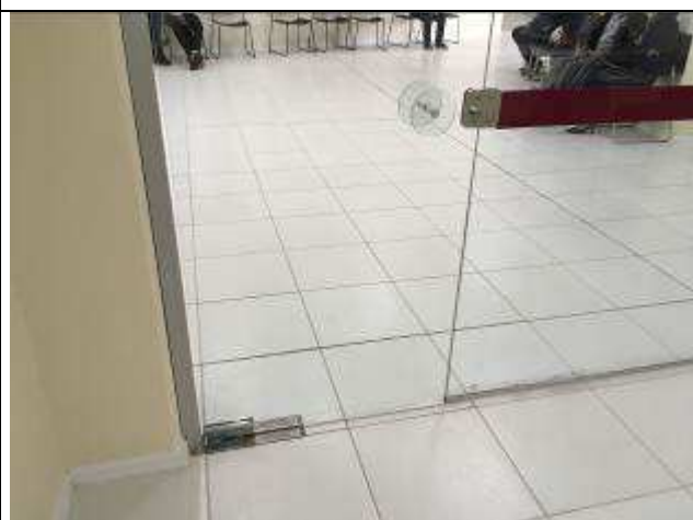
Figura 26C: porta vidro temperado - balcão de atendimento.
