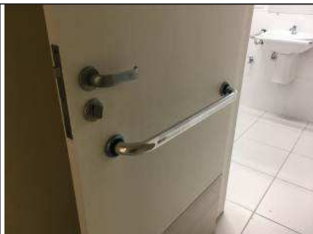
Figura 37C: barra de apoio reta - BWC PNEs público
