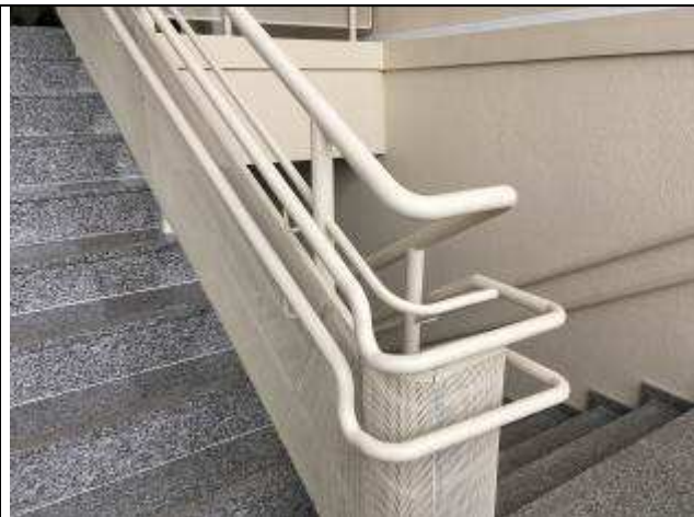
Figura 42C: guarda-corpo reinstalado e adequado em sua altura.
