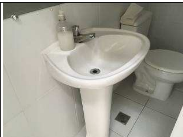
Figura 04C: lavatório e metais reinstalados.
