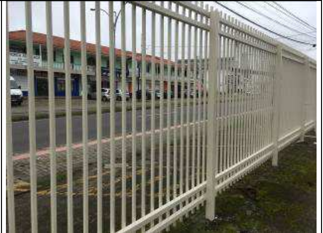
Figura 50C: pintura gradil externo - testada Rua Joaquim Nabuco.
