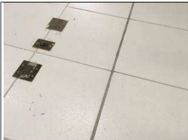
Figura 14C: Juntas de dilatação - Secretaria.
