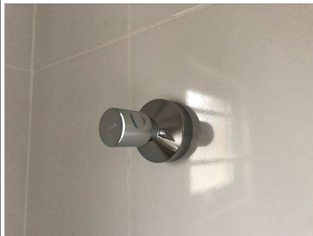
Figura 02C: Registros de 1 1/2" - acabamentos.
