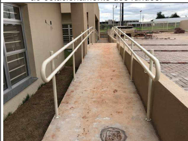
Figura 43C: Corrimãos - rampas de acesso ao estacionamento dos fundos.
