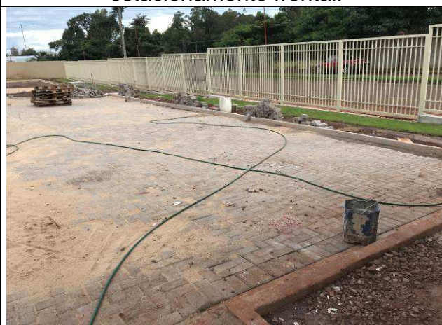
Figura 38C: Meios-fios em concreto - estacionamento frente.
