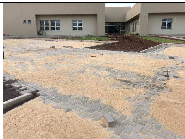
Figura 34C: Assentamento de paver - estacionamento frontal.
