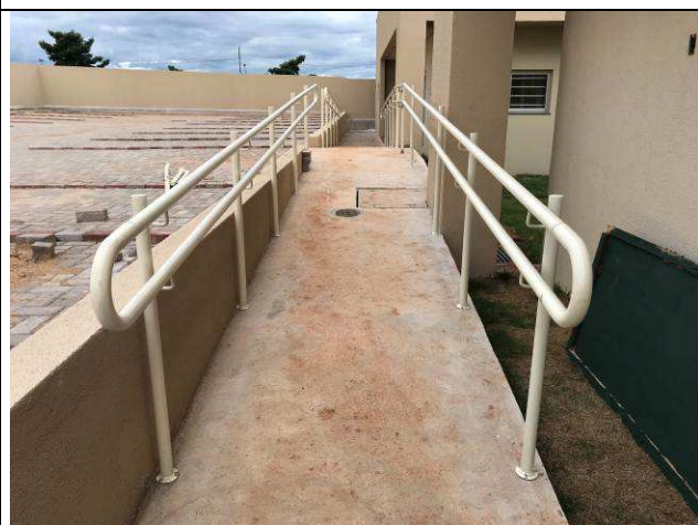
Figura 44C: Corrimãos - rampas de acesso ao estacionamento dos fundos.
