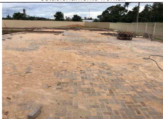
Figura 37C: Assentamento de paver - estacionamento frontal.
