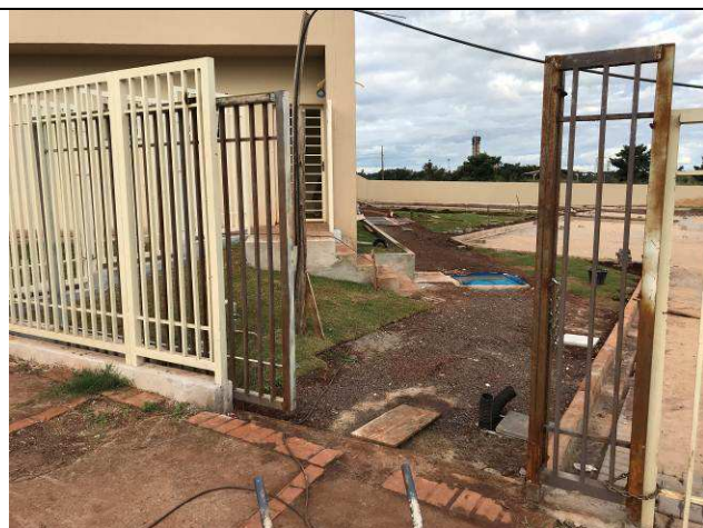
Figura 51C: Gradil de fechamento - portão de pedestres.
