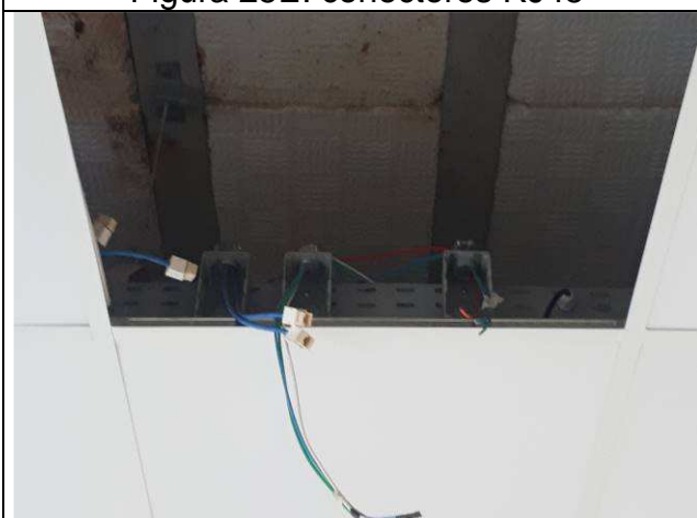
Figura 27E: conectores RJ45
