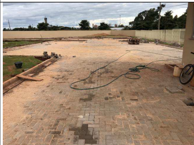
Figura 36C: Assentamento de paver - estacionamento frontal.
