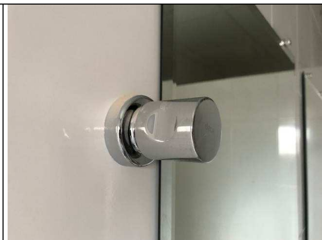
Figura 04C: Registros de 3/4" - acabamentos.
