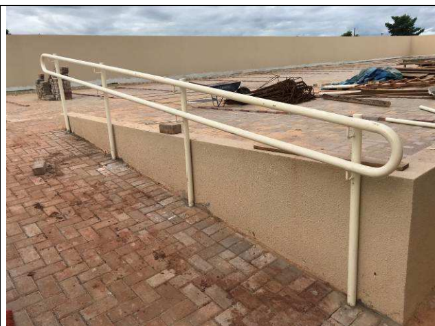
Figura 40C: Corrimãos - rampas de acesso ao estacionamento dos fundos.
