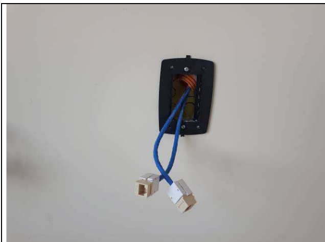
Figura 25E: conectores RJ45
