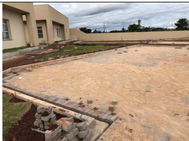
Figura 35C: Assentamento de paver - estacionamento frontal.
