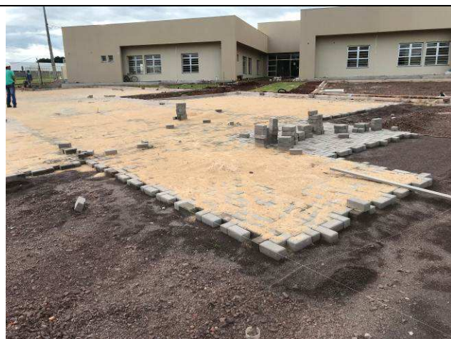
Figura 33C: Assentamento de paver - estacionamento frontal.
