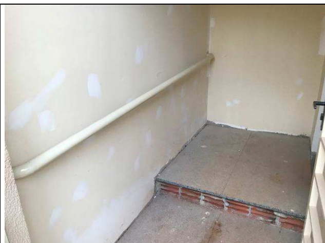
Figura 45C: Corrimãos - acesso lateral da 1ª Vara.
