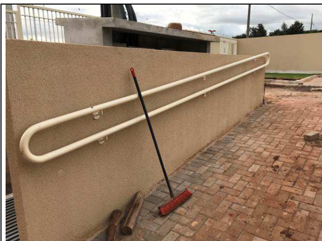
Figura 39C: Corrimãos - rampas de acesso ao estacionamento dos fundos.
