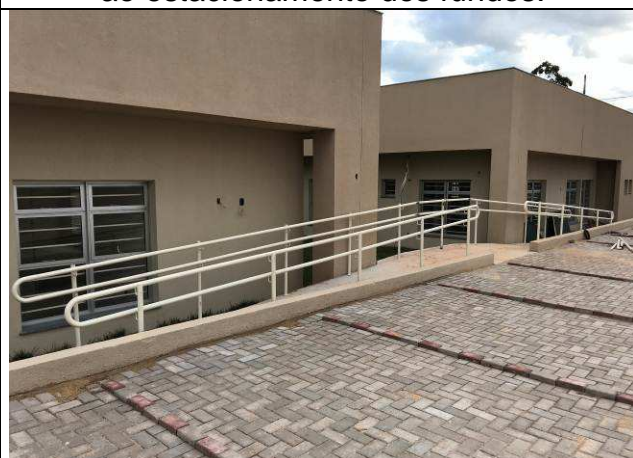
Figura 42C: Corrimãos - rampas de acesso ao estacionamento dos fundos.
