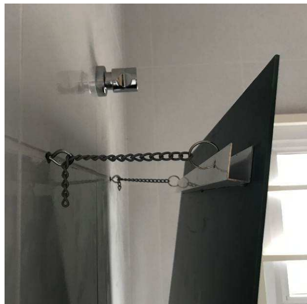
Figura 20C: Espelho para sanitário - correntes para inclinar o espelho nos banheiros PNE.
