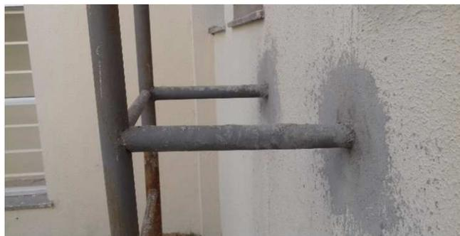
Figura 44C: Escada marinheiro - detalhe da fixação
