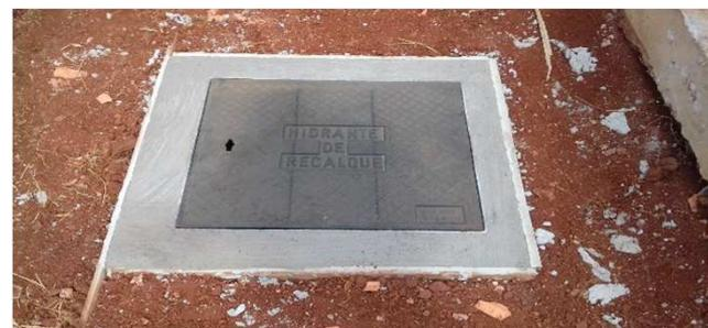
Figura 24C: Detalhe do tampo do hidrante de recalque
