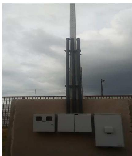
Figura 03E: eletrodutos entrada de energia e telecomunicações
