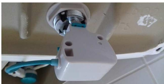
Figura 15C: Bacia sanitária com caixa acoplada - detalhe de acionador duplo
