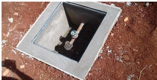
Figura 25C: Caixa em alvenaria - hidrante de recalque
