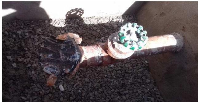
Figura 26C: Tubulação e registro globo - hidrante de recalque
