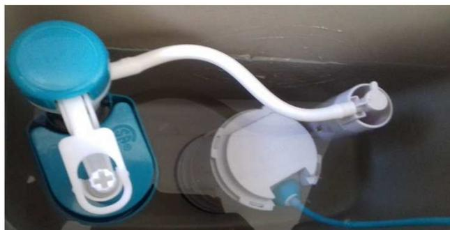
Figura 14C: Bacia sanitária com caixa acoplada - detalhe de válvula de descarga
