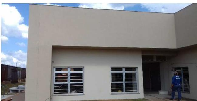
Figura 37C: Segunda demão de textura acrílica - bloco central (lateral direita)
