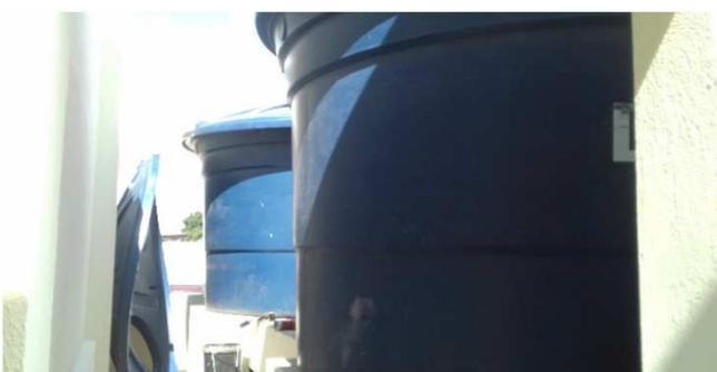
Figura 28C: Reservatórios em polietileno
