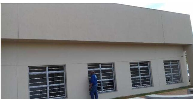
Figura 36C: Segunda demão de textura acrílica - bloco da direita (frontal)
