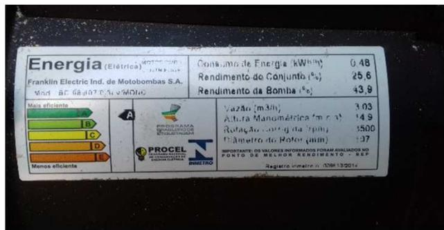
figura 10C: Bomba de recalque de 1/2 HP - eficiência energética e rendimento
