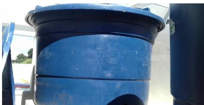
Figura 27C: Reservatório em polietileno
