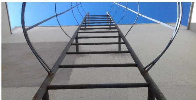
Figura 43C: Escada marinheiro - guarda-corpos e degraus
