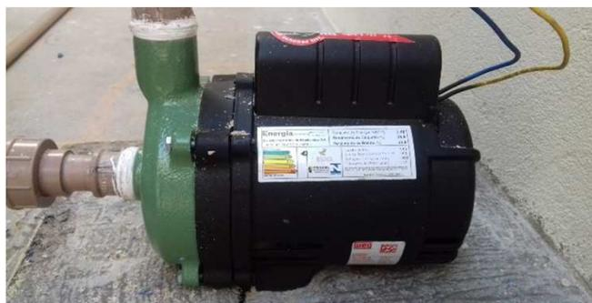
Figura 09C: Bomba de recalque de 1/2 HP
