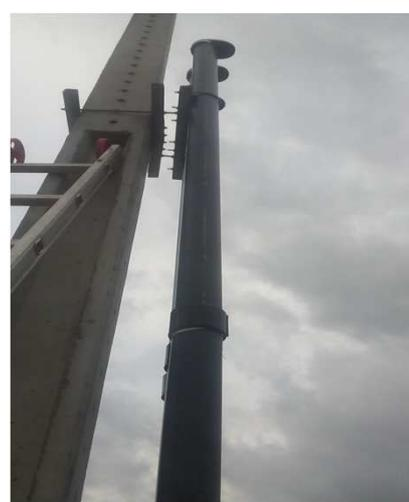
Figura 04E: eletrodutos entrada de energia e telecomunicações
