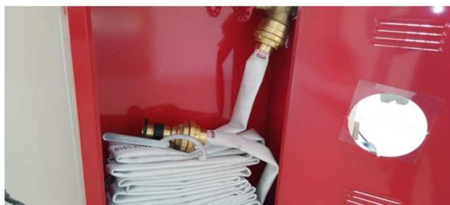
Figura 21C: detalhe de mangueira e registro globo angular, em hidrante
