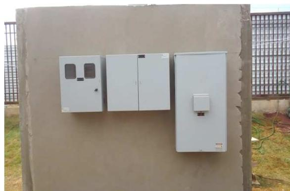
Figura 02E: mureta e caixas de medição, tcs e proteção
