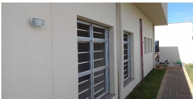
Figura 38C: Segunda demão de textura acrílica - bloco da esquerda (fundos)
