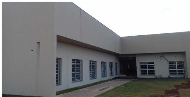
Figura 39C: Segunda demão de textura acrílica - bloco da esquerda (frontal)
