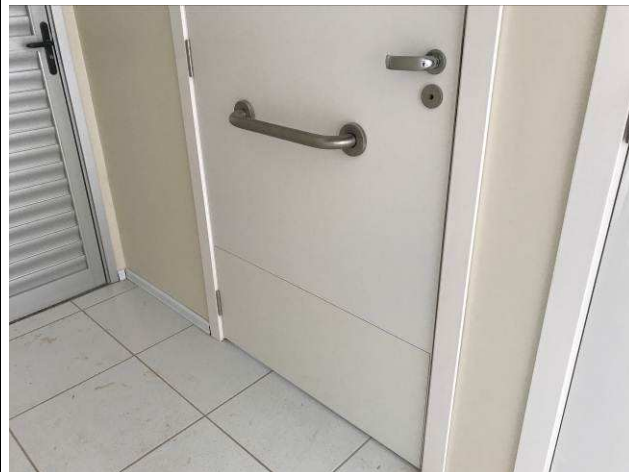
Figura 11C: Portas de madeira PNE com barra de apoio e placa de fórmica na parte inferior - Fórum.
