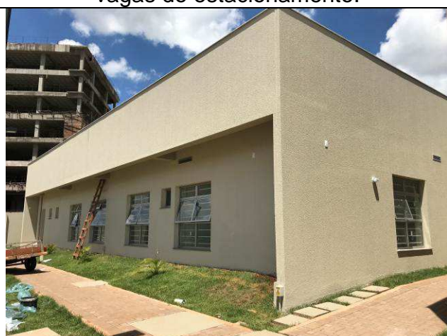
Figura 94C: Textura em paredes externas.
