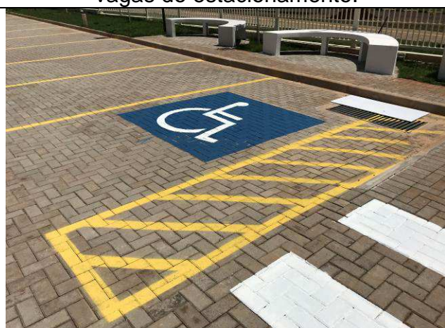
Figura 88C: Pintura em piso - demarcação vagas do estacionamento.
