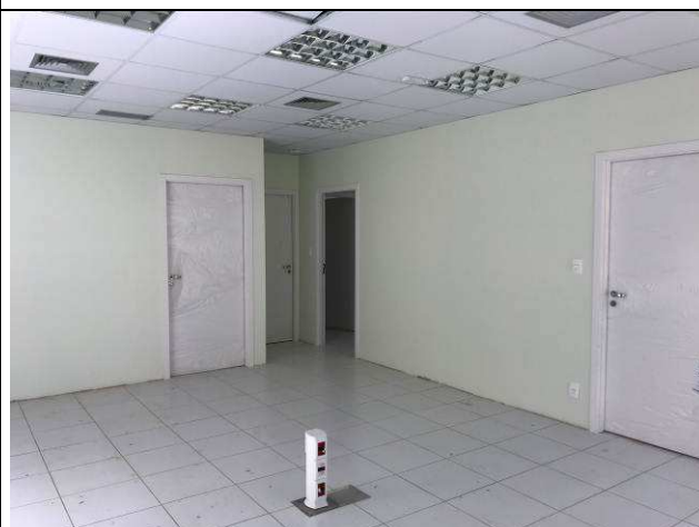
Figura 105C: Pintura em paredes internas.
