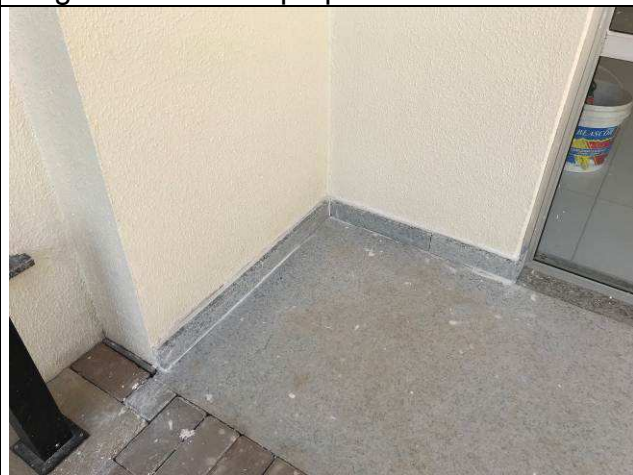
Figura 44C: Rodapé granito - Fórum.
