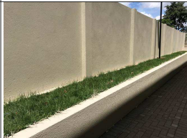
Figura 81C: Pintura do muro de divisa.
