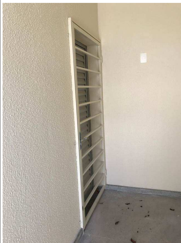
Figura 33C: Porta de grade da entrada da 2ª Vara - Fórum.
