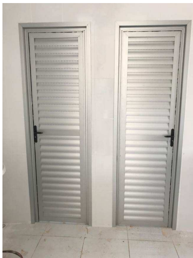
Figura 16C: Portas de alumínio dos banheiros dos vestiários - Arquivo.
