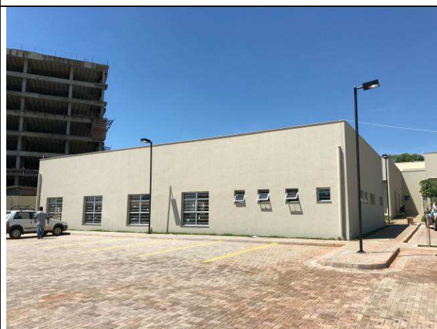
Figura 101C: Textura em paredes externas.
