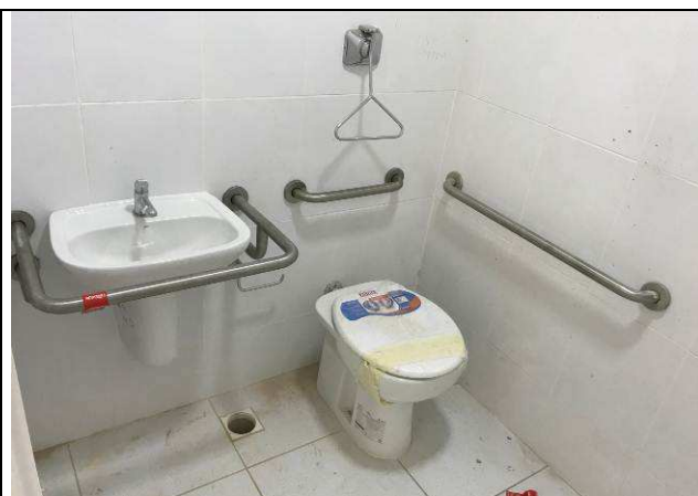
Figura 47C: Barras lavatórios - Fórum.
