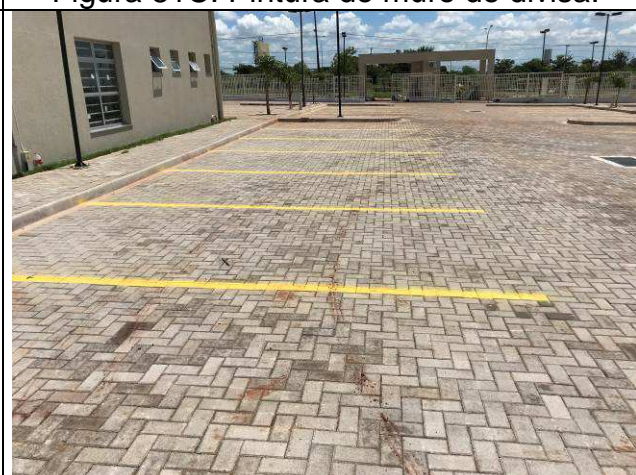
Figura 83C: Pintura em piso - demarcação vagas do estacionamento.
