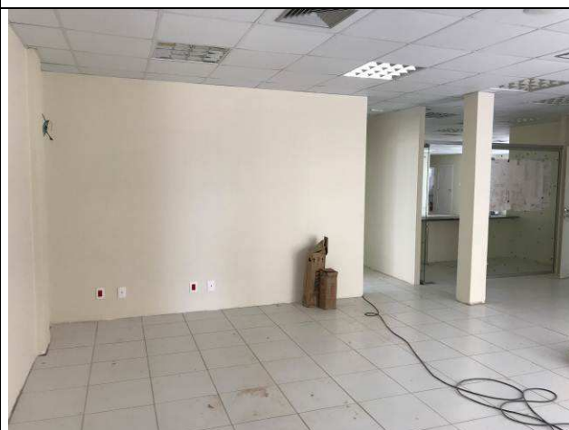
Figura 107C: Pintura em paredes internas.
