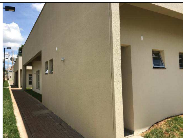
Figura 97C: Textura em paredes externas.
