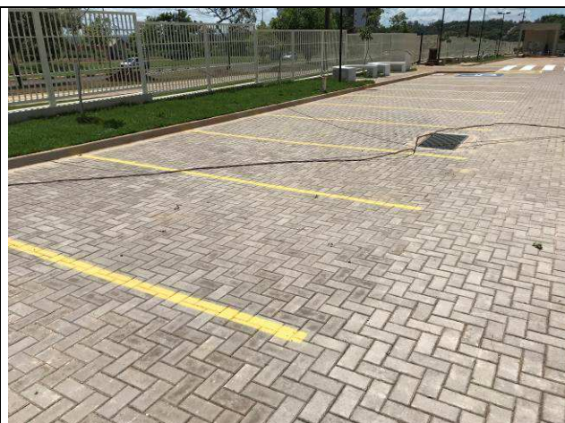
Figura 91C: Pintura em piso - demarcação vagas do estacionamento.
