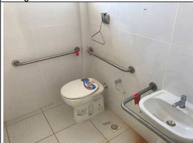
Figura 50C: Barras lavatório e bacia- Fórum.
