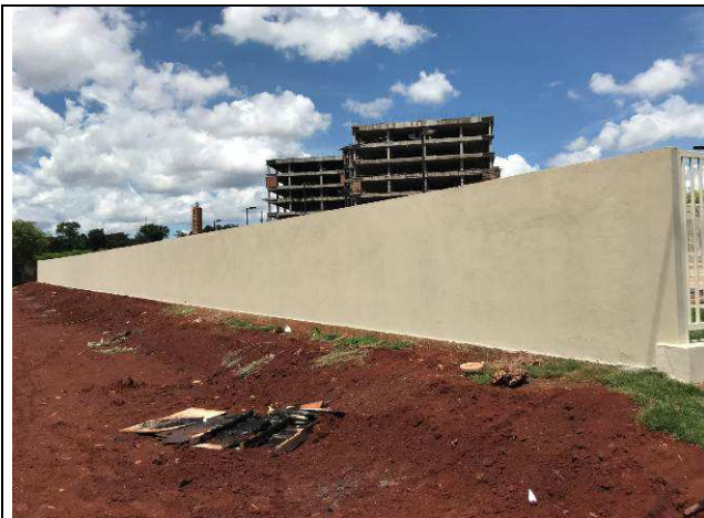
Figura 78C: Pintura do muro de divisa.
