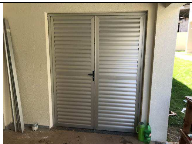
Figura 18C: Porta de alumínio dupla da entrada do Arquivo.
