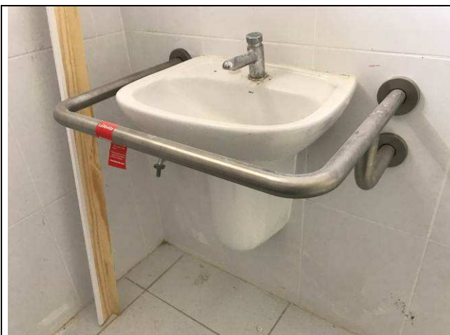
Figura 48C: Barras lavatórios - Fórum.
