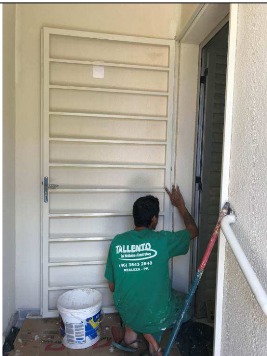
Figura 34C: Porta de grade da entrada da 3ª Vara - Fórum.
