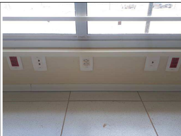
Figura 04E: interruptores, espelhos, tomadas elétricas
