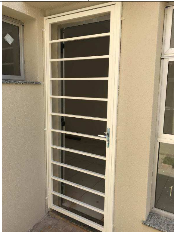
Figura 36C: Porta de grade da entrada lateral do Hall central- Fórum.
