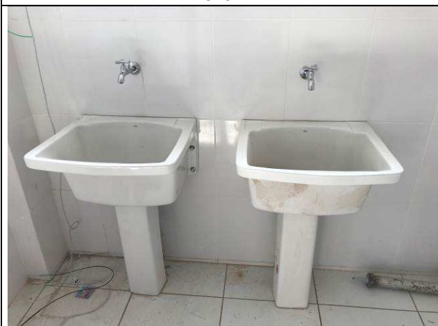
Figura 52C: Tanques de louça - Arquivo.
