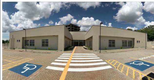
Figura 99C: Textura em paredes externas.
