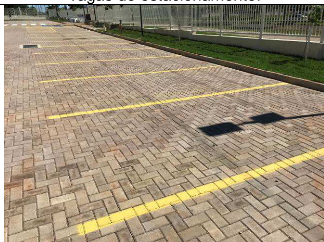
Figura 92C: Pintura em piso - demarcação vagas do estacionamento.
