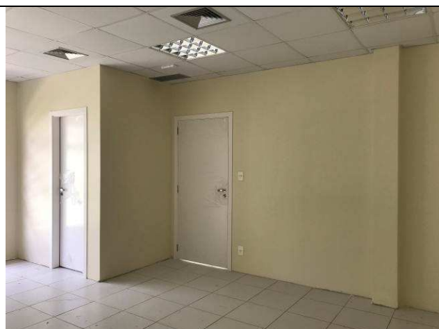
Figura 104C: Pintura em paredes internas.
