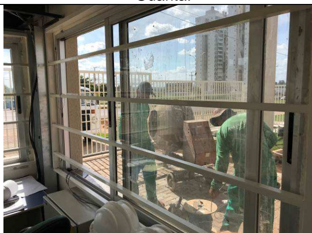
Figura 21C: Gradis de proteção das janelas - Guarita.
