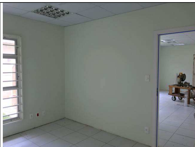
Figura 103C: Pintura em paredes internas.
