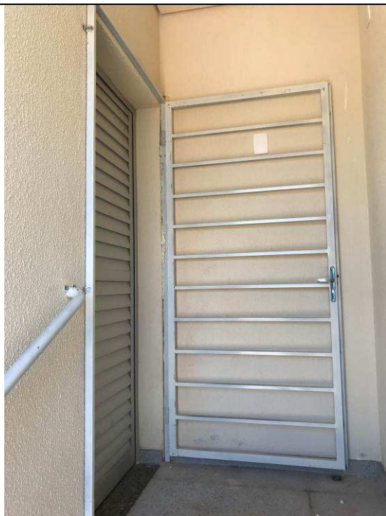
Figura 35C: Porta de grade da entrada da 2ª Vara - Fórum.
