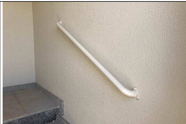
Figura 61C: Corrimão metálico - Distribuição.
