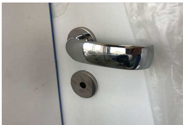
Figura 12C: Fechaduras instaladas nas portas normais e de banheiro - Fórum.
