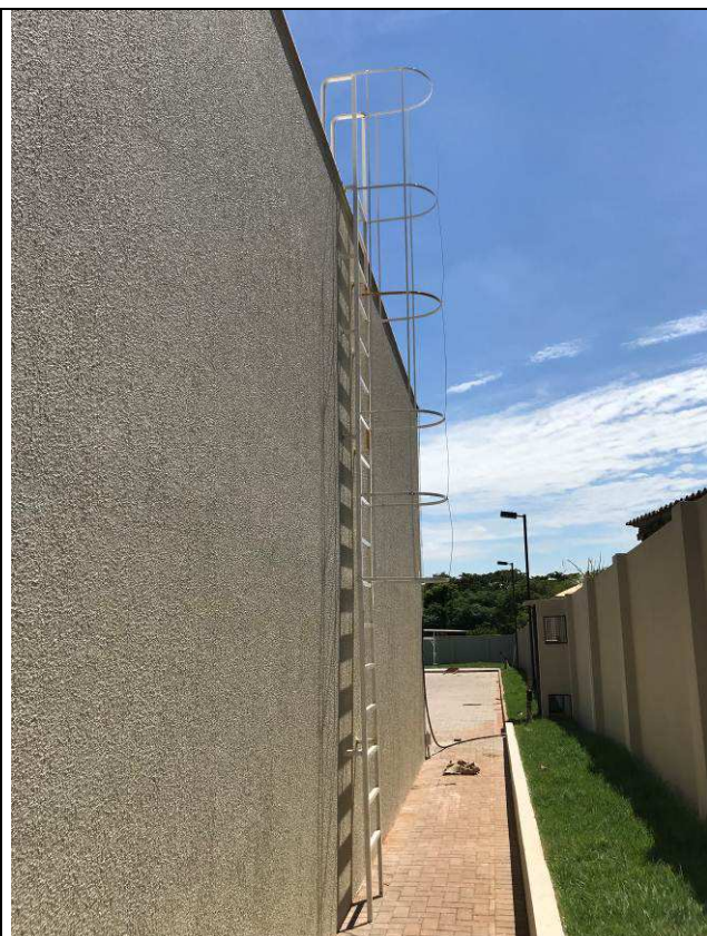
Figura 115C: Escada marinheiro - Arquivo.
