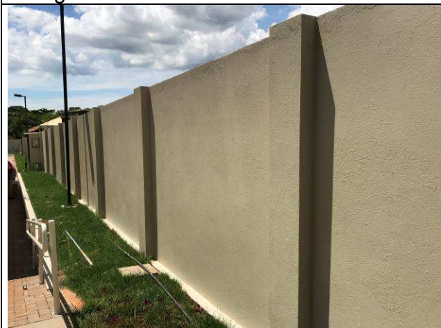
Figura 80C: Pintura do muro de divisa.
