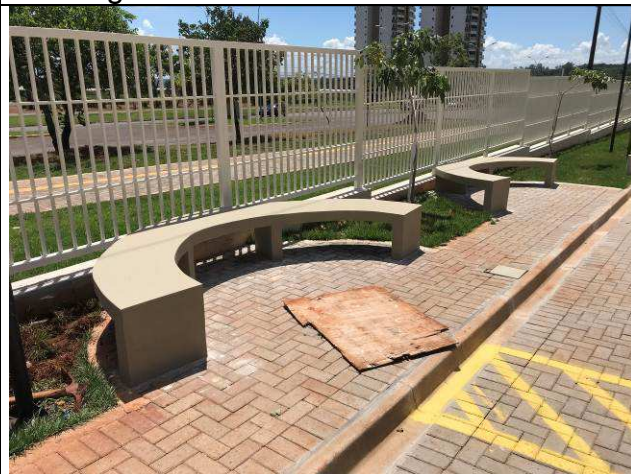
Figura 110C: Bancos de concreto.
