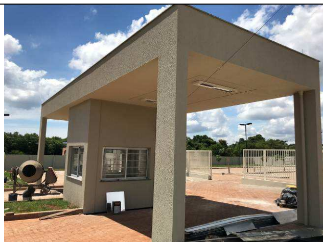
Figura 102C: Textura em paredes externas.
