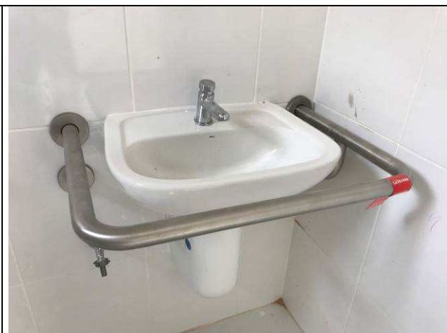
Figura 49C: Barras lavatórios - Fórum.
