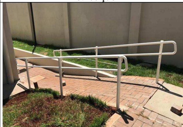
Figura 63C: Corrimão metálico - ligação entre os fundos do Arquivo e do Fórum.
