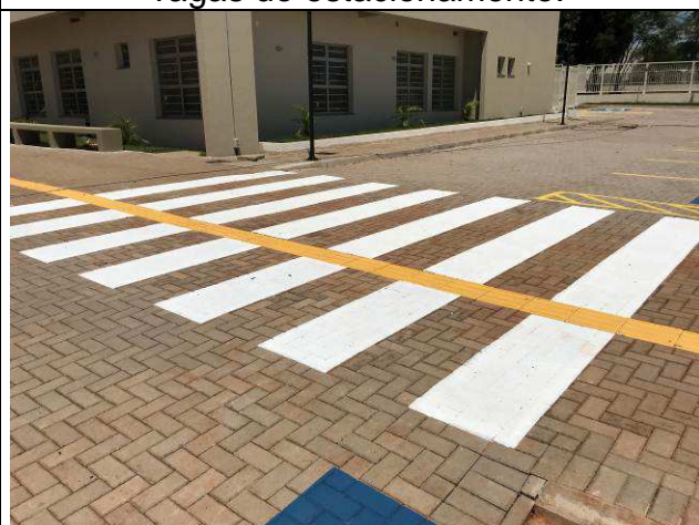
Figura 87C: Pintura em piso - demarcação vagas do estacionamento.
