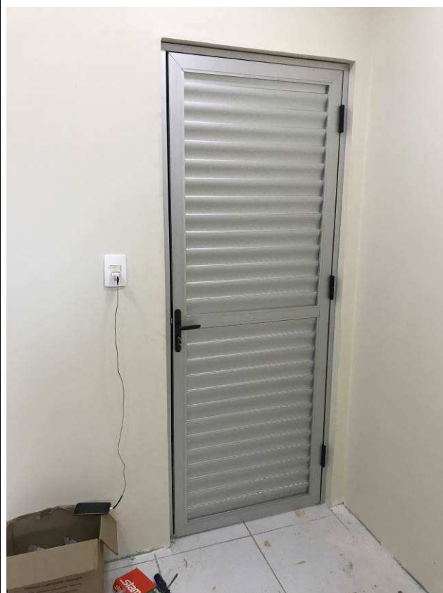
Figura 17C: Porta de alumínio da entrada do vestiário - Arquivo.
