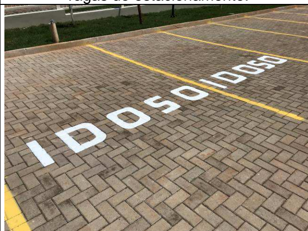
Figura 93C: Pintura em piso - demarcação vagas do estacionamento.
