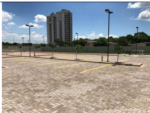
Figura 84C: Pintura em piso - demarcação vagas do estacionamento.
