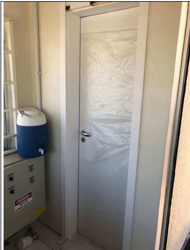
Figura 06C: Portas de madeira - Guarita.
