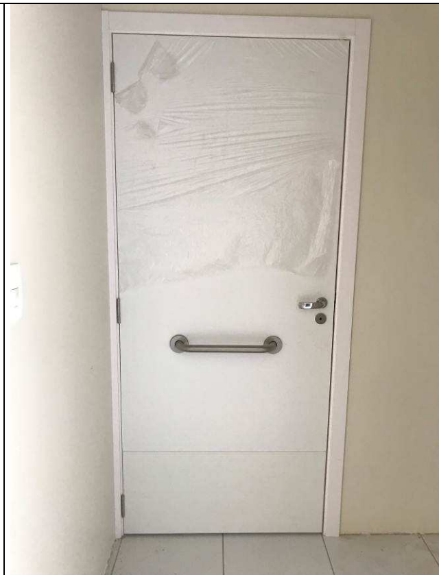
Figura 07C: Portas de madeira PNE com barra de apoio e placa de fórmica na parte inferior - Fórum.
