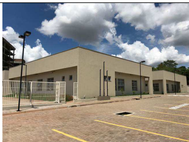
Figura 100C: Textura em paredes externas.
