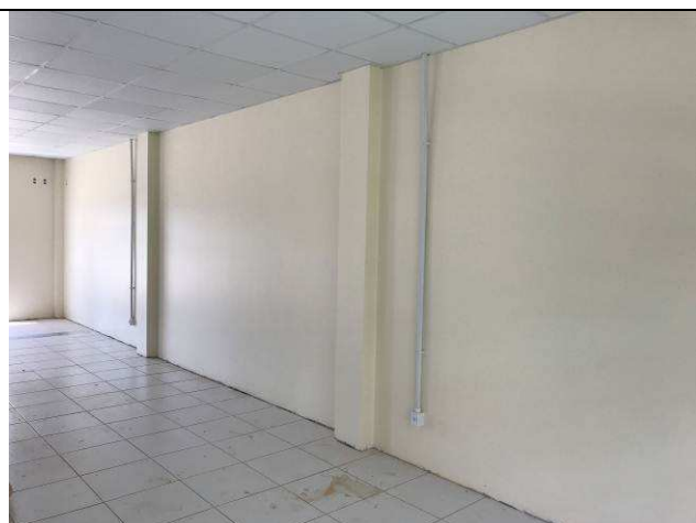
Figura 106C: Pintura em paredes internas.
