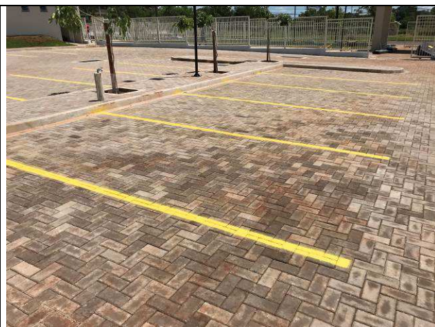
Figura 85C: Pintura em piso - demarcação vagas do estacionamento.
