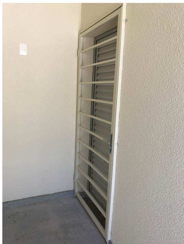
Figura 32C: Porta de grade da entrada da 1ª Vara - Fórum.
