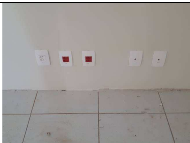
Figura 03E: interruptores, espelhos, tomadas elétricas
