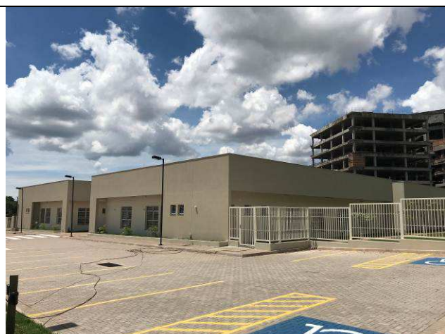
Figura 98C: Textura em paredes externas.
