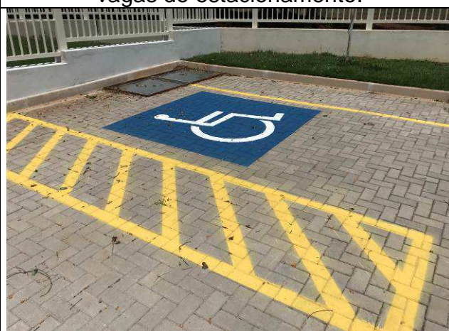
Figura 89C: Pintura em piso - demarcação vagas do estacionamento.
