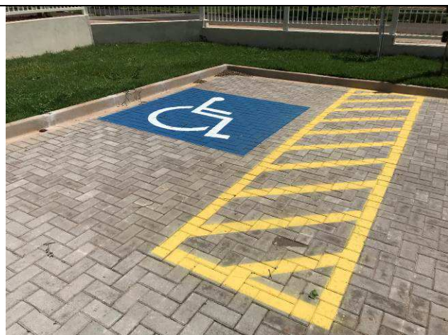
Figura 90C: Pintura em piso - demarcação vagas do estacionamento.
