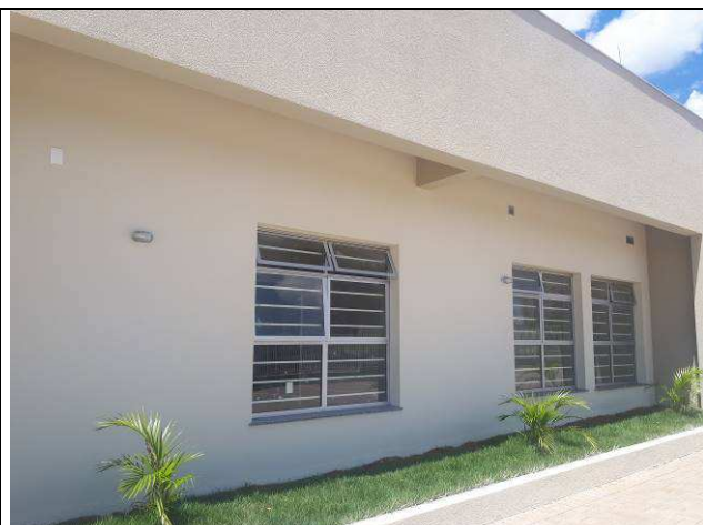
Figura 16E: luminárias tipo tartaruga
