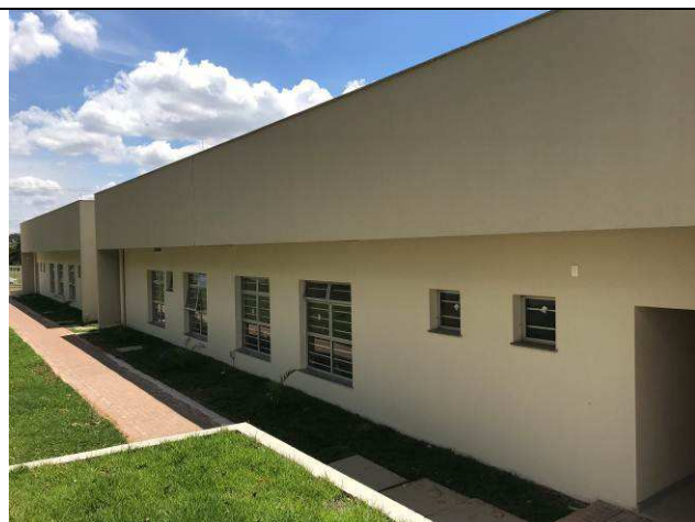
Figura 96C: Textura em paredes externas.
