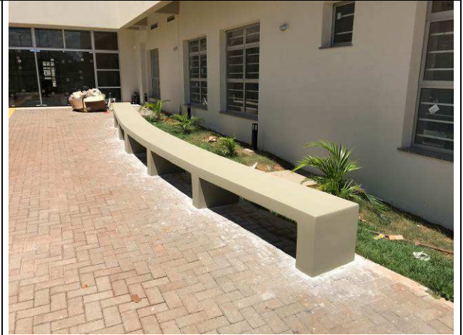
Figura 109C: Bancos de concreto.
