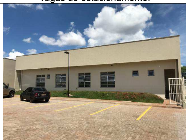
Figura 95C: Textura em paredes externas.
