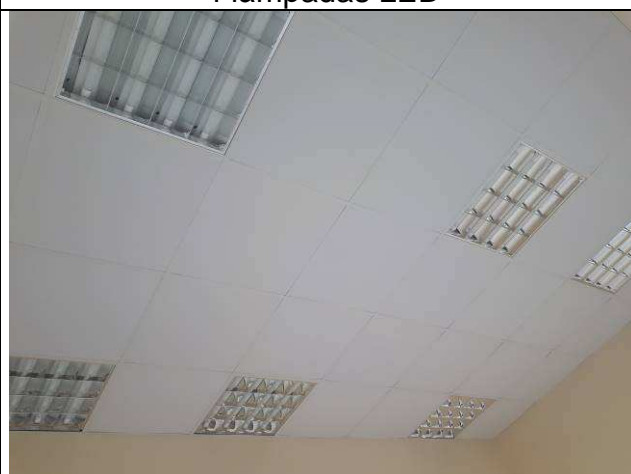
Figura 12E: iluminação interna - luminárias 4 lâmpadas LED
