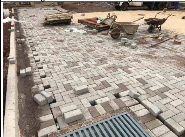
Figura 51C: Assentamento de paver - estacionamento frontal.
