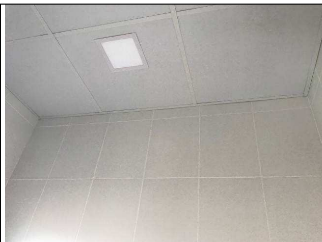
Figura 10C: Forro - Banheiro Gabinete de Juiz - 2ª Vara.
