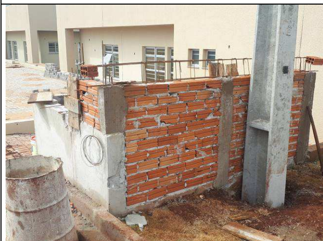
Figura 05E: entrada de energia e transformador
