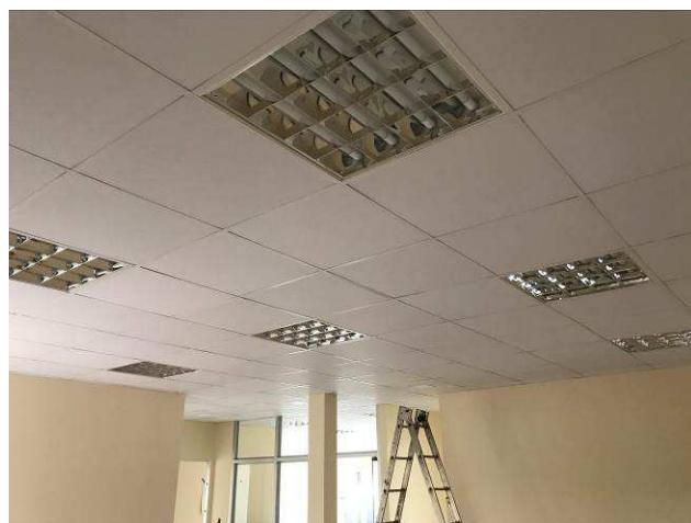
Figura 01C: Forro - Espera público - 2ª Vara.
