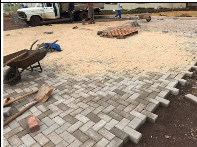
Figura 53C: Assentamento de paver - estacionamento frontal.
