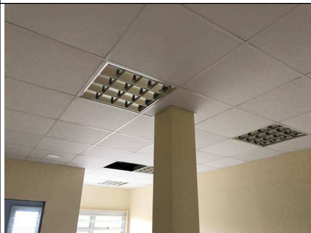
Figura 11C: Forro - Sala de Perícias.
