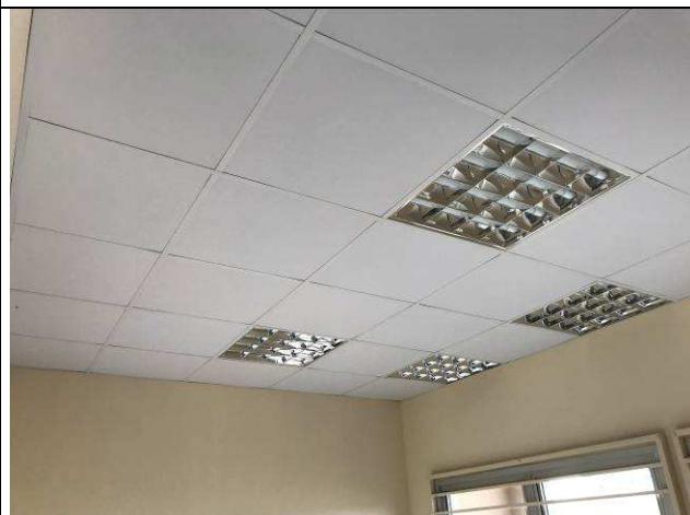
Figura 08C: Forro - Sala de Assistentes - 2ª Vara.
