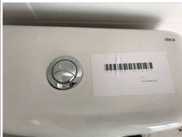
Figura 24C: Duplo botão de acionamento da caixa acoplada.
