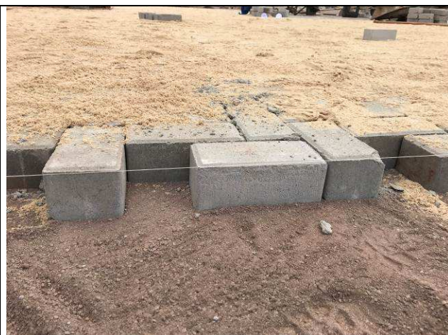
Figura 55C: Assentamento de paver - estacionamento frontal.
