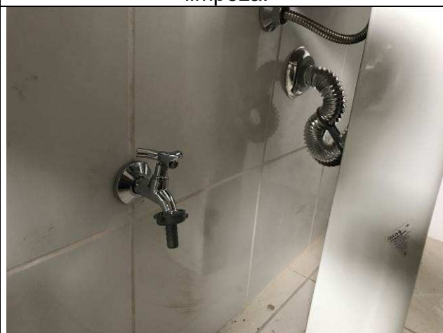
Figura 30C: Torneira, sifão corrugado e engate flexível cromados para lavatório.
