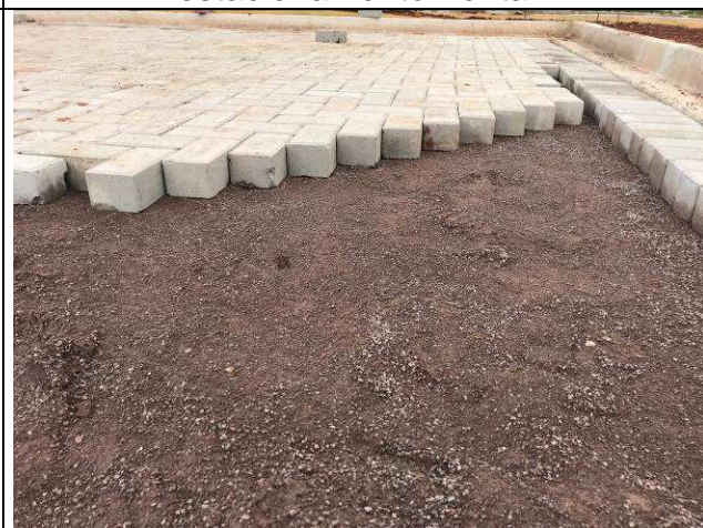
Figura 54C: Assentamento de paver - estacionamento frontal.
