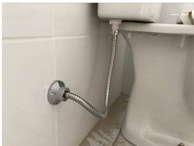
Figura 23C: Engate flexível de alimentação da caixa acoplada.
