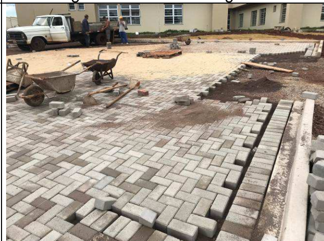
Figura 52C: Assentamento de paver - estacionamento frontal.
