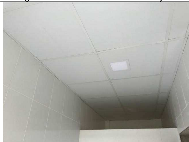
Figura 17C: Forro - Banheiro Público.
