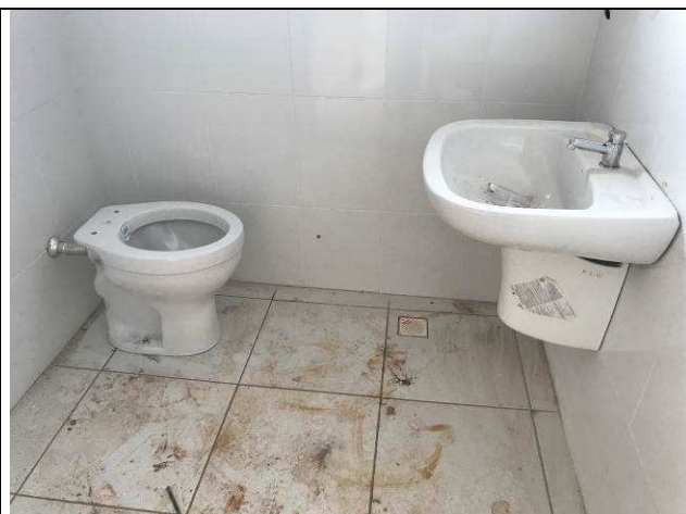
Figura 32C: Bacia sanitária PNE e lavatório com coluna suspensa.
