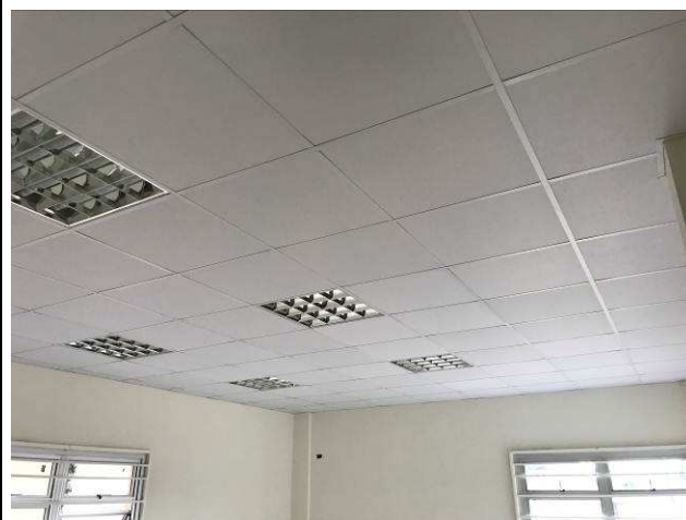
Figura 02C: Forro - Sala de Audiências - 2ª Vara.
