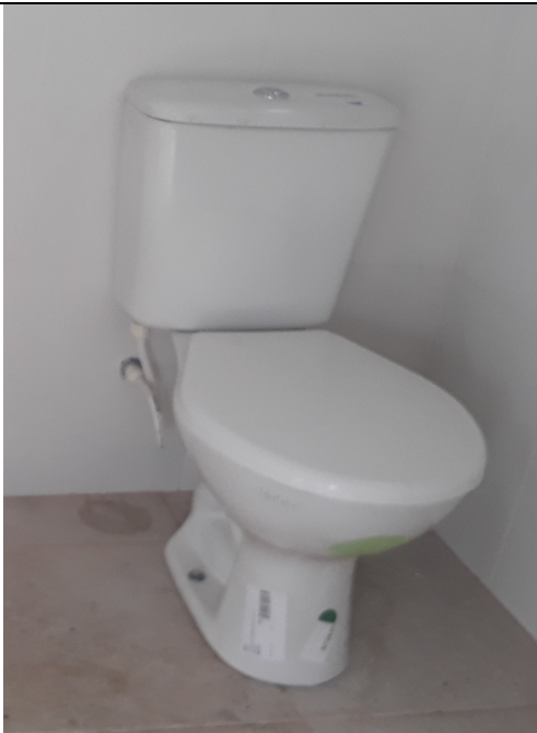
Figuras 10 - Sanitários com caixas acopladas e assentos.
