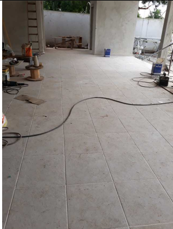
Figura 07 - Assentamento de piso cerâmico na Área de Vivência.
