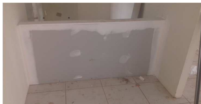
Figura 03C: Fechamento em gesso acartonado, sob balcão de atendimento - 2ª Vara
