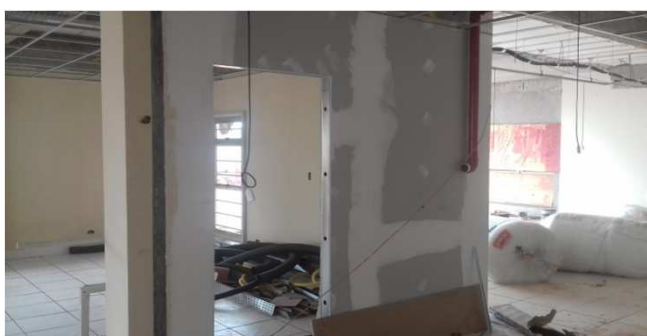
Figura 01C: Parede de gesso acartonado simples - Sala da OAB
