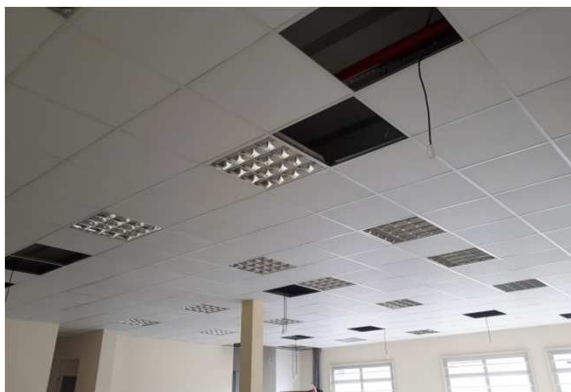
Figura 17E: luminárias com aletas 62,5 x 62,5cm
