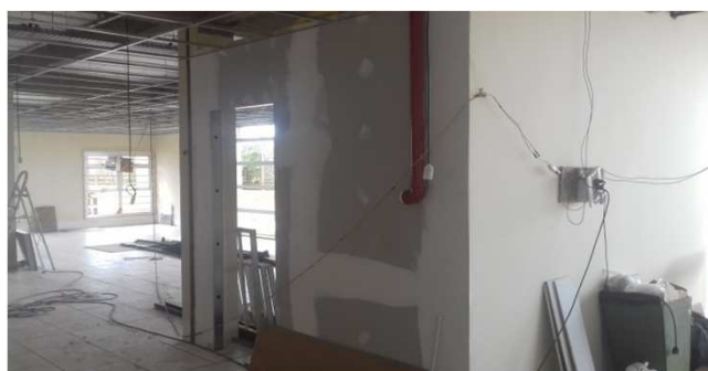
Figura 02C: Parede de gesso acartonado simples - Sala da OAB
