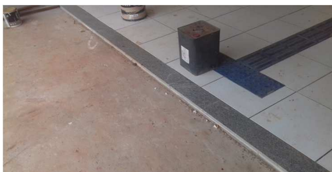
Figura 15C: Soleira instalada junto à entrada principal (frontal) do Fórum
