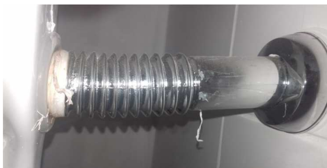
Figura 22C: Detalhe do Engate de alimentação de bacia sanitária
