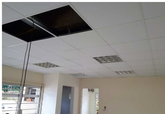
Figura 18E: luminárias com aletas 62,5 x 62,5cm
