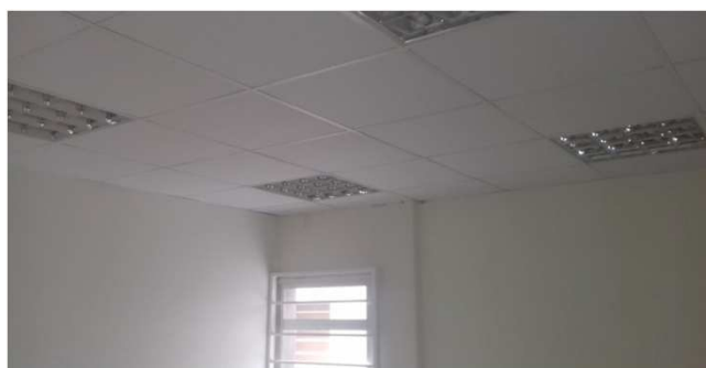
Figura 10C: Forro instalado na sala de audiência 2 da 1ª Vara
