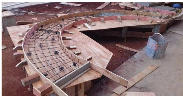
Figura 55C: Banco de concreto armado tendo sua fôrma e armadura sendo confeccionadas
