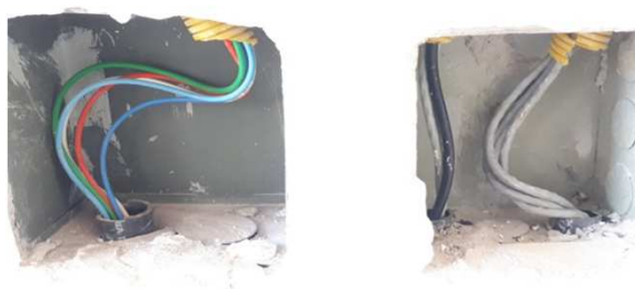
Figura 25E: cabeamento som, utp e caixas audiências
