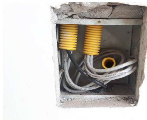
Figura 26E: cabeamento som, utp e caixas audiências
