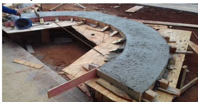
Figura 56C: Banco de concreto armado sendo concretado
