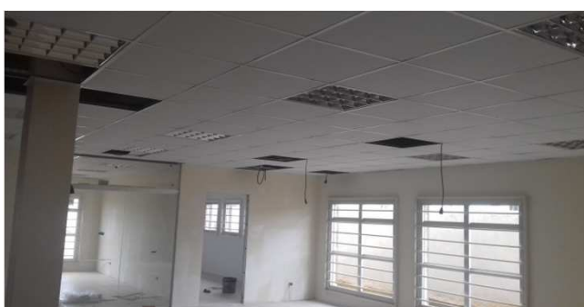
Figura 08C: Forro instalado na secretaria da 1ª Vara
