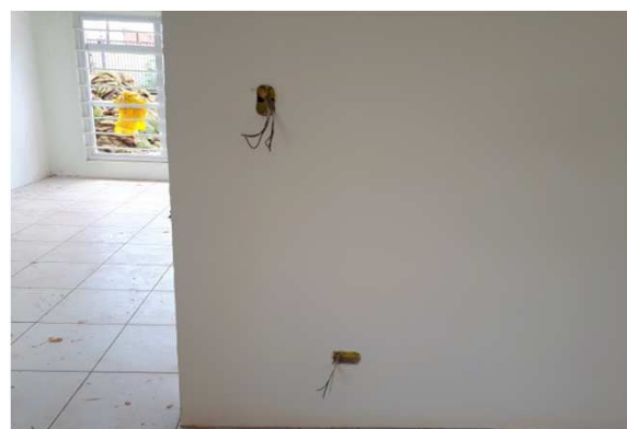
Figura 04E: caixas 2x4" drywall substituídas
