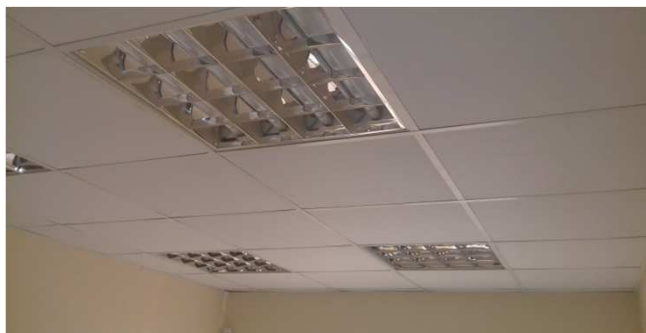
Figura 11C: Forro instalado na sala de audiência 1 da 2ª Vara
