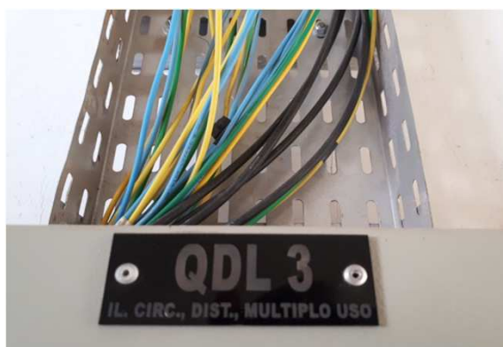
Figura 14E: cabearmento elétrico e alimentadores
