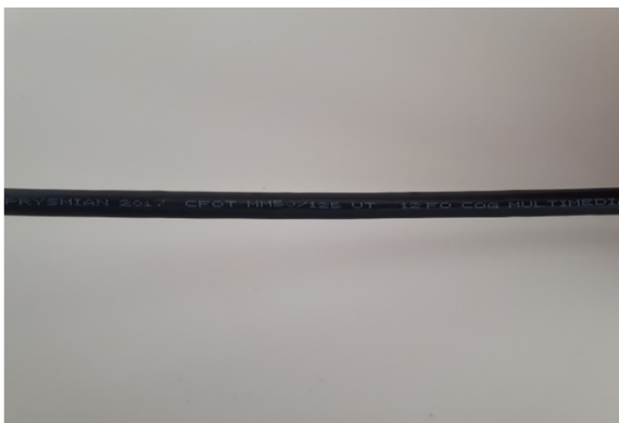
Figura 29E: fibra óptica MM entroncamento racks
