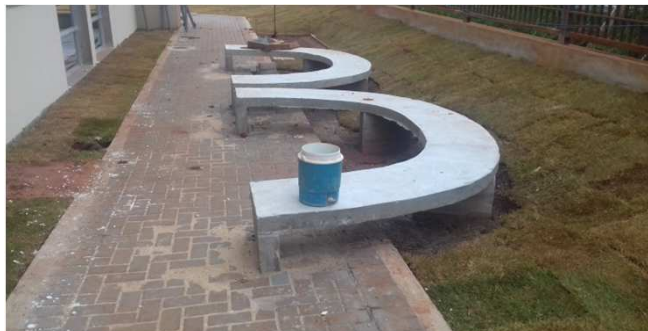
Figura 58C: Bancos de concreto já desformados - Defronte aos PABs
