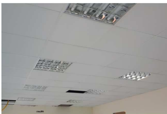
Figura 21E: luminárias com aletas 62,5 x 62,5cm
