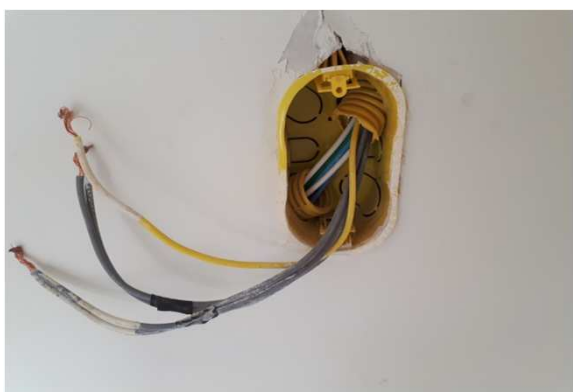
Figura 03E: caixas 2x4" drywall substituídas
