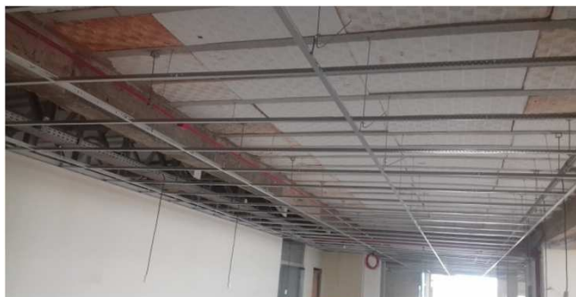
Figura 05C: Início da instalação do forro em gesso acartonado - Instalação dos perfis metálicos e atirantamento na laje
