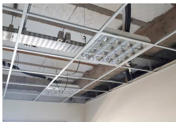
Figura 22E: luminárias com aletas 62,5 x 62,5cm
