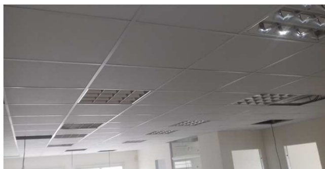
Figura 12C: Forro instalado na secretaria da 2ª Vara
