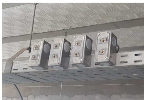
Figura 34E: conduletes padrão genérico
