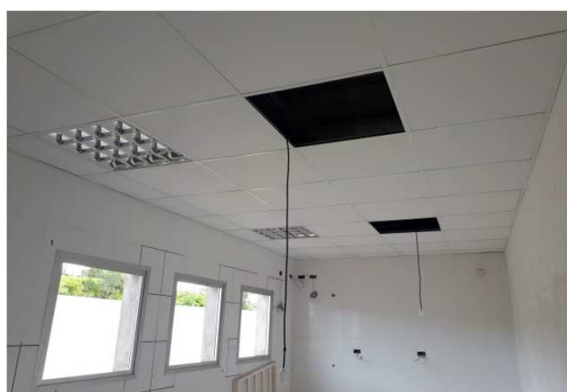
Figura 20E: luminárias com aletas 62,5 x 62,5cm
