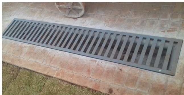
Figura 16C: Canaleta com grela, instalada no passeio entre estacionamento e porta lateral - bloco da esquerda
