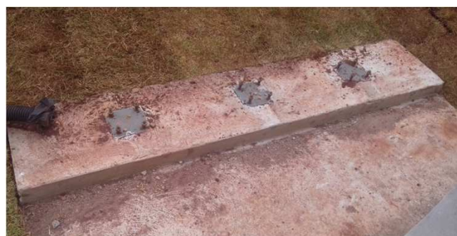
Figura 54C: Bloco de fundação e bases para fixação dos mastros
