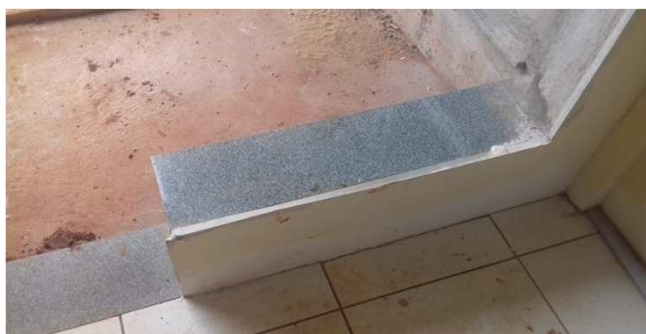
Figura 13C: Peitoril e soleira, instaladas na porta lateral e painel de vidro - saída para o estacionamento da esquerda
