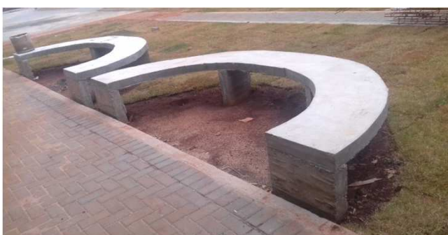
Figura 57C: bancos de concreto já desformados - defronte à 2ª Vara
