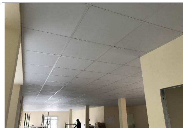
Figura 05C: Forro modular - Módulo de Apoio (PAB's).
