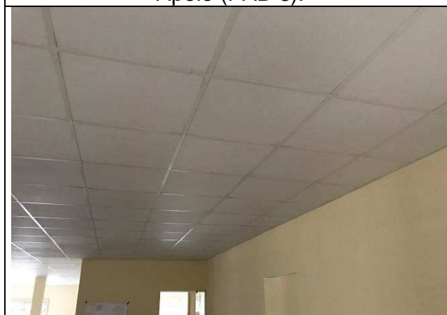
Figura 07C: Forro modular - Módulo de Apoio (PAB's).
