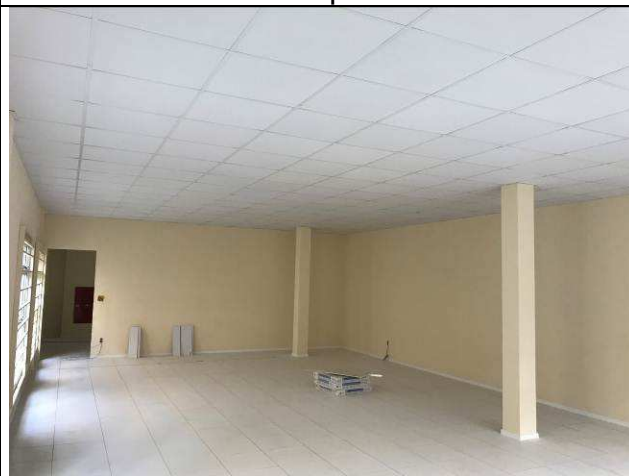
Figura 18C: Forro modular - Arquivo.
