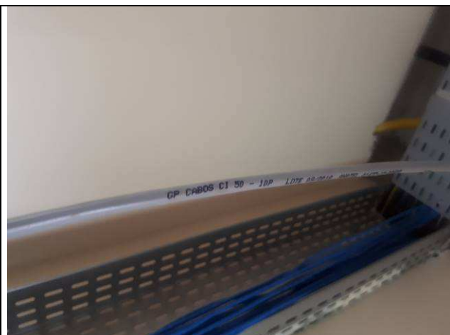
Figura 24E: cabo CCI 10 pares OAB
