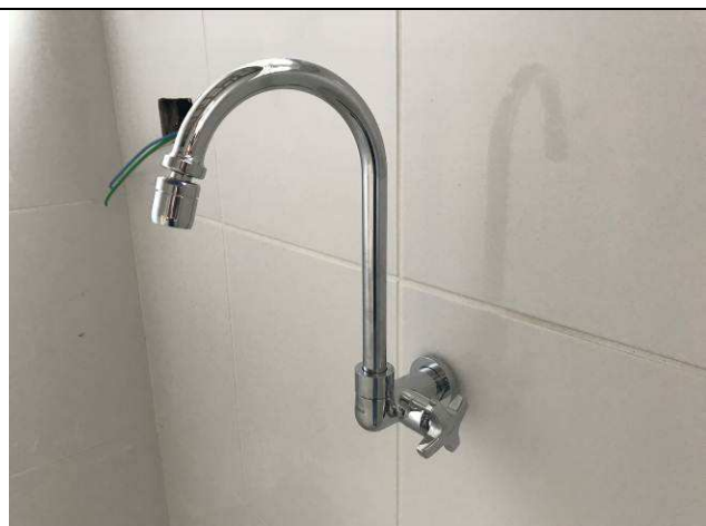
Figura 57C: Torneira de pressão para pia de copa com bica móvel.
