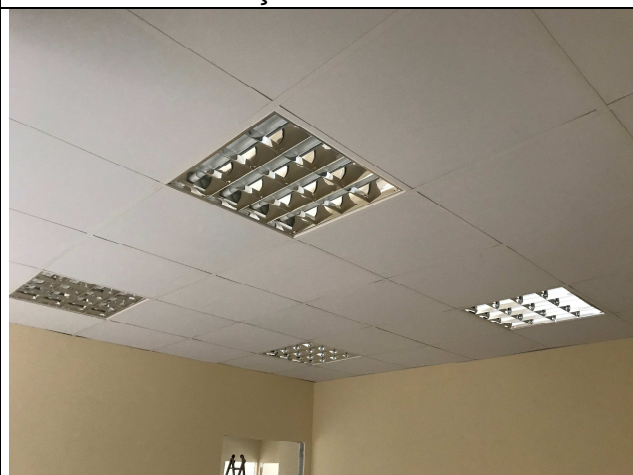
Figura 29C: Forro modular - Gabinete 1 de juiz da 1ª Vara.
