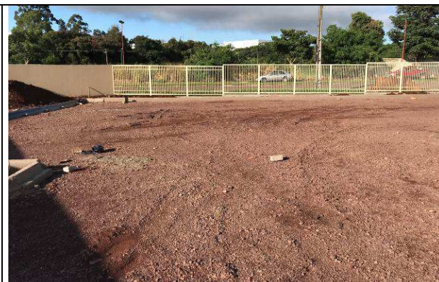
Figura 70C: Base compactada em brita para assentamento da pavimentação.
