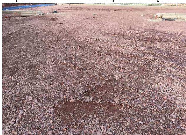
Figura 71C: Base compactada em brita para assentamento da pavimentação.
