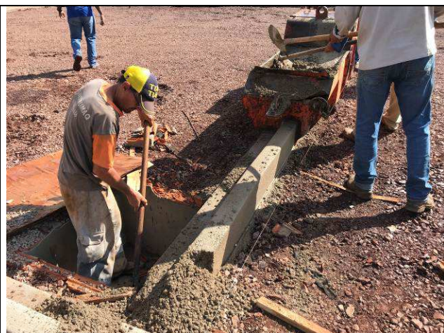
Figura 74C: Execução dos meios-fios em concreto com extrusora.
