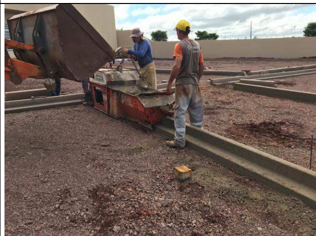
Figura 76C: Execução dos meios-fios em concreto com extrusora.
