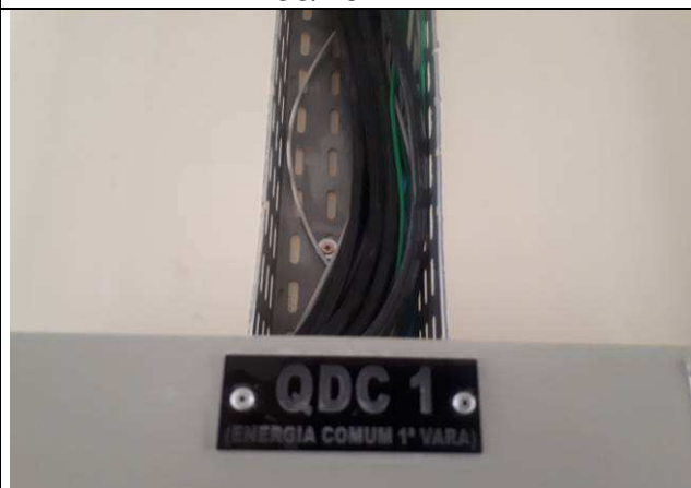
Figura 04E: cabeamento alimentador 35/16mm 2
