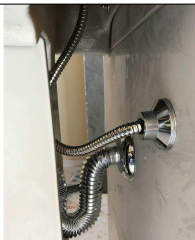
Figura 56C: Flexível de água e sifão corrugado cromados - lavatórios.
