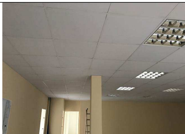
Figura 31C: Forro modular - Gabinete de juiz da 1ª Vara.
