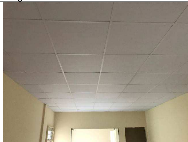
Figura 16C: Forro modular - Hall do Módulo do Arquivo.
