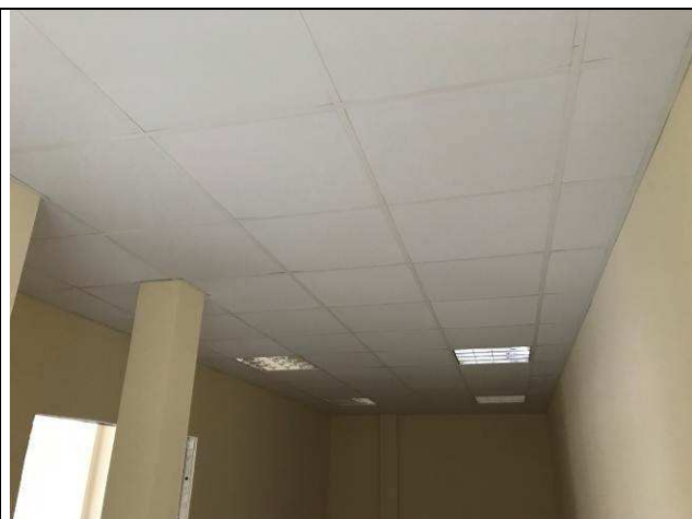
Figura 19C: Forro modular - Hall da Sala Múltiplo Uso.
