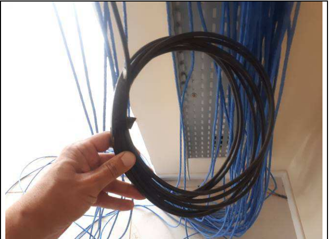
Figura 18E: fibra MM 6 entroncamento
