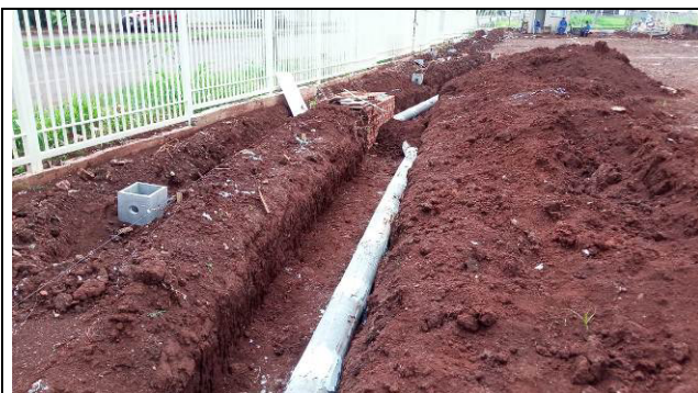
Figura 61C: Tubulações de concreto - Drenagem pluvial estacionamento frontal.
