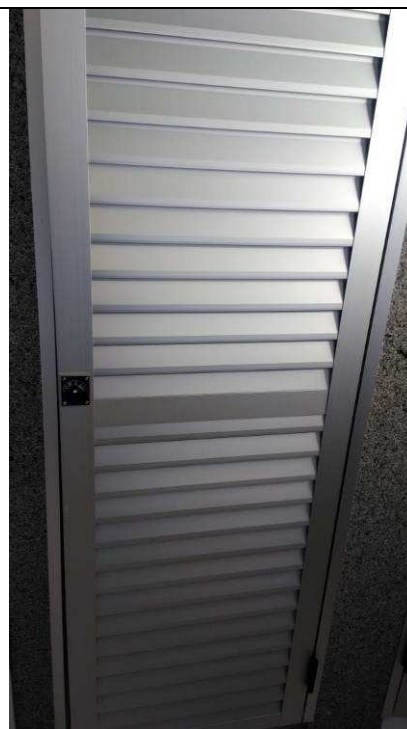
Figura 02C: Portas de alumínio - banheiros públicos.
