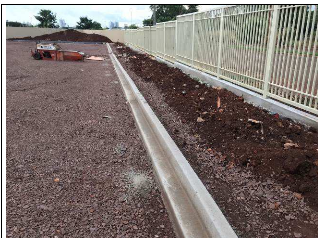
Figura 79C: Meios-fios em concreto - estacionamento frente.
