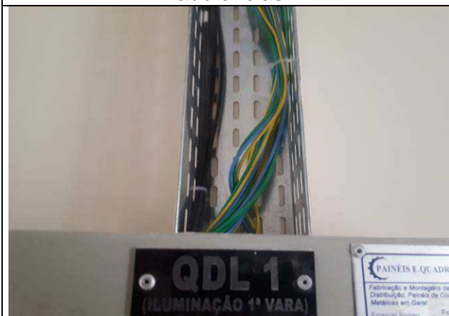
Figura 03E: cabeamento alimentador 6mm 2
