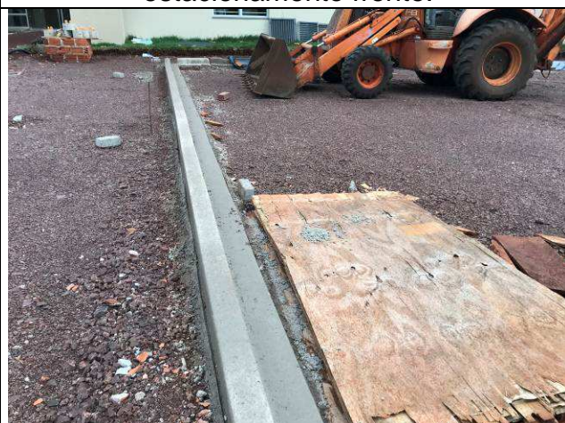
Figura 82C: Meios-fios em concreto - estacionamento frente.
