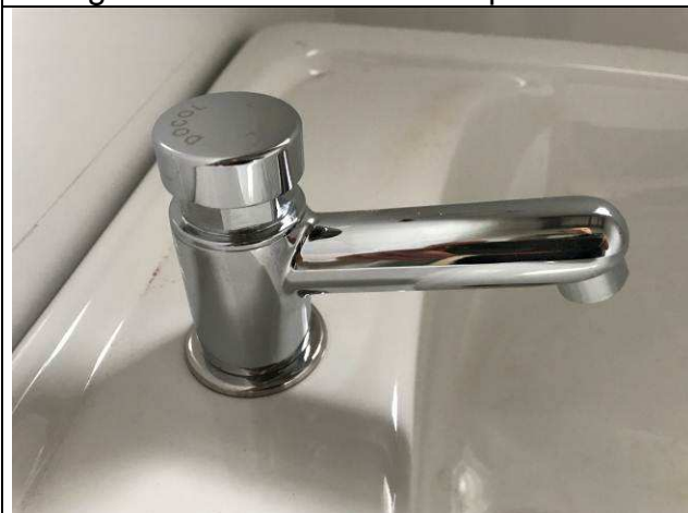
Figura 41C: Torneira de pressão com fechamento automático.
