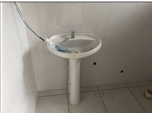
Figura 49C: Lavatório com coluna.
