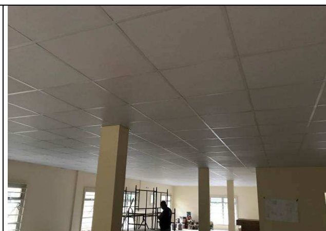
Figura 06C: Forro modular - Módulo de Apoio (PAB's).
