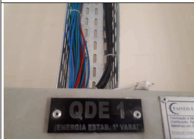
Figura 05E: cabeamento alimentador 10mm 2
