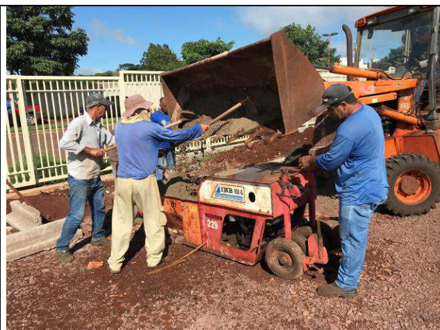
Figura 73C: Execução dos meios-fios em concreto com extrusora.
