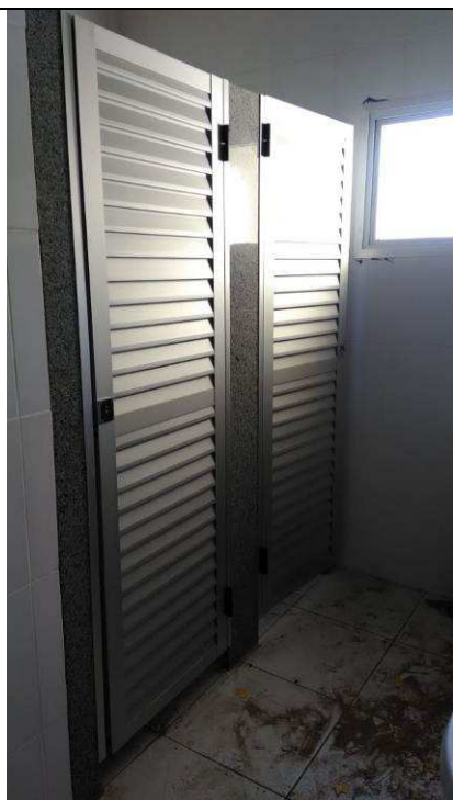
Figura 01C: Portas de alumínio - banheiros públicos.
