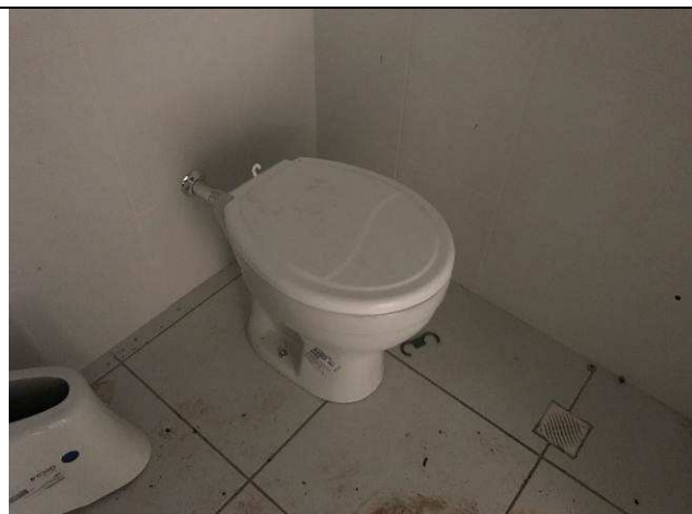
Figura 45C: Bacia sanitária para PNE.
