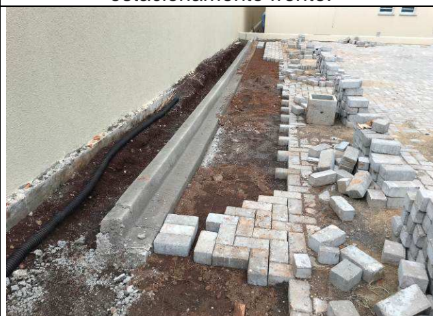
Figura 84C: Meios-fios em concreto - estacionamento fundos.
