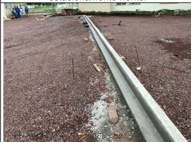
Figura 81C: Meios-fios em concreto - estacionamento frente.
