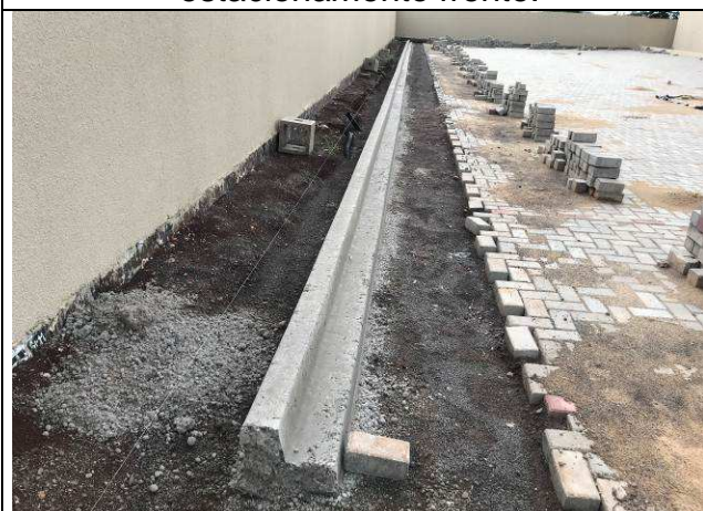
Figura 83C: Meios-fios em concreto - estacionamento fundos.
