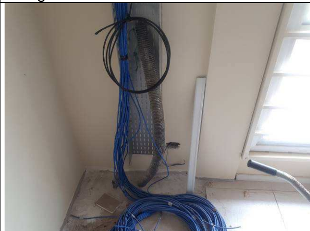
Figura 19E: fibra MM 6 entroncamento
