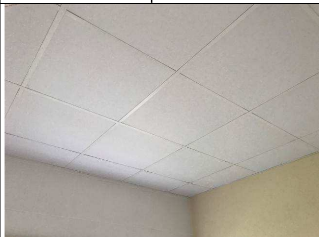
Figura 21C: Forro modular - Copa da Área de Vivência.
