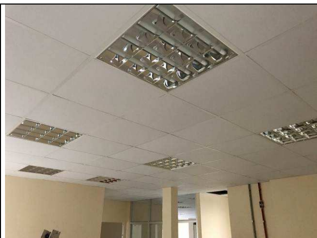
Figura 26C: Forro modular - Espera da 1ª Vara.
