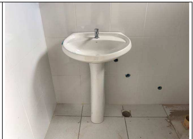
Figura 40C: Lavatório com coluna.
