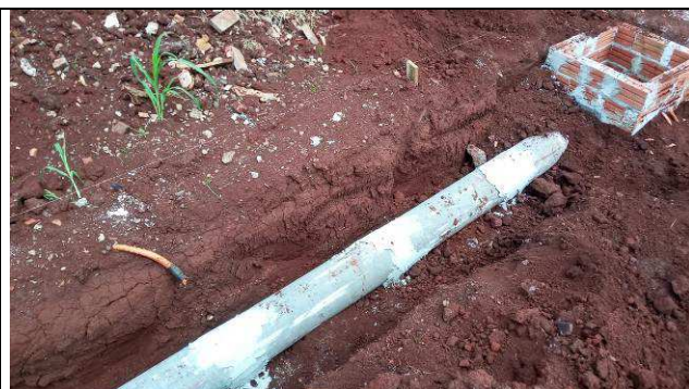
Figura 62C: Tubulações de concreto - Drenagem pluvial estacionamento frontal.
