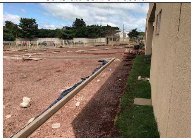
Figura 78C: Meios-fios em concreto - estacionamento frente.
