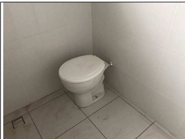
Figura 39C: Bacia sanitária para PNE.
