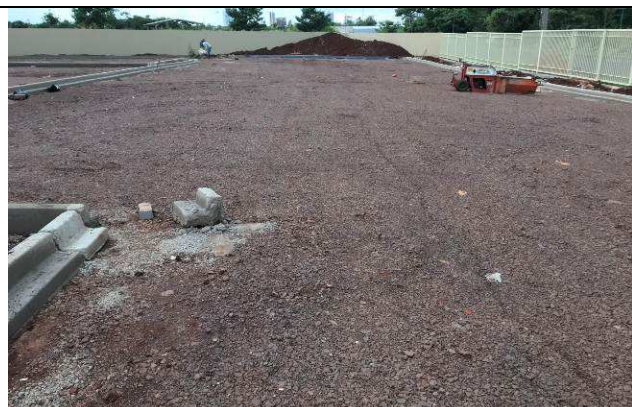
Figura 69C: Base compactada em brita para assentamento da pavimentação.
