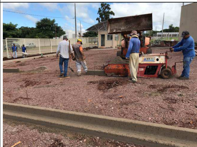
Figura 75C: Execução dos meios-fios em concreto com extrusora.
