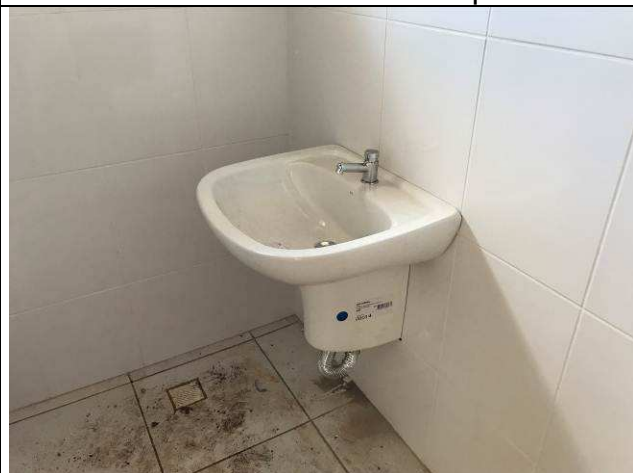
Figura 53C: Lavatório com coluna suspensa - banheiros PNE.
