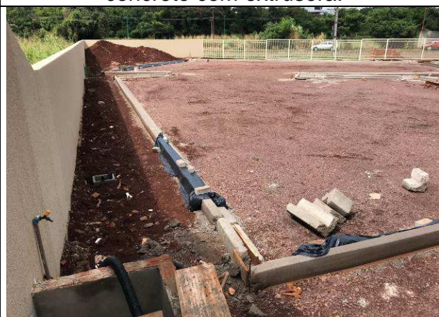
Figura 77C: Meios-fios em concreto - estacionamento frente.
