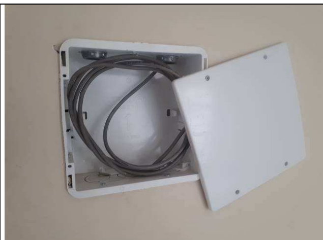
Figura 23E: cabo CCI 10 pares OAB
