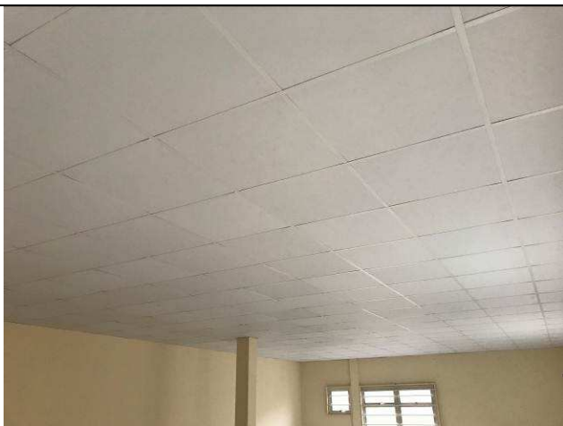
Figura 17C: Forro modular - Arquivo.
