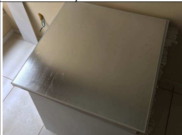
Figura 36C: Revestimento em alumínio das placas de forro.
