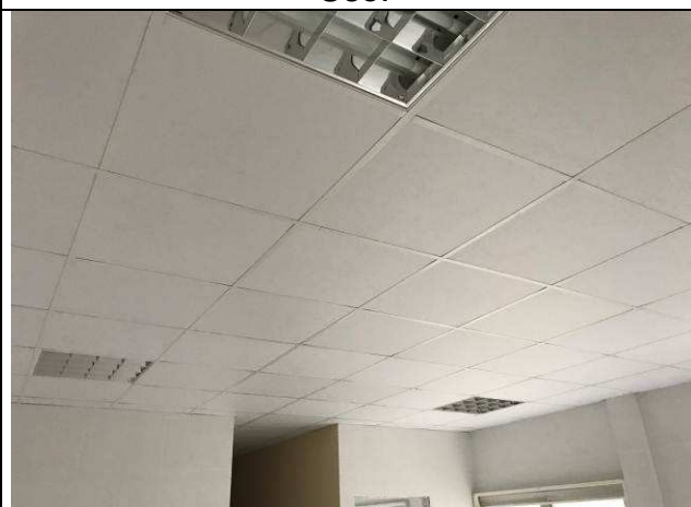
Figura 24C: Forro modular - Copa de Terceirizados.
