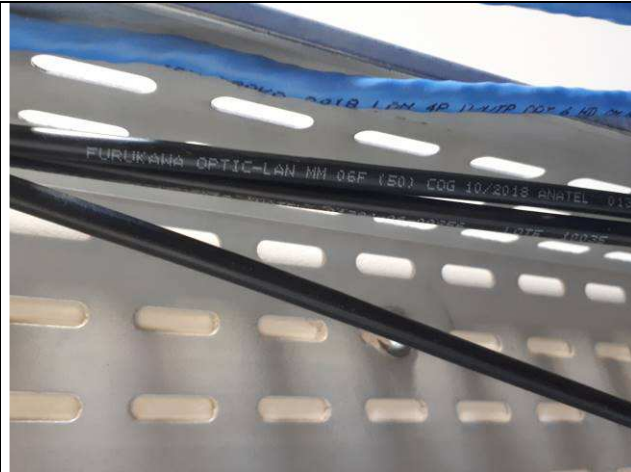
Figura 17E: fibra MM 6 entroncamento
