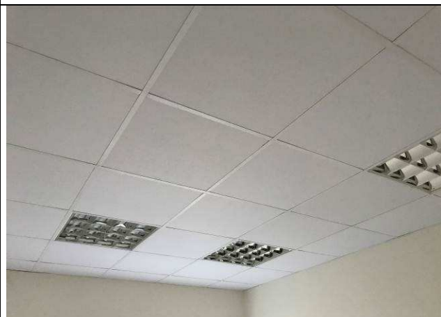
Figura 27C: Forro modular - Sala de Conciliação 1 da 1ª Vara.
