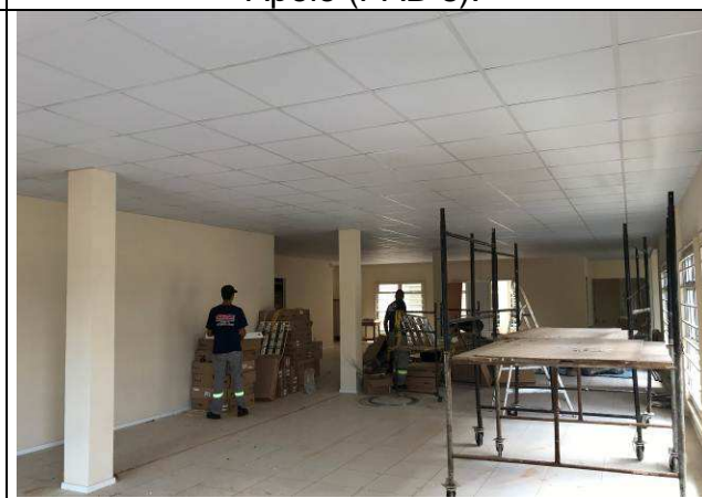
Figura 08C: Forro modular - Módulo de Apoio (PAB's).
