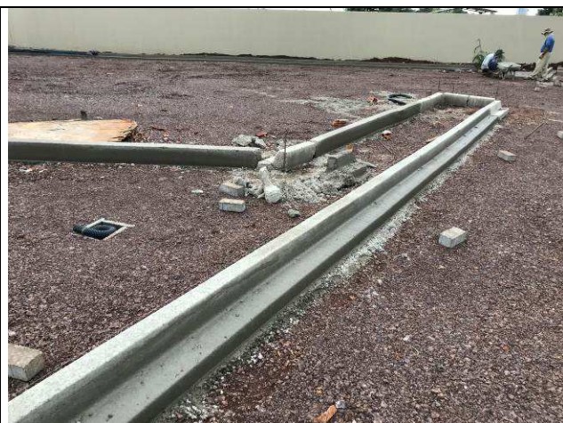
Figura 80C: Meios-fios em concreto - estacionamento frente.
