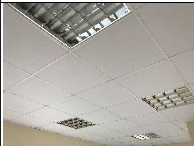
Figura 30C: Forro modular - Gabinete 2 de juiz da 1ª Vara.
