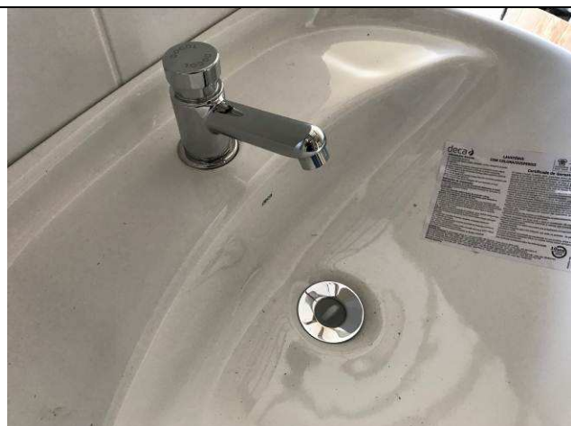
Figura 55C: Torneira de pressão e válvula - lavatórios.
