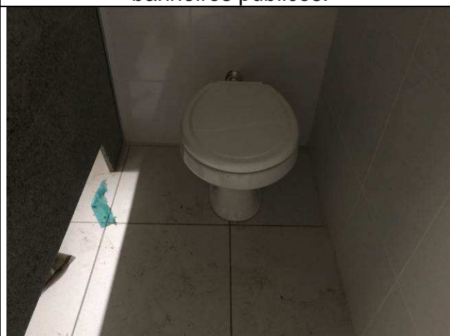
Figura 48C: Bacia sanitária para convencional - banheiros públicos.
