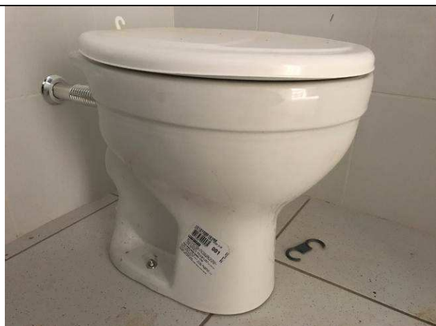
Figura 50C: Bacia sanitária para convencional - banheiros públicos.
