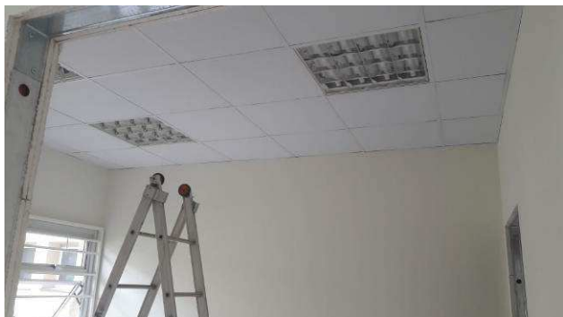
Figura 13C: Forro modular - Sala de Conciliação - 2ª Vara.
