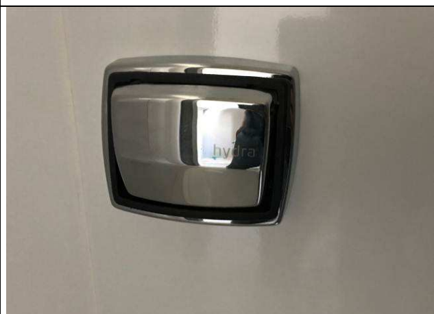
Figura 51C: Acabamento de válvula para as bacias convencionais - bwc's públicos.
