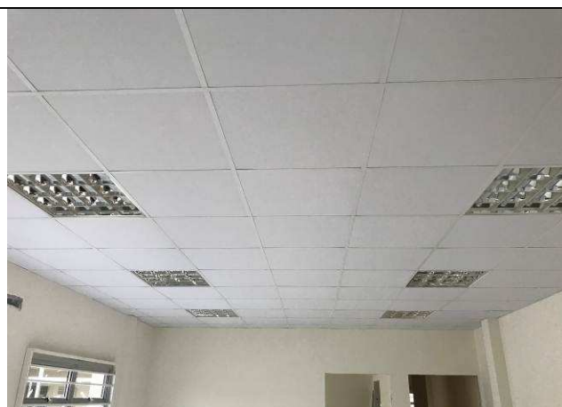
Figura 33C: Forro modular - Sala de Audiências 2 da 1ª Vara.
