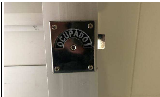
Figura 04C: Portas de alumínio - banheiros públicos.
