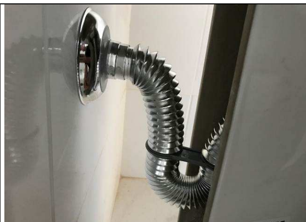
Figura 44C: Sifão corrugado cromado para lavatório.
