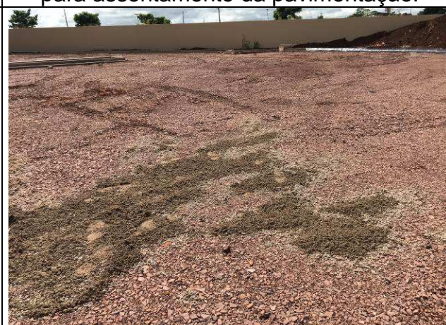
Figura 72C: Base compactada em brita para assentamento da pavimentação.
