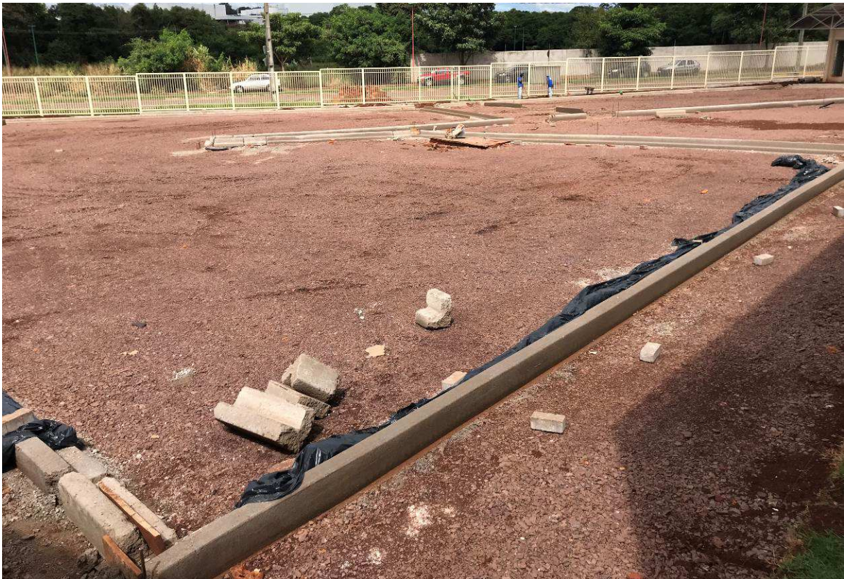
Figura 2 – Fórum - Vista externa - Frente.
