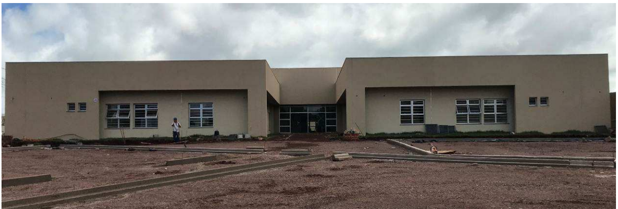
Figura 1 – Fórum - Vista externa.
