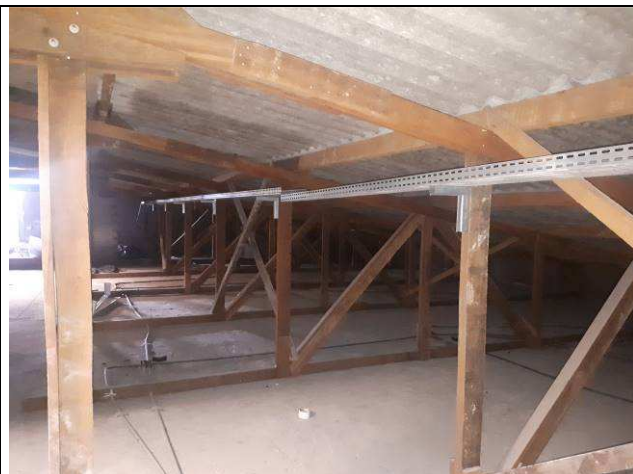
Figura 43E: instalações elétricas ar - cobertura VM362
