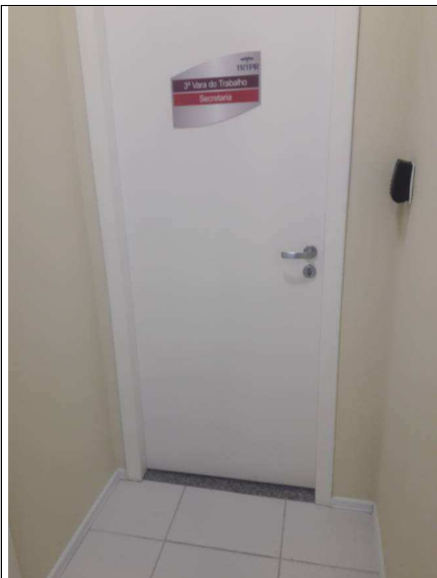
Figura 03C: Portas faltantes instaladas, inclusive rodapés e soleiras.
