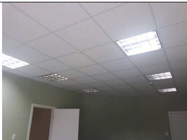
Figura 06C: Forros de gesso acartonado instalados.
