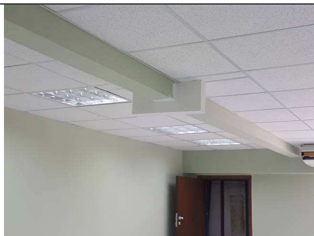
Figura 07C: Forro de envelopamento da rede de ar condicionado instalado.
