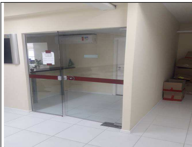
Figura 01C: Balcão de atendimento e portas de vidro reinstalados, 6ª VT.
