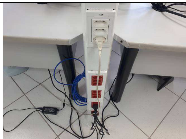
Figura 09E: colunas técnicas e acessórios Dutotec
