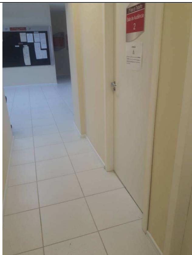
Figura 04C: Portas faltantes instaladas inclusive rodapés.
