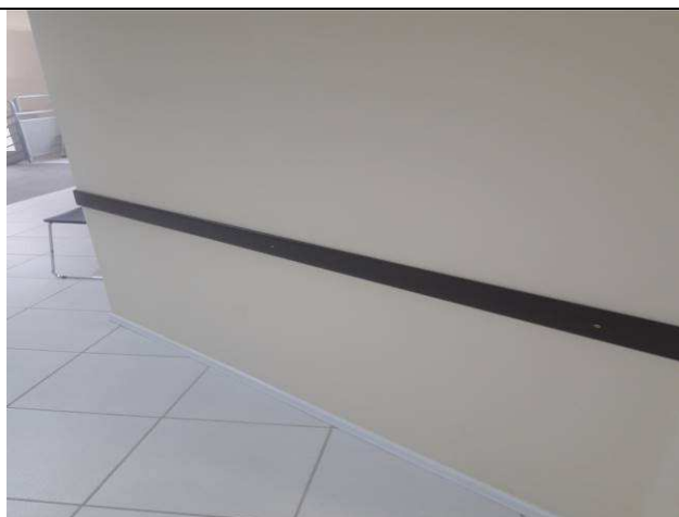
Figura 08C: Rodapés e bate macas instalados.
