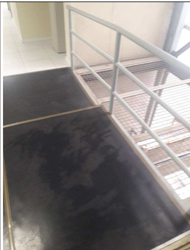
Figura 14C:.. Remoção e colocação do revestimento executado.
