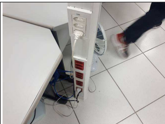
Figura 10E: colunas técnicas e acessórios Dutotec
